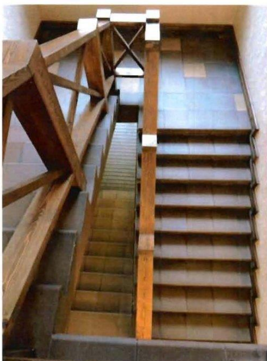
12. Лестница пом. 14-Н
