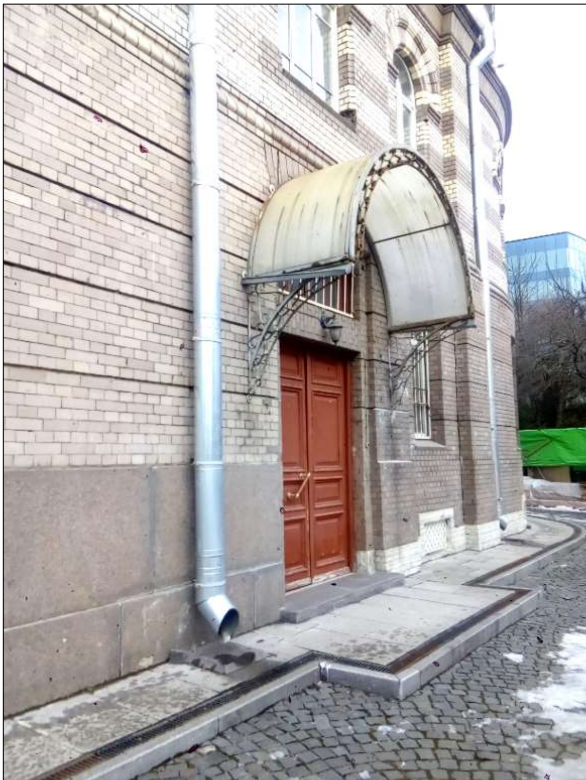
14. Козырек над дверным проемом восточной части фасада. Фото Н.М.Петуховой.01.02.2021г.
