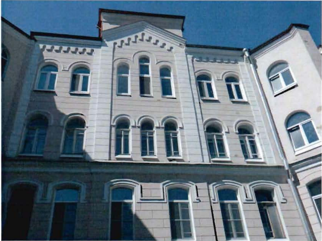
5. Фрагмент северо-восточной части фасада
