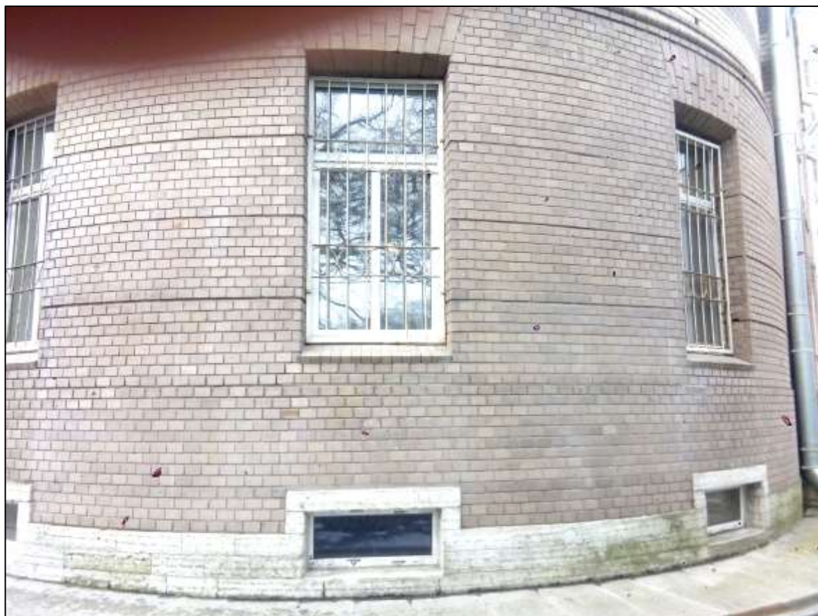
11.Угловая северо-восточная часть фасада. Состояние известнякового цоколя и облицовки 1 этажа. Фото Н.М.Петуховой. 01.02.2021г.
