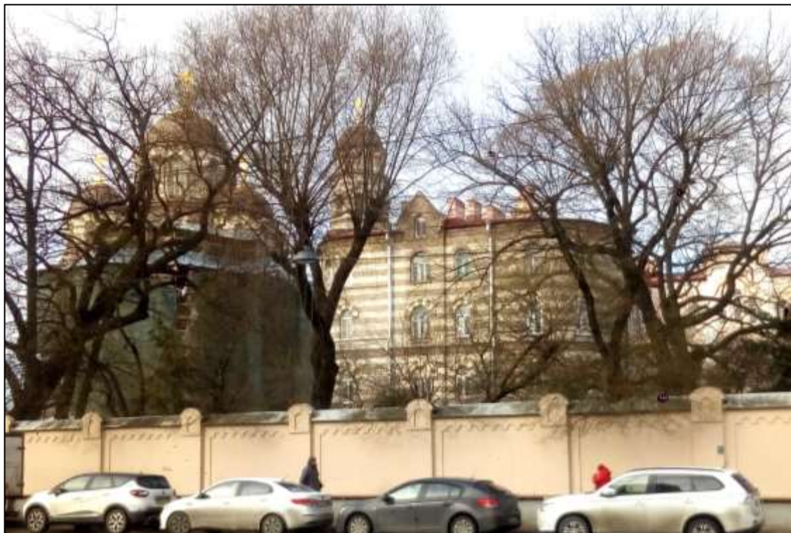
2. Общий вид комплекса Иоанновского монастыря и садового фасада с Иоанновского переулка. Фото Н.М.Петуховой. 01.02.2021г.
