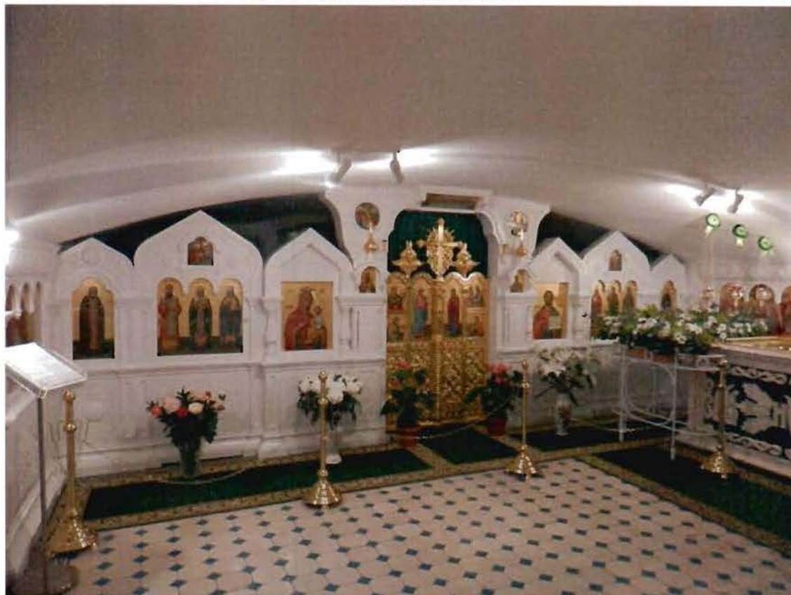
Храм-усыпальница 19. Своды, метлахская плитка
