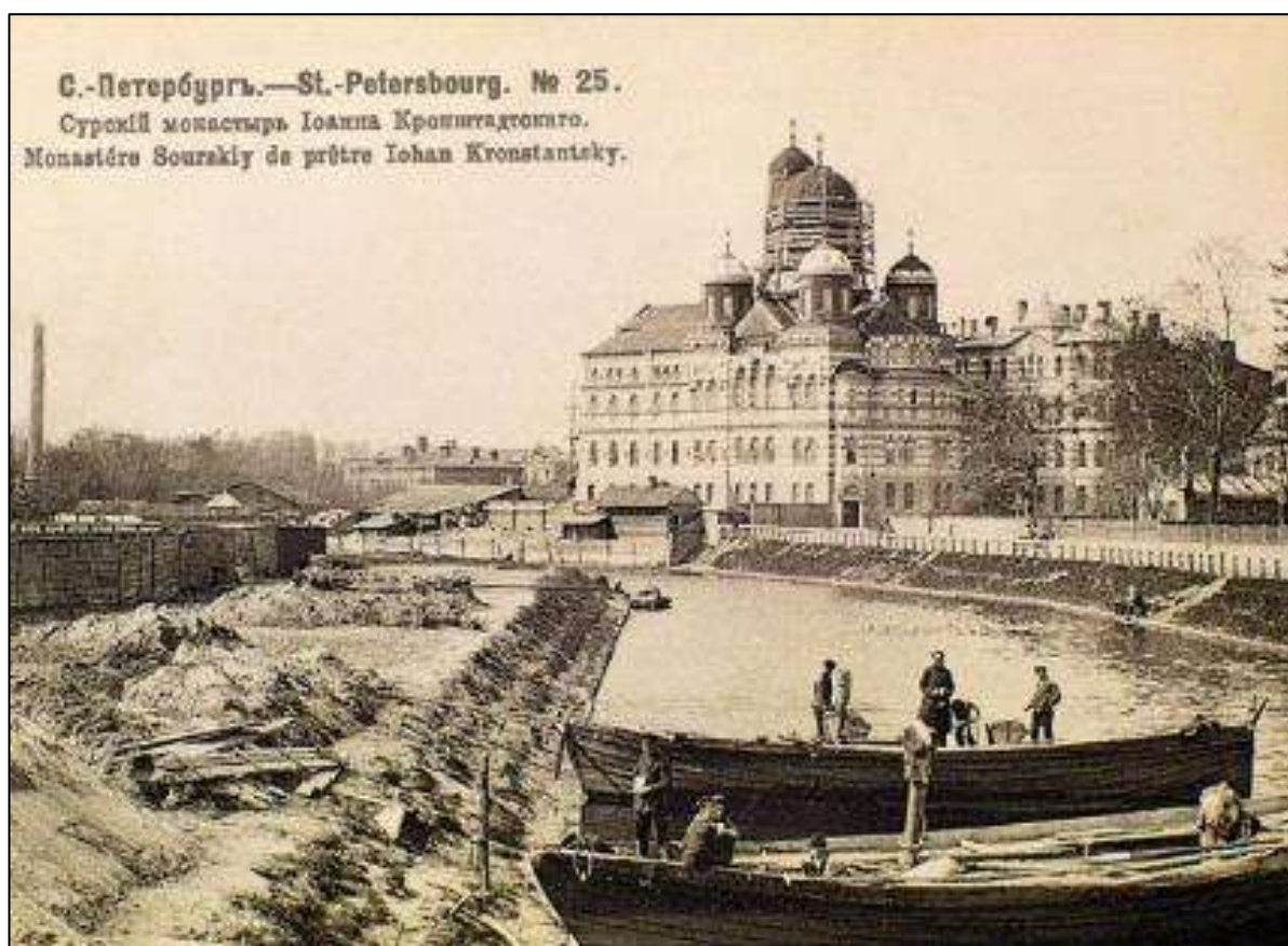
17. Устройство керамических куполов храма Двенадцати апостолов. 1903г. Открытка начала XX в.
