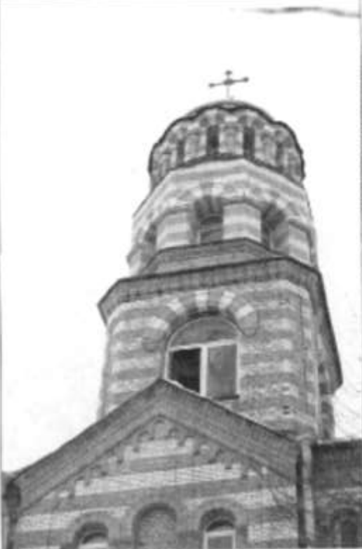
6. Колокольня. Вид с севостока.
