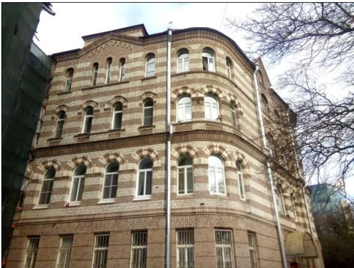
4. Угловая юго-восточная часть садового фасада. Вид с юго-востока. Фото Н.М.Петуховой.01.02.2021г.
