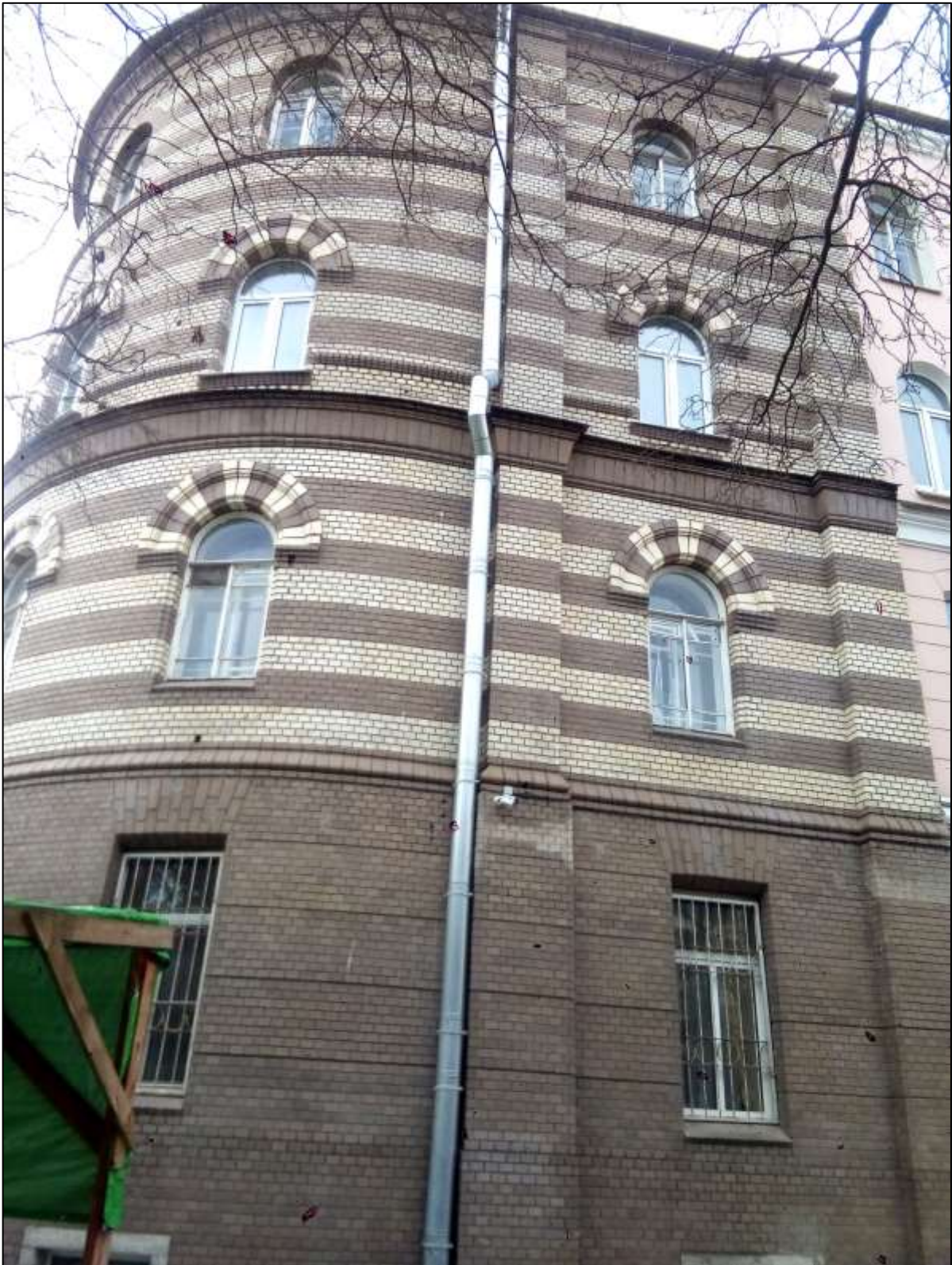
12. Северная часть садового фасада. Фото Н.М.Петуховой.01.02.2021г.
