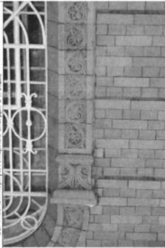
22. Главный корпус. Алтарные апсиды. 1-й этаж. Напичники окон.
