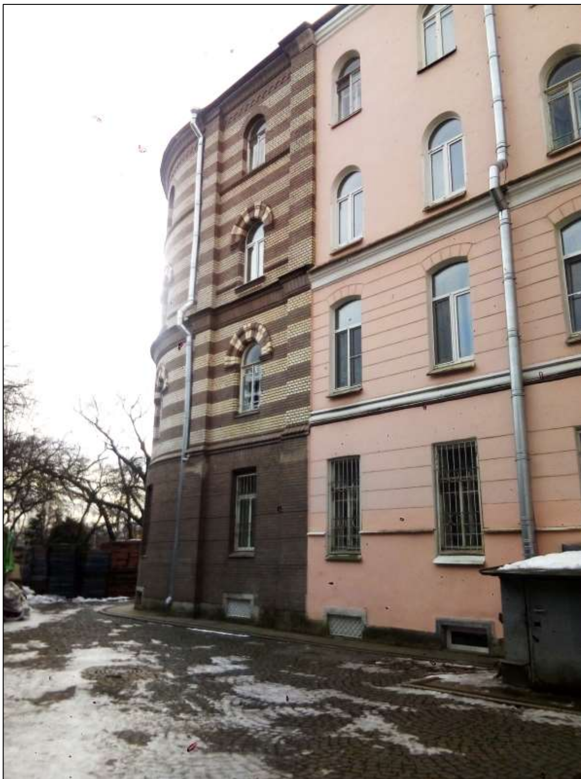
13. Вид с северо-запада примыкания садового фасада к корпусу 1909г. Фото Н.М.Петуховой.01.02.2021г.
