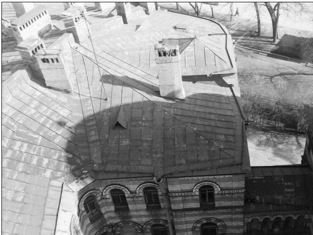
28.Фрагмент крыши жилого корпуса с четырехскатной кровлей взамен разобранного купола. Вид с запада.Фотография 1990г. Архив Иоанновского монастыря.
