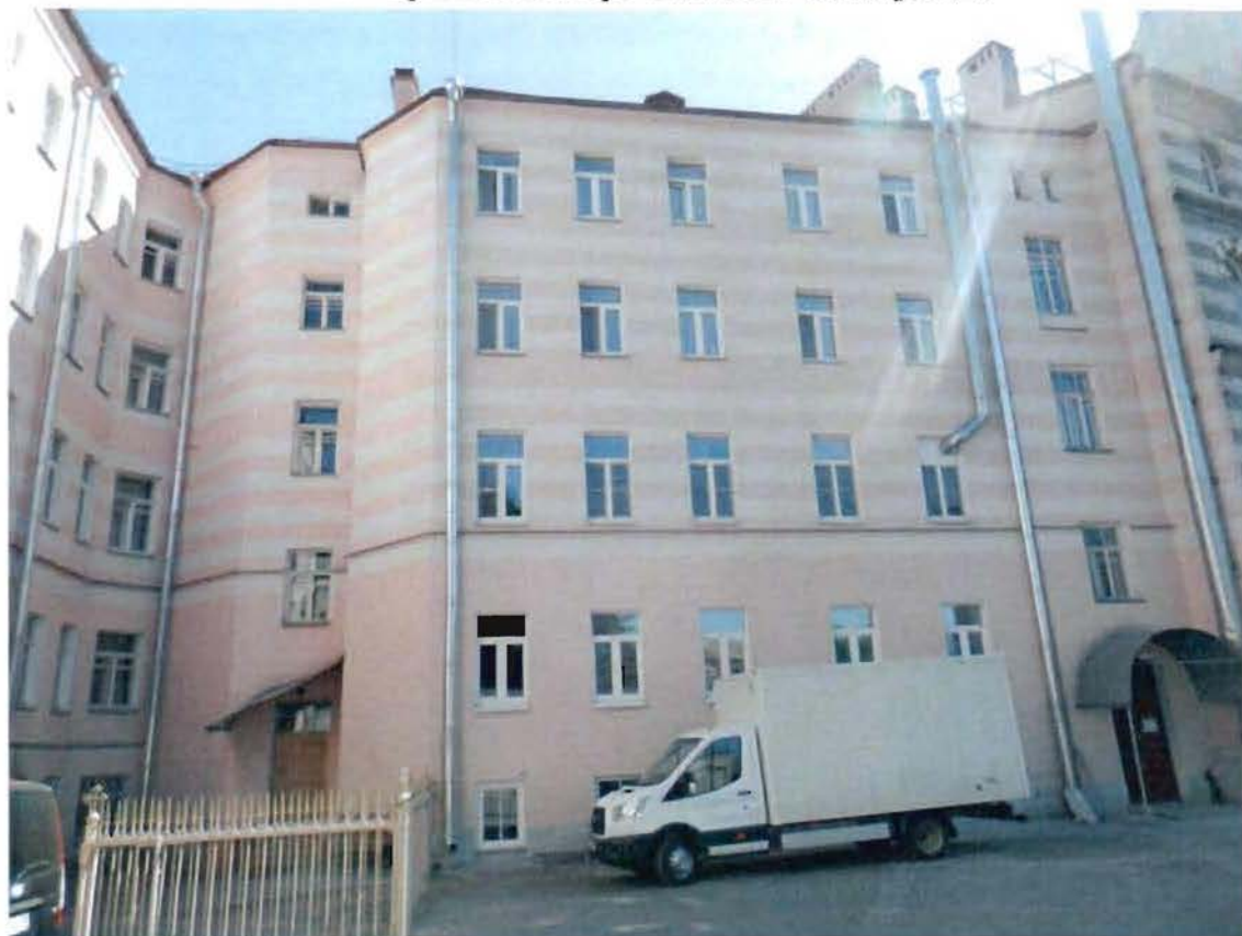
7. Фрагмент северо-западной части фасада
