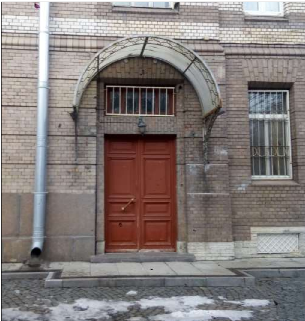
8. Входная группа на восточной части фасада. Видна граница различного материала облицовки цоколя. Фото Н.М.Петуховой.01.02.2021г.
