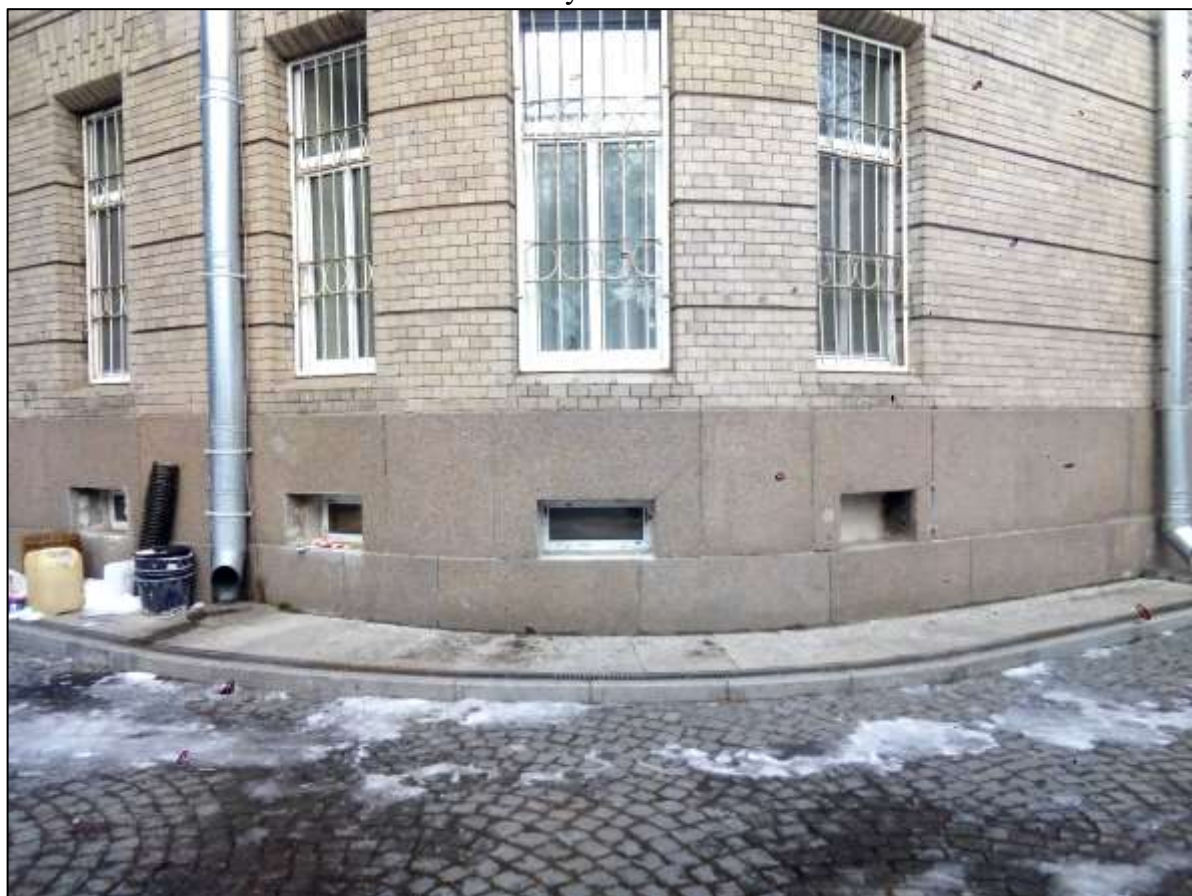
5. Угловая часть фасада. Гранитный цоколь и характер отделки стен первого этажа. Фото Н.М.Петуховой.01.02.2021г.
