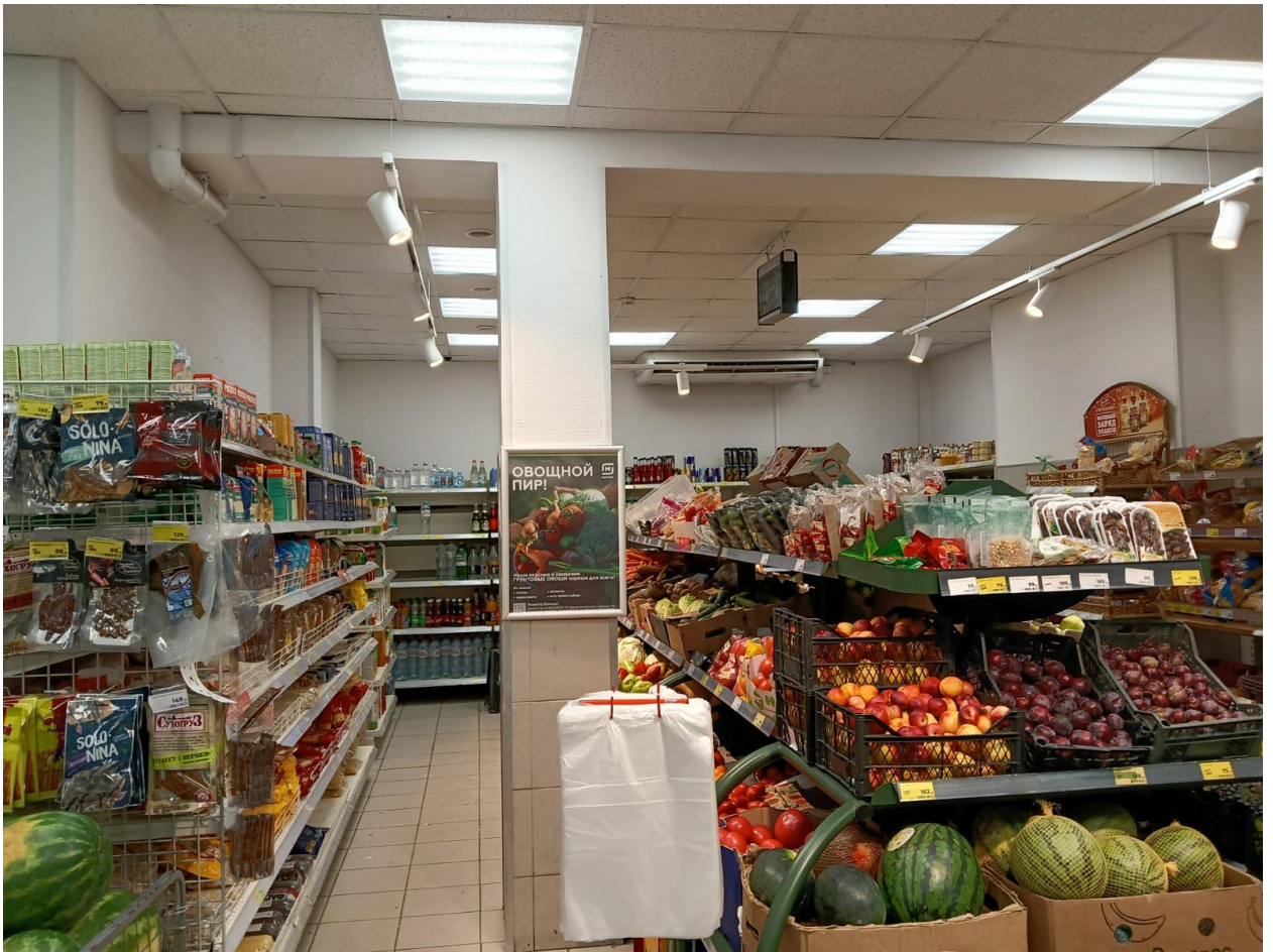
Фото 9. Объект культурного наследия регионального значения «Жилой дом купца Синебрюхова», расположенный по адресу: Санкт-Петербург, город Кронштадт, улица Аммермана, дом 26, литера А. Помещение 2-Н, торговый зал, колонна.
