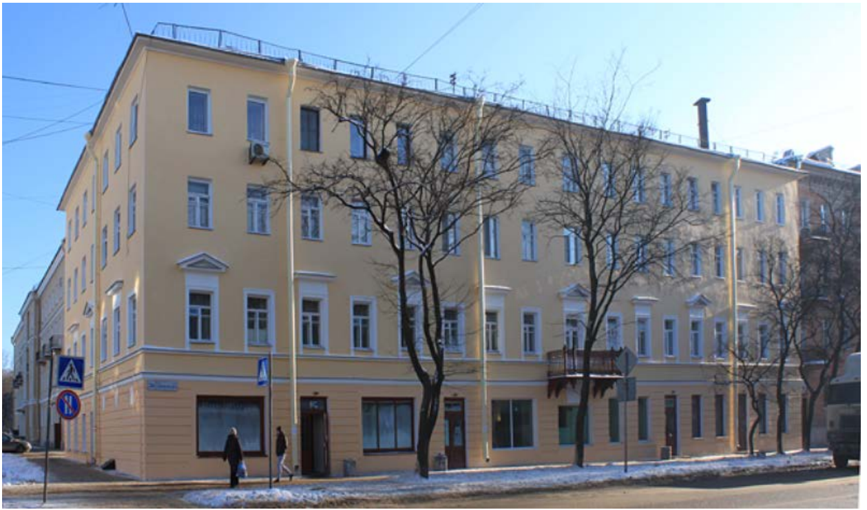
Илл. 15. Кронштадт. Жилой дом купца Синебрюхова. Улица Аммермана, д.26 (после капитального ремонта). Фото 2012 г.
