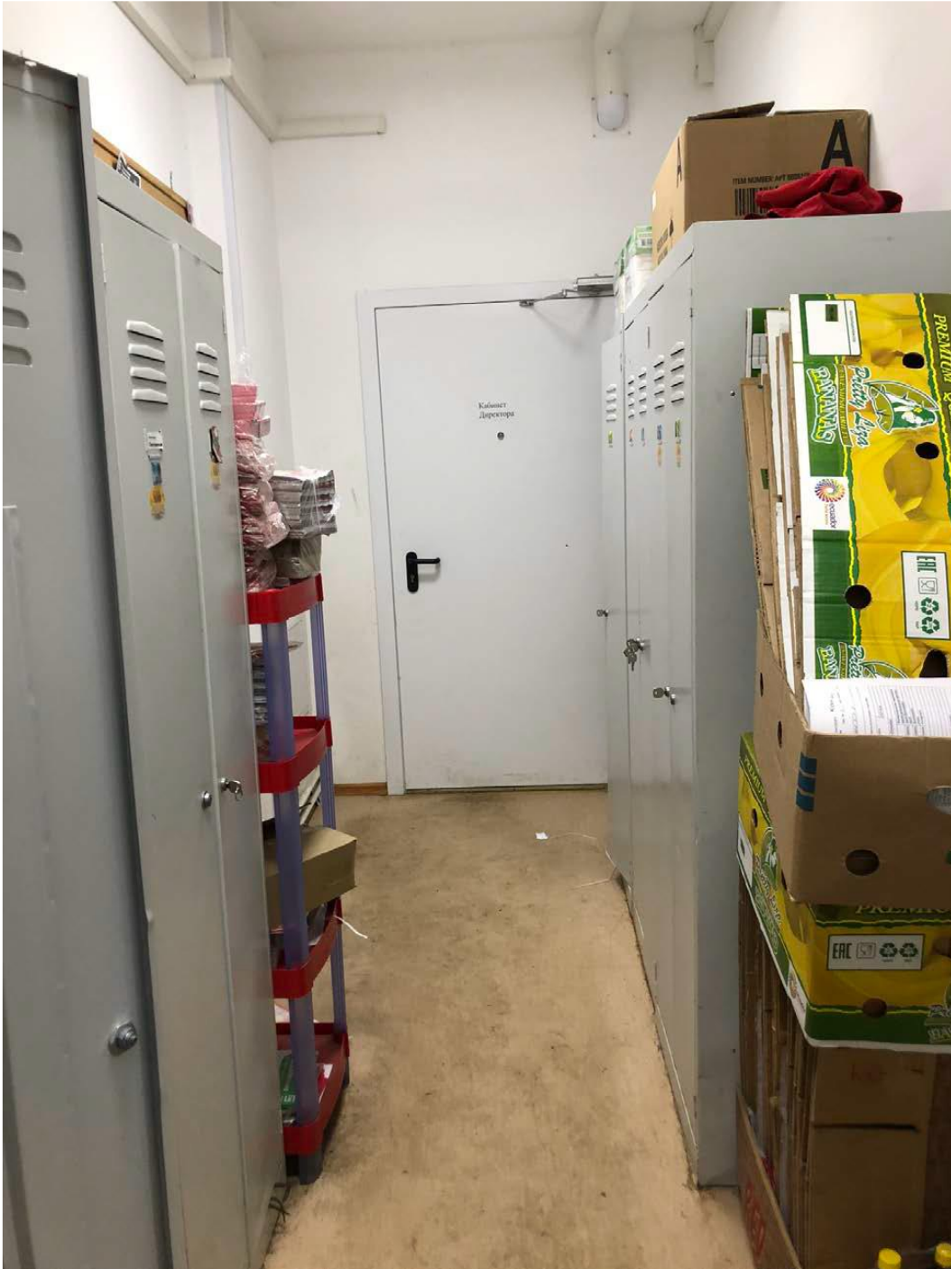
Фото 14. Объект культурного наследия регионального значения «Жилой дом купца Синебрюхова», расположенный по адресу: Санкт-Петербург, город Кронштадт, улица Аммермана, дом 26, литера А. Помещение 2-Н, подсобное помещение, коридор.
