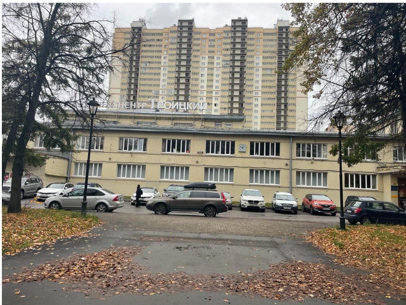
1. Выявленный объект культурного наследия «Дом культуры им. В. И. Ленина завода «Большевик», 1927–1929 гг., г. Санкт-Петербург, проспект Обуховской Обороны, 223, литера А. Фото Каргинова М. Д. (октябрь 2022)
