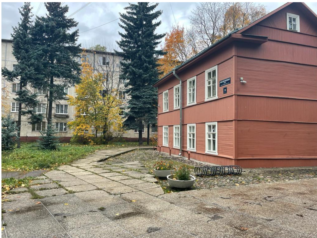
32. Объект культурного наследия регионального значения «Дом, где в 1894–1917 гг. проводились собрания рабочих-марксистов», 1894-1917 гг., г. Санкт-Петербург, Ново-Александровская улица, дом 23.
