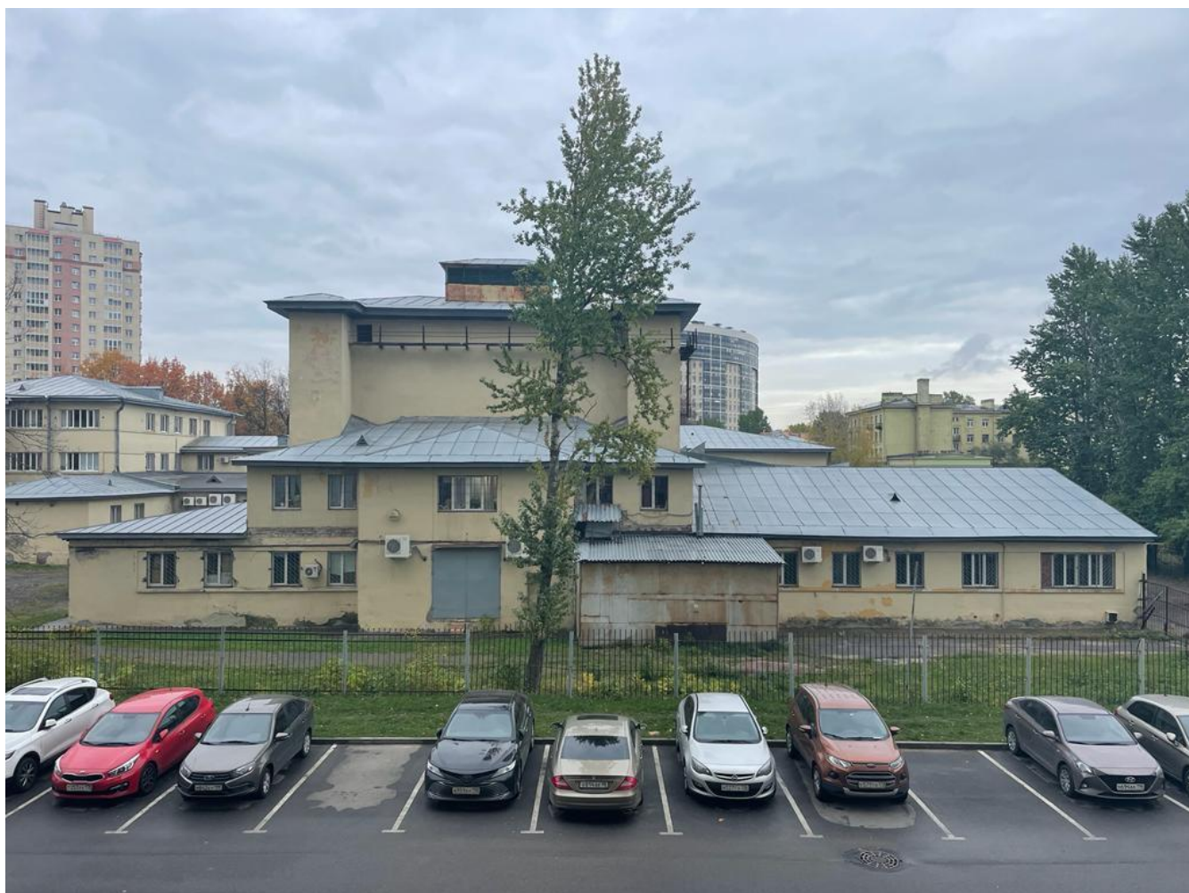
13. Выявленный объект культурного наследия «Дом культуры им. В. И. Ленина завода «Большевик», 1927–1929 гг., г. Санкт-Петербург, проспект Обуховской Обороны, 223, литера А.
