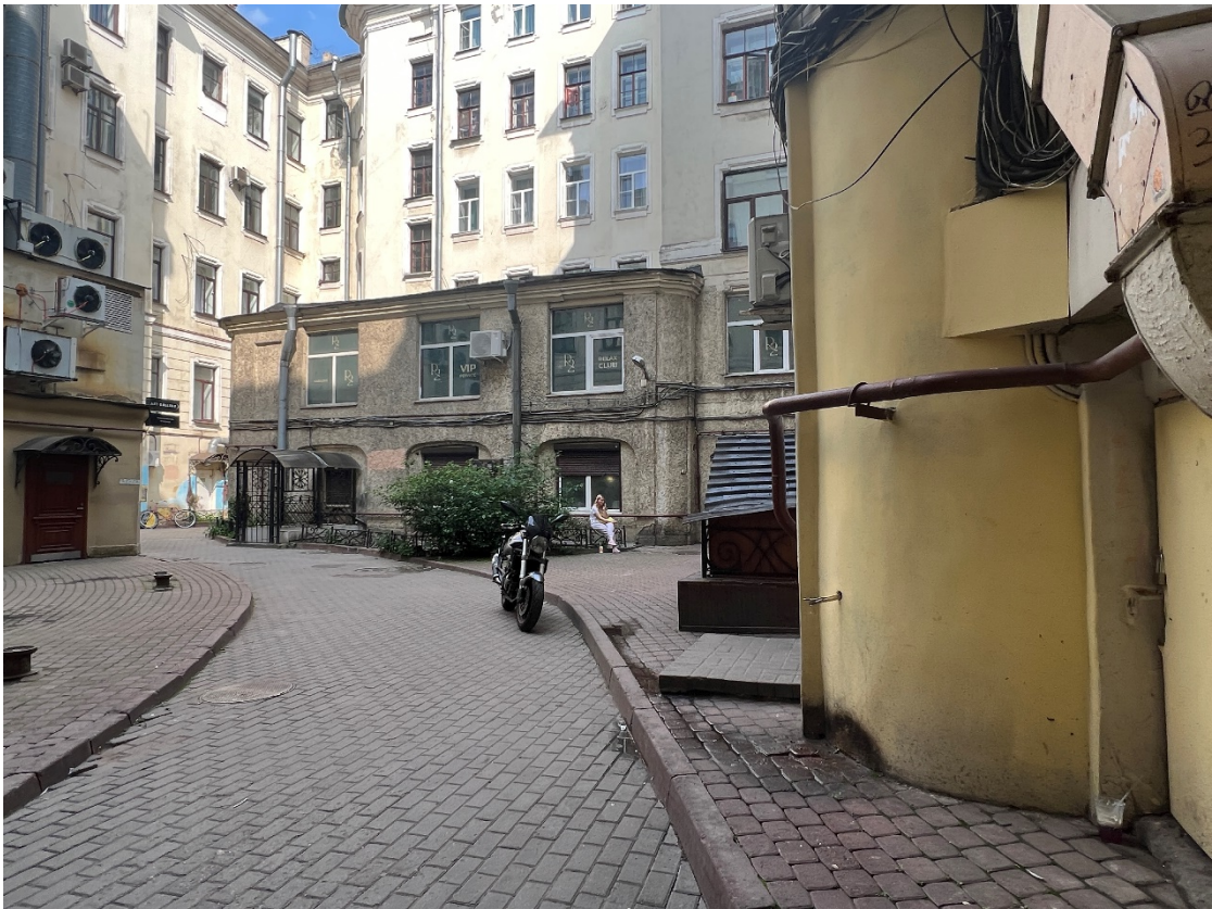
10. Объект культурного наследия регионального значения «Дом И.И. Ростовцева» по адресу: Невский пр., 45; Рубинштейна ул., 2. Внутренний двор. Дата съемки 06.07.2023.
