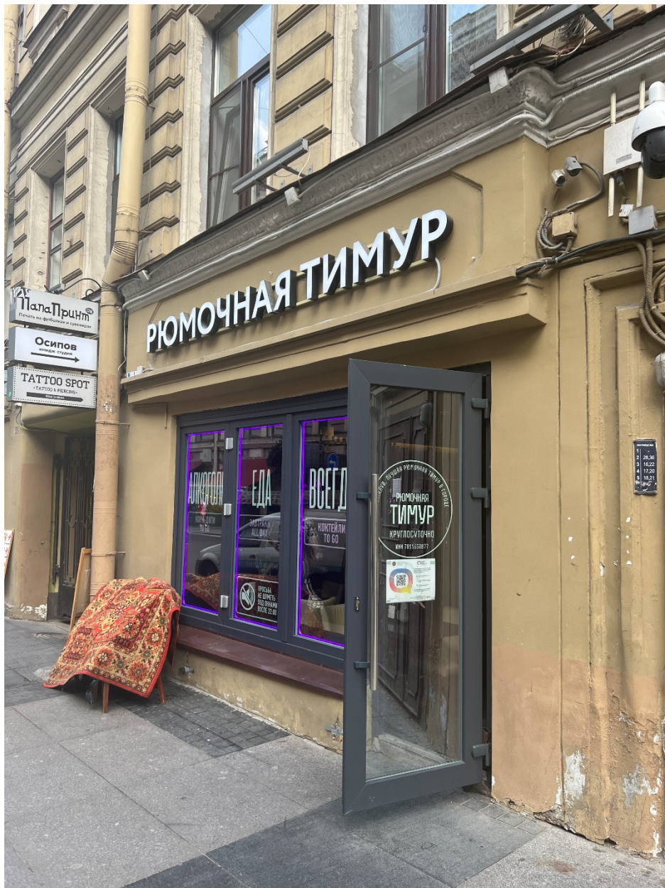
4. Объект культурного наследия регионального значения «Дом И.И. Ростовцева» по адресу: Невский пр., 45; Рубинштейна ул., 2. Западный фасад. Дверь. Дата съемки 06.07.2023.
