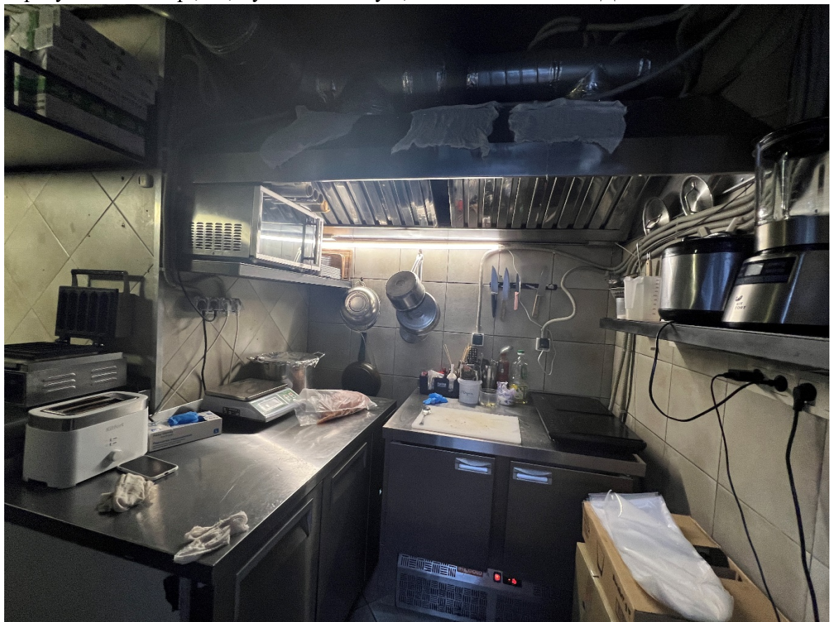
19. Объект культурного наследия регионального значения «Дом И.И. Ростовцева» по адресу: Невский пр., 45; Рубинштейна ул., 2. Помещение 7-Н. Дата съемки 06.07.2023.
