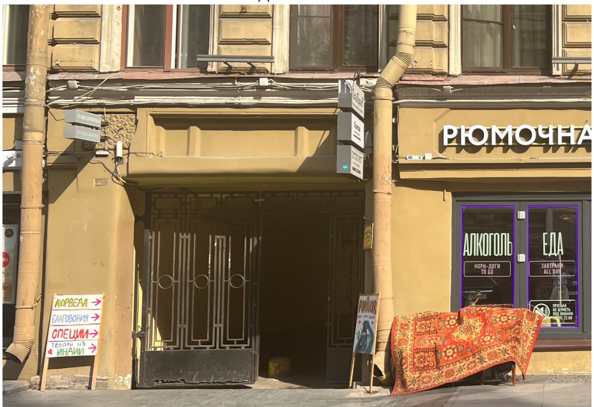
6. Объект культурного наследия регионального значения «Дом И.И. Ростовцева» по адресу: Невский пр., 45; Рубинштейна ул., 2. Западный фасад. Проход во двор. Дата съемки 06.07.2023.
