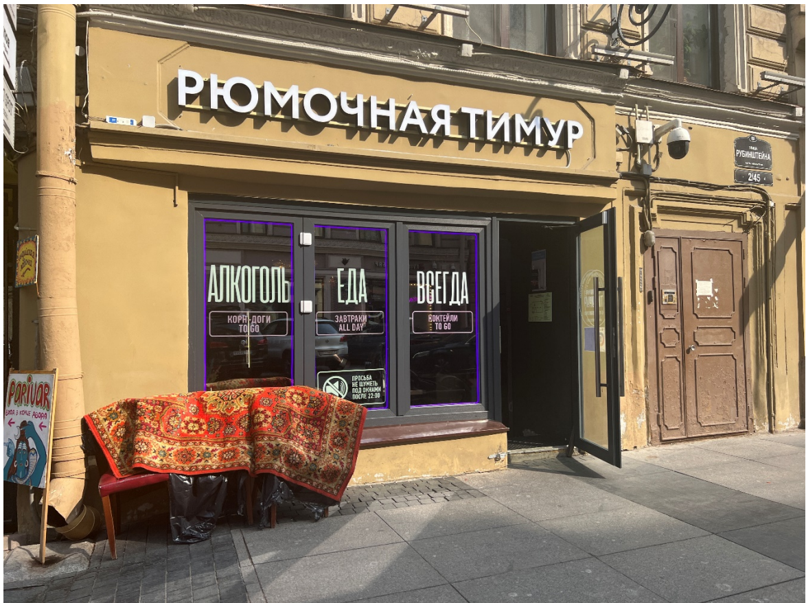
5. Объект культурного наследия регионального значения «Дом И.И. Ростовцева» по адресу: Невский пр., 45; Рубинштейна ул., 2. Западный фасад. Оконное и дверное заполнения. Дата съемки 06.07.2023.
