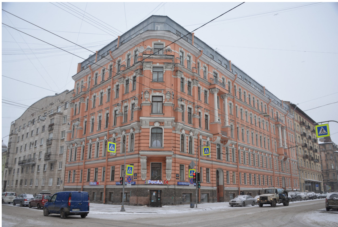
1. Общий вид выявленного объекта культурного наследия «Дом А.Е. Длусской»
