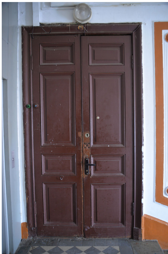
5. Входная дверь в квартиру №16
