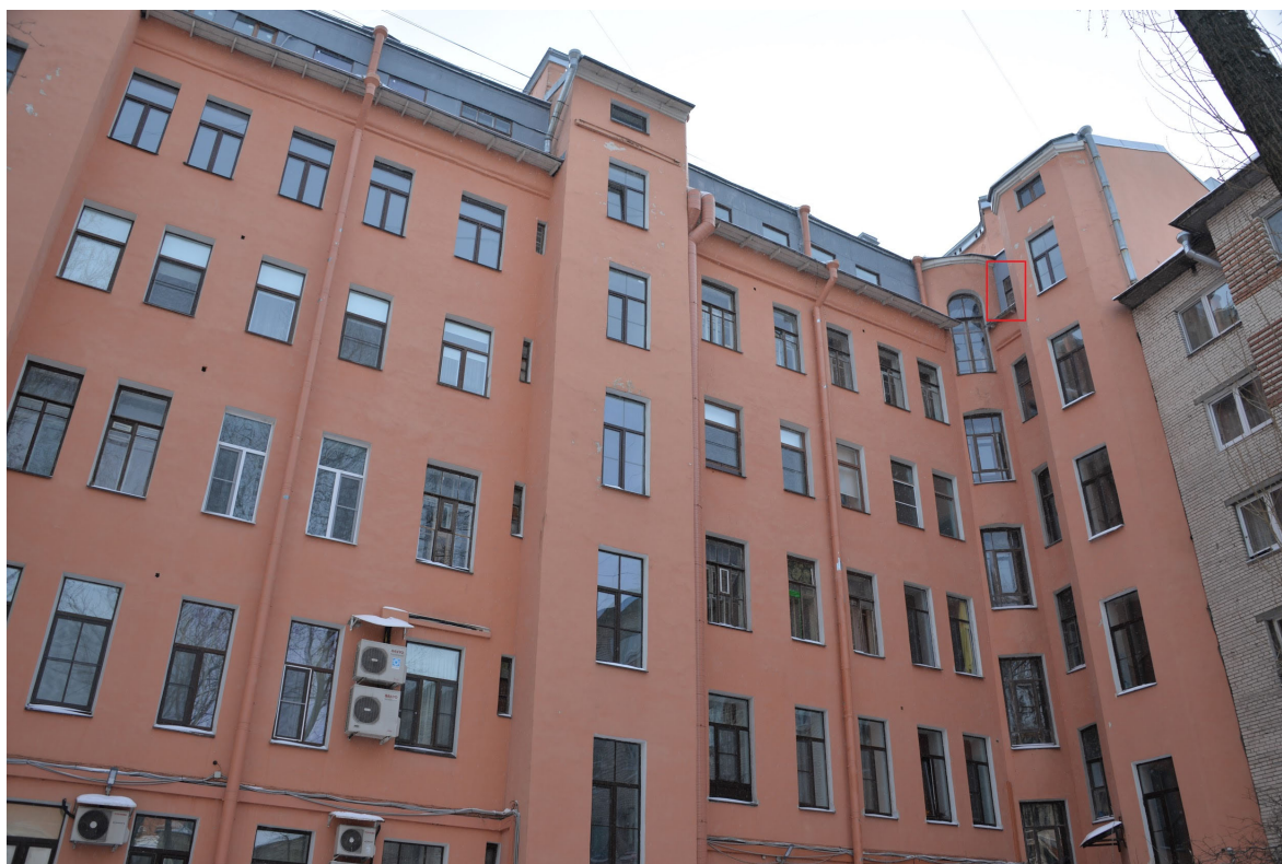
4. Фрагмент дворового фасада объекта культурного наследия «Дом А.Е. Длусской»
