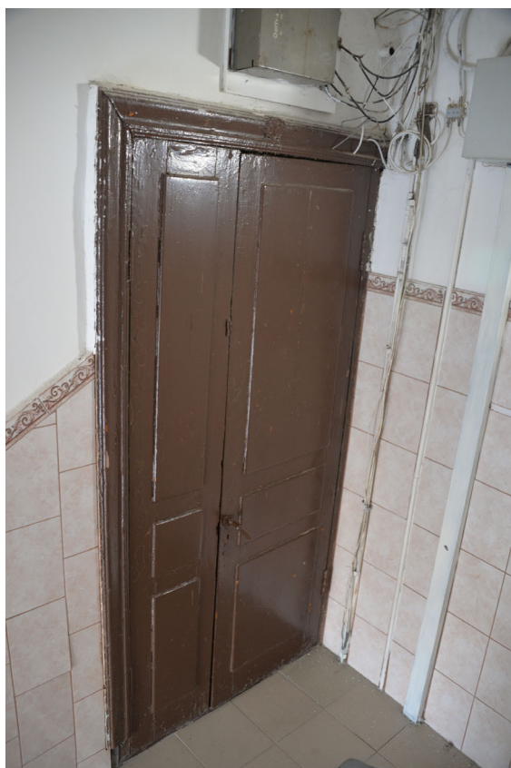
6. Входная дверь в квартиру №16
