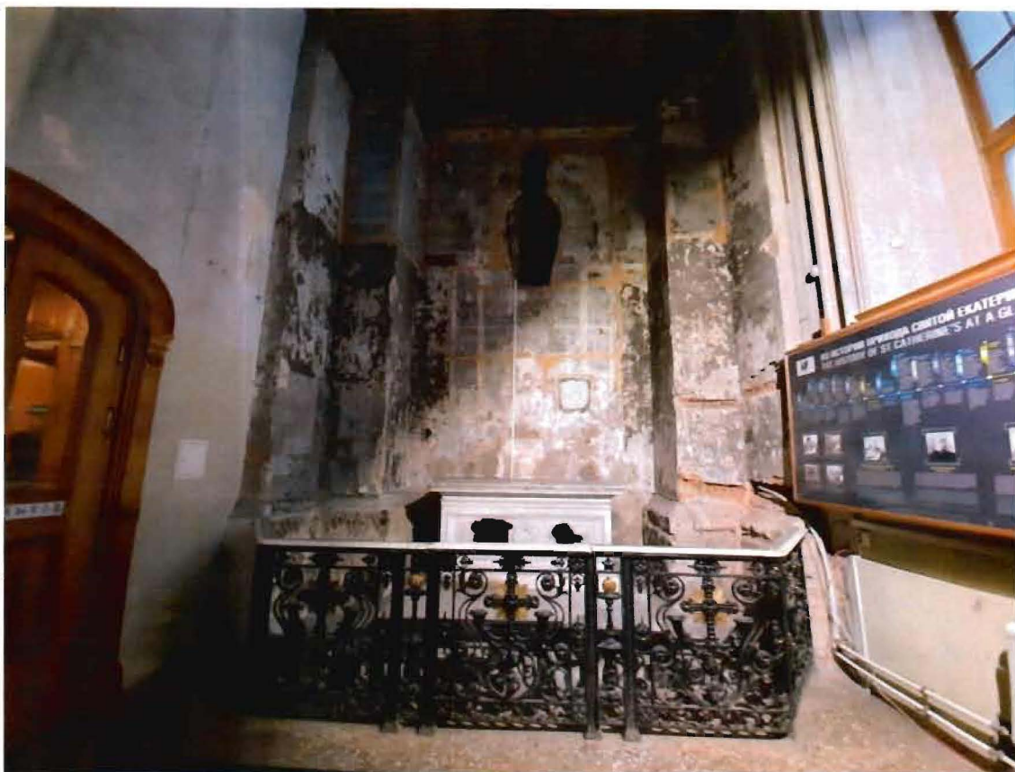
6. Интерьеры объекта культурного наследия. Пом. 95-Н (3) (09.02.2022)
