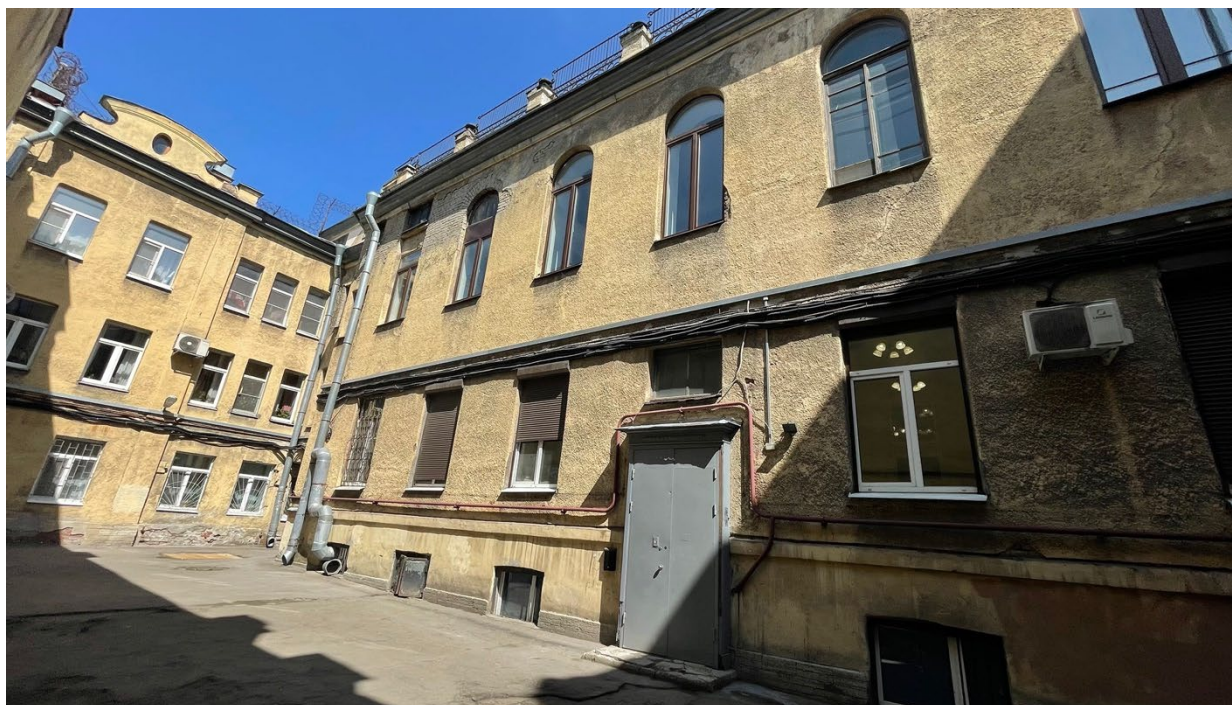
13. Вид на дворовой фасад объекта культурного наследия регионального значения «Особняк А.Нейдгарта. 1910 г. Гр.инж.И.И.Бургазлиев» по адресу: Кирочная улица, дом 40, литера А (Салтыкова-Щедрина, 40);
