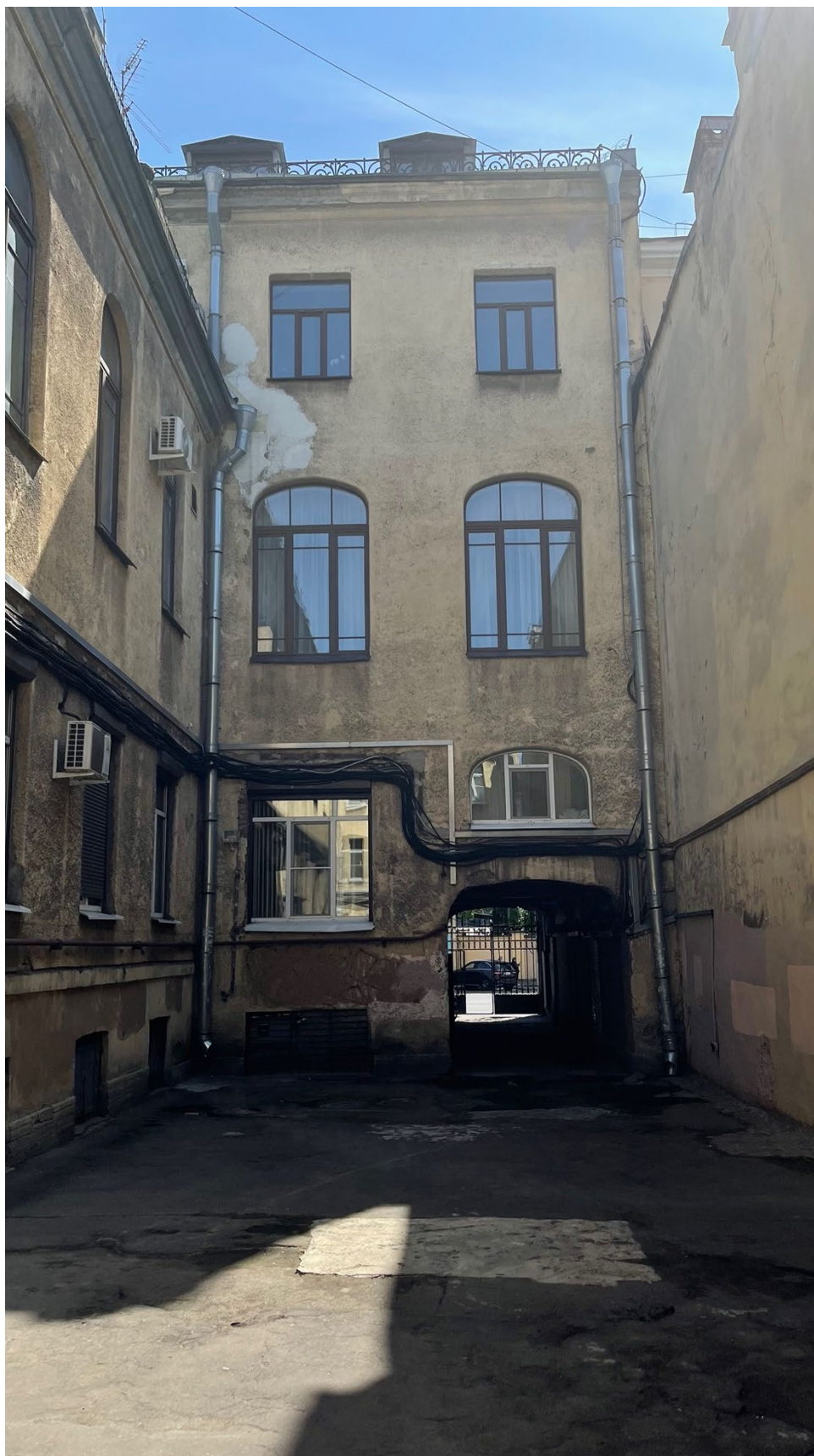
12. Вид на дворовой фасад объекта культурного наследия регионального значения «Особняк А.Нейдгарта. 1910 г. Гр.инж.И.И.Бургазлиев» по адресу: Кирочная улица, дом 40, литера А (Салтыкова-Щедрина, 40);
