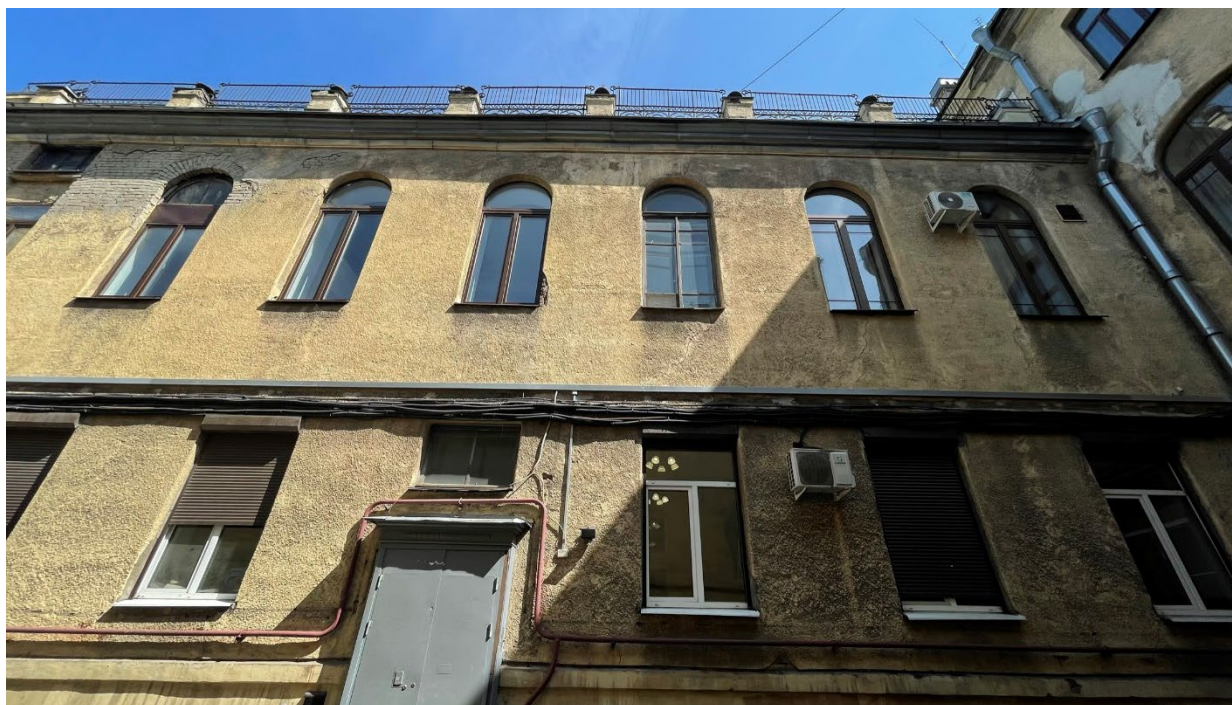
15. Вид на дворовой фасад объекта культурного наследия регионального значения «Особняк А.Нейдгарта. 1910 г. Гр.инж.И.И.Бургазлиев» по адресу: Кирочная улица, дом 40, литера А (Салтыкова-Щедрина, 40);
