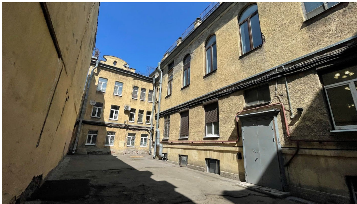
11. Вид на дворовой фасад объекта культурного наследия регионального значения «Особняк А.Нейдгарта. 1910 г. Гр.инж.И.И.Бургазлиев» по адресу: Кирочная улица, дом 40, литера А (Салтыкова-Щедрина, 40);
