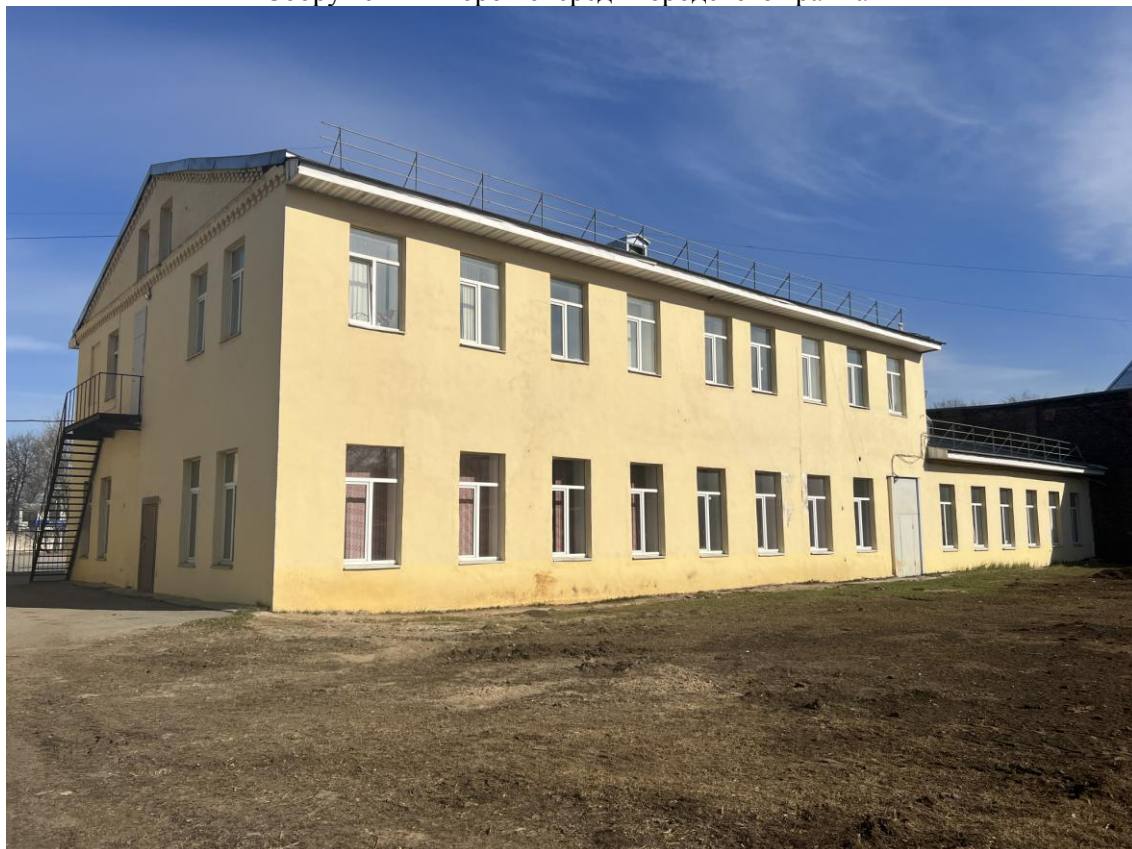
Фото 6. Фрагмент лицевого фасада выявленного объекта культурного наследия «Административное здание», входящего в состав выявленного объекта культурного наследия «Сооружения Второй очереди городского трамвая»
