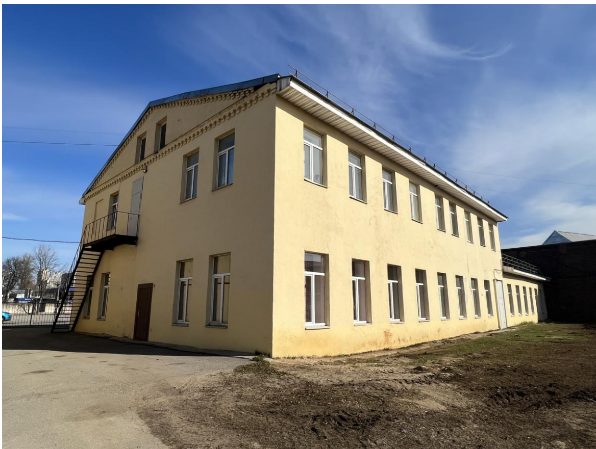
Фото 5. Фрагмент лицевого фасада выявленного объекта культурного наследия «Административное здание», входящего в состав выявленного объекта культурного наследия «Сооружения Второй очереди городского трамвая»
