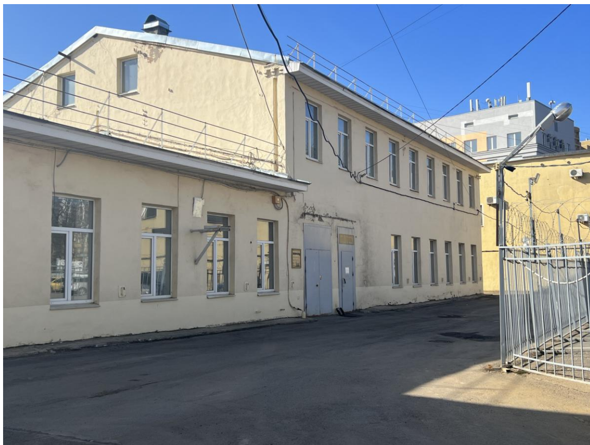
Фото 1. Фрагмент лицевого фасада выявленного объекта культурного наследия «Административное здание», входящего в состав выявленного объекта культурного наследия «Сооружения Второй очереди городского трамвая»
