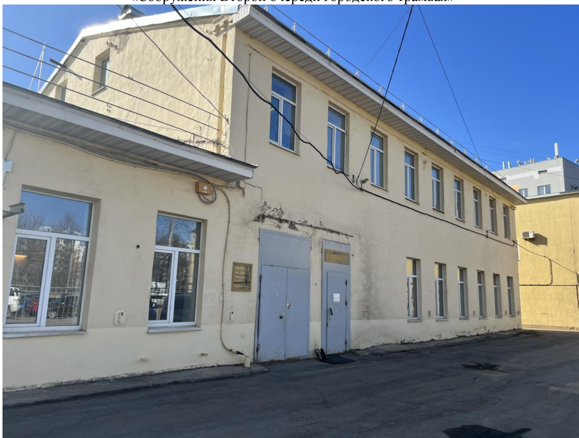
Фото 2. Фрагмент лицевого фасада выявленного объекта культурного наследия «Административное здание», входящего в состав выявленного объекта культурного наследия «Сооружения Второй очереди городского трамвая»
