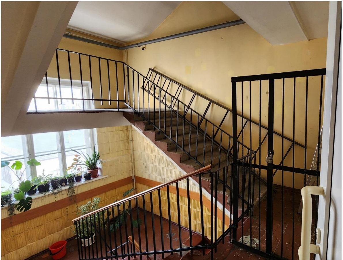
Фото 11. Парадная лестница. Вид с междуэтажной площадки 4-го и 5-го этажей.
