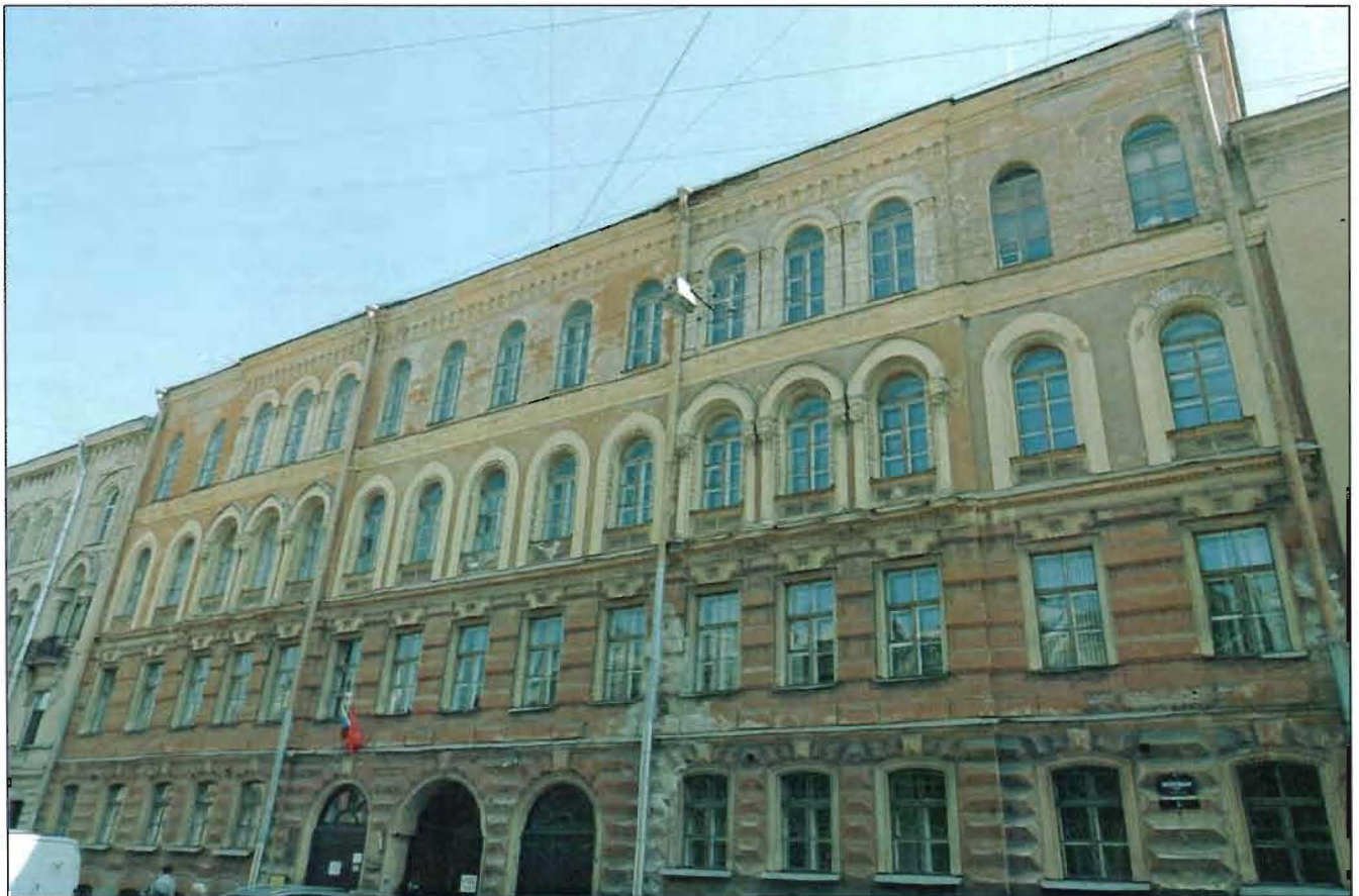
1. Лицевой фасад по Моховой улице.
