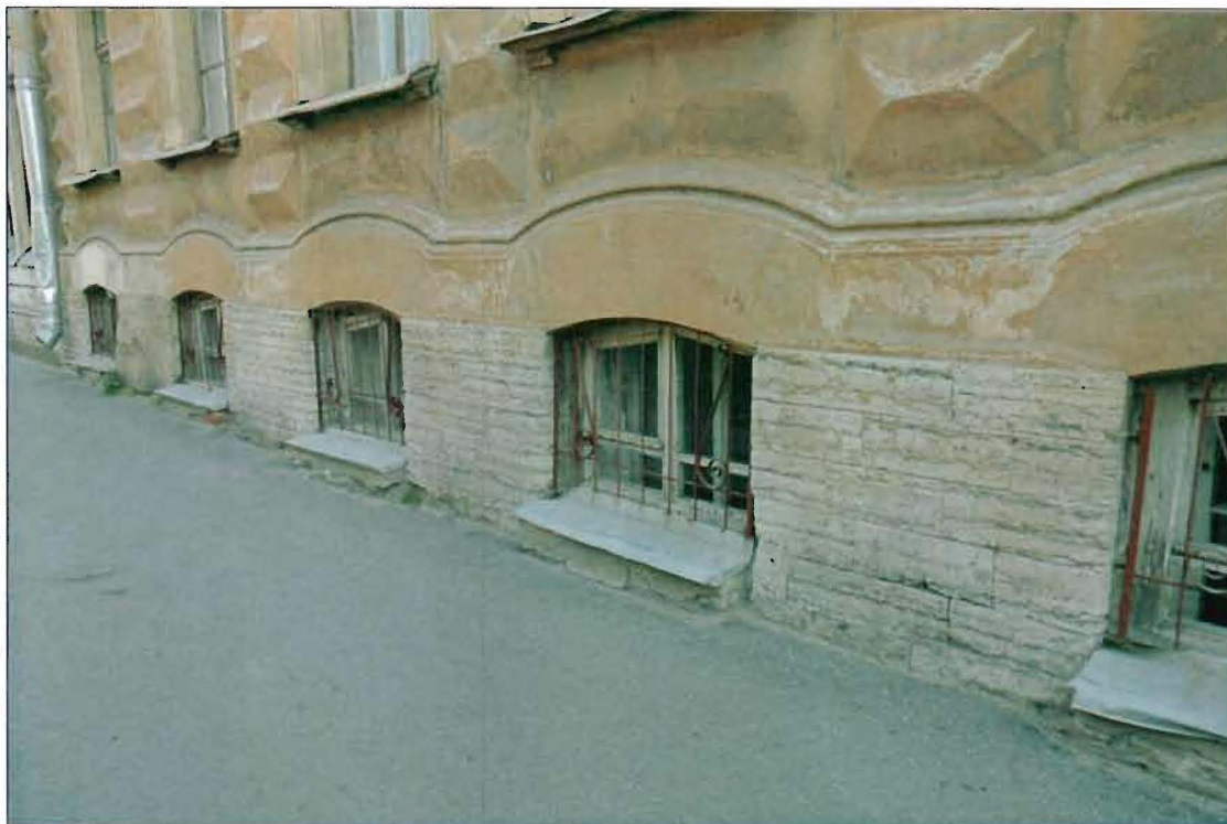
2. Лицевой фасад. Фрагмент. Цоколь.
