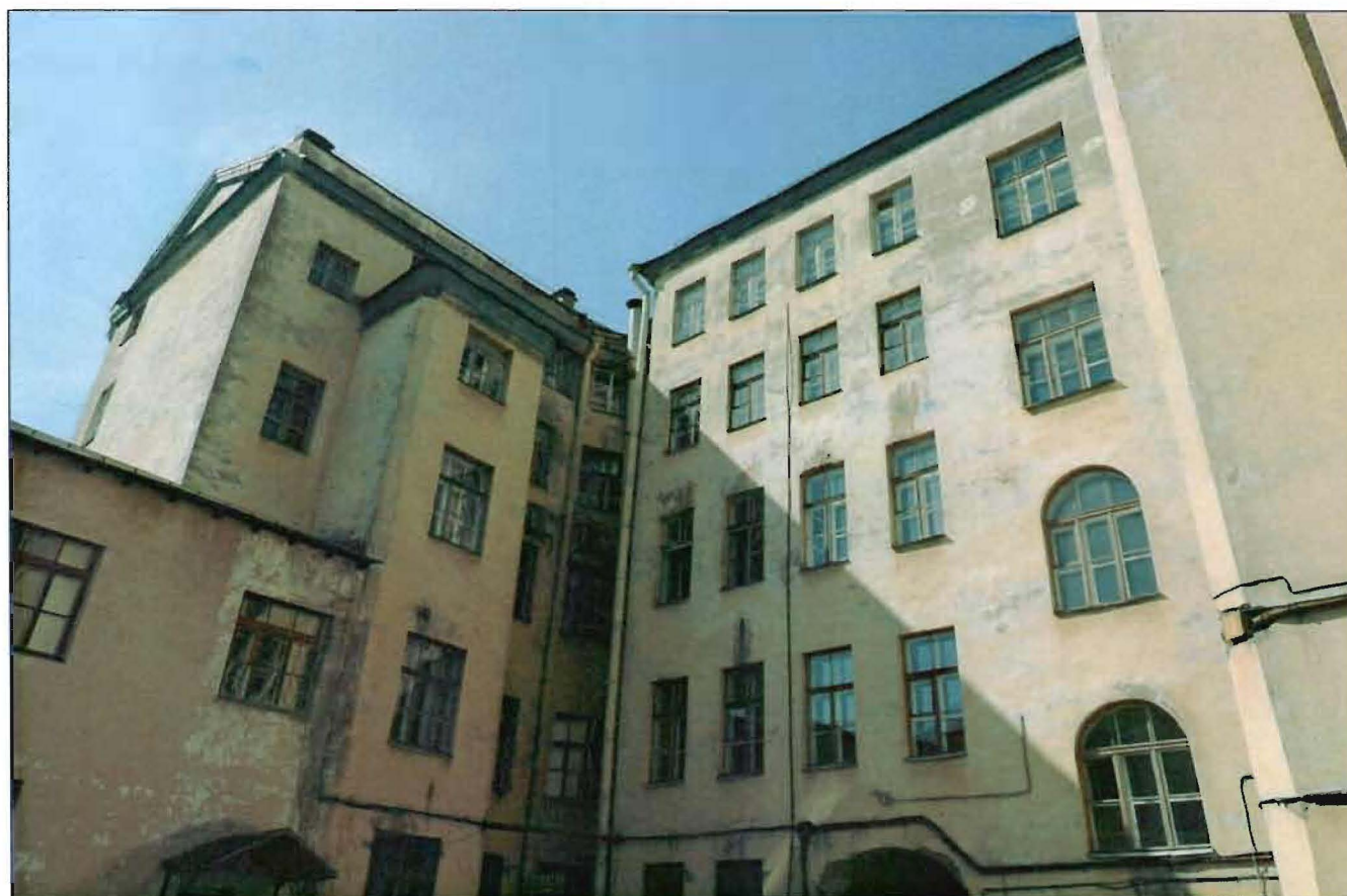
6. Общий вид дворовых фасадов.
