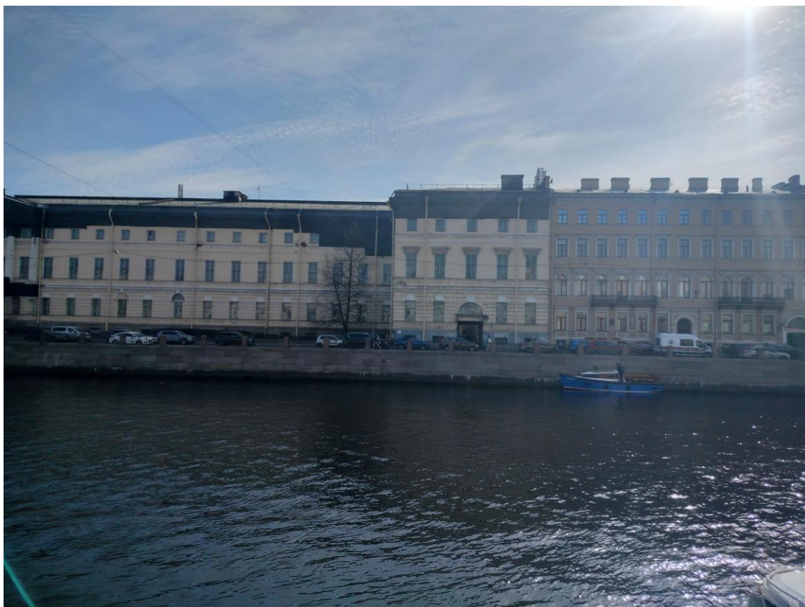
Фото 3. Фрагмент лицевого фасада объекта культурного наследия федерального значения «Институт», входящего в состав объекта культурного наследия федерального значения «Институт Екатерининский»
