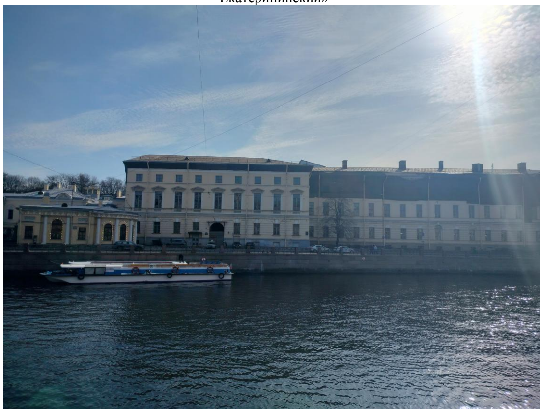
Фото 2. Фрагмент лицевого фасада объекта культурного наследия федерального значения «Институт», входящего в состав объекта культурного наследия федерального значения «Институт Екатерининский»
