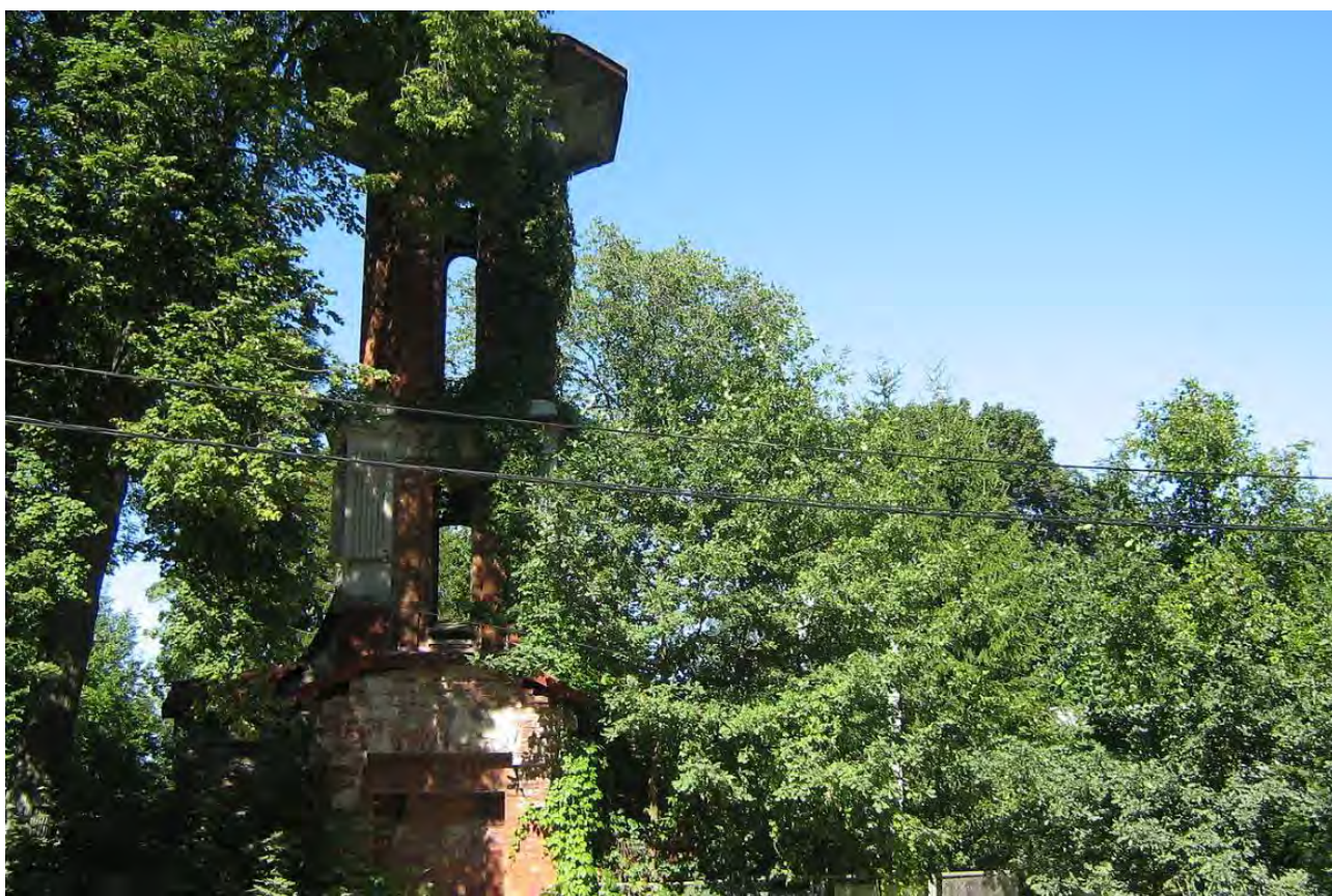
Водонапорная башня. Усадьба Мордвиновых. 2011 г. Источник: Retro View of Mankind's Habitat. [Электронный ресурс]. Режим доступа: https://www.pastvu.com
