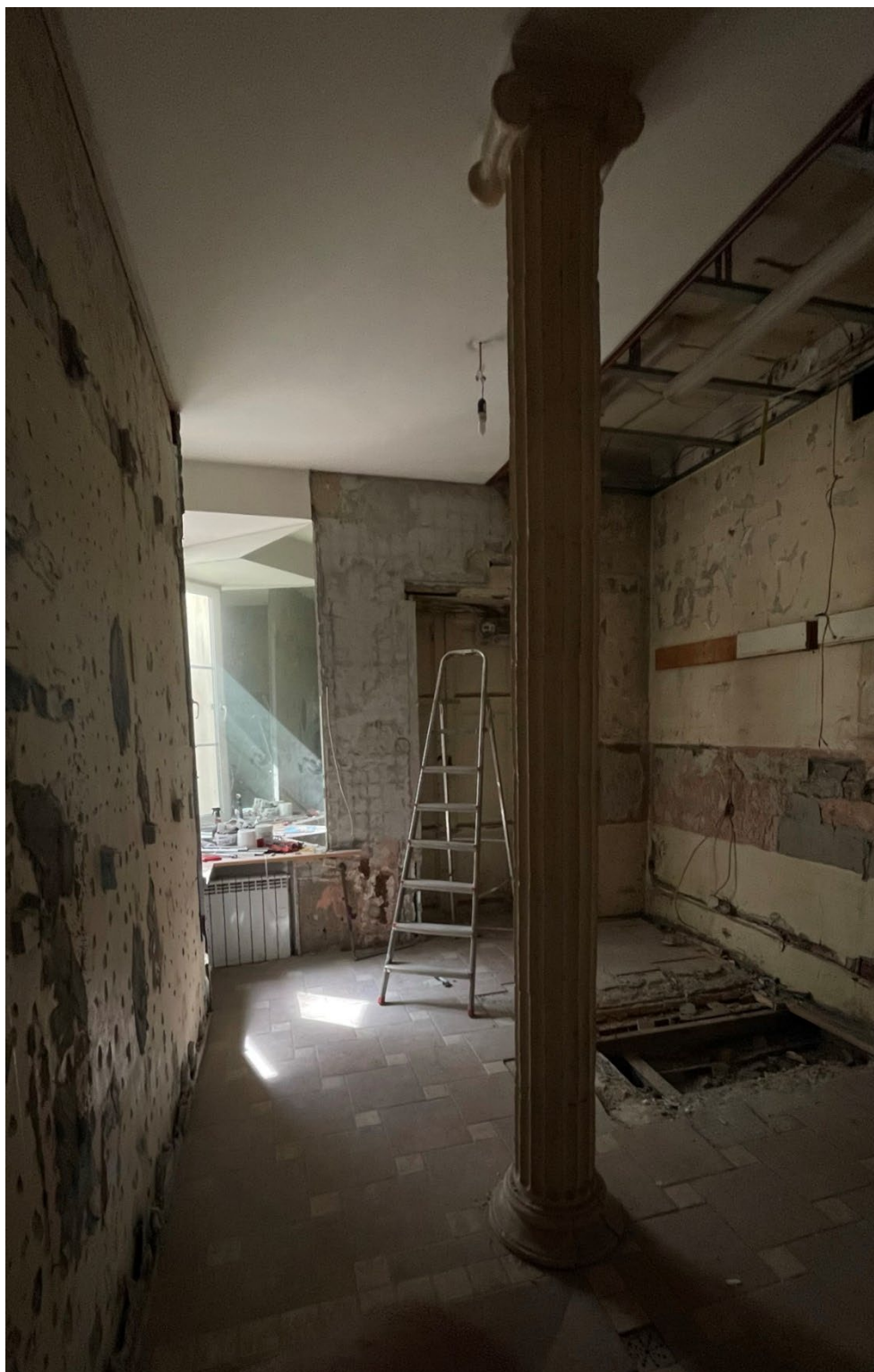
21.Фрагмент интерьера кухни (помещение 12/11);
