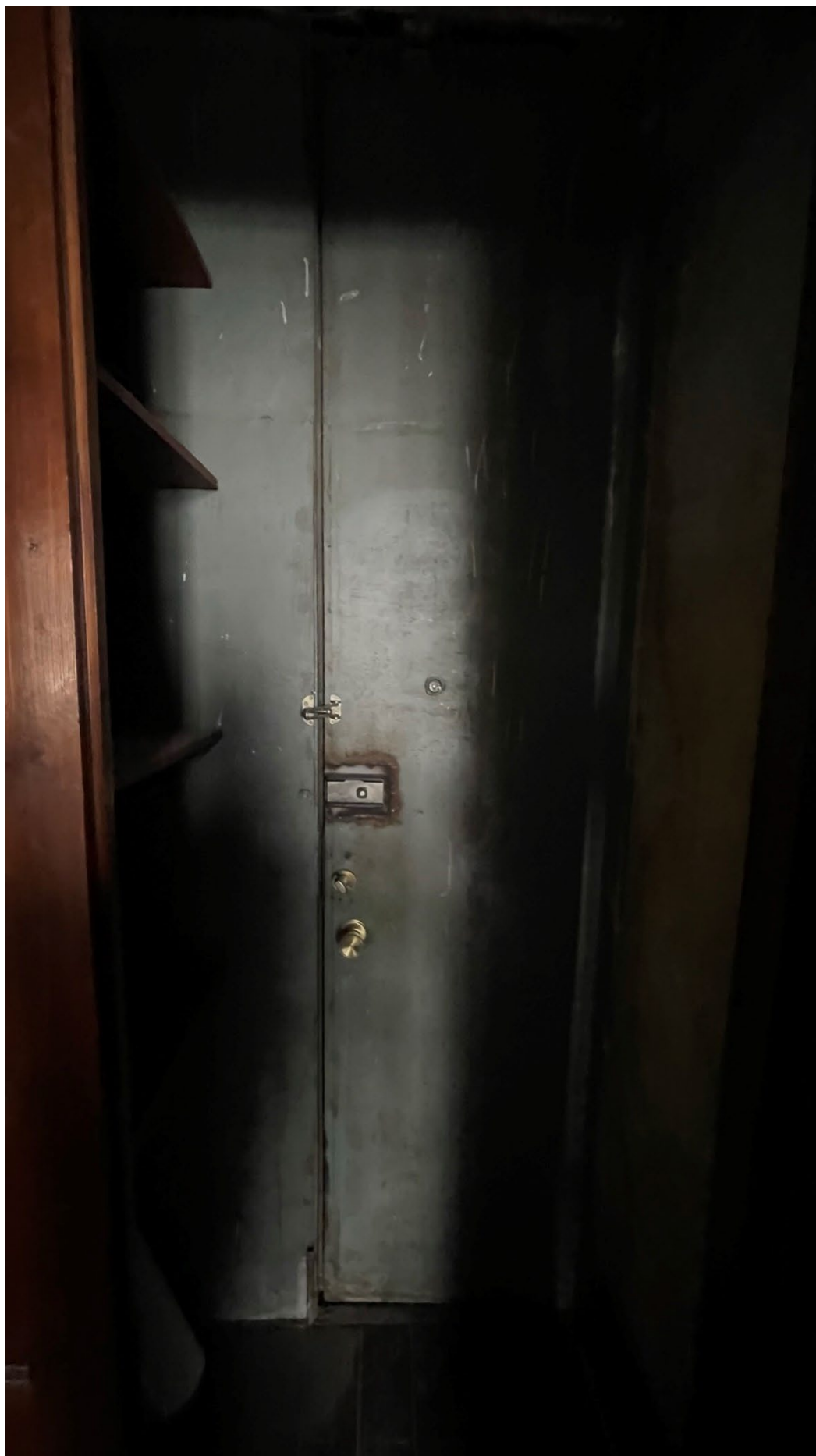
4. Вид на входную дверь в квартире;
