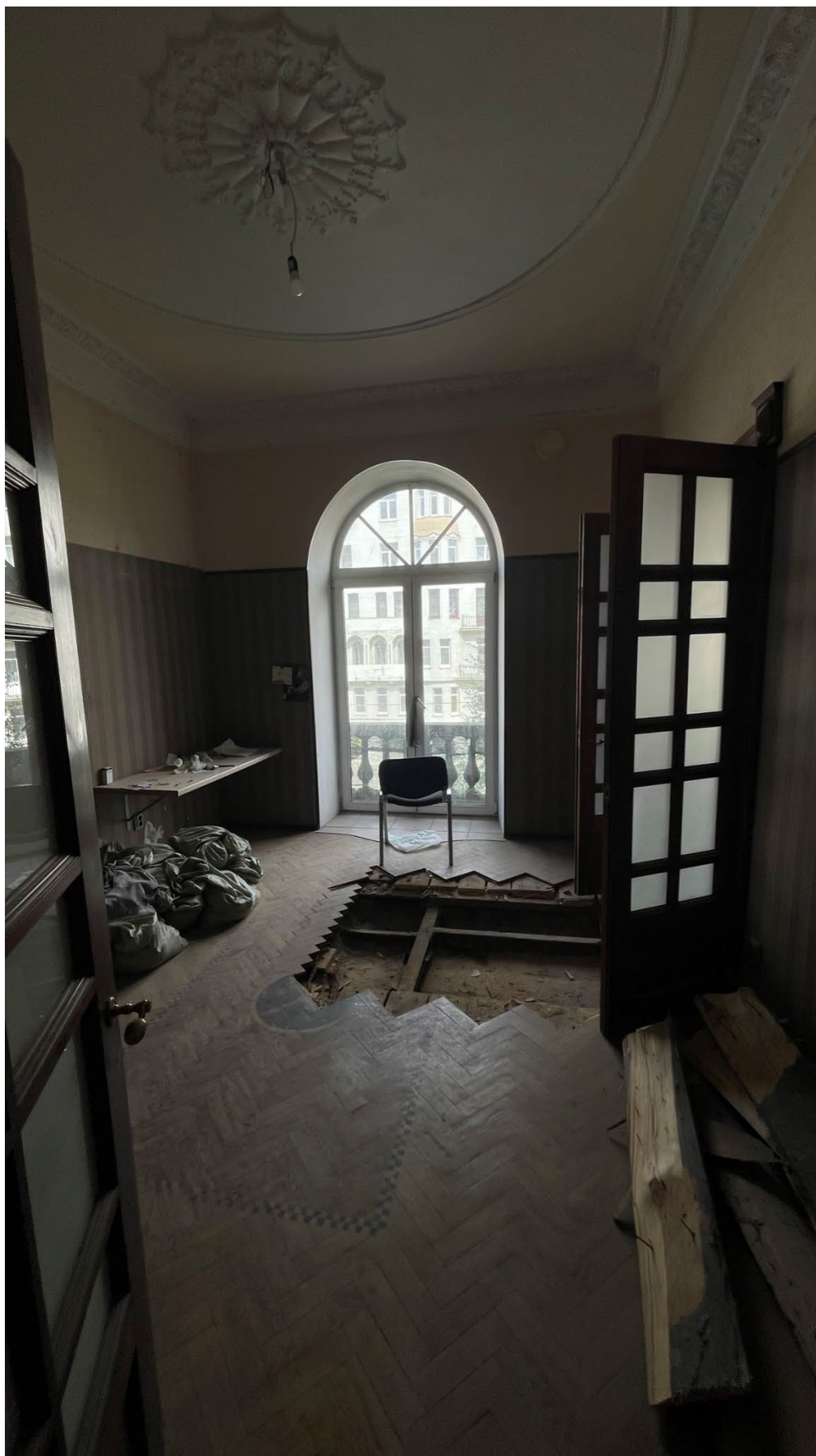
13.Фрагмент интерьера комнаты (помещение 3/16.4);
