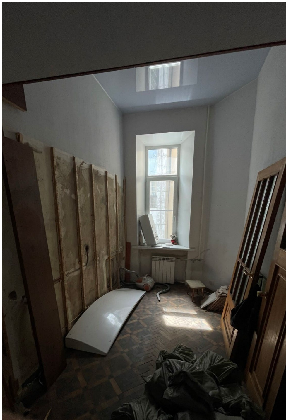
20. Фрагмент интерьера комнаты (помещение 11/10);
