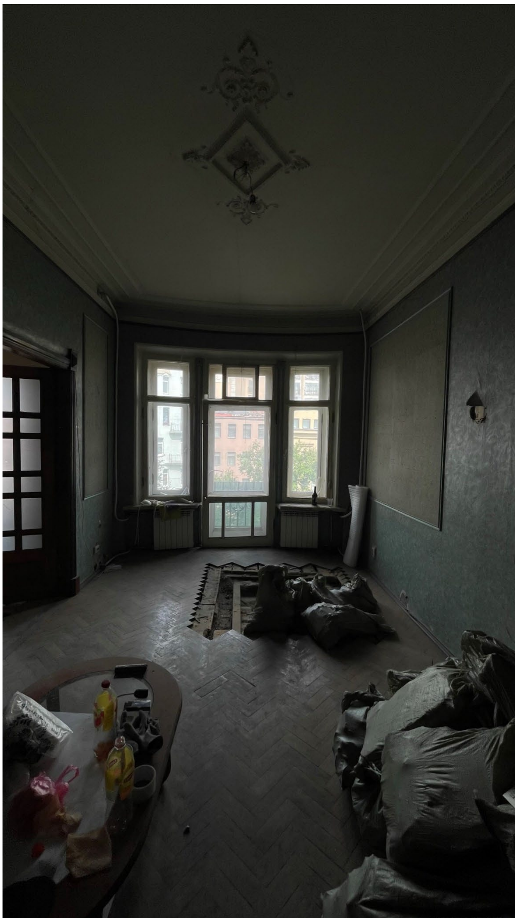
10. Фрагмент интерьера комнаты (помещение 4/20.1);
