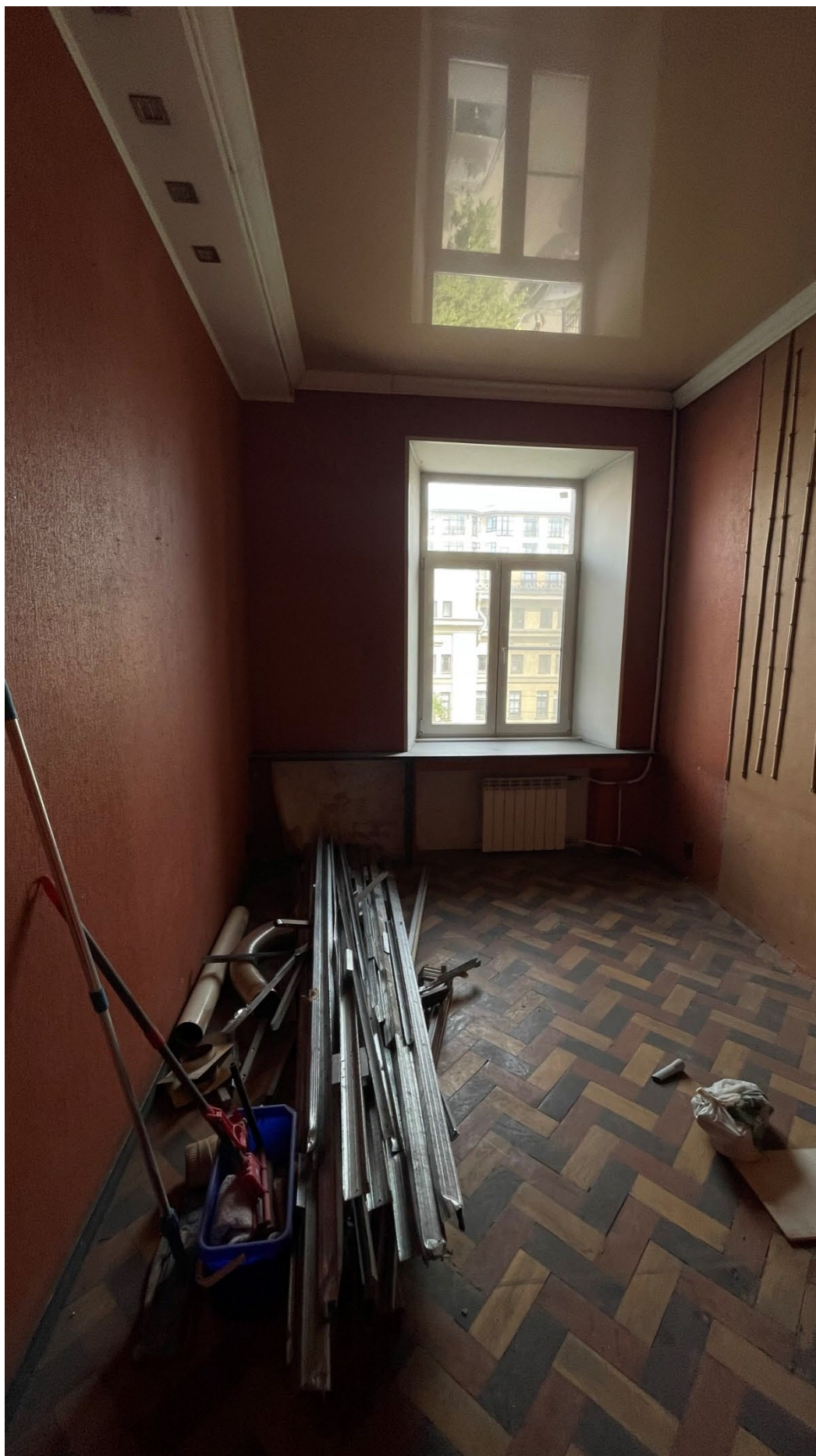
8. Фрагмент интерьера комнаты (помещение 5/14.3);
