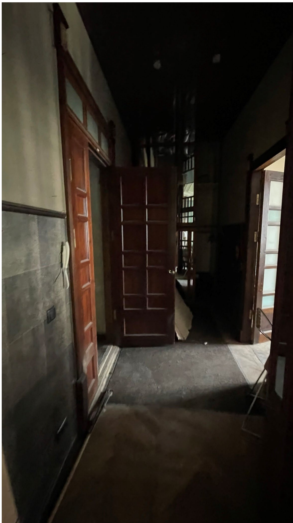
6. Фрагмент интеръера коридора (помещение 1/5.9);
