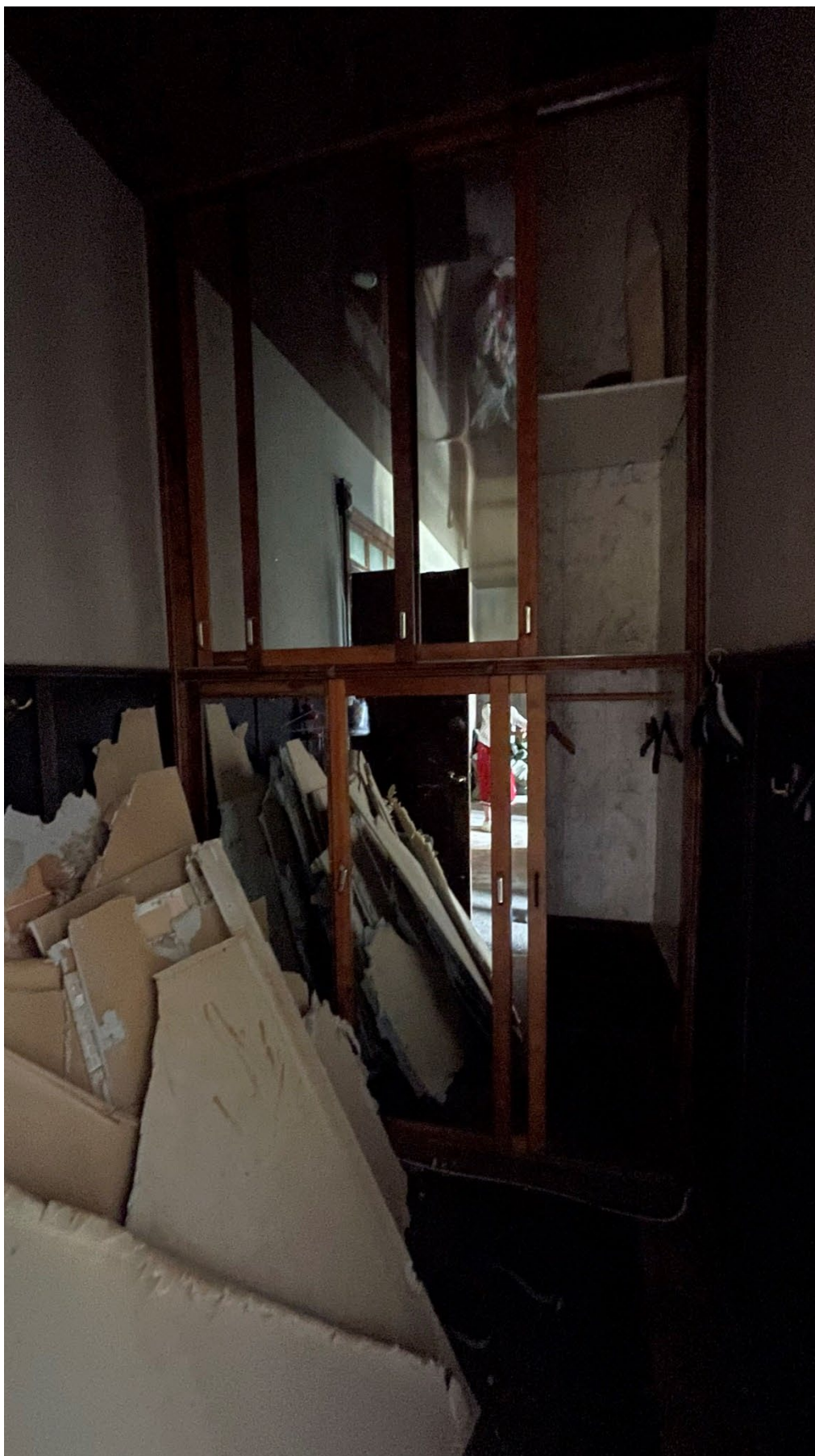
7. Фрагмент интеръера коридора (помещение 1/5.9);
