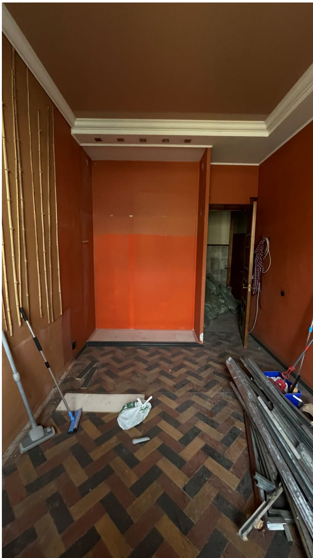
9. Фрагмент интерьера комнаты (помещение 5/14.3);
