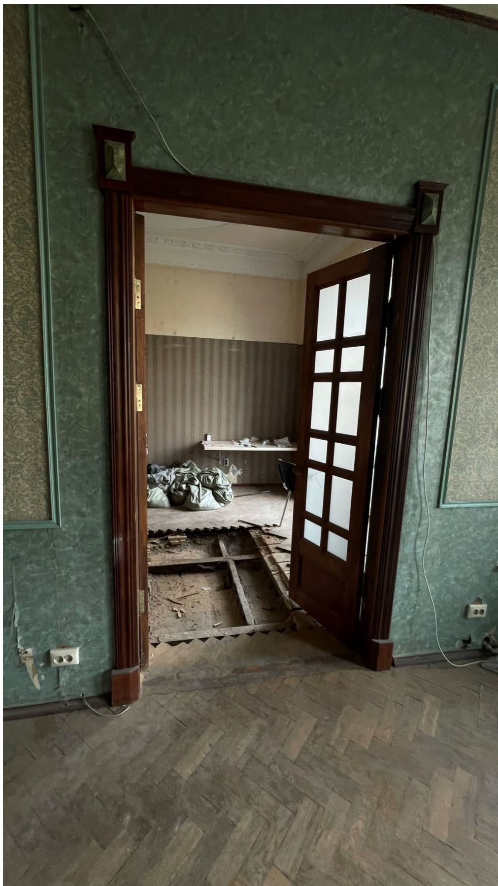
12.Фрагмент интерьера комнаты (помещение 4/20.1);
