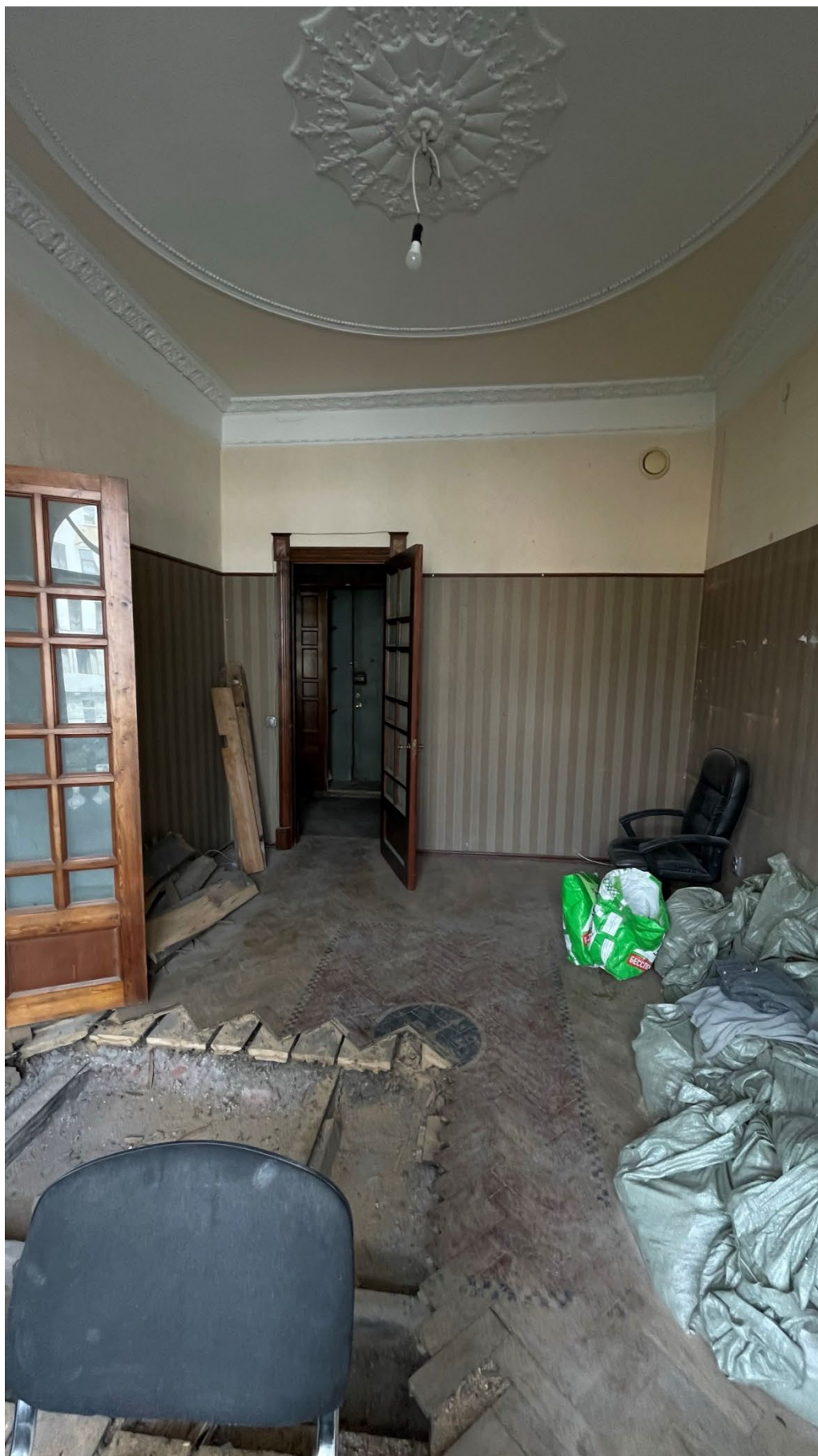
14. Фрагмент интерьера комнаты (помещение 3/16.4);
