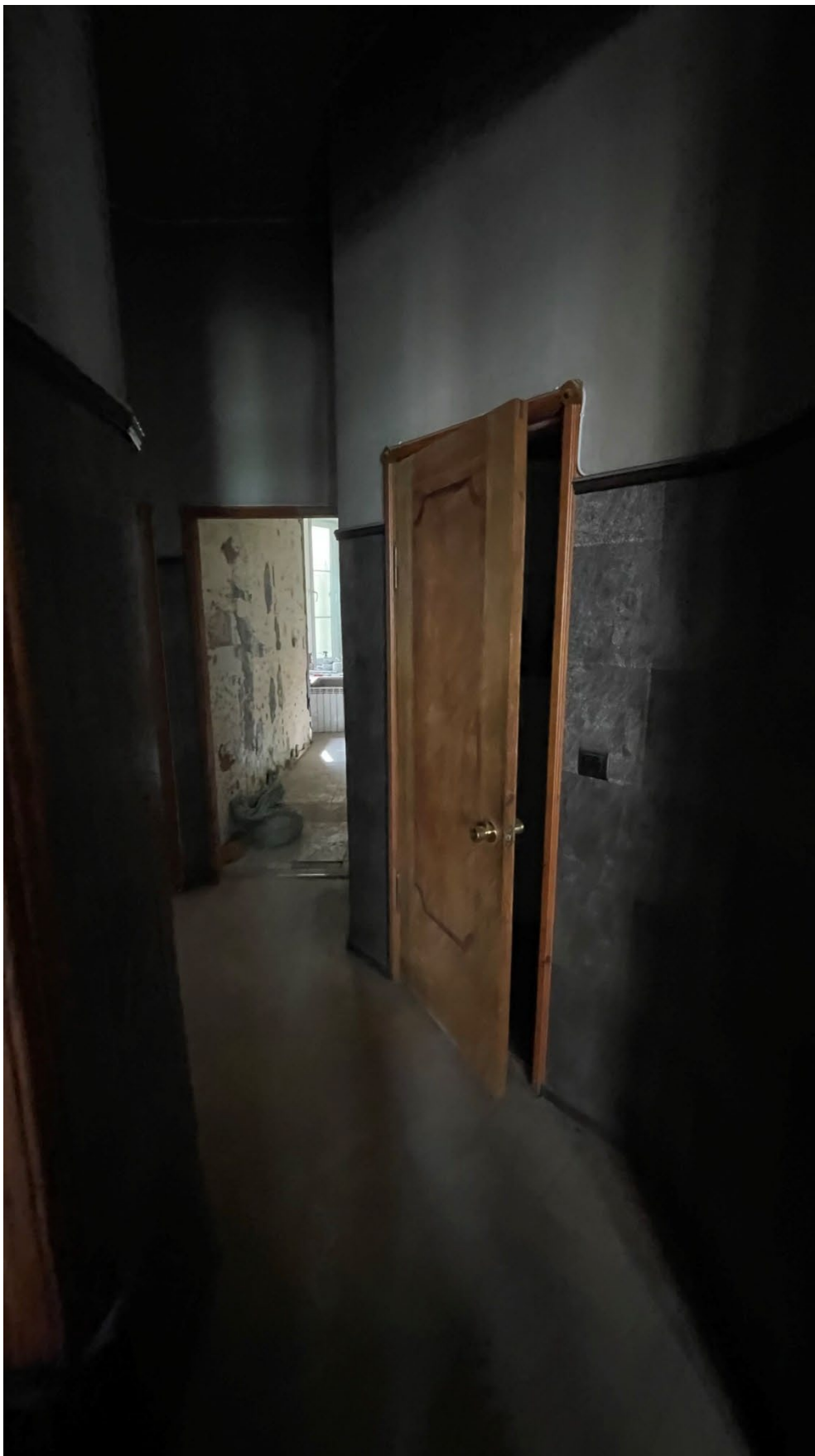
16. Фрагмент интеръера коридора (помещение 8/2.9);
