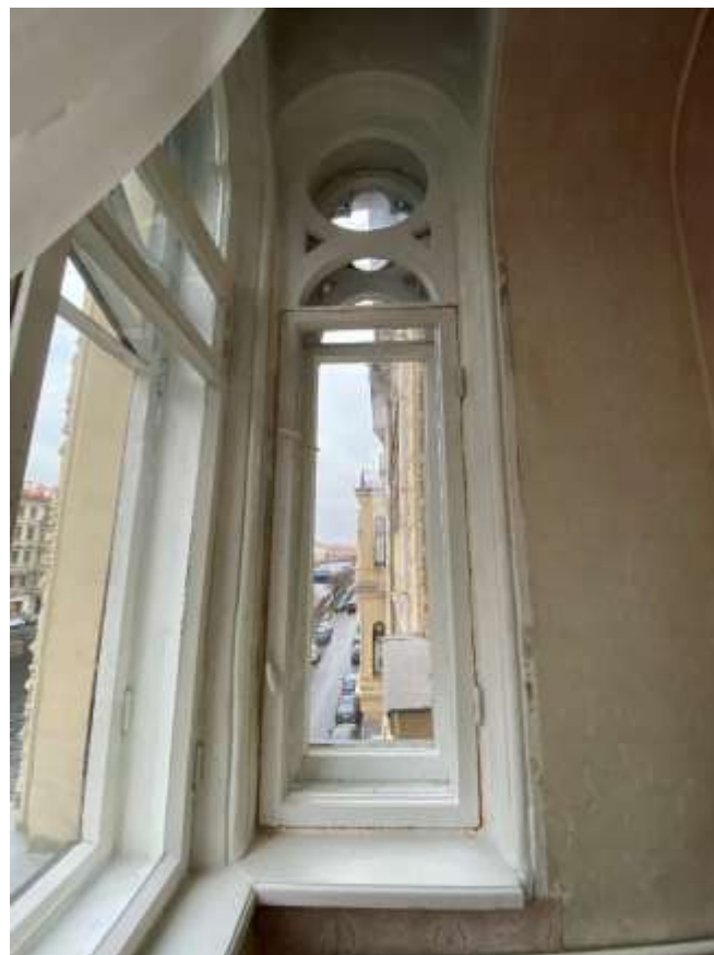
Фото 17. Помещение № 4. Историческое оконное заполнение. Вид с северо-востока.
