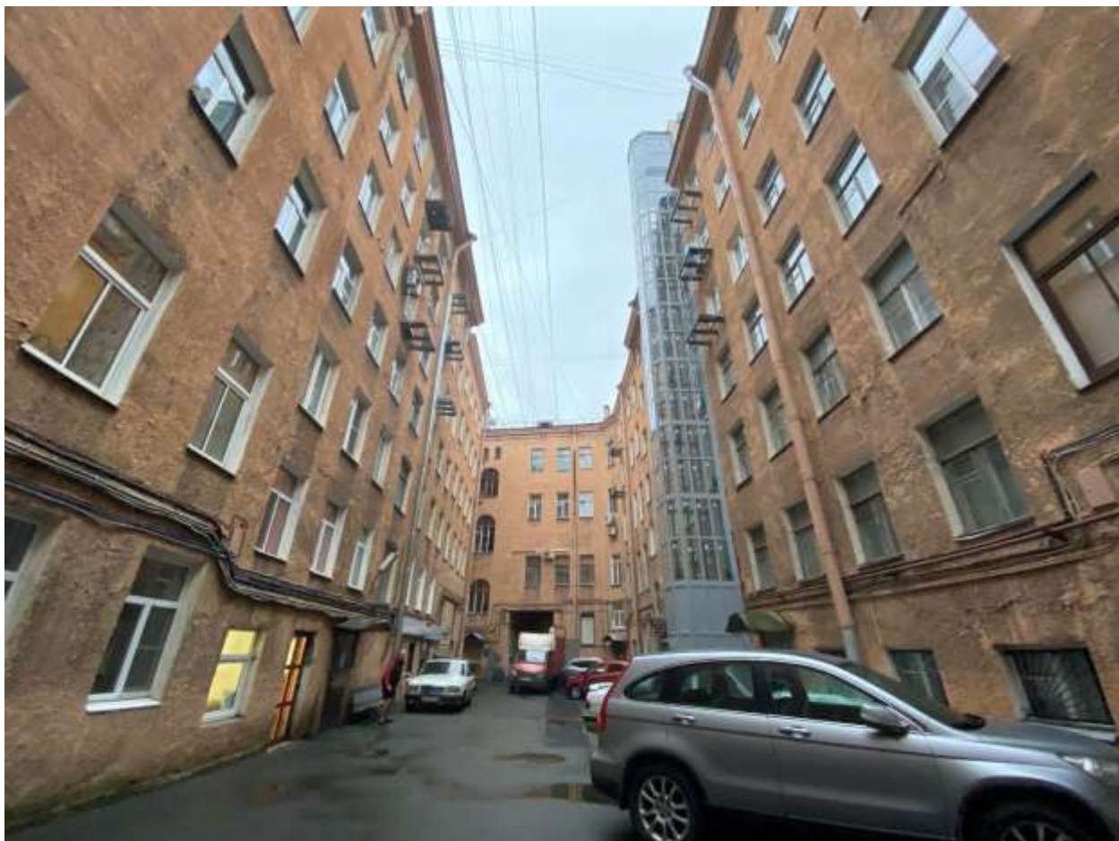
Фото 3. Общий вид дворовых фасадов. Вид с северо-запада.
