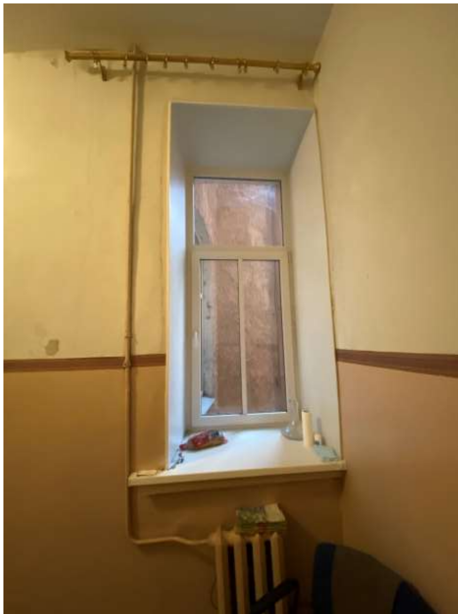
Фото 25. Помещение № 9. Кухня. Современное оконное заполнение. Вид с северо-запада.
