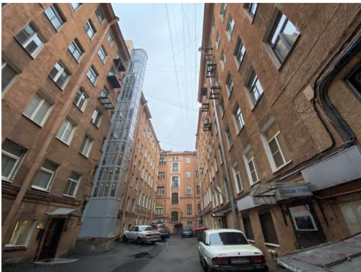
Фото 4. Общий вид дворовых фасадов. Вид с юго-востока.
