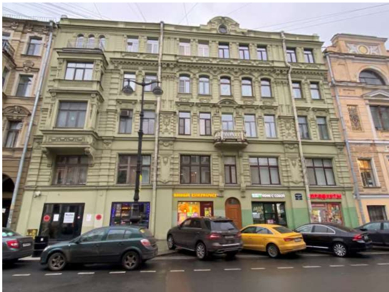
Фото 2. Лицевой фасад по Большой Морской улице. Вид с северо-запада.
