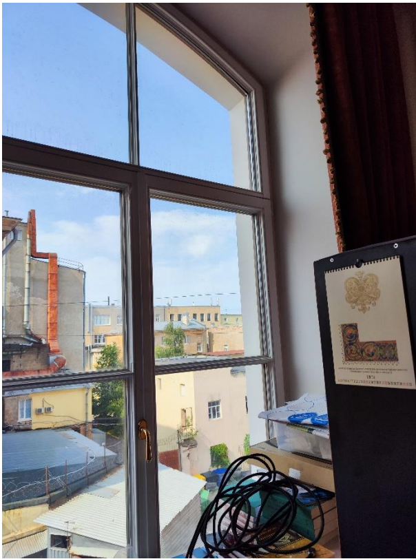
19. «Дом Боткина М.П.», ул. 18-я линия В.О., д.1, лит. А. Третий этаж. Помещение в осях 8-Г. Оконное заполнение. Фрагмент. Фото 22.06.2023г.
