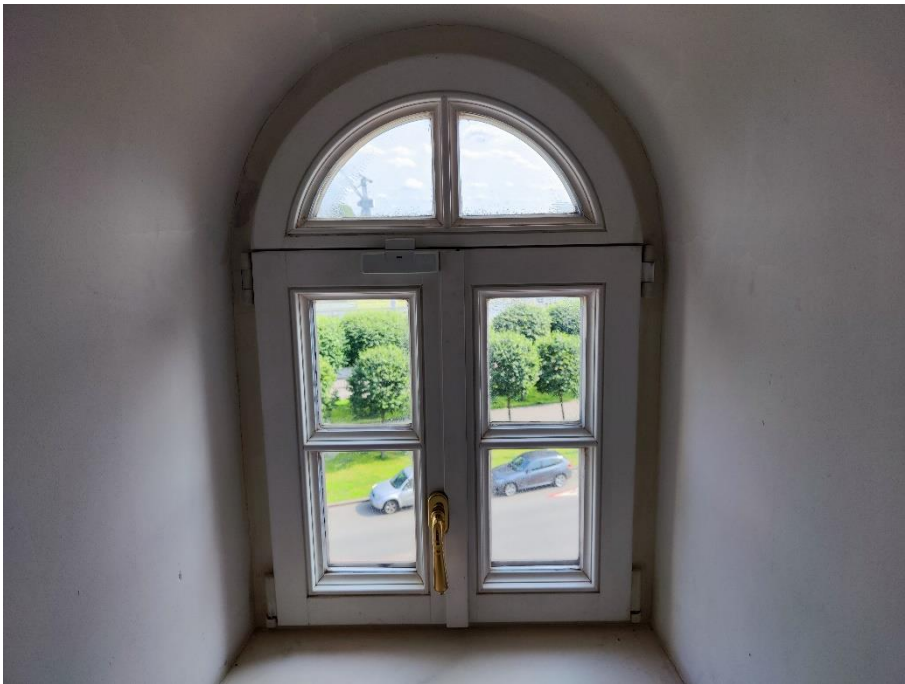
15. «Дом Боткина М.П.», ул. 18-я линия В.О., д.1, лит. А. Третий этаж. Помещение в осях 8-А. Оконное заполнение. Общий вид. Фото 22.06.2023г.
