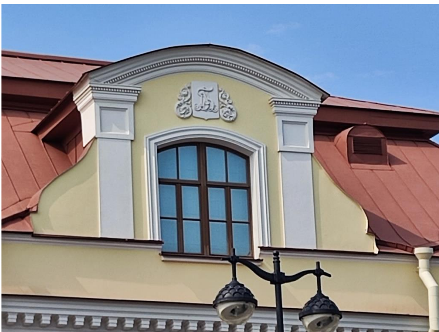
5. «Дом Боткина М.П.», ул. 18-я линия В.О., д.1, лит. А. Юго-восточный фасад. Фрагмент. Фото 22.06.2023г.
