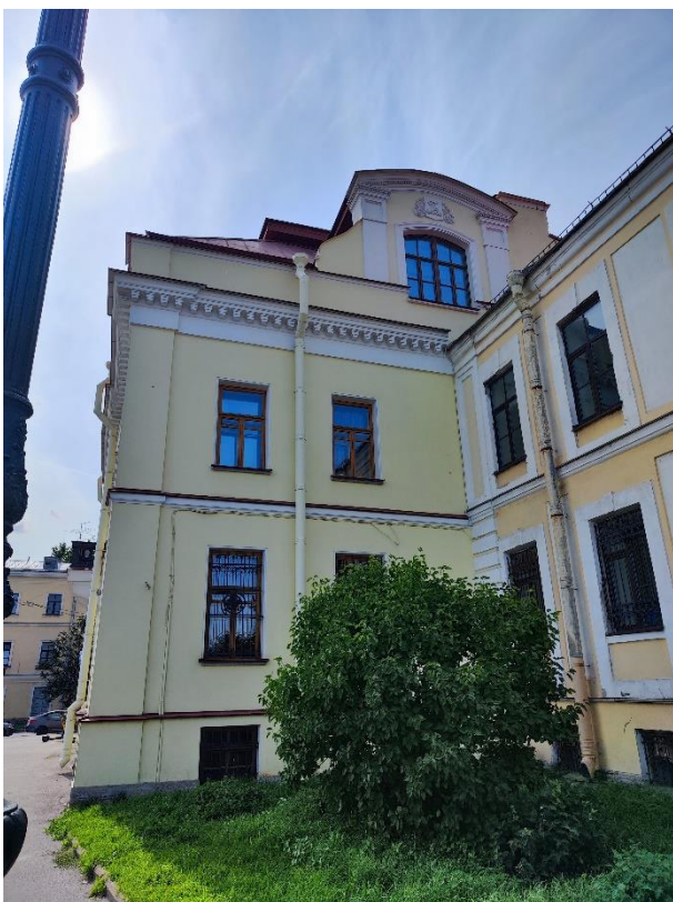
3. «Дом Боткина М.П.», ул. 18-я линия В.О., д.1, лит. А. Северо-восточный фасад. Общий вид. Фото 22.06.2023г.
