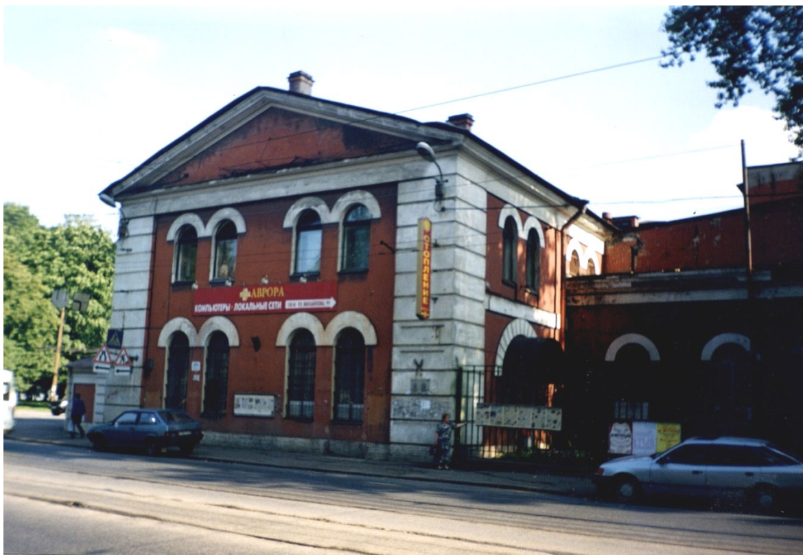
29. Арсенал. Вид с ул. Комсомола. Фото 2008 г. (28).
