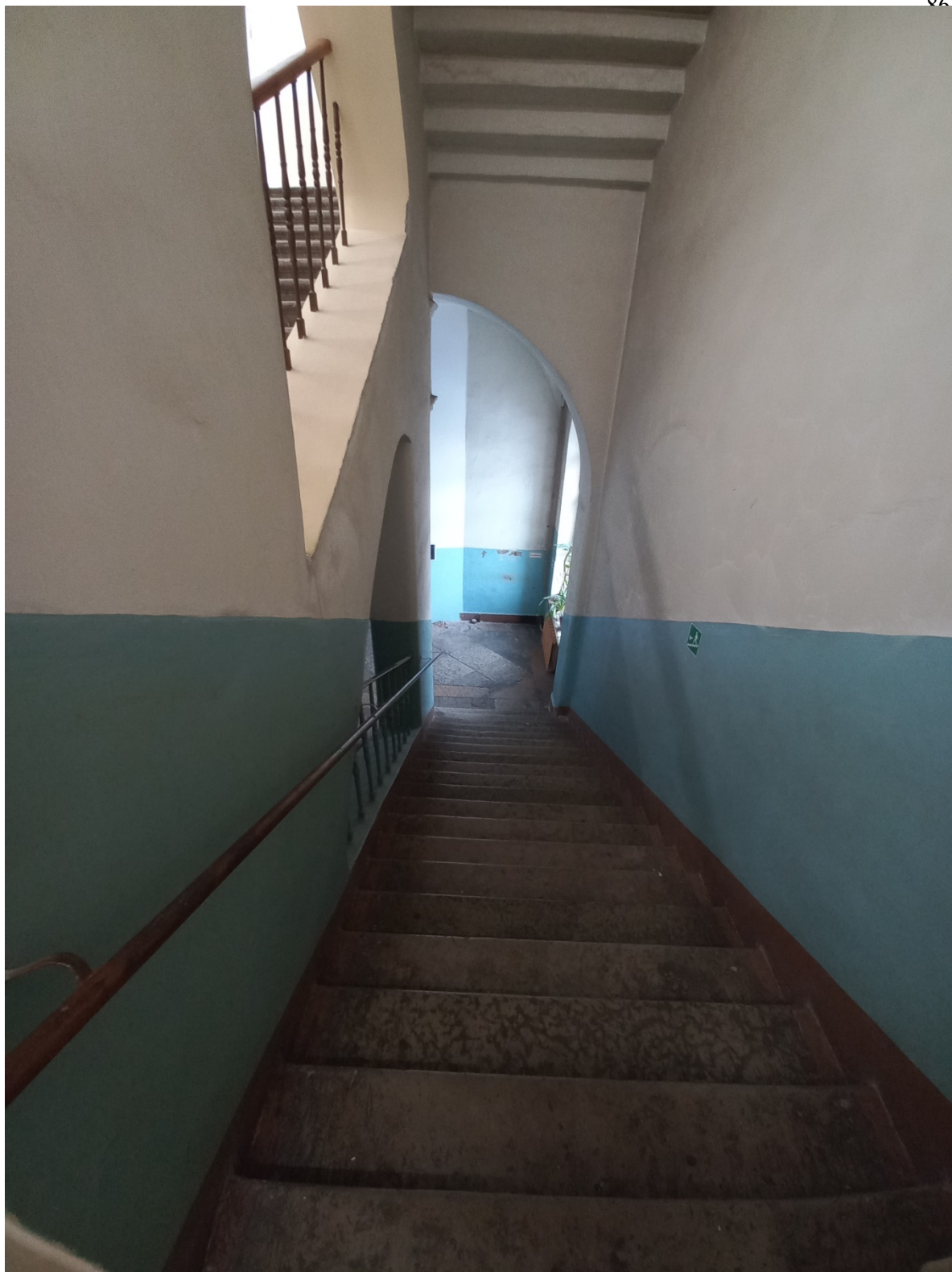
Фото 11. Вид на площадку 2 этажа.
