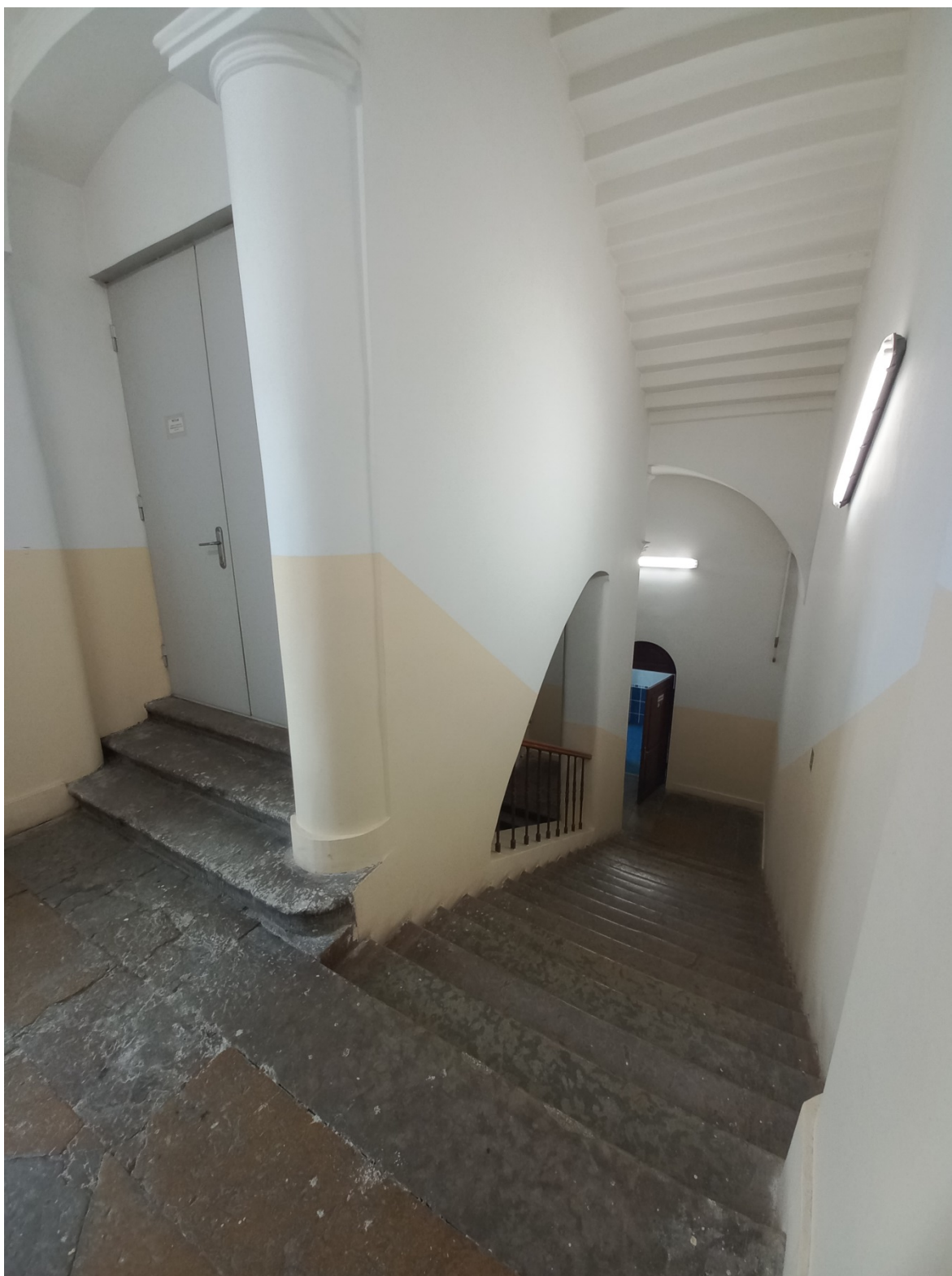
Фото 7. Вид с площадки 3 этажа.
