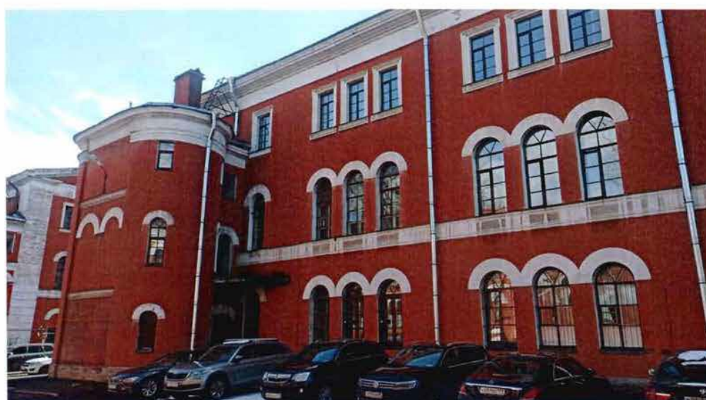
3. Вид на северный фасад объекта культурного наследия.
