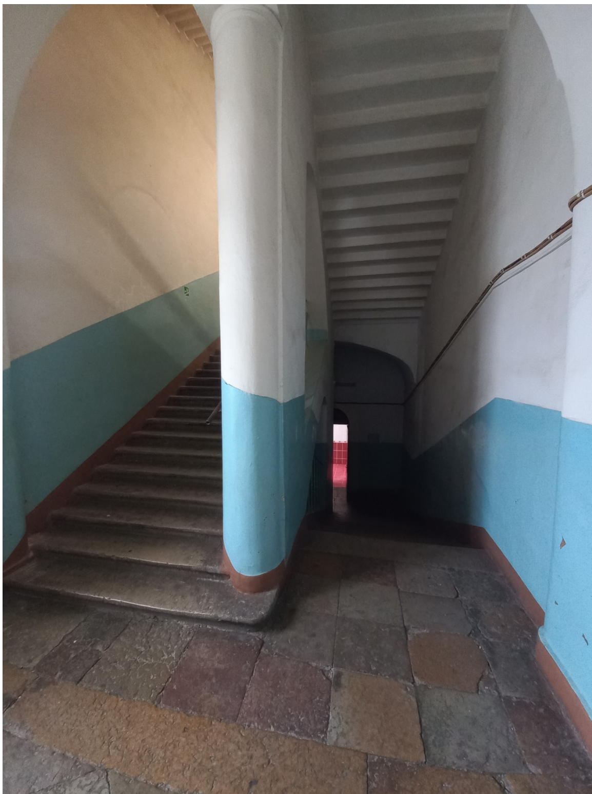
Фото 13. Вид с площадки 2 этажа.
