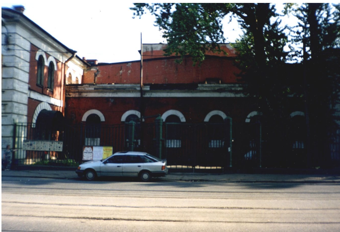
30. Арсенал. Вид с ул. Комсомола. Фото 2008 г. (28).
