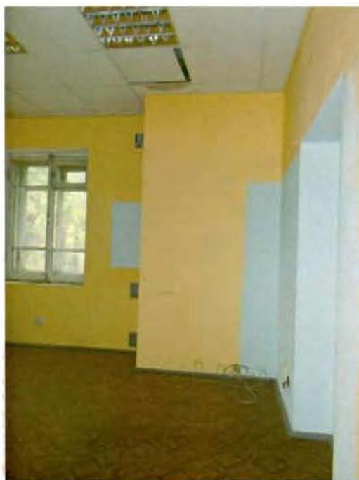
10. Интерьер помещения второго этажа.
