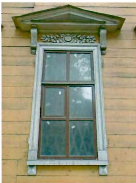
4. Оконный проем первого этажа.
