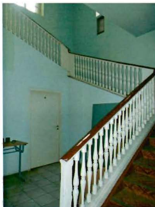
12. Ограждение лестничных маршей.
