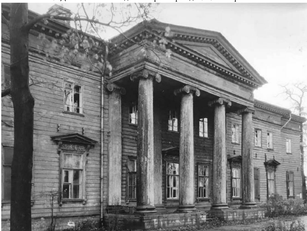
Илл. 46. Дача Головина. 1952 г. Главный (южный) фасад // Архив КГИОП
