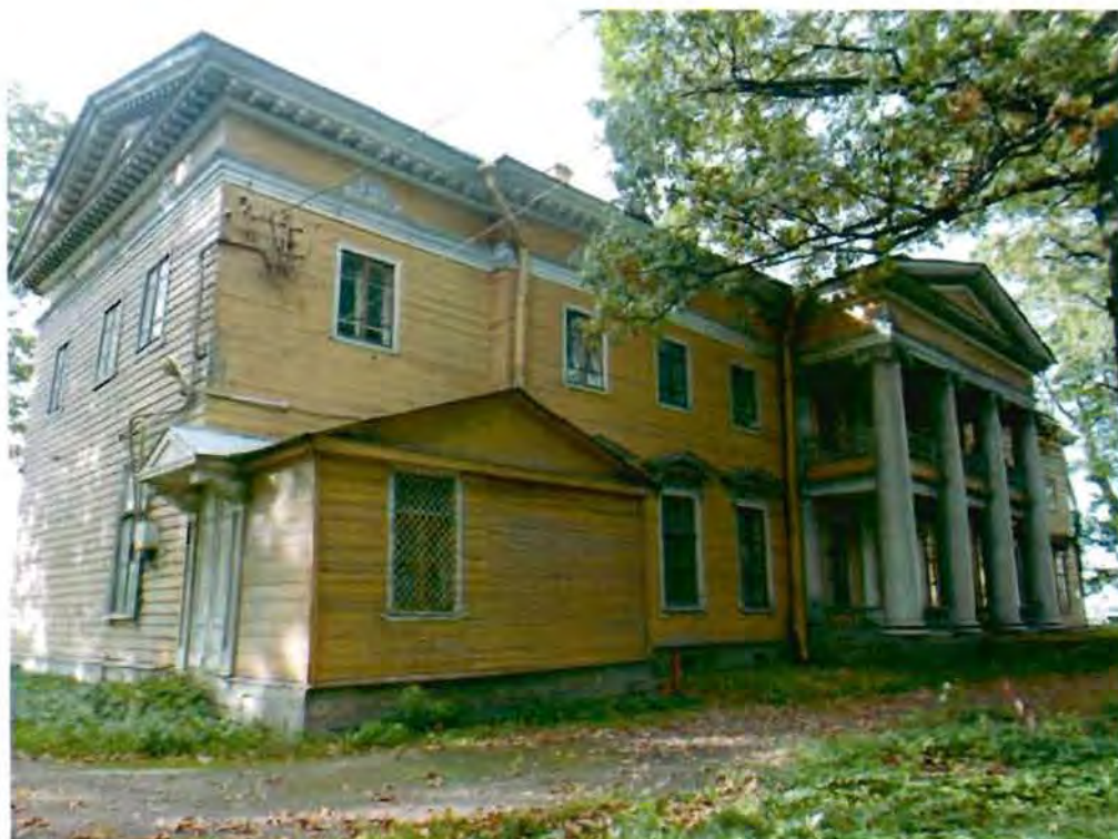
2. Общий вид с северо-востока.
