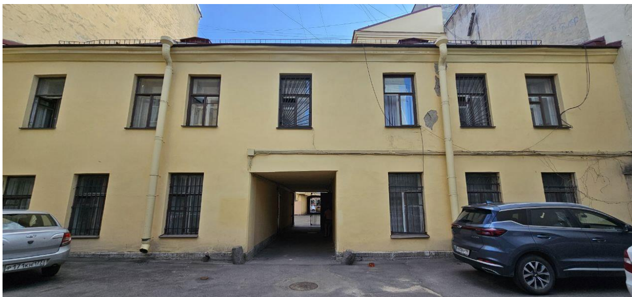
Фото 5. Общий вид дворовых фасадов объекта культурного наследия регионального значения «Дом А.И. Кракау».
