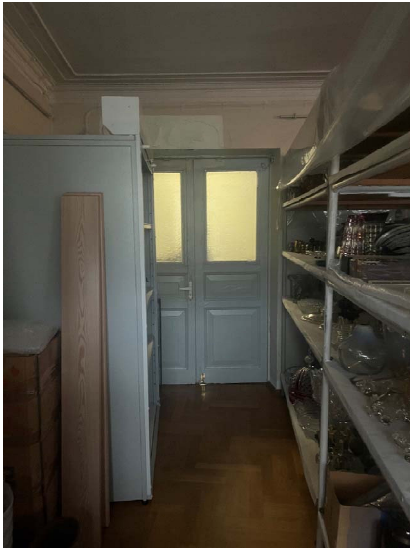
Фото №62. 2-ой этаж, помещение 1-Н(21).
