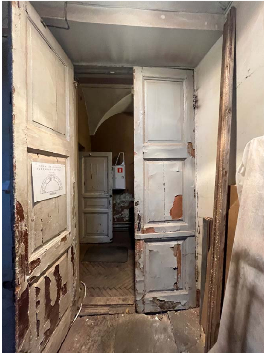
Фото №43. 1-ый этаж, западное крыло, помещение 1-Н(10), дверное заполнение.
