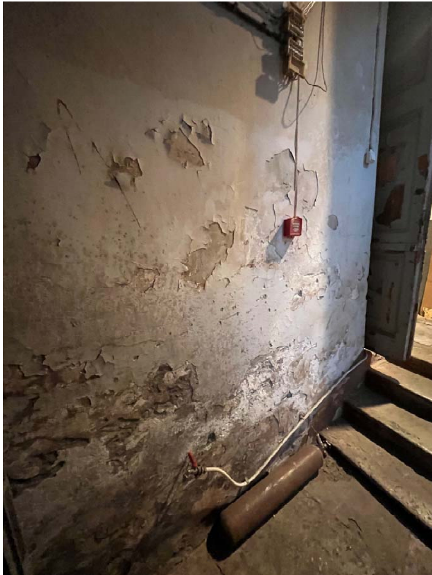
Фото №41. 1-ый этаж, западное крыло, помещение 1-Н(10), лестничная клетка.
