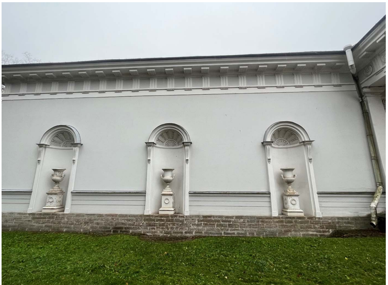
Фото №9. Северный фасад, фрагмент.
