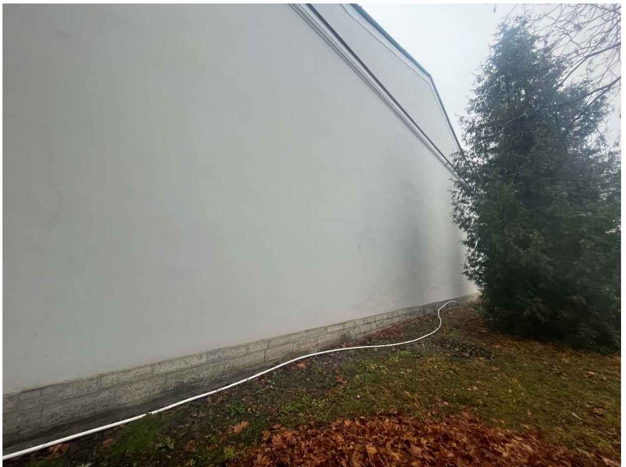
Фото 17. Дворовый южный фасад.
