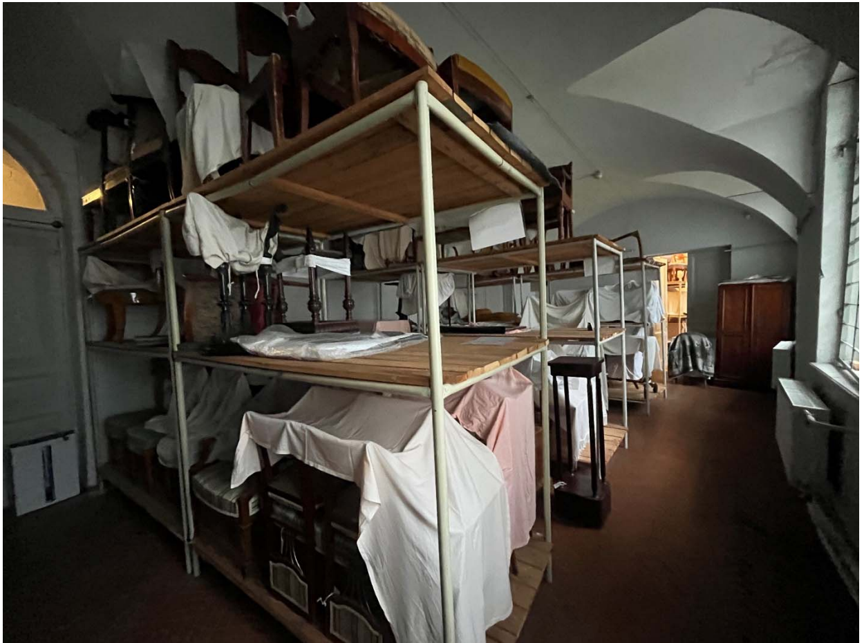
Фото №31. 1-ый этаж, восточное крыло, помещение 1-Н(4).
