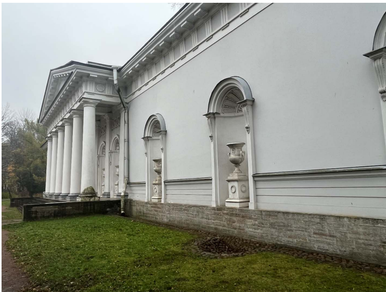
Фото 12. Северный фасад, конструкции лестницы портика.
