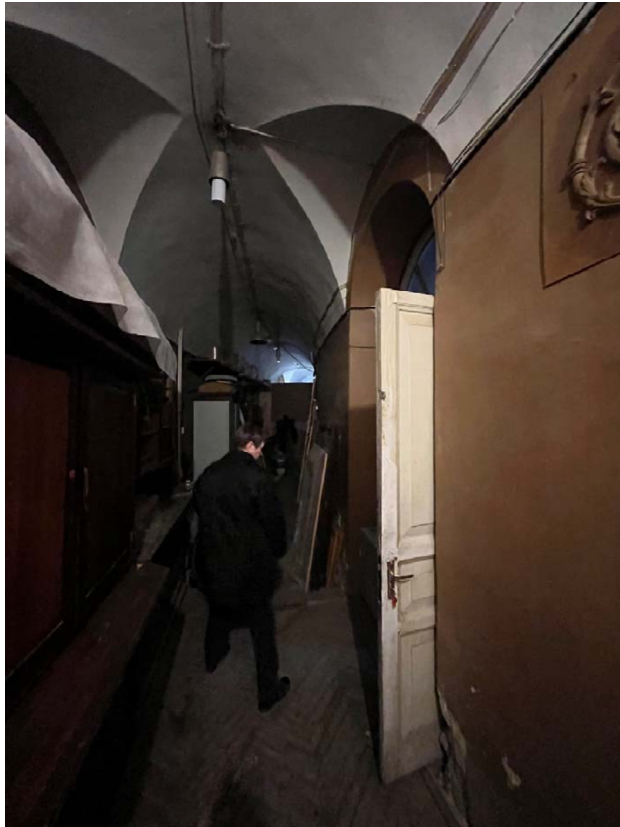
Фото №45. 1-ый этаж, западное крыло, помещение 1-Н(11).
