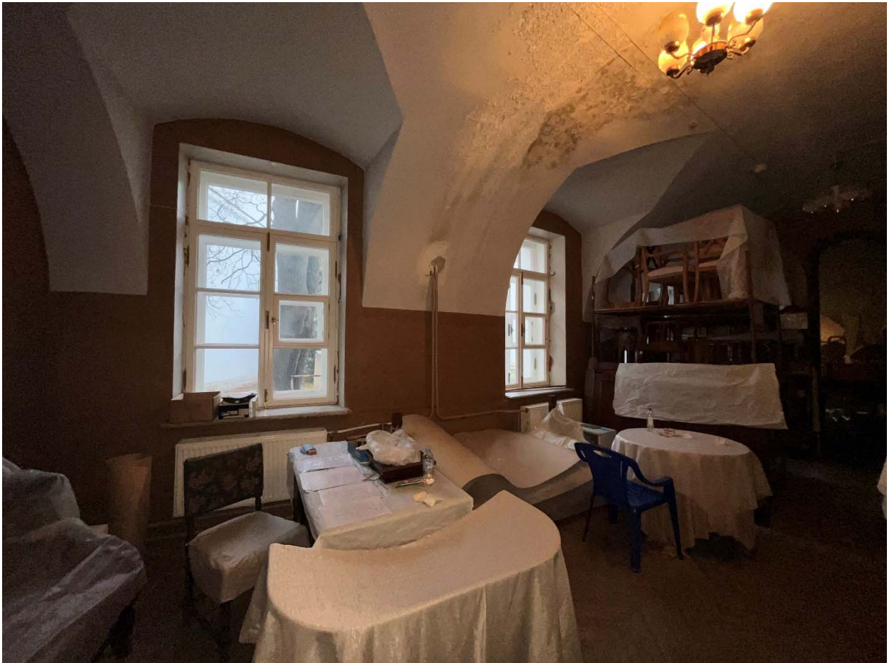
Фото №52. 1-ый этаж, западное крыло, помещение 1-Н(13).
