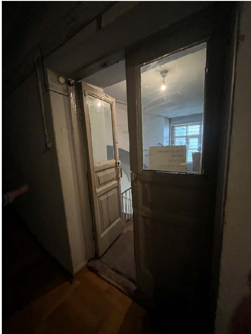
Фото №63. 2-ой этаж, помещение 1-Н(19).
