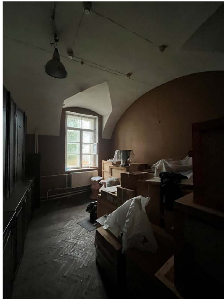
Фото №45. 1-ый этаж, западное крыло, помещение 1-Н(11).
