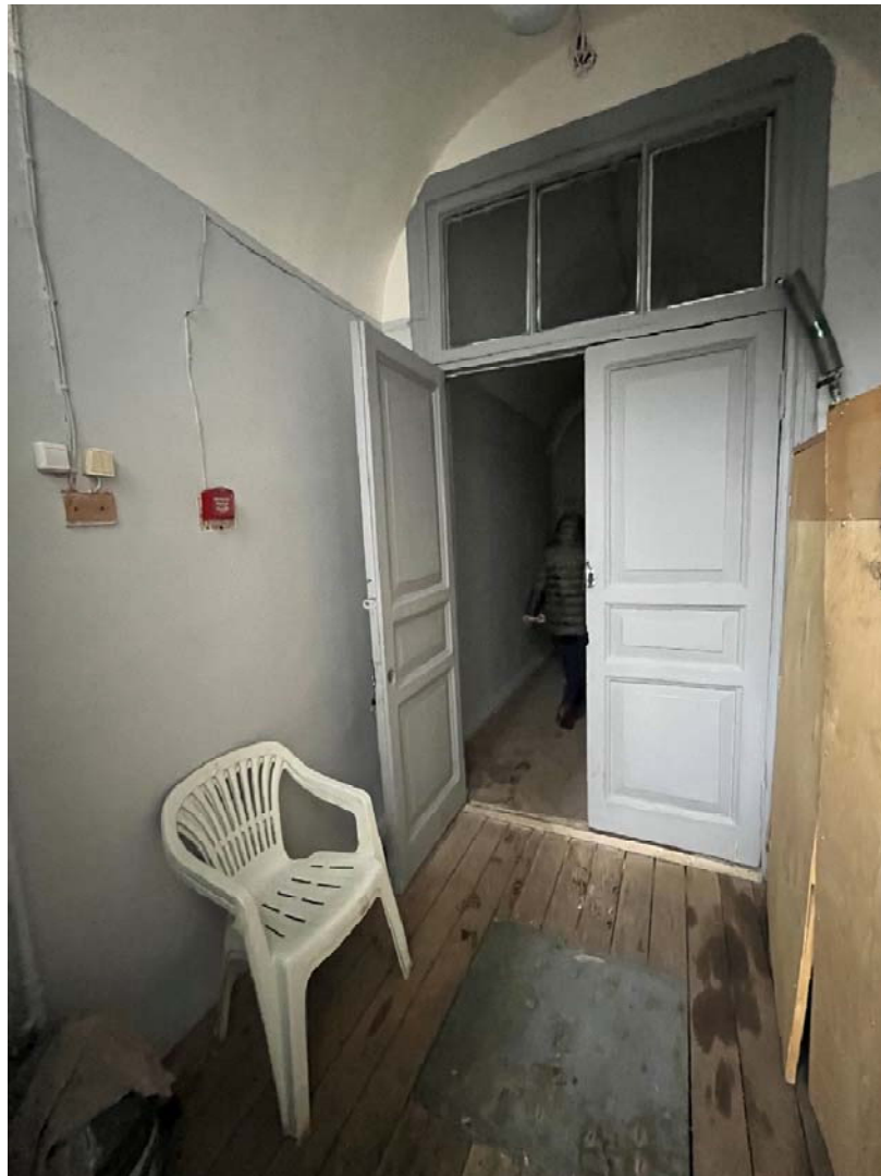
Фото №49. 1-ый этаж, западное крыло, помещение 1-Н(15).
