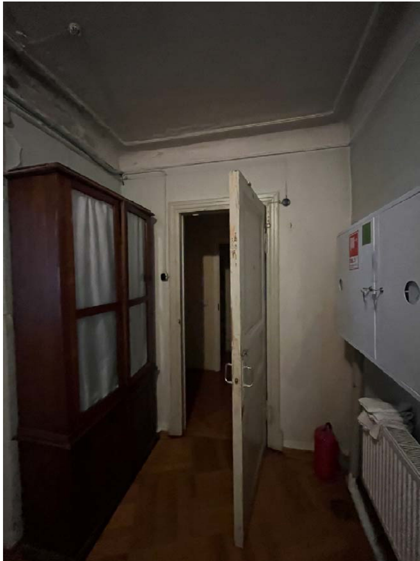
Фото №56. 2-ой этаж, помещение 1-Н(19).
