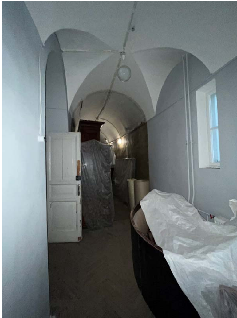
Фото №51. 1-ый этаж, западное крыло, помещение 1-Н(11).
