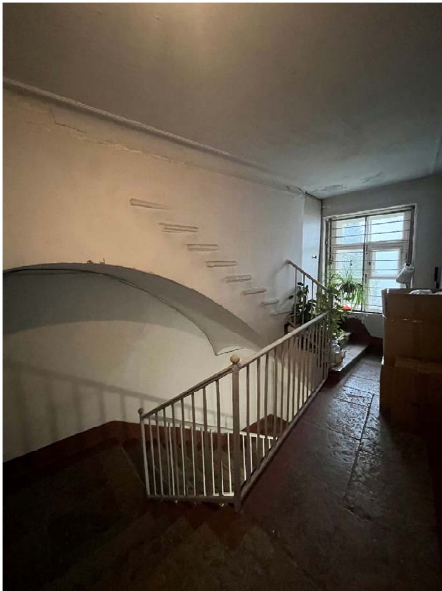
Фото №64. 2-ой этаж, помещение 1-Н(22).
