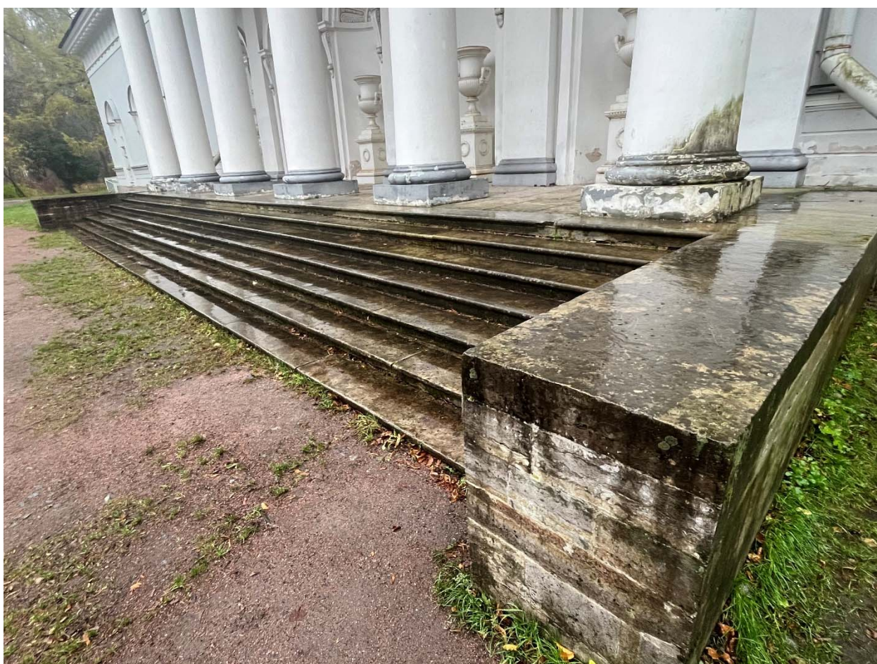
Фото 11. Северный фасад, конструкции лестницы портика.
