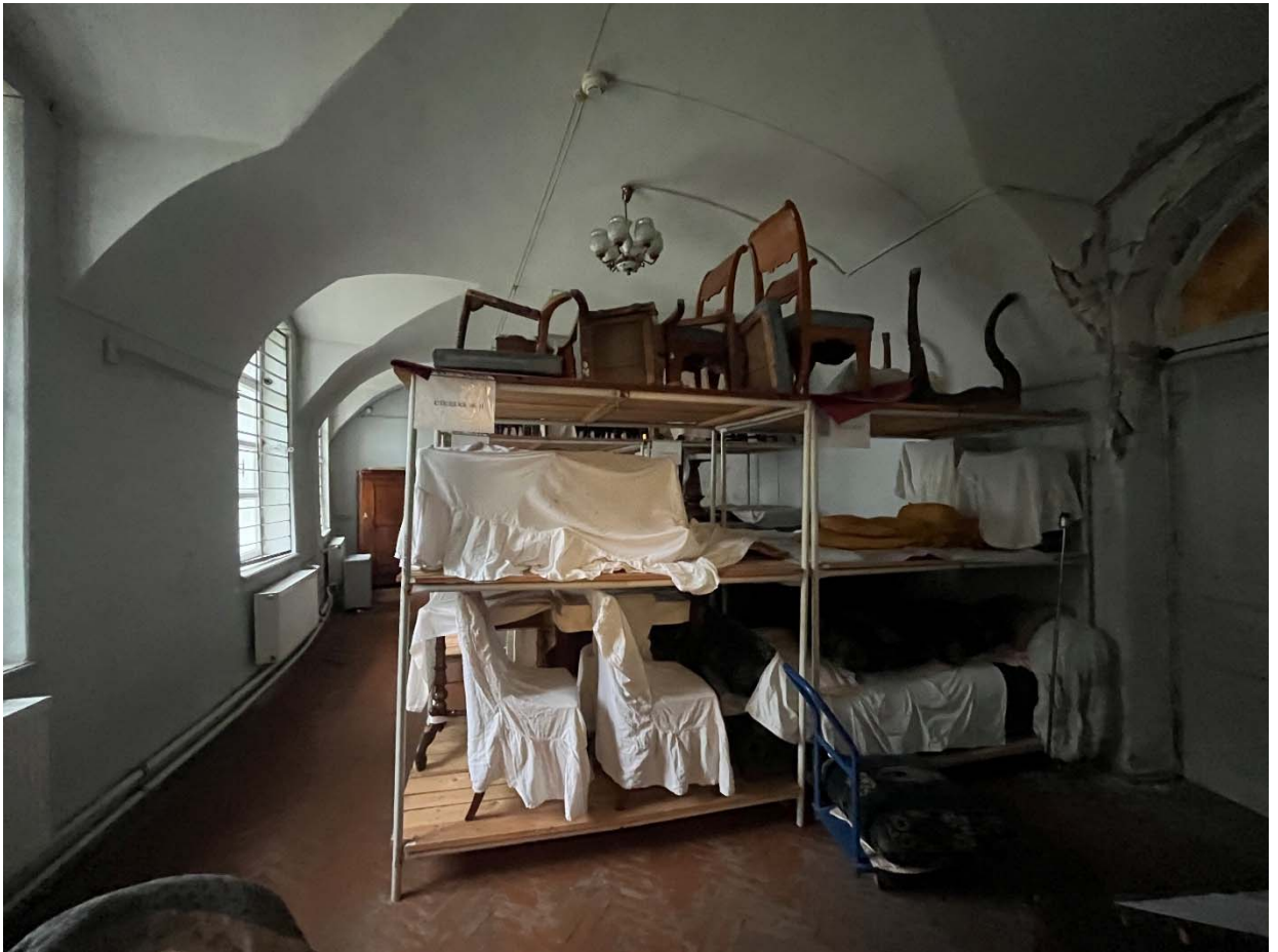
Фото №30. 1-ый этаж, восточное крыло, помещение 1-Н(4).
