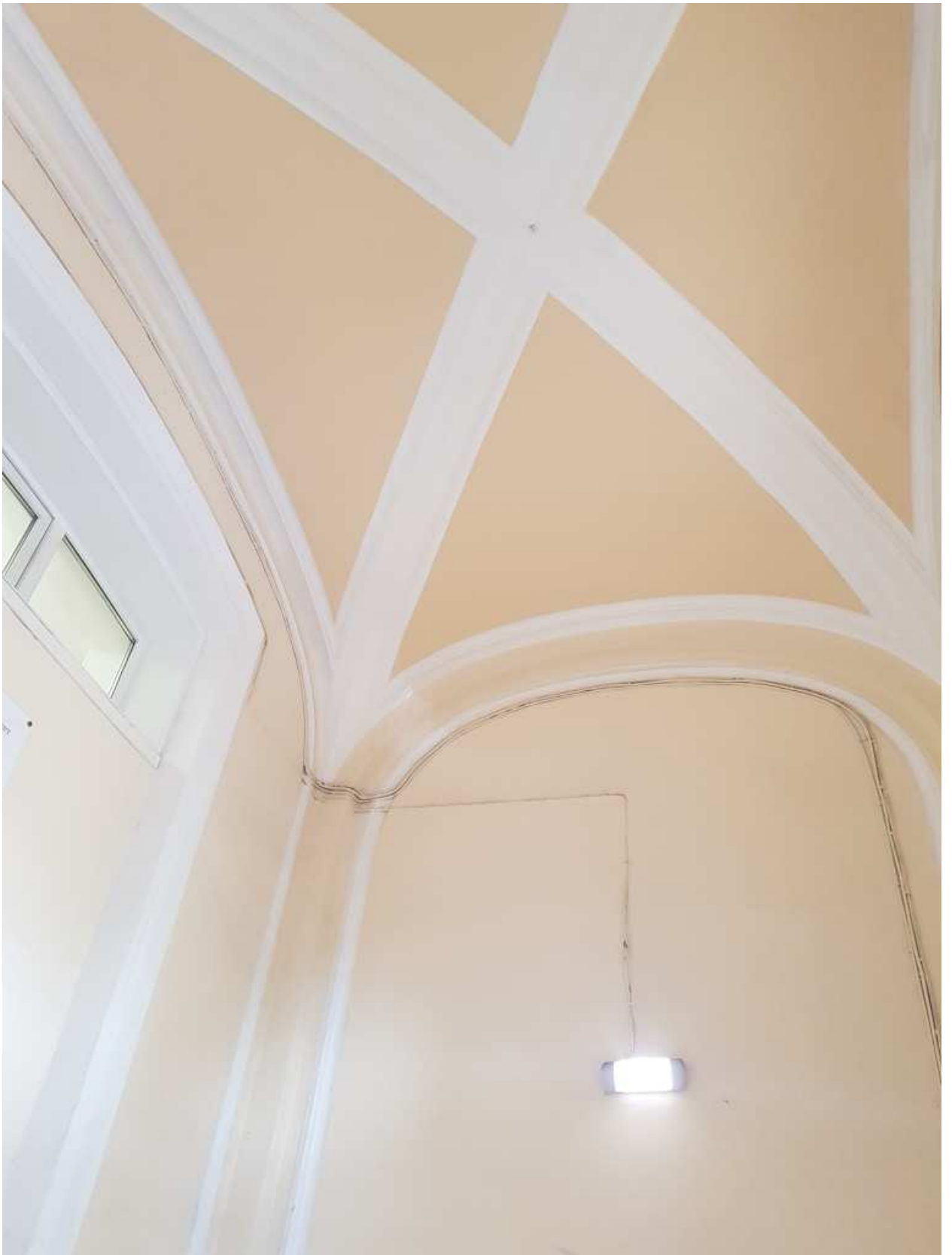
4. Сводчатое перекрытие пом. тамбура.
