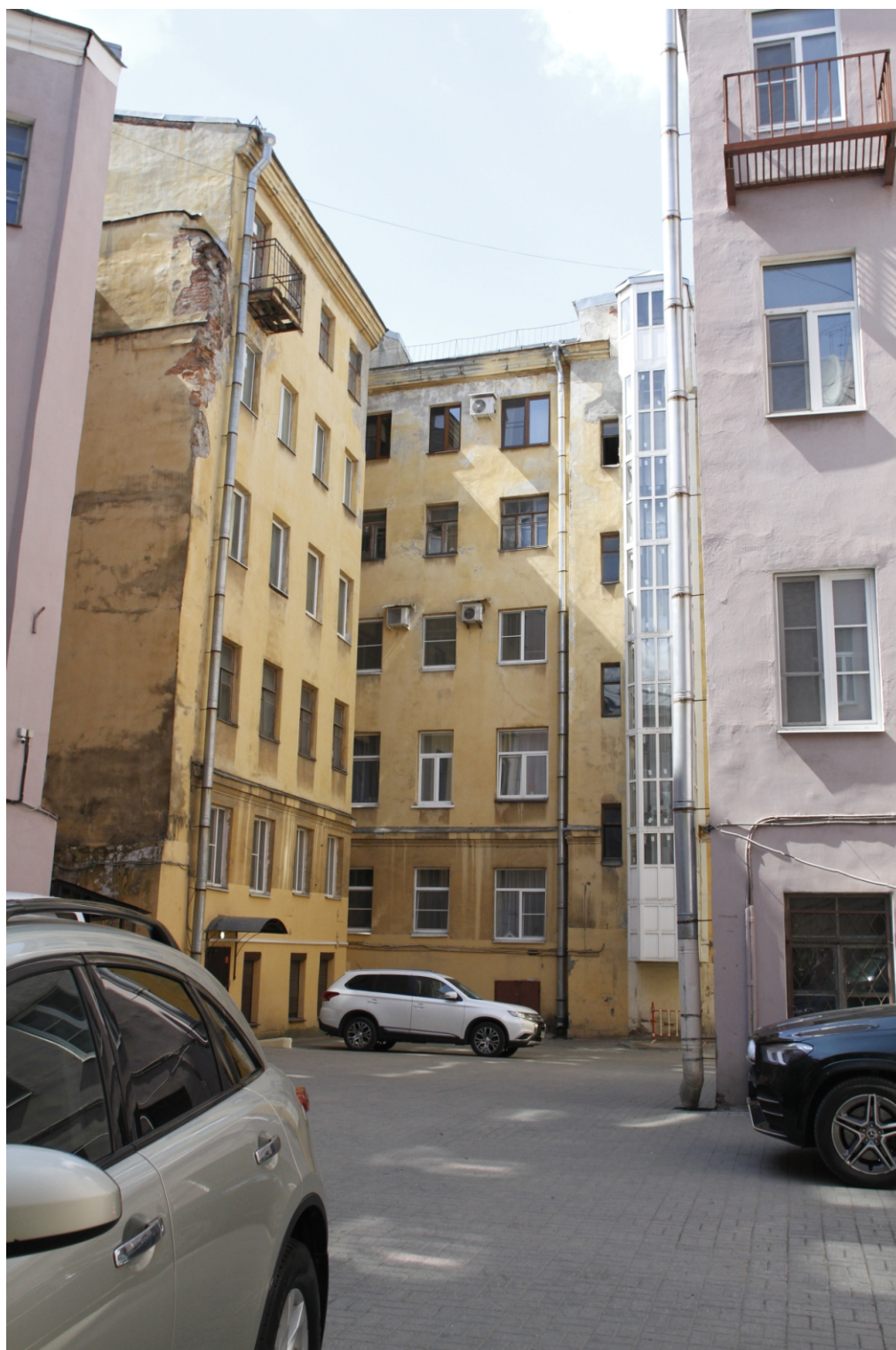
12. «Дом В.Ф. Краевского». Санкт-Петербург, ул. Чехова, дом 3, литера А. Общий вид на фасады 2-го двора. Фото: 23.06.2023.
