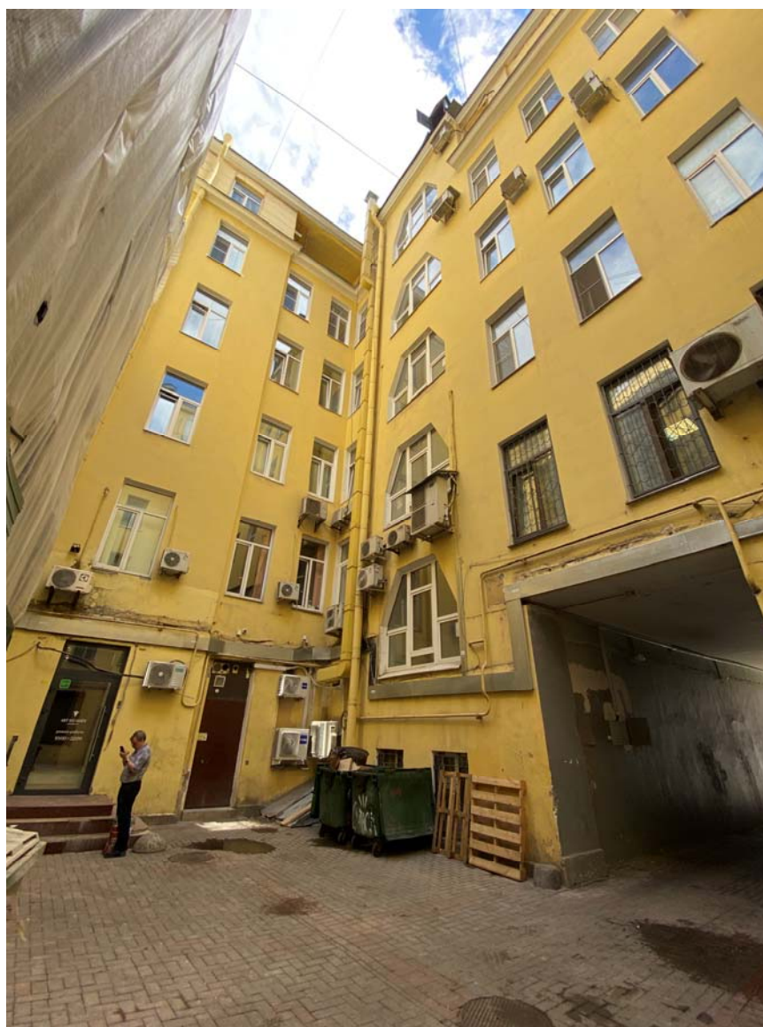
Фото №6. Дворовый (северный) фасад лицевого корпуса.
