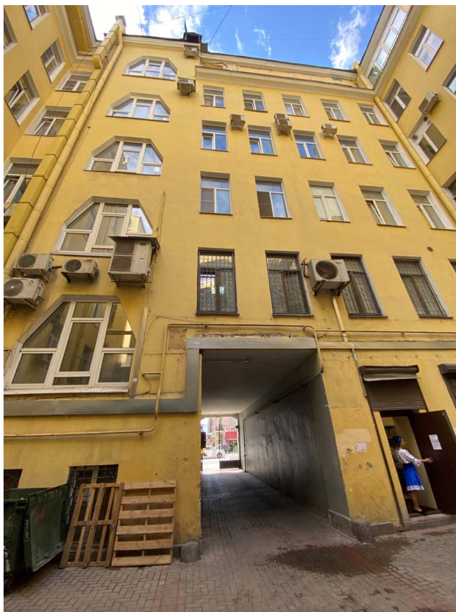
Фото №5. Дворовый (северный) фасад лицевого корпуса.
