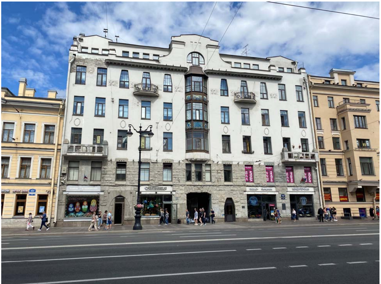
Фото №1. Лицевой (южный) фасад по Невскому проспекту.
