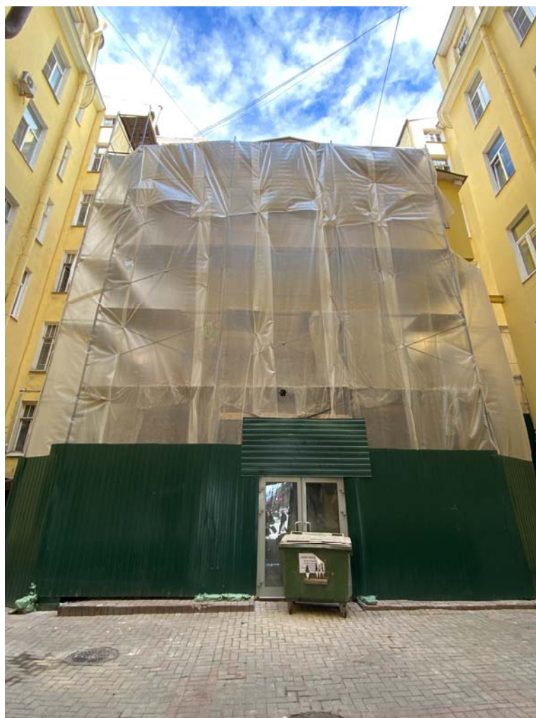
Фото №13. Дворовый (южный фасад) дворового корпуса.
