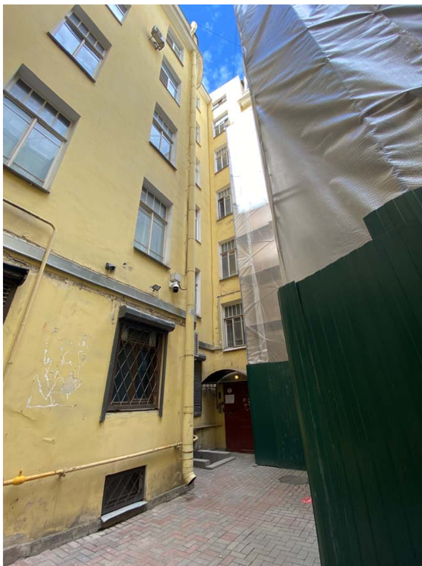
Фото №8. Дворовый (южный) фасад дворового корпуса.
