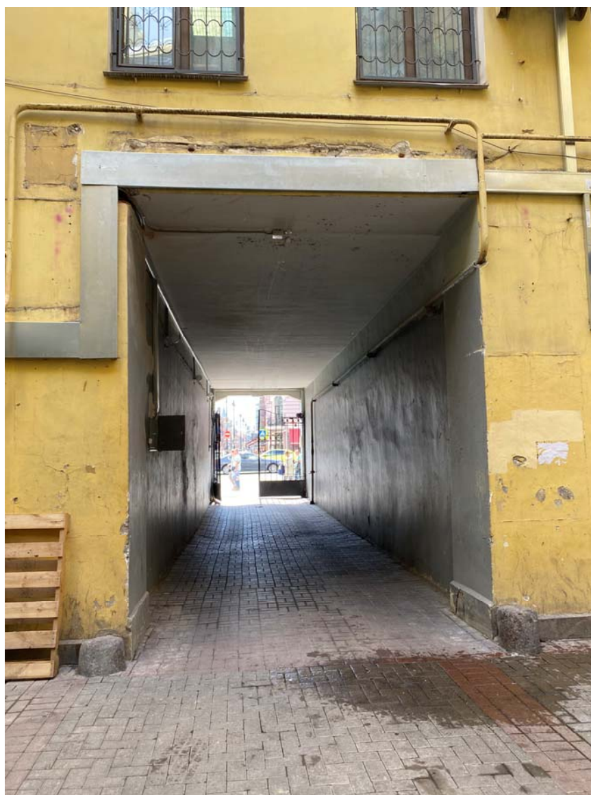
Фото №4. Воротный проезд, вид со стороны двора.
