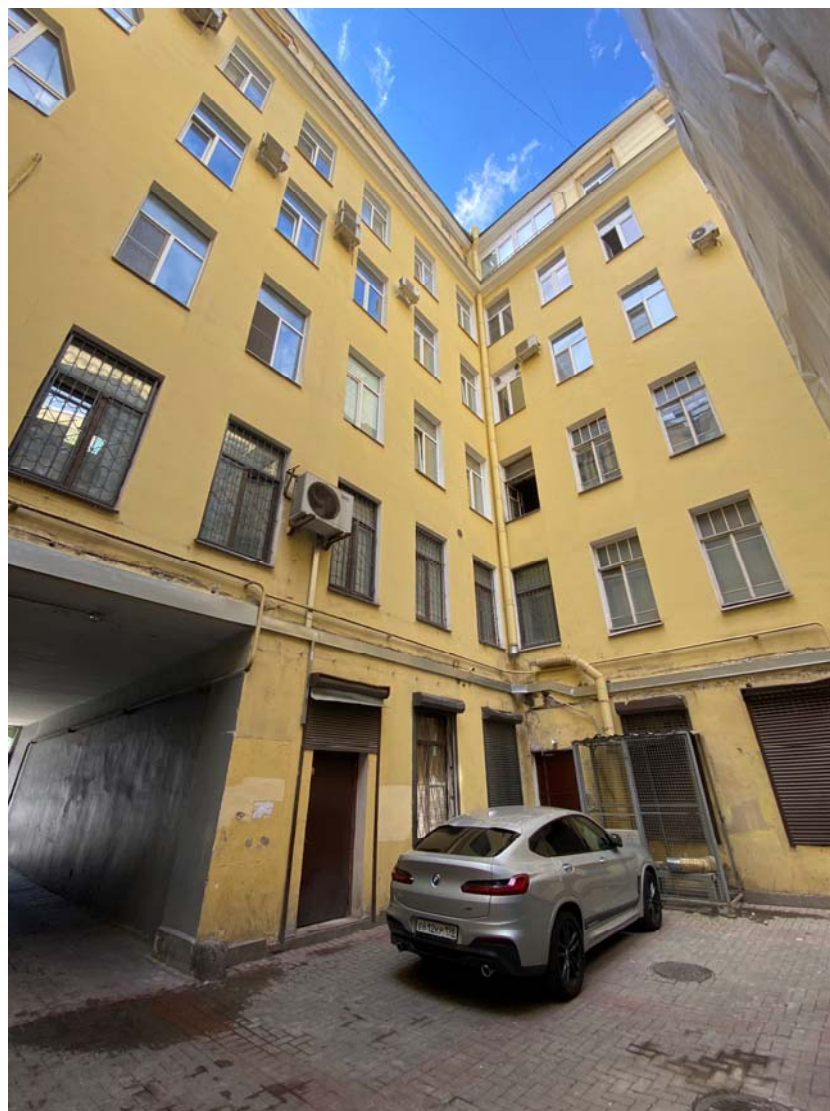
Фото №7. Дворовый фасад (сенверный) лицевого корпуса.
