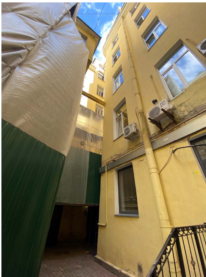
Фото №9. Дворовый (южный) фасад дворового корпуса.
