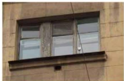
скамья - местоположение (на лицевом фасаде семиэтажного корпуса), габариты, конфигурация, материал (известняк), конструкция (на профилированных кронштейнах);
