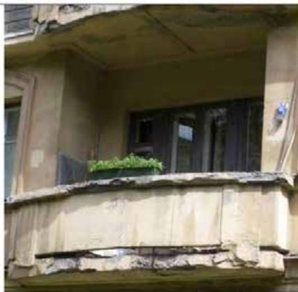
семь балконов на уровне 5-го этажа - местоположение, габариты, конфигурация (прямоугольные в плане), ограждение (глухое, бетонное, с несколькими проемами в нижней части);
