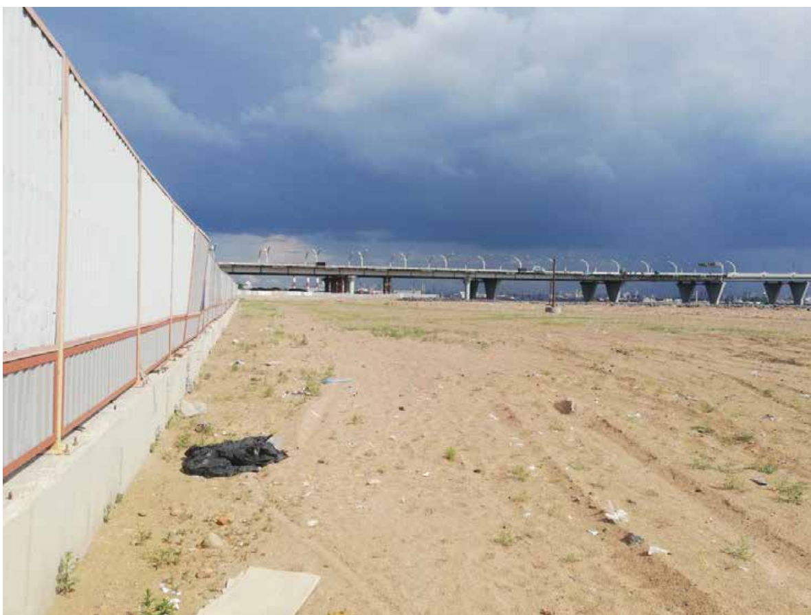
Фотография 2. Направление съемки: восток. Дата съемки 25.06.2023.
