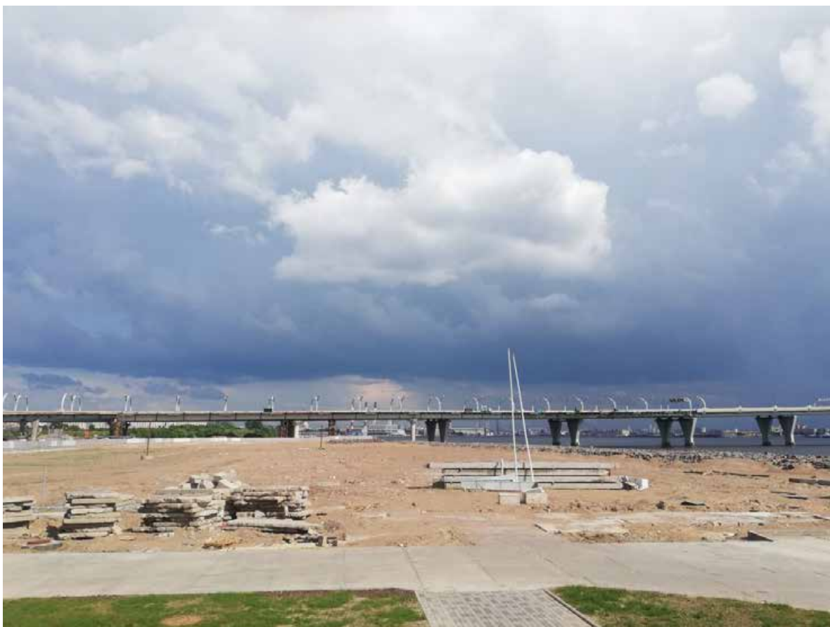
Фотография 1. Направление съемки: восток. Дата съемки 25.06.2023.
