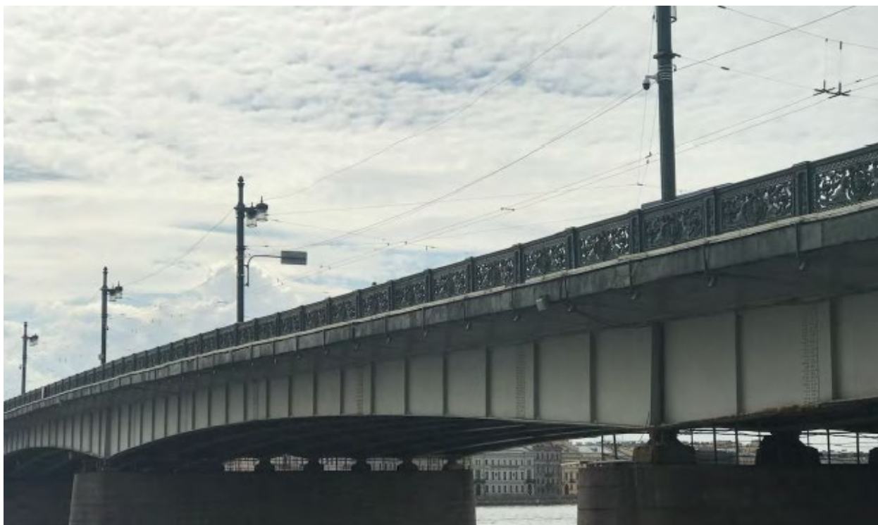
7. Объект культурного наследия регионального значения «Ограждение Литейного моста», расположенный по адресу: г. Санкт-Петербург, Литейный мост, литера А. 25.05.2023.
