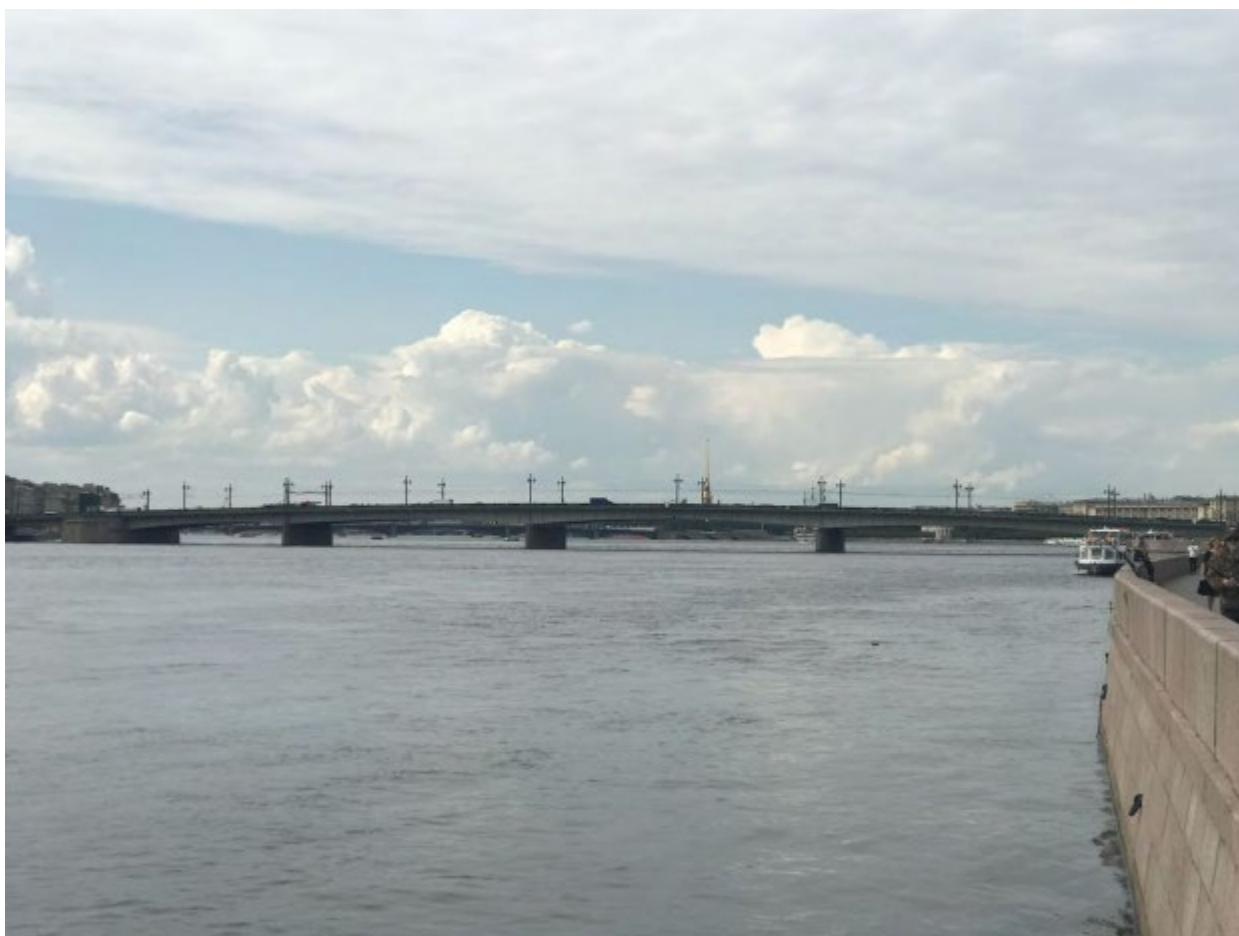
5. Вид на объект культурного наследия регионального значения «Ограждение Литейного моста», расположенный по адресу: г. Санкт-Петербург, Литейный мост, литера А, от зоны производства работ. 25.05.2023.
