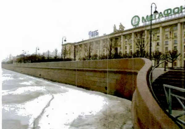
5. Вид стенки набережной
