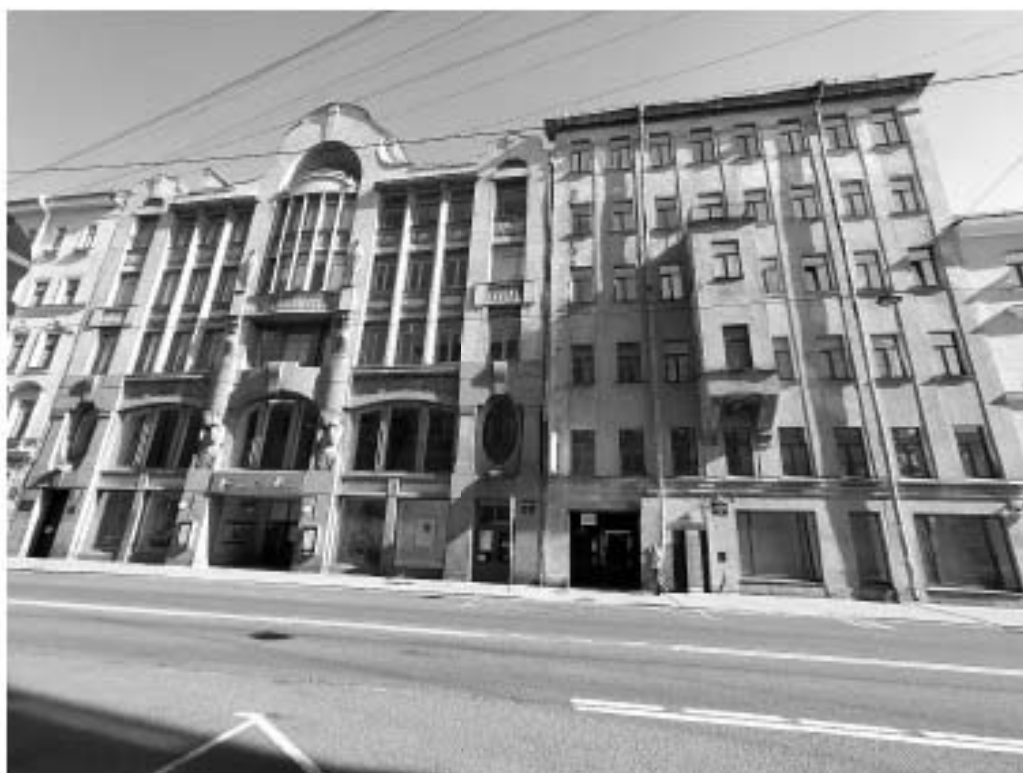
Фото 2. Общий вид лицевых фасадов дома № 10-12 по ул. Некрасова в южном направлении.
