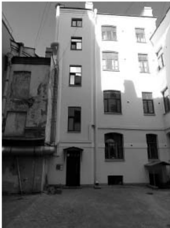
Фото 13. Восточный фасад дома № 10 по ул. Некрасова (слева), дома № 5 по Баскову переулку (справа).
