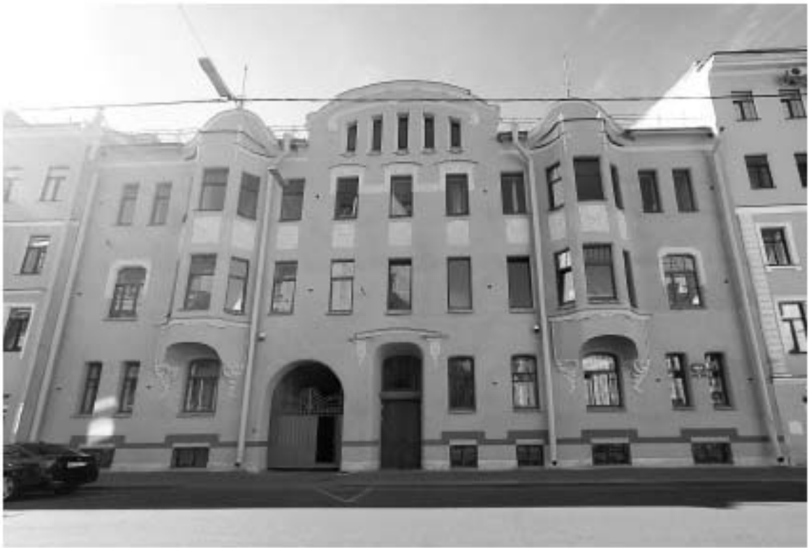
Фото 8. Объект культурного наследия регионального значения «Дом А.И. Ерошенко». Общий вид лицевого фасада дома № 5 по Баскову переулку, вид в северном направлении (после реставрации, выполненной в 2022 году).
