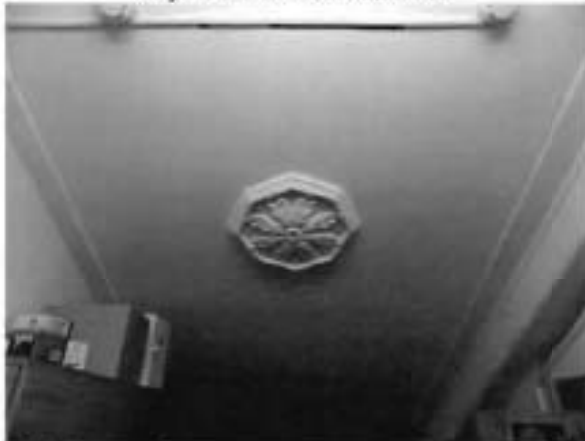
16. Служебное помещение под центральной лестницей. Лепная розетка под лестничным маршем.
