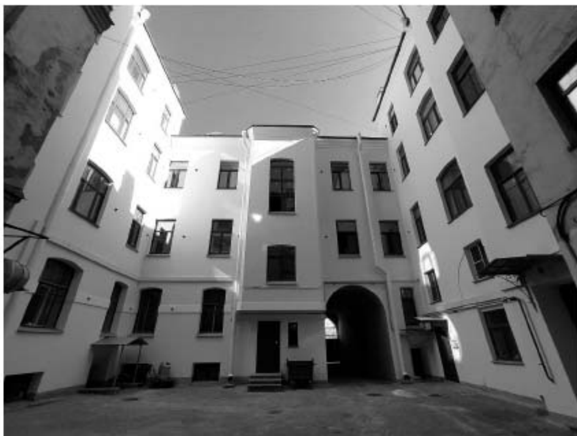
Фото 12. Дворовые фасады дома № 5 по Баскову переулку.
