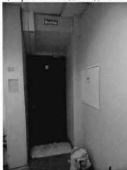
25. Внутренняя планировочная структура. Выход на эвакуационную лестницу в восточном крыле
