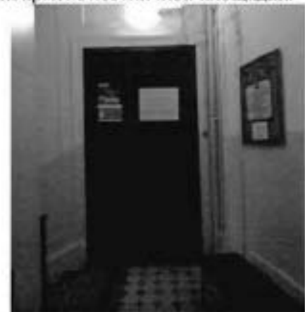
59. Вестибюль западного входа. Дверное заполнение.
