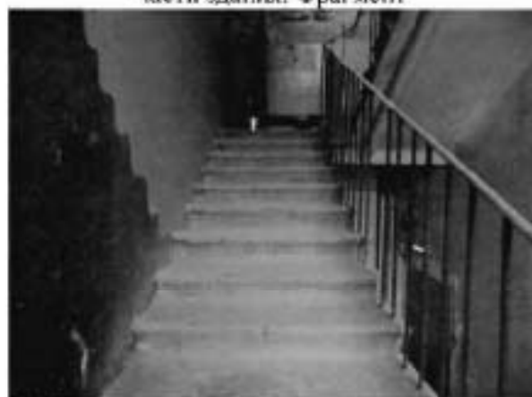
89. Службная лестничная клетка в восточной части здания. Фрагмент
