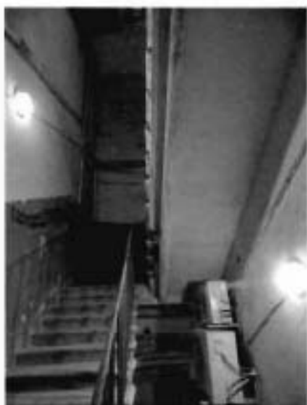
86. Службная лестничная клетка в восточной части здания. Фрагмент
