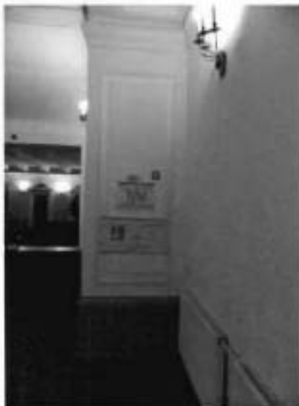
6. Штукатурные зеркала в лепных рамах с прорезкой растительного орнамента на пилонах парадной лестницы.
