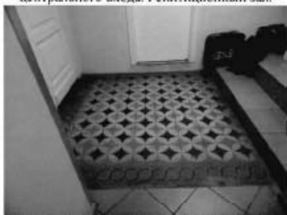
22. Отделка служебных помещений восточнее центрального входа. Площадка облицованная метлахской плиткой.
