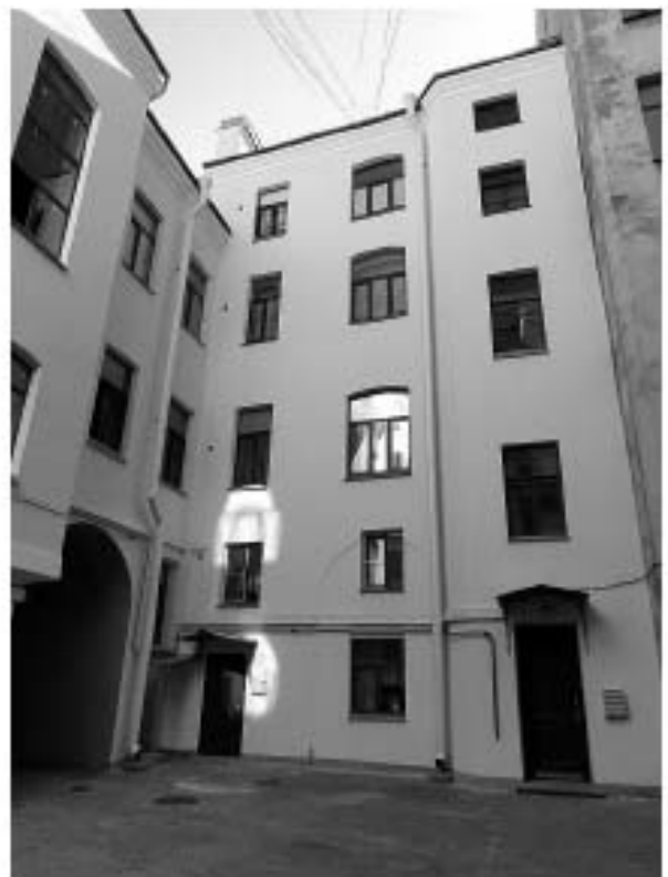
Фото 14. Западный фасад дома № 5 по Баскову переулку.
