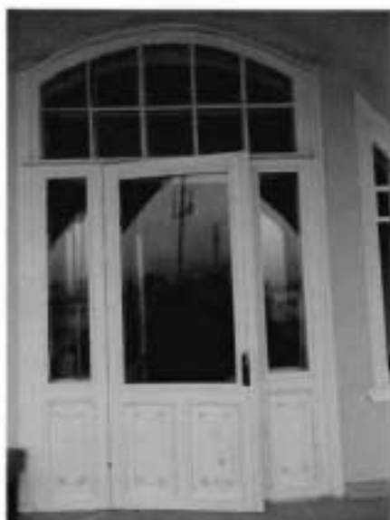
80. Шестой этаж. Балкон. Столярное заполнение дверного проема.
