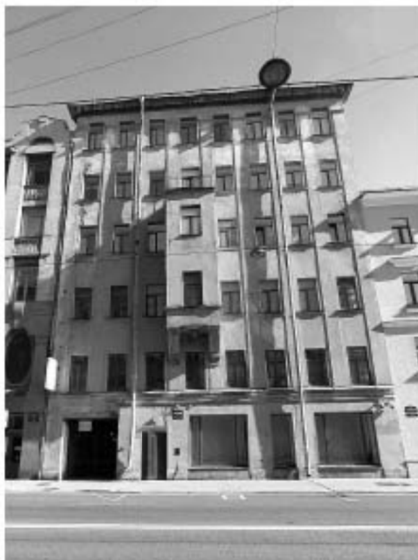
Фото 3. Общий вид лицевого фасада дома № 12 по ул. Некрасова.
