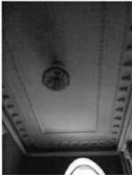
46. Вестибюль второго этажа центральной части здания. Лепные тяги, люстры и кронштейны в декоративной отделка потолка.
