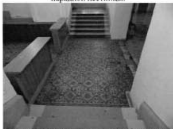
37. Площадка облицованная метлахской плиткой парадной лестницы в центральной части здания.
