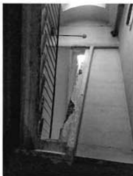
87. Службная лестничная клетка в восточной части здания. Фрагмент
