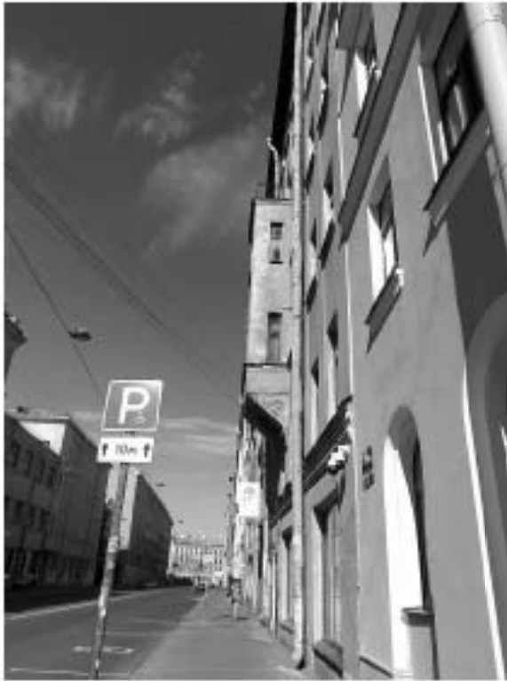
Фото 5. Вид сбоку на эркер дома № 12 по ул. Некрасова в юго-западном направлении.
