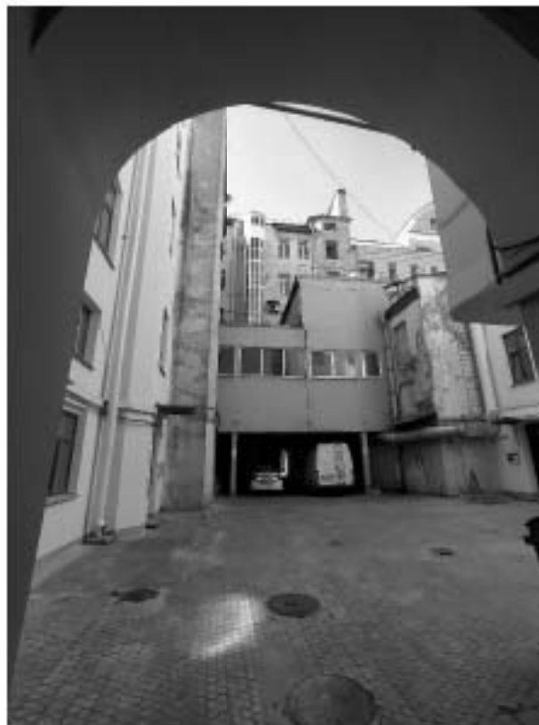
Фото 7. Общий вид дворовых фасадов дома 10-12 по ул. Некрасова. Вид из арки дома № 5 по Баскову переулку в северном направлении.
