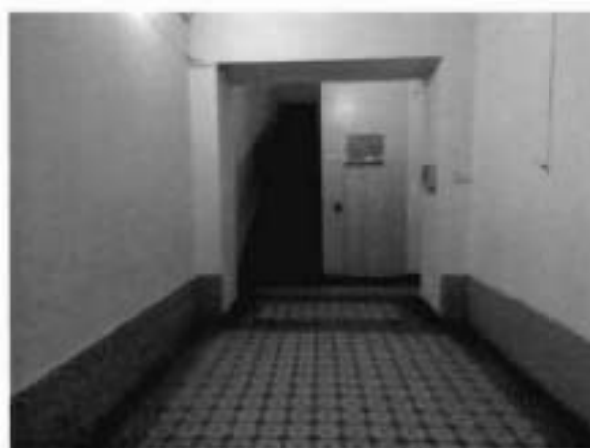
54. Западная парадная. Вестибюль
