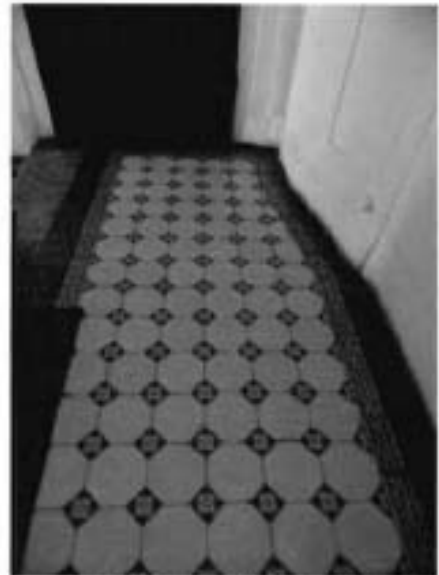
57. Западная парадная. Плиточное напольное покрытие лестничной площадки.
