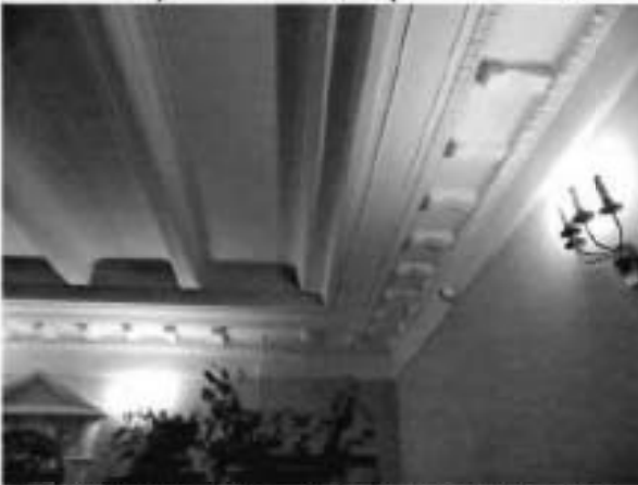
10. Холл первого этажа центрального входа. Фрагмент декоративного оформления кессонированного потолка
