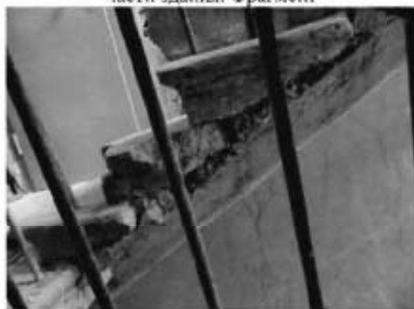
88. Службная лестничная клетка в восточной части здания. Фрагмент.
