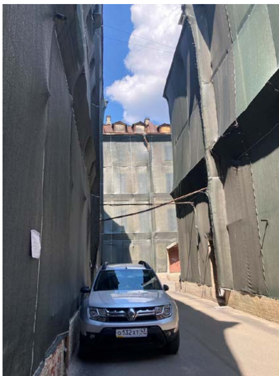
Фото 33. Фрагмент дворового фасада объекта культурного наследия регионального значения «Дом Утина И. Здесь с 1860 г. жил и в 1911 г. умер историк, издатель журнала "Вестник Европы" Стасюлевич Михаил Матвеевич. Здесь с 1893 г. жил и в 1895 г. умер ученый-машиностроитель Вышнеградский Иван Алексеевич. Здесь в 1884-1888 гг. останавливался скульптор Антокольский Марк Матвеевич»
