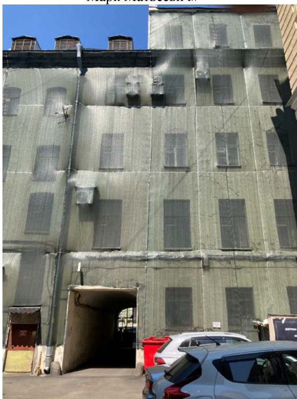
Фото 30. Фрагмент дворового фасада объекта культурного наследия регионального значения «Дом Утина И. Здесь с 1860 г. жил и в 1911 г. умер историк, издатель журнала "Вестник Европы" Стасюлевич Михаил Матвеевич. Здесь с 1893 г. жил и в 1895 г. умер ученый-машиностроитель Вышнеградский Иван Алексеевич. Здесь в 1884-1888 гг. останавливался скульптор Антокольский Марк Матвеевич»
