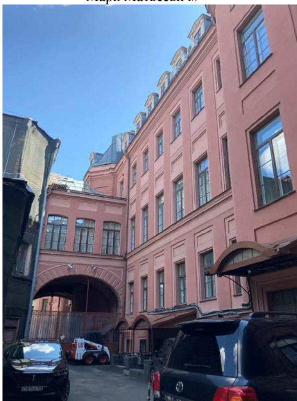
Фото 18. Фрагмент дворового фасада объекта культурного наследия регионального значения «Дом Утина И. Здесь с 1860 г. жил и в 1911 г. умер историк, издатель журнала "Вестник Европы" Стасюлевич Михаил Матвеевич. Здесь с 1893 г. жил и в 1895 г. умер ученый-машиностроитель Вышнеградский Иван Алексеевич. Здесь в 1884-1888 гг. останавливался скульптор Антокольский Марк Матвеевич»
