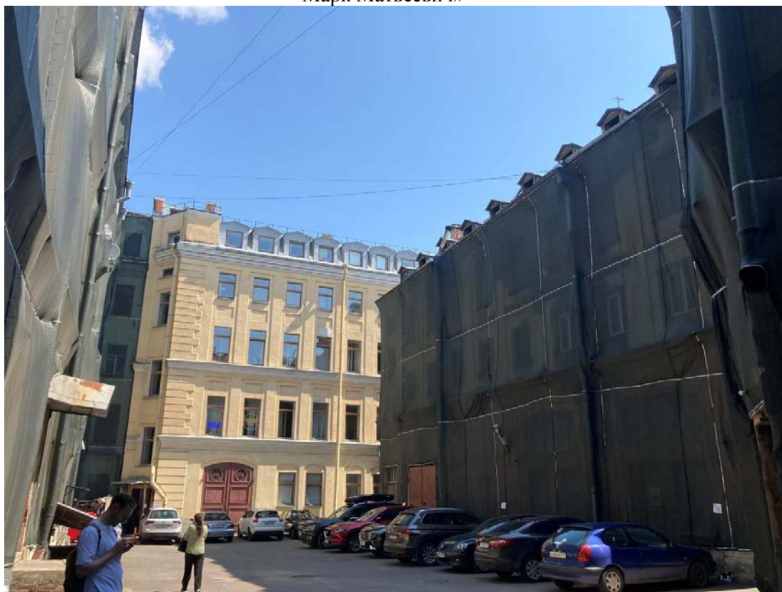
Фото 24. Фрагмент дворового фасада объекта культурного наследия регионального значения «Дом Утина И. Здесь с 1860 г. жил и в 1911 г. умер историк, издатель журнала "Вестник Европы" Стасюлевич Михаил Матвеевич. Здесь с 1893 г. жил и в 1895 г. умер ученый-машиностроитель Вышнеградский Иван Алексеевич. Здесь в 1884-1888 гг. останавливался скульптор Антокольский Марк Матвеевич»
