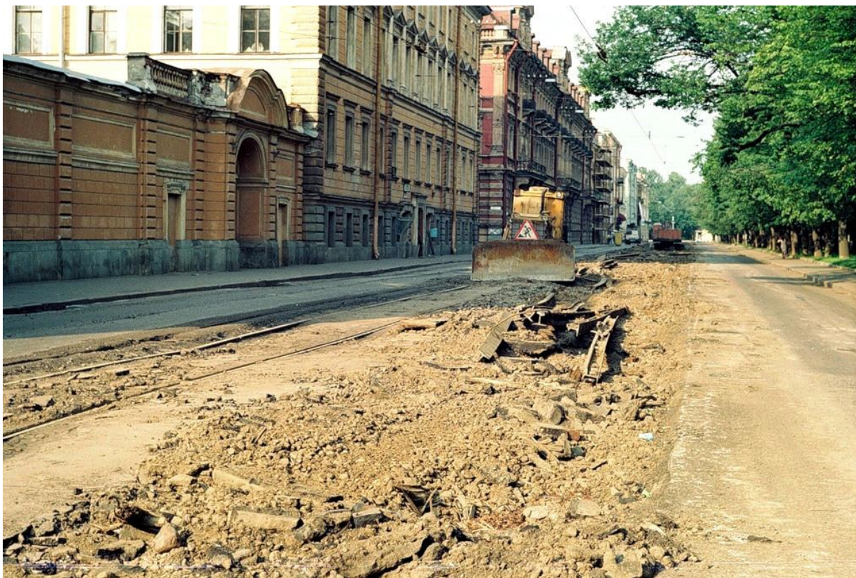
17. Демонтаж трамвайной линии на Конногвардейском бульваре. 1997 г. — «PastVu» – ретро-фотографии стран и городов [Электронный ресурс]. URL: https://pastvu.com/p/129637 .
