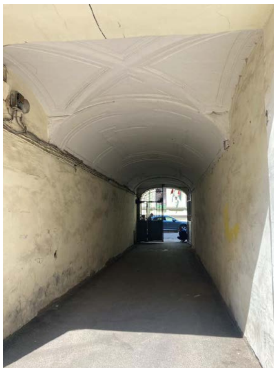
Фото 27. Фрагмент дворового фасада объекта культурного наследия регионального значения «Дом Утина И. Здесь с 1860 г. жил и в 1911 г. умер историк, издатель журнала "Вестник Европы" Стасюлевич Михаил Матвеевич. Здесь с 1893 г. жил и в 1895 г. умер ученый-машиностроитель Вышнеградский Иван Алексеевич. Здесь в 1884-1888 гг. останавливался скульптор Антокольский Марк Матвеевич», воротный проезд (по Галерной ул.)
