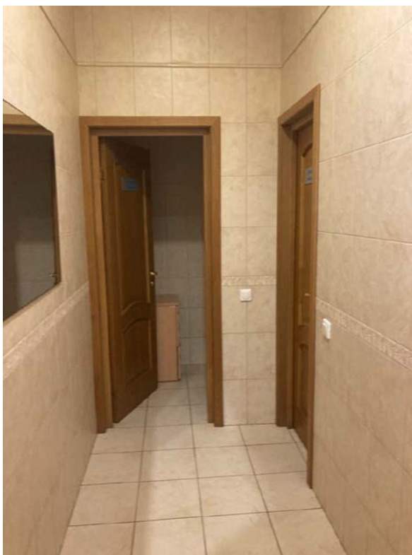
Фото 83. Интерьер 1 этажа объекта культурного наследия регионального значения «Дом Утина И. Здесь с 1860 г. жил и в 1911 г. умер историк, издатель журнала "Вестник Европы" Стасюлевич Михаил Матвеевич. Здесь с 1893 г. жил и в 1895 г. умер ученый-машиностроитель Вышнеградский Иван Алексеевич. Здесь в 1884-1888 гг. останавливался скульптор Антокольский Марк Матвеевич»
