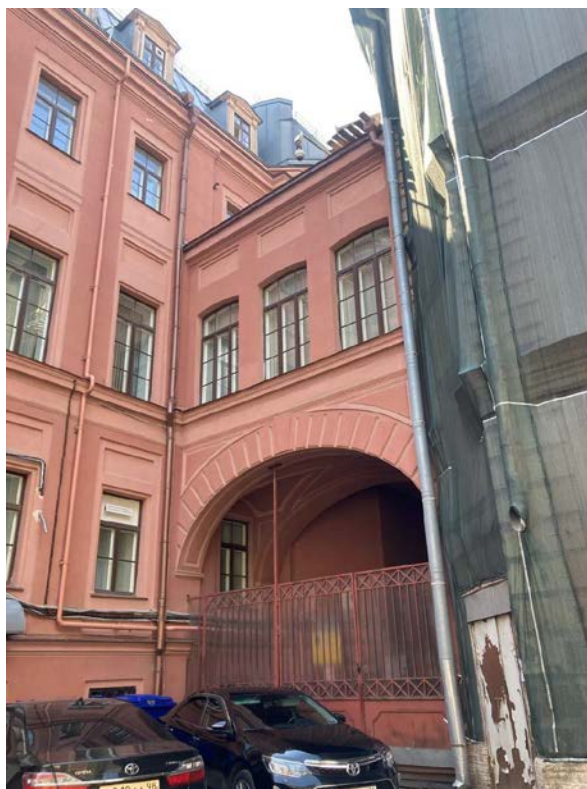
Фото 35. Фрагмент дворового фасада объекта культурного наследия регионального значения «Дом Утина И. Здесь с 1860 г. жил и в 1911 г. умер историк, издатель журнала "Вестник Европы" Стасюлевич Михаил Матвеевич. Здесь с 1893 г. жил и в 1895 г. умер ученый-машиностроитель Вышнеградский Иван Алексеевич. Здесь в 1884-1888 гг. останавливался скульптор Антокольский Марк Матвеевич»
