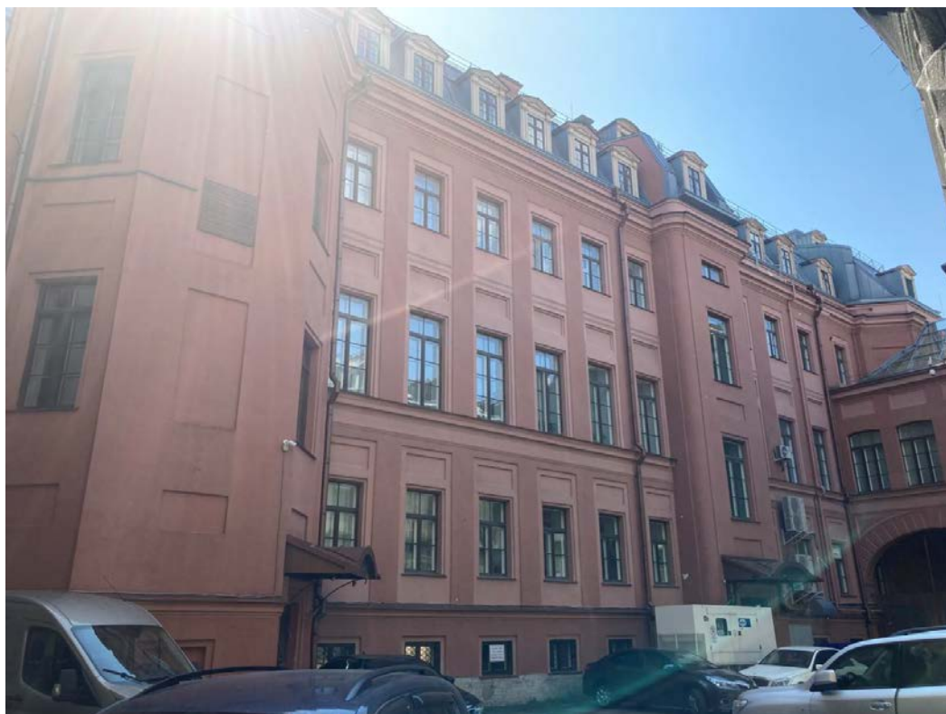
Фото 31. Фрагмент дворового фасада объекта культурного наследия регионального значения «Дом Утина И. Здесь с 1860 г. жил и в 1911 г. умер историк, издатель журнала "Вестник Европы" Стасюлевич Михаил Матвеевич. Здесь с 1893 г. жил и в 1895 г. умер ученый-машиностроитель Вышнеградский Иван Алексеевич. Здесь в 1884-1888 гг. останавливался скульптор Антокольский Марк Матвеевич»
