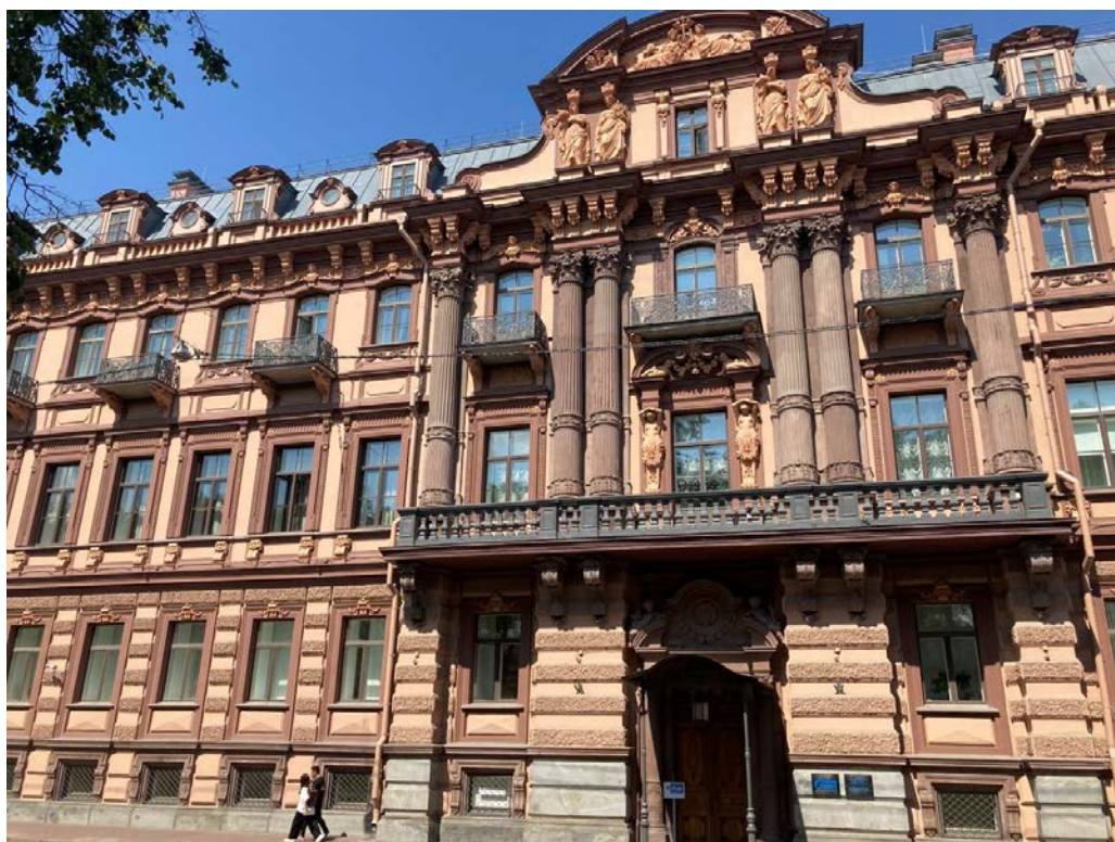
Фото 13. Фрагмент лицевого фасада объекта культурного наследия регионального значения «Дом Утина И. Здесь с 1860 г. жил и в 1911 г. умер историк, издатель журнала "Вестник Европы" Стасюлевич Михаил Матвеевич. Здесь с 1893 г. жил и в 1895 г. умер ученый-машиностроитель Вышнеградский Иван Алексеевич. Здесь в 1884-1888 гг. останавливался скульптор Антокольский Марк Матвеевич» (по Конногвардейскому бул.)
