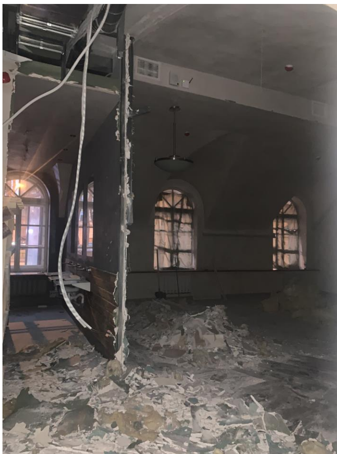
Фото 7. Помещение № 10. Вид на окна.
