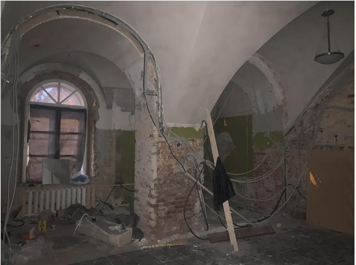
Фото 2. Помещение № 1. Вид на окна.
