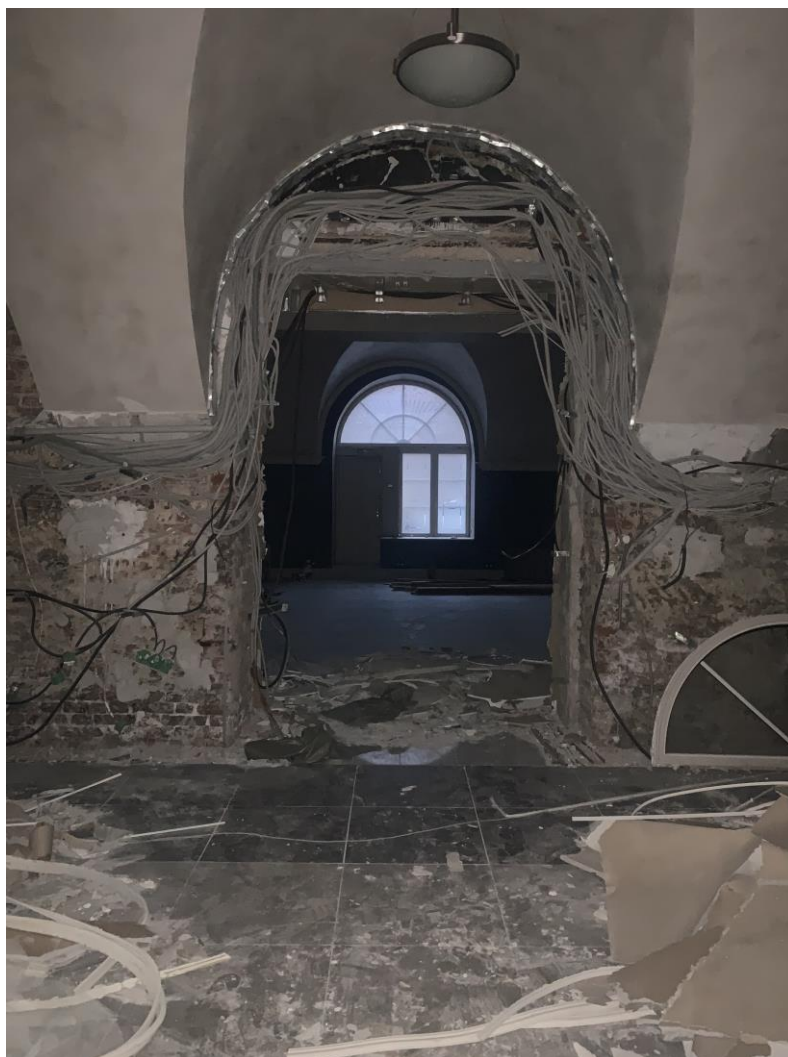
Фото 3. Помещение № 1. Вид на дверной проем в помещении № 18.
