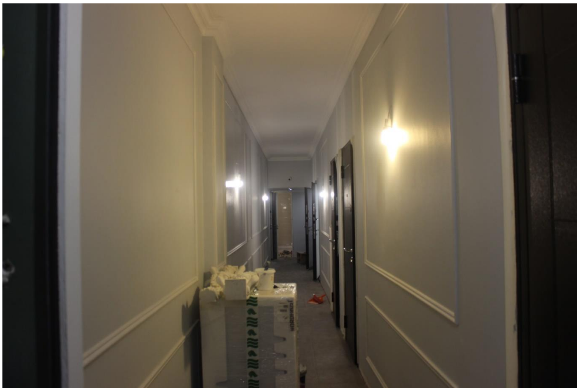
5. Здание по адресу: Санкт-Петербург, улица Чехова, д.3, Лит. А. Коридор квартиры № 6
