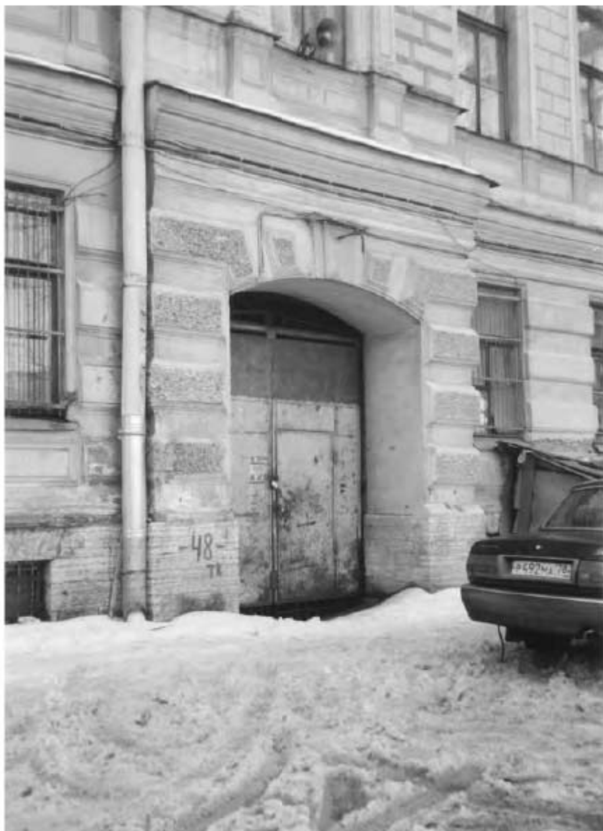
88. Арка ворот особняка М.Н. Полежаева. 2003 г. // ООО «Капитал-Строй». Проект реконструкции учебного корпуса детского дома-школы № 51. Том 3. Книга 1. Часть 1. Проект реставрации архитектурных элементов лицевых фасадов здания. СПб., 2003. / КГИОП. П. 1500Б/Пр. 80.
