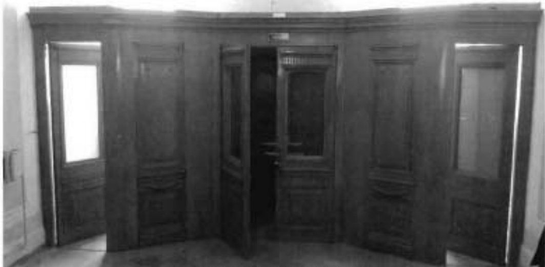
7. Тамбур парадного входа (Фотография от 19.05.2022)
