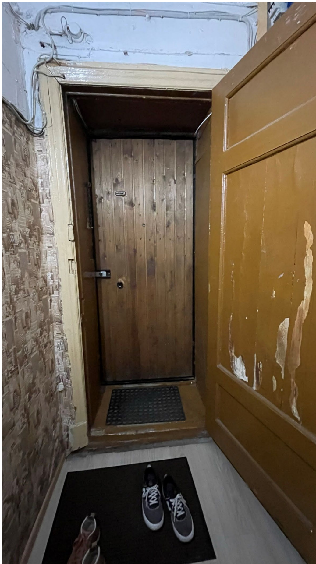
4. Вид на входную дверь в квартире;
