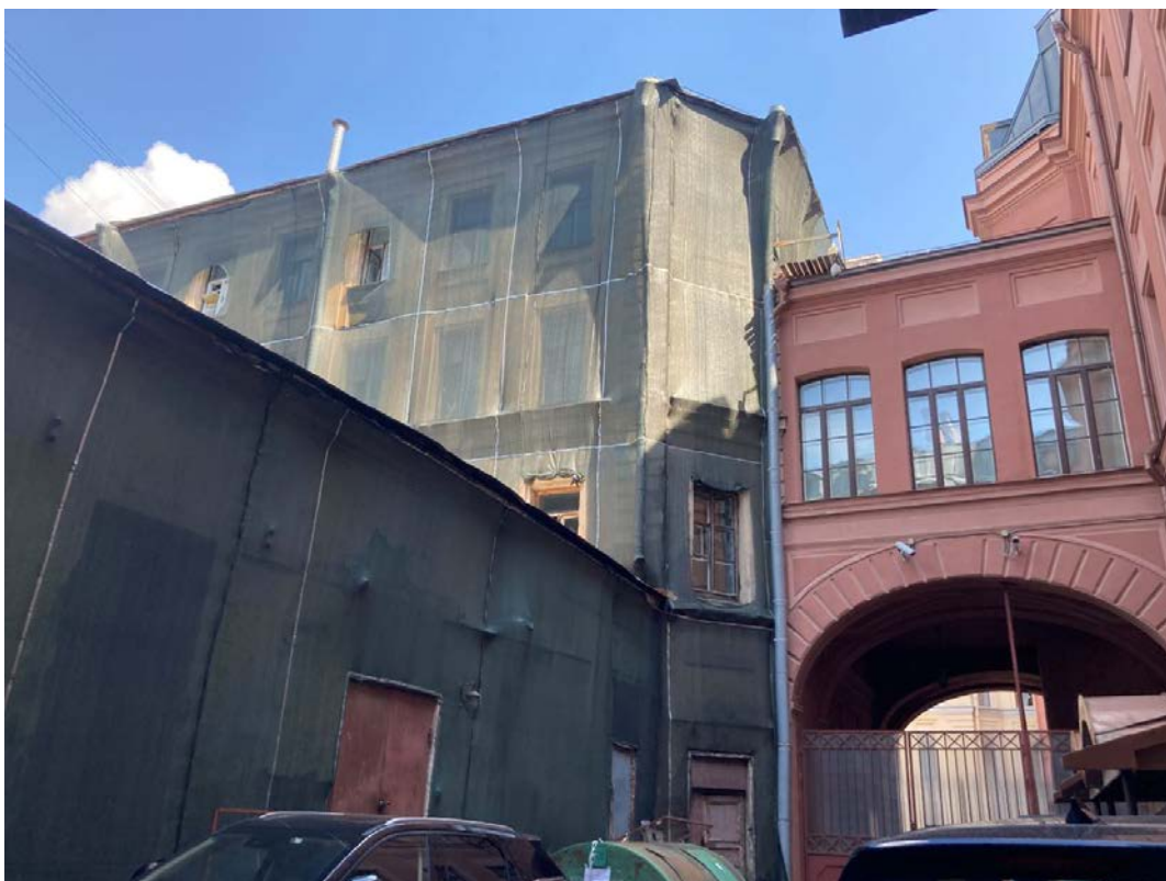
Фото 19. Фрагмент дворового фасада объекта культурного наследия регионального значения «Дом Утина И. Здесь с 1860 г. жил и в 1911 г. умер историк, издатель журнала "Вестник Европы" Стасюлевич Михаил Матвеевич. Здесь с 1893 г. жил и в 1895 г. умер ученый-машиностроитель Вышнеградский Иван Алексеевич. Здесь в 1884-1888 гг. останавливался скульптор Антокольский Марк Матвеевич»
