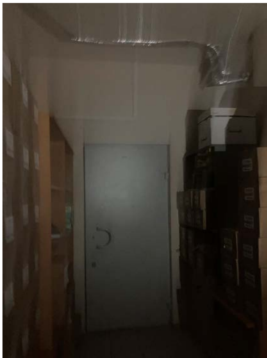
Фото 61. Интерьер цокольного этажа объекта культурного наследия регионального значения «Дом Утина И. Здесь с 1860 г. жил и в 1911 г. умер историк, издатель журнала "Вестник Европы" Стасюлевич Михаил Матвеевич. Здесь с 1893 г. жил и в 1895 г. умер ученый-машиностроитель Вышнеградский Иван Алексеевич. Здесь в 1884-1888 гг. останавливался скульптор Антокольский Марк Матвеевич»
