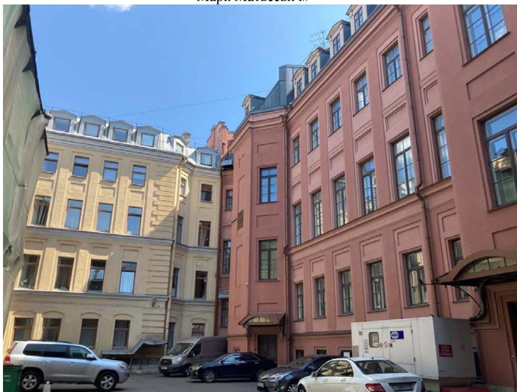
Фото 32. Фрагмент дворового фасада объекта культурного наследия регионального значения «Дом Утина И. Здесь с 1860 г. жил и в 1911 г. умер историк, издатель журнала "Вестник Европы" Стасюлевич Михаил Матвеевич. Здесь с 1893 г. жил и в 1895 г. умер ученый-машиностроитель Вышнеградский Иван Алексеевич. Здесь в 1884-1888 гг. останавливался скульптор Антокольский Марк Матвеевич»
