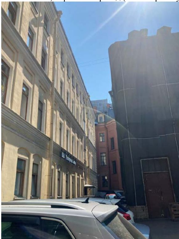
Фото 28. Фрагмент дворового фасада объекта культурного наследия регионального значения «Дом Утина И. Здесь с 1860 г. жил и в 1911 г. умер историк, издатель журнала "Вестник Европы" Стасюлевич Михаил Матвеевич. Здесь с 1893 г. жил и в 1895 г. умер ученый-машиностроитель Вышнеградский Иван Алексеевич. Здесь в 1884-1888 гг. останавливался скульптор Антокольский Марк Матвеевич»
