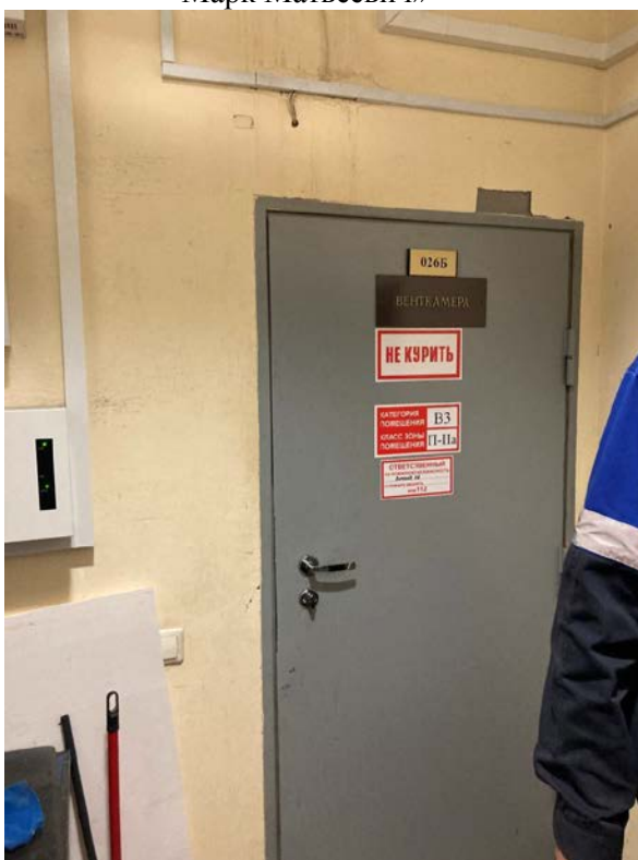
Фото 80. Интерьер цокольного этажа объекта культурного наследия регионального значения «Дом Утина И. Здесь с 1860 г. жил и в 1911 г. умер историк, издатель журнала "Вестник Европы" Стасюлевич Михаил Матвеевич. Здесь с 1893 г. жил и в 1895 г. умер ученый-машиностроитель Вышнеградский Иван Алексеевич. Здесь в 1884-1888 гг. останавливался скульптор Антокольский Марк Матвеевич»
