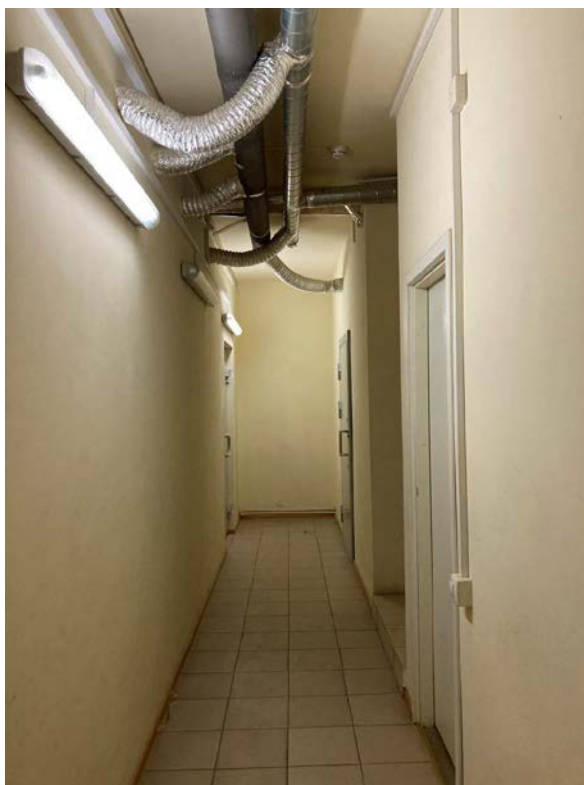
Фото 67. Интерьер цокольного этажа объекта культурного наследия регионального значения «Дом Утина И. Здесь с 1860 г. жил и в 1911 г. умер историк, издатель журнала "Вестник Европы" Стасюлевич Михаил Матвеевич. Здесь с 1893 г. жил и в 1895 г. умер ученый-машиностроитель Вышнеградский Иван Алексеевич. Здесь в 1884-1888 гг. останавливался скульптор Антокольский Марк Матвеевич»
