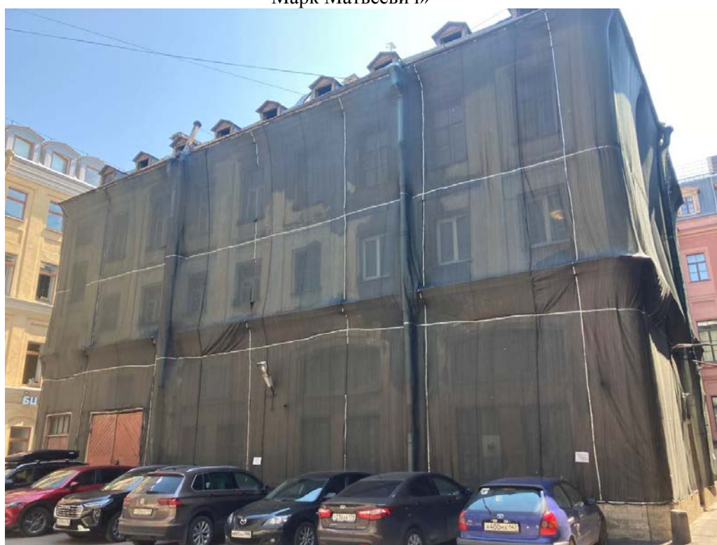
Фото 26. Фрагмент дворового фасада объекта культурного наследия регионального значения «Дом Утина И. Здесь с 1860 г. жил и в 1911 г. умер историк, издатель журнала "Вестник Европы" Стасюлевич Михаил Матвеевич. Здесь с 1893 г. жил и в 1895 г. умер ученый-машиностроитель Вышнеградский Иван Алексеевич. Здесь в 1884-1888 гг. останавливался скульптор Антокольский Марк Матвеевич»
