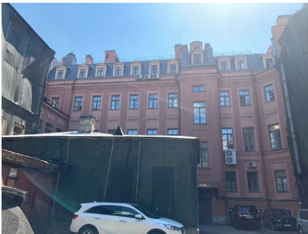
Фото 21. Фрагмент дворового фасада объекта культурного наследия регионального значения «Дом Утина И. Здесь с 1860 г. жил и в 1911 г. умер историк, издатель журнала "Вестник Европы" Стасюлевич Михаил Матвеевич. Здесь с 1893 г. жил и в 1895 г. умер ученый-машиностроитель Вышнеградский Иван Алексеевич. Здесь в 1884-1888 гг. останавливался скульптор Антокольский Марк Матвеевич»
