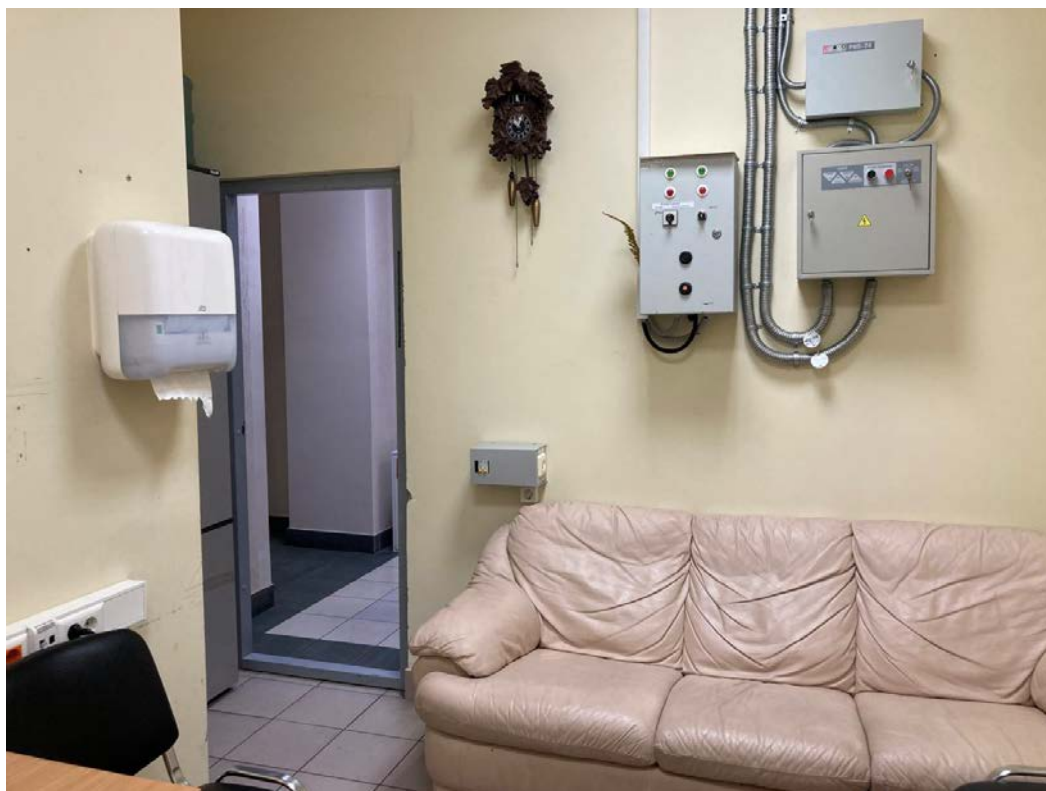
Фото 151. Интерьер 4 этажа объекта культурного наследия регионального значения «Дом Утина И. Здесь с 1860 г. жил и в 1911 г. умер историк, издатель журнала "Вестник Европы" Стасюлевич Михаил Матвеевич. Здесь с 1893 г. жил и в 1895 г. умер ученый-машиностроитель Вышнеградский Иван Алексеевич. Здесь в 1884-1888 гг. останавливался скульптор Антокольский Марк Матвеевич»
