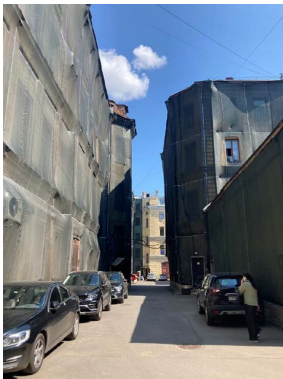
Фото 23. Фрагмент дворового фасада объекта культурного наследия регионального значения «Дом Утина И. Здесь с 1860 г. жил и в 1911 г. умер историк, издатель журнала "Вестник Европы" Стасюлевич Михаил Матвеевич. Здесь с 1893 г. жил и в 1895 г. умер ученый-машиностроитель Вышнеградский Иван Алексеевич. Здесь в 1884-1888 гг. останавливался скульптор Антокольский Марк Матвеевич»
