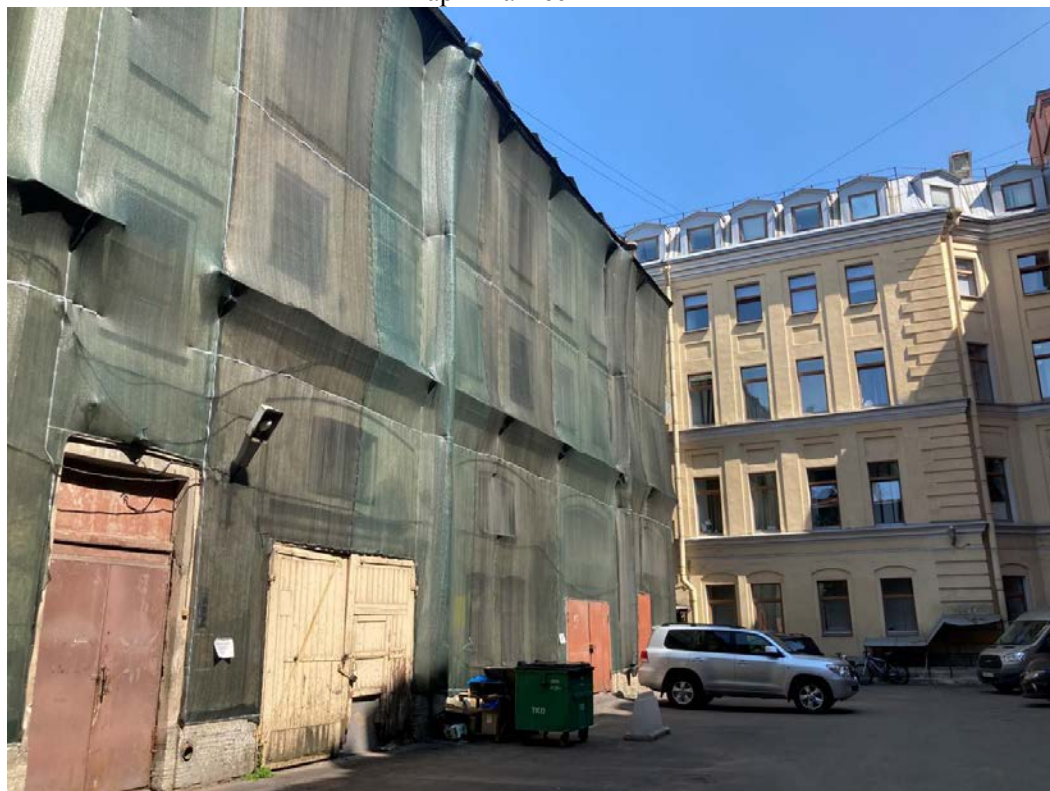
Фото 34. Фрагмент дворового фасада объекта культурного наследия регионального значения «Дом Утина И. Здесь с 1860 г. жил и в 1911 г. умер историк, издатель журнала "Вестник Европы" Стасюлевич Михаил Матвеевич. Здесь с 1893 г. жил и в 1895 г. умер ученый-машиностроитель Вышнеградский Иван Алексеевич. Здесь в 1884-1888 гг. останавливался скульптор Антокольский Марк Матвеевич»
