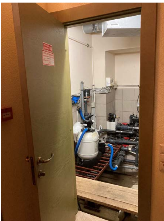
Фото 47. Интерьер цокольного этажа объекта культурного наследия регионального значения «Дом Утина И. Здесь с 1860 г. жил и в 1911 г. умер историк, издатель журнала "Вестник Европы" Стасюлевич Михаил Матвеевич. Здесь с 1893 г. жил и в 1895 г. умер ученый-машиностроитель Вышнеградский Иван Алексеевич. Здесь в 1884-1888 гг. останавливался скульптор Антокольский Марк Матвеевич»
