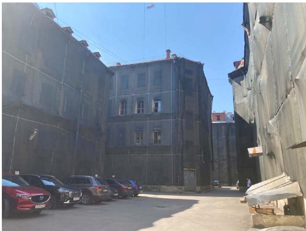
Фото 29. Фрагмент дворового фасада объекта культурного наследия регионального значения «Дом Утина И. Здесь с 1860 г. жил и в 1911 г. умер историк, издатель журнала "Вестник Европы" Стасюлевич Михаил Матвеевич. Здесь с 1893 г. жил и в 1895 г. умер ученый-машиностроитель Вышнеградский Иван Алексеевич. Здесь в 1884-1888 гг. останавливался скульптор Антокольский Марк Матвеевич»
