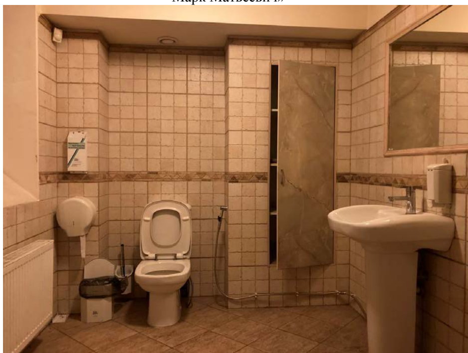
Фото 48. Интерьер цокольного этажа объекта культурного наследия регионального значения «Дом Утина И. Здесь с 1860 г. жил и в 1911 г. умер историк, издатель журнала "Вестник Европы" Стасюлевич Михаил Матвеевич. Здесь с 1893 г. жил и в 1895 г. умер ученый-машиностроитель Вышнеградский Иван Алексеевич. Здесь в 1884-1888 гг. останавливался скульптор Антокольский Марк Матвеевич»
