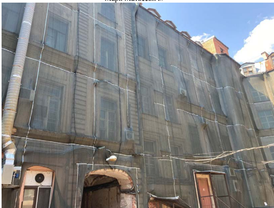
Фото 20. Фрагмент дворового фасада объекта культурного наследия регионального значения «Дом Утина И. Здесь с 1860 г. жил и в 1911 г. умер историк, издатель журнала "Вестник Европы" Стасюлевич Михаил Матвеевич. Здесь с 1893 г. жил и в 1895 г. умер ученый-машиностроитель Вышнеградский Иван Алексеевич. Здесь в 1884-1888 гг. останавливался скульптор Антокольский Марк Матвеевич»
