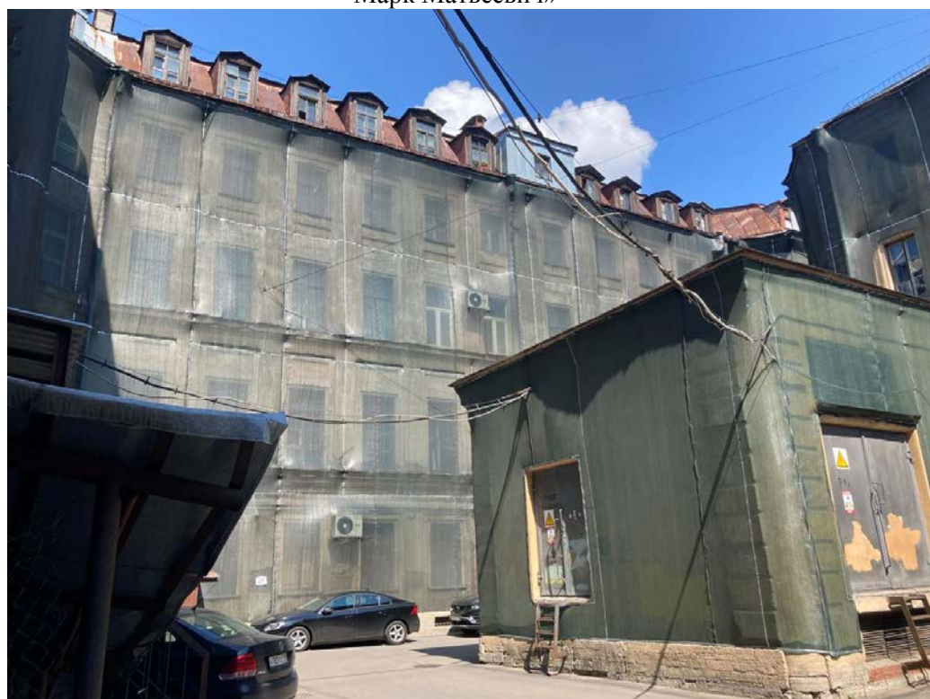
Фото 16. Фрагмент дворового фасада объекта культурного наследия регионального значения «Дом Утина И. Здесь с 1860 г. жил и в 1911 г. умер историк, издатель журнала "Вестник Европы" Стасюлевич Михаил Матвеевич. Здесь с 1893 г. жил и в 1895 г. умер ученый-машиностроитель Вышнеградский Иван Алексеевич. Здесь в 1884-1888 гг. останавливался скульптор Антокольский Марк Матвеевич»
