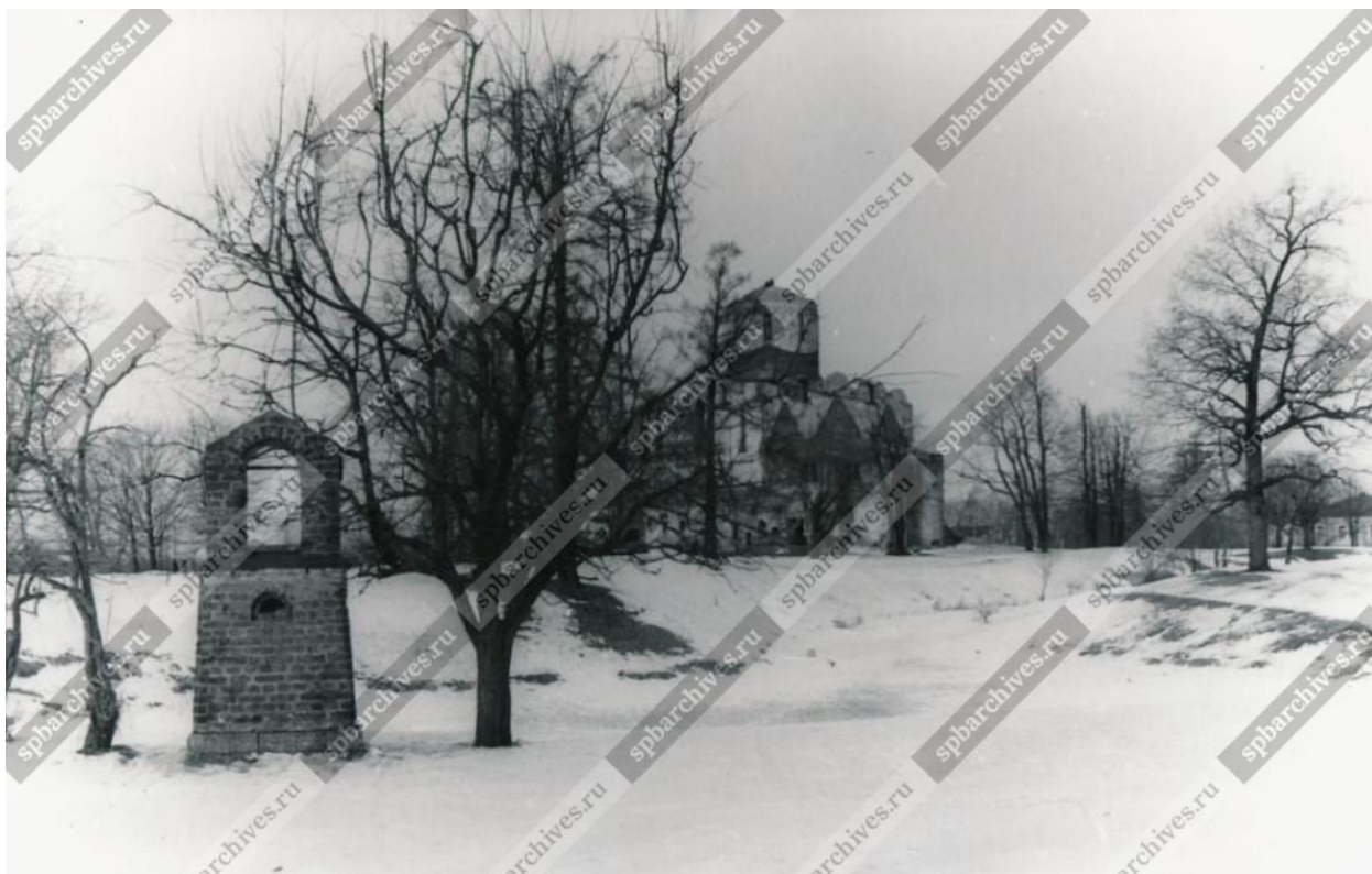
Илл. 38. Вид на разрушенный Федоровский собор со стороны Александровского парка, слева разрушенный фонарь в виде звонницы. Апрель 1973 г. (источник: ЦГАКФФД СПб. Фотодокумент Ар 236309).
