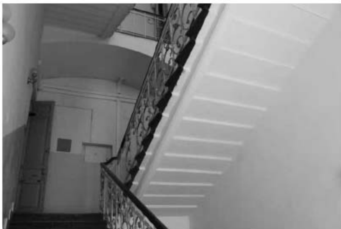
Фото 170. Выявленный объект культурного наследия «Корпус квартир офицеров (угловой)» (объект культурного наследия регионального значения «Академия Михайловская артиллерийская, где преподавали ученые Ленц Э.Х., Остроградский М.В., Петрушевский В.Ф.»). 9ЛК. Фото 03.05.2023 г.
