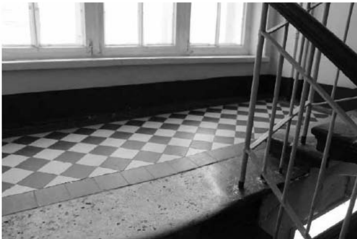
Фото 184. Выявленный объект культурного наследия «Орудийный сарай». Лестница 44-Н. Фото 03.05.2023 г.
