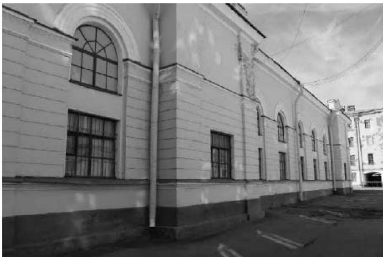
Фото 71. Вид на восточный фасад выявленного объекта культурного наследия «Экипажный сарай с конюшнями». Фото 03.05.2023 г.
