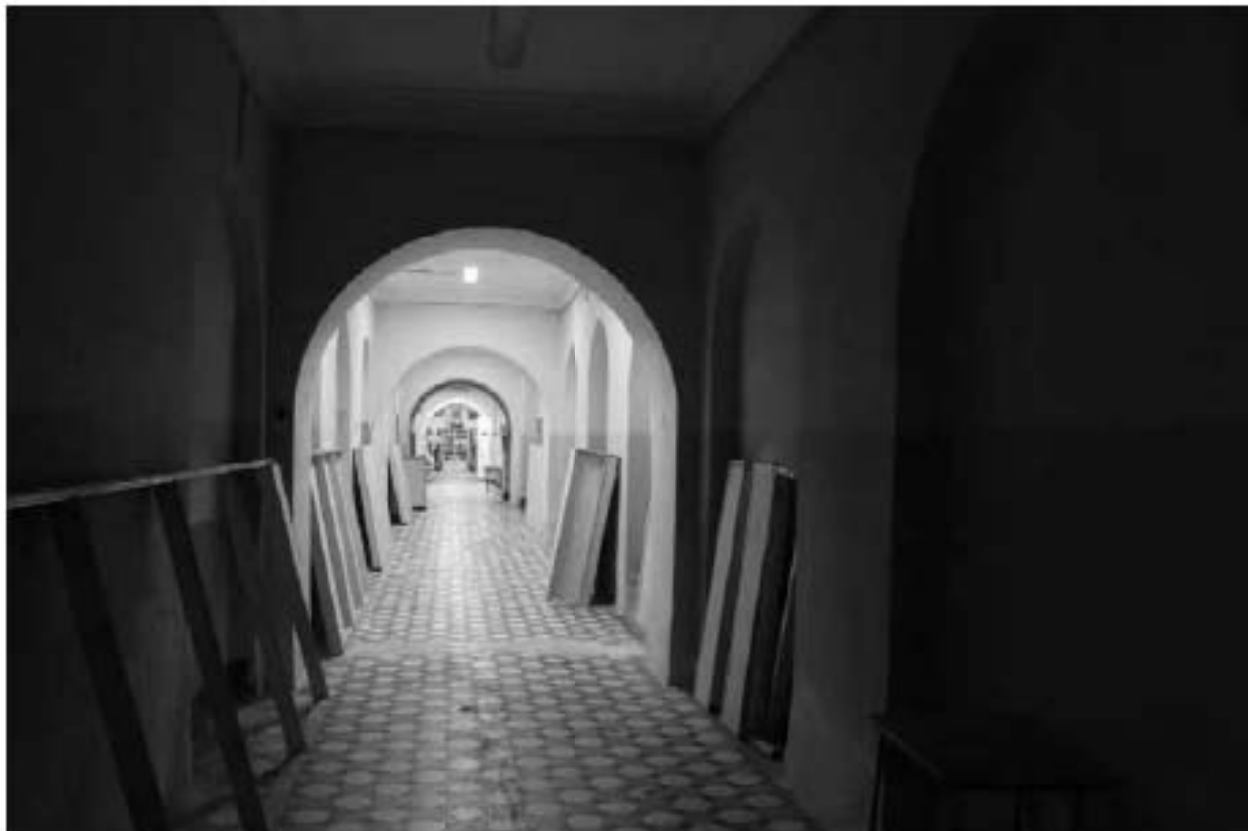
Фото 94. Выявленный объект культурного наследия «Главный корпус с 1-м солдатским корпусом, офицерским флигелем и Михайловское артиллерийское училище». Внутренние помещения 1-го этажа. Фото 03.05.2023 г.
