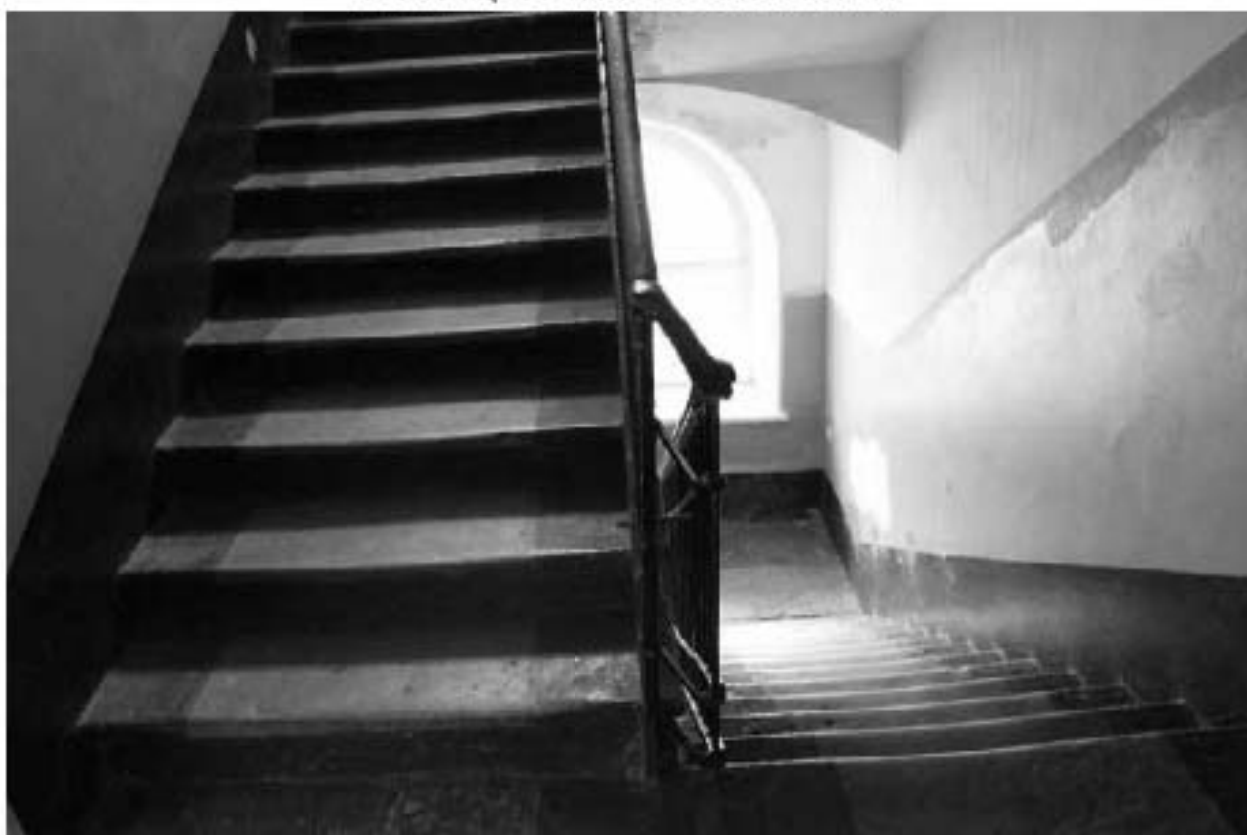
Фото 212. Выявленный объект культурного наследия «Лабораторный корпус». Лестница 99-Н. Фото 03.05.2023 г.
