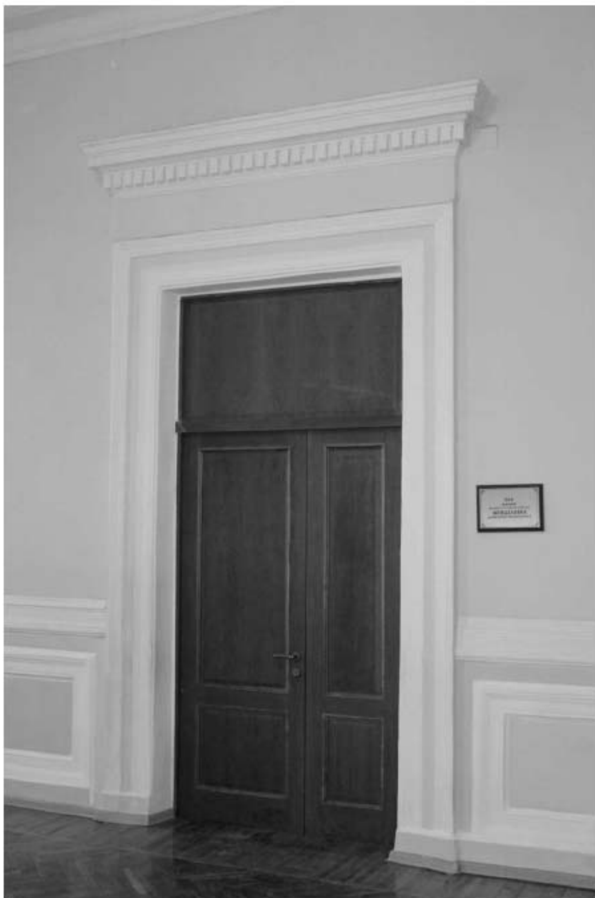
Фото 128. Выявленный объект культурного наследия «Лабораторный корпус». 15ЛК. Фото 03.05.2023 г.
