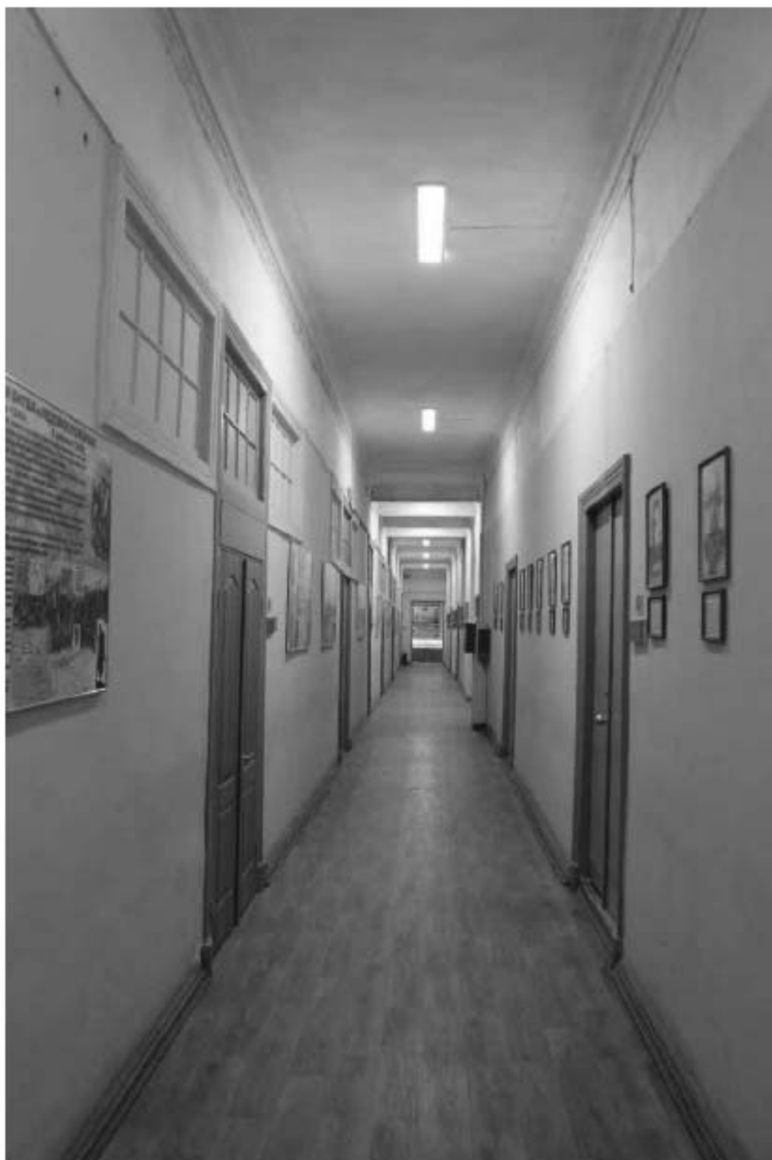
Фото 111. Выявленный объект культурного наследия «Главный корпус с 1-м солдатским корпусом, офицерским флигелем и Михайловское артиллерийское училище». Внутренние помещения 3-го этажа. Фото 03.05.2023 г.
