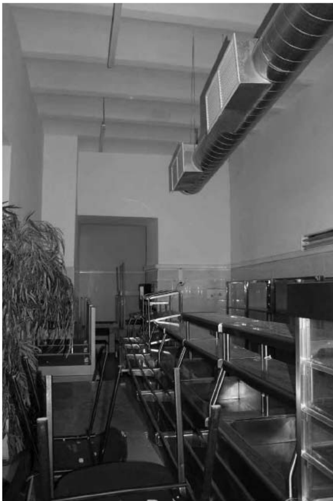
Фото 131. Выявленный объект культурного наследия «Лабораторный корпус». Внутренние помещения 3-го этажа. Фото 03.05.2023 г.
