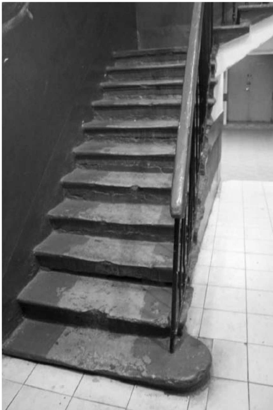
Фото 207. Выявленный объект культурного наследия «Пиротехническая школа». 13ЛК. Фото 03.05.2023 г.
