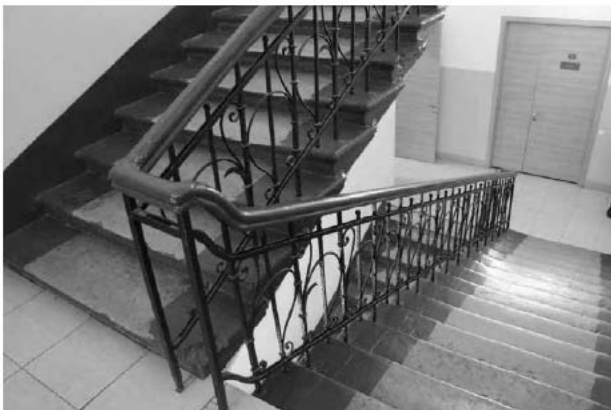
Фото 197. Выявленный объект культурного наследия «Пиротехническая школа». 12ЛК. Фото 03.05.2023 г.
