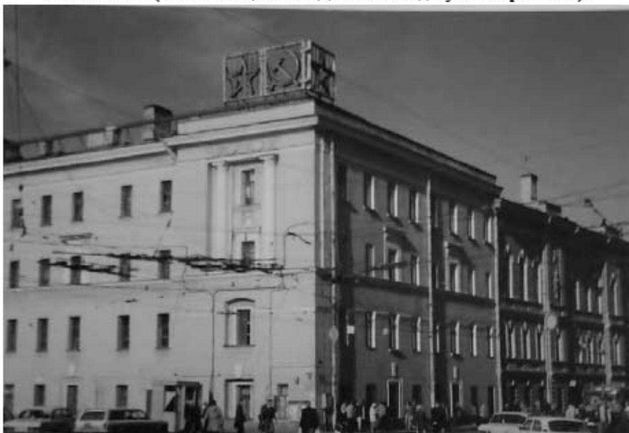
Илл. 109. Фасад восточного корпуса на углу ул. Комсомола и пл. Ленина. 1996 г. (источник: архив КГИОП П. 408. Пр-4).
