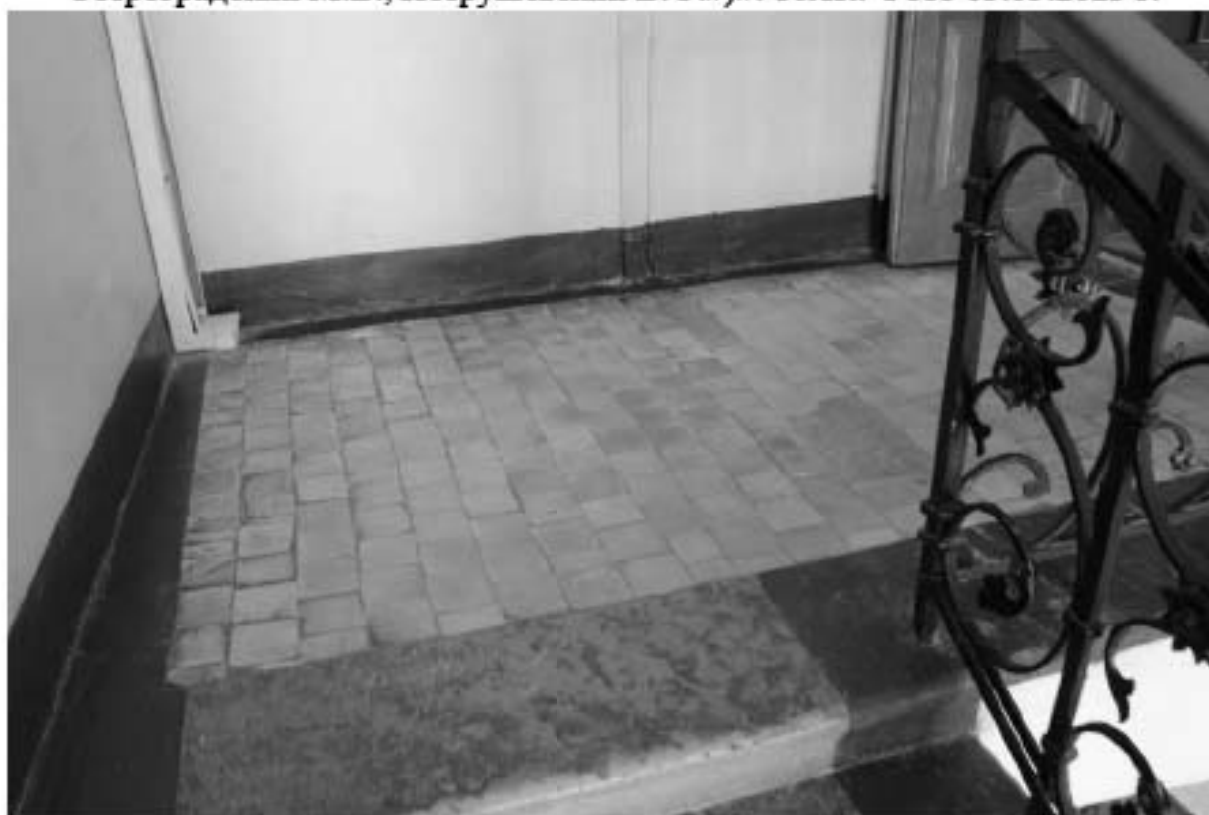
Фото 179. Выявленный объект культурного наследия «Корпус квартир офицеров (угловой)» (объект культурного наследия регионального значения «Академия Михайловская артиллерийская, где преподавали ученые Ленц Э.Х., Остроградский М.В., Петрушевский В.Ф.»). 10ЛК. Фото 03.05.2023 г.
