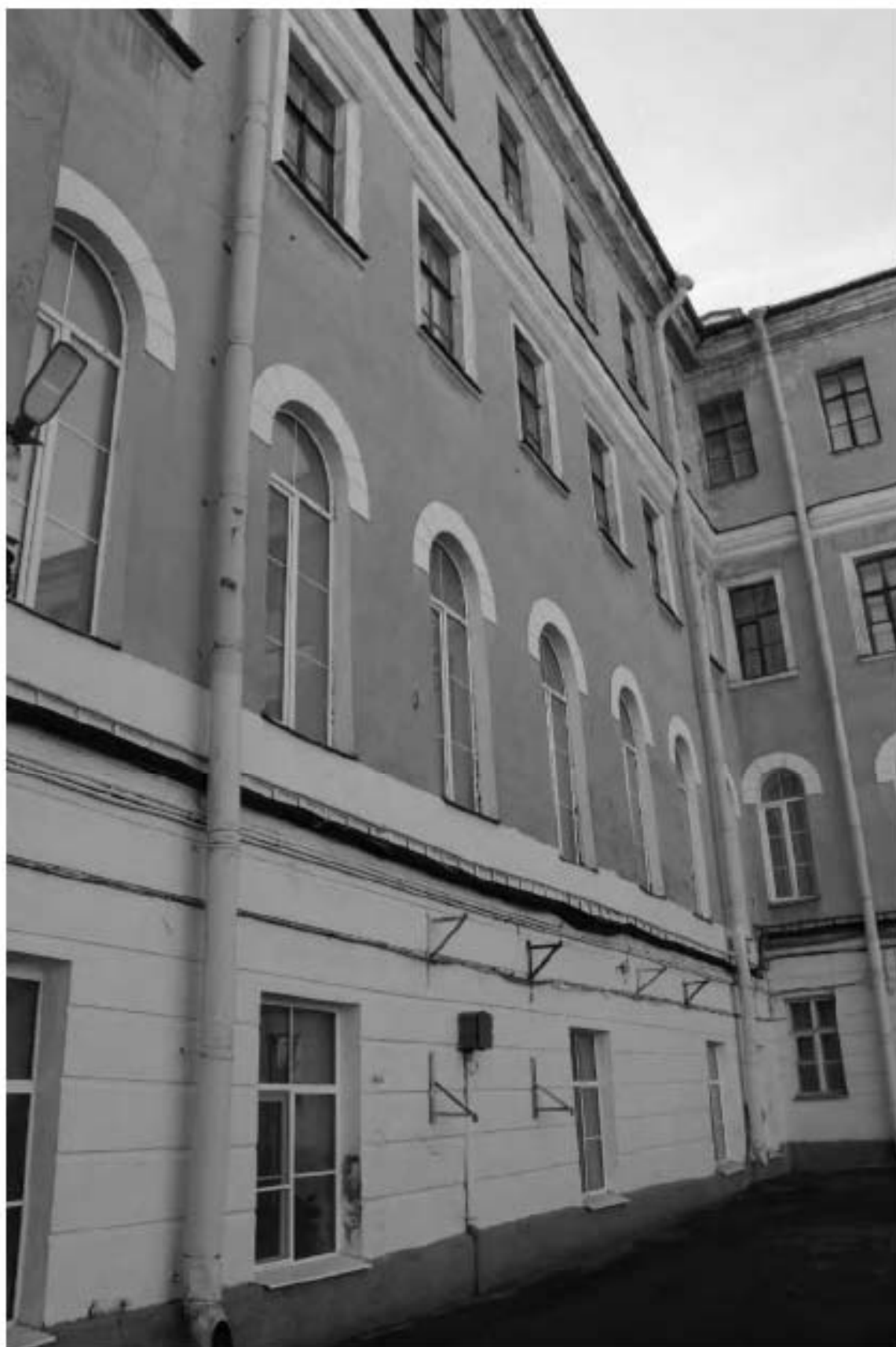
Фото 34. Вид на северный фасад южного корпуса выявленного объекта культурного наследия «Главный корпус с 1-м солдатским корпусом, офицерским флигелем и Михайловское артиллерийское училище». Фото 03.05.2023 г.
