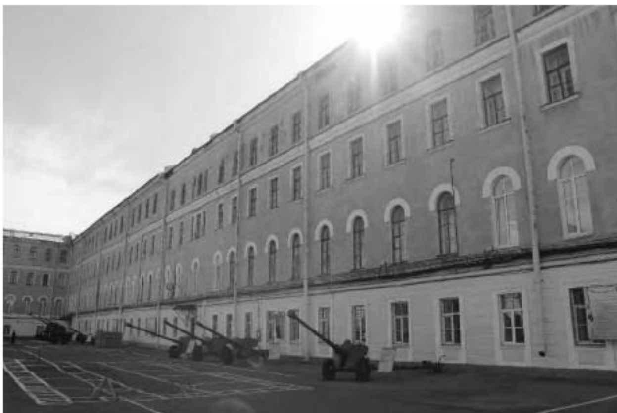
Фото 37. Вид на восточный фасад западного корпуса выявленного объекта культурного наследия «Главный корпус с 1-м солдатским корпусом, офицерским флигелем и Михайловское артиллерийское училище». Фото 03.05.2023 г.
