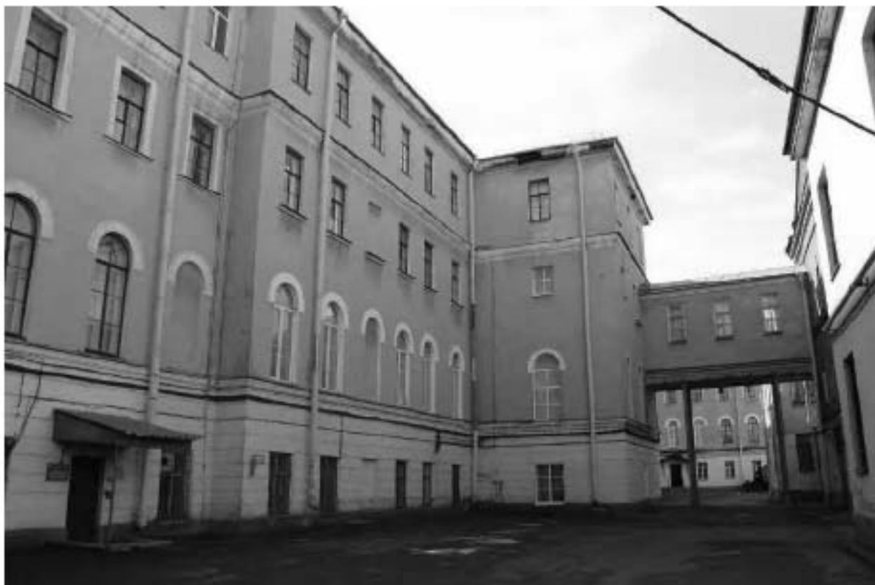
Фото 32. Вид на северный фасад южного корпуса выявленного объекта культурного наследия «Главный корпус с 1-м солдатским корпусом, офицерским флигелем и Михайловское артиллерийское училище». Фото 03.05.2023 г.
