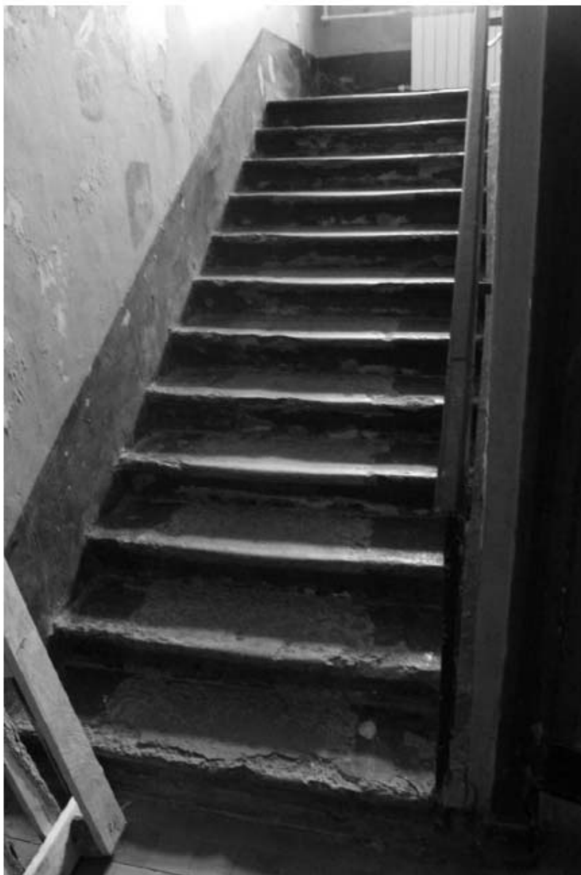
Фото 210. Выявленный объект культурного наследия «Лабораторный корпус». Лестница 99-Н. Фото 03.05.2023 г.
