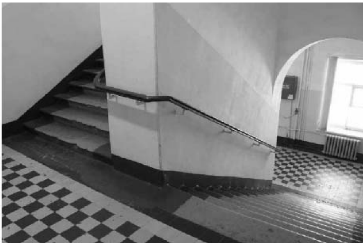
Фото 101. Выявленный объект культурного наследия «Главный корпус с 1-м солдатским корпусом, офицерским флигелем и Михайловское артиллерийское училище». 4ЛК. Фото 03.05.2023 г.
