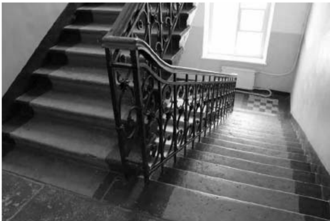
Фото 176. Выявленный объект культурного наследия «Корпус квартир офицеров (угловой)» (объект культурного наследия регионального значения «Академия Михайловская артиллерийская, где преподавали ученые Ленц Э.Х., Остроградский М.В., Петрушевский В.Ф.»). 10ЛК. Фото 03.05.2023 г.
