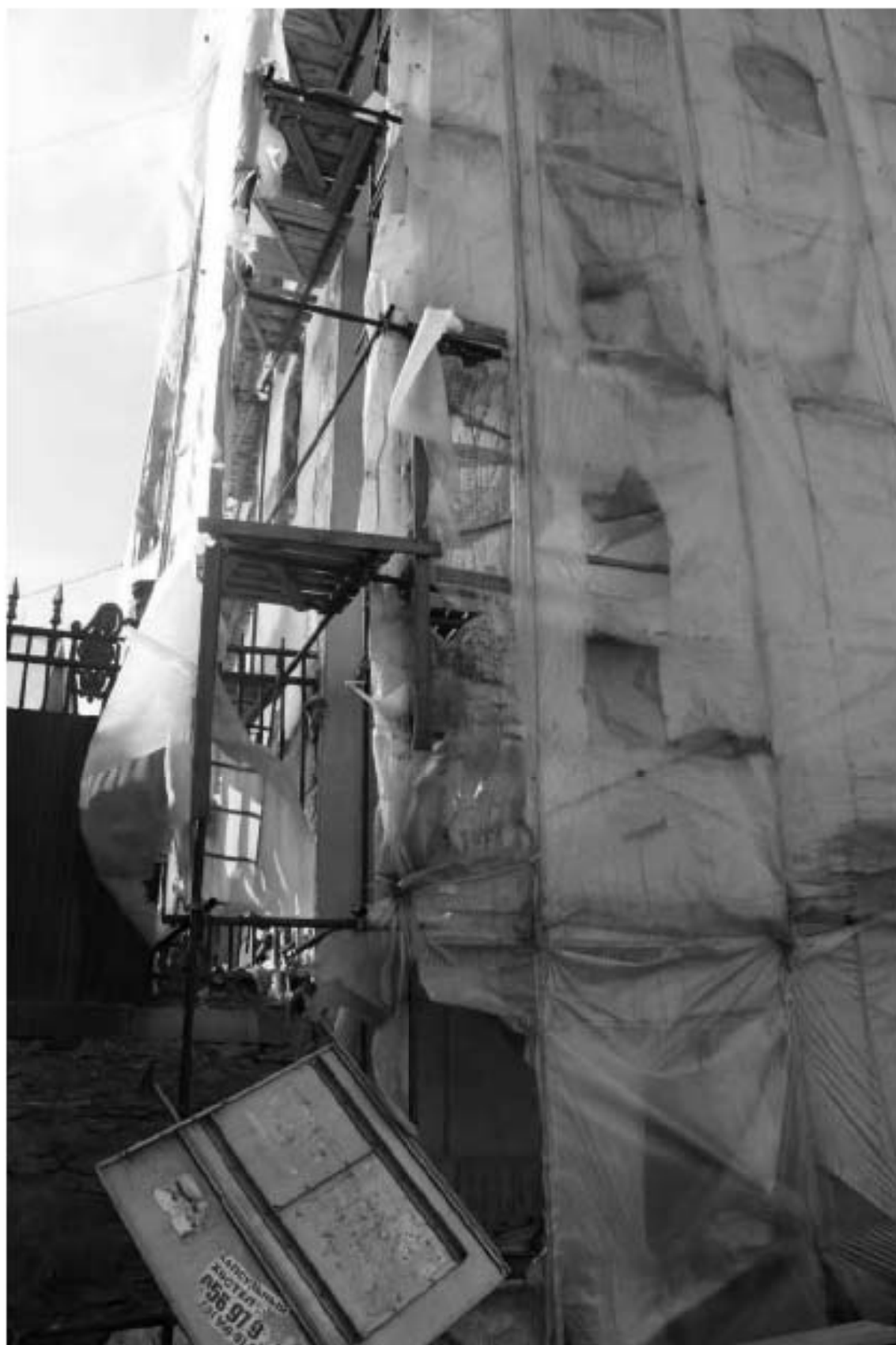
Фото 57. Вид на южный фасад выявленного объекта культурного наследия «Пиротехническая школа». Фото 03.05.2023 г.
