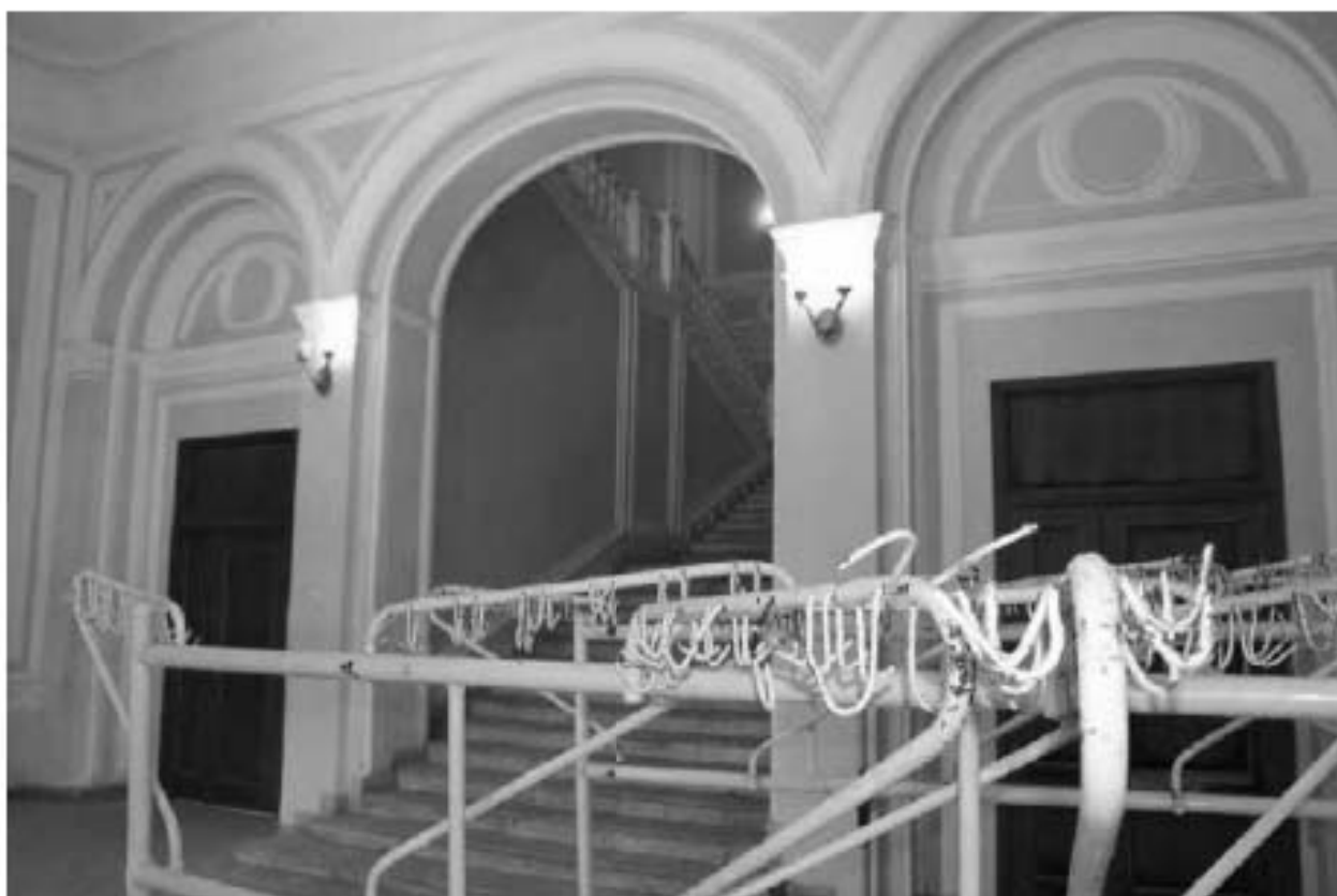
Фото 122. Выявленный объект культурного наследия «Лабораторный корпус». Внутренние помещения 1-го этажа. Фото 03.05.2023 г.
