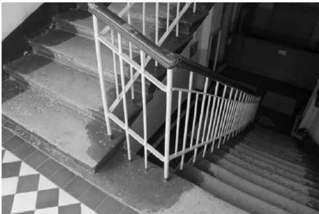
Фото 185. Выявленный объект культурного наследия «Орудийный сарай». Лестница 44-Н. Фото 03.05.2023 г.
