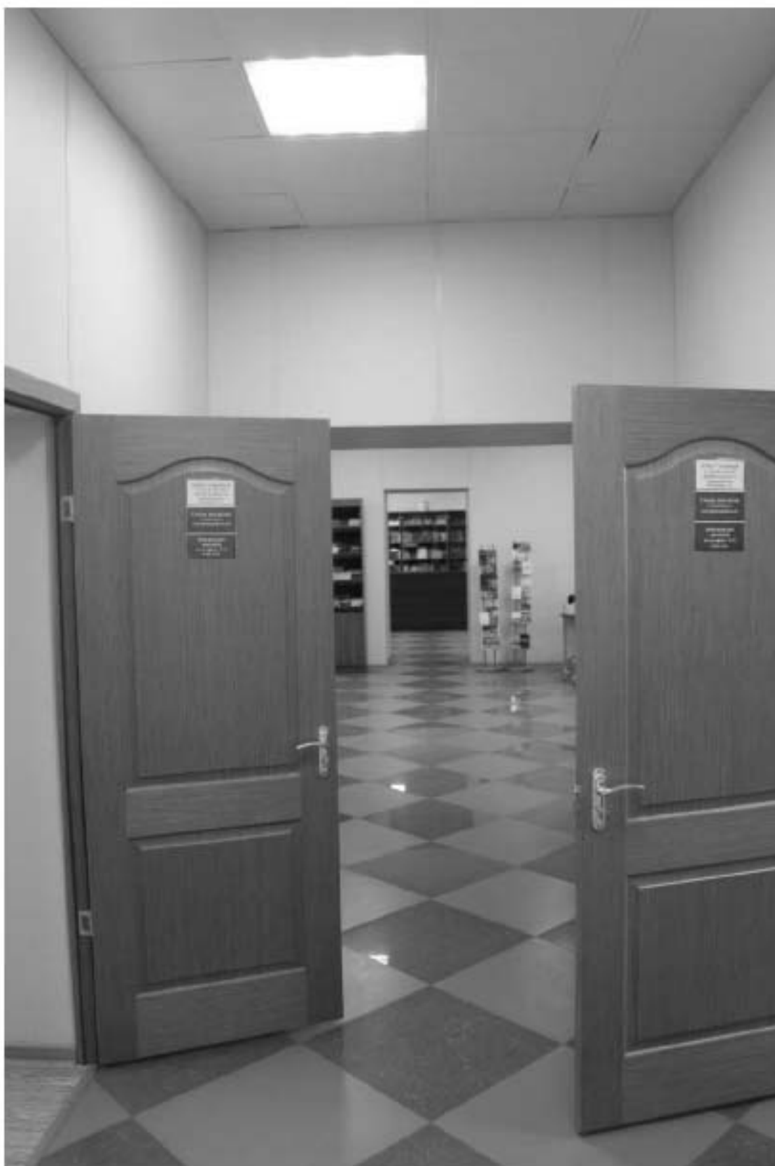
Фото 161. Выявленный объект культурного наследия «Главный корпус с 1-м солдатским корпусом, офицерским флигелем и Михайловское артиллерийское училище». Внутренние помещения 1-го этажа. Фото 03.05.2023 г.
