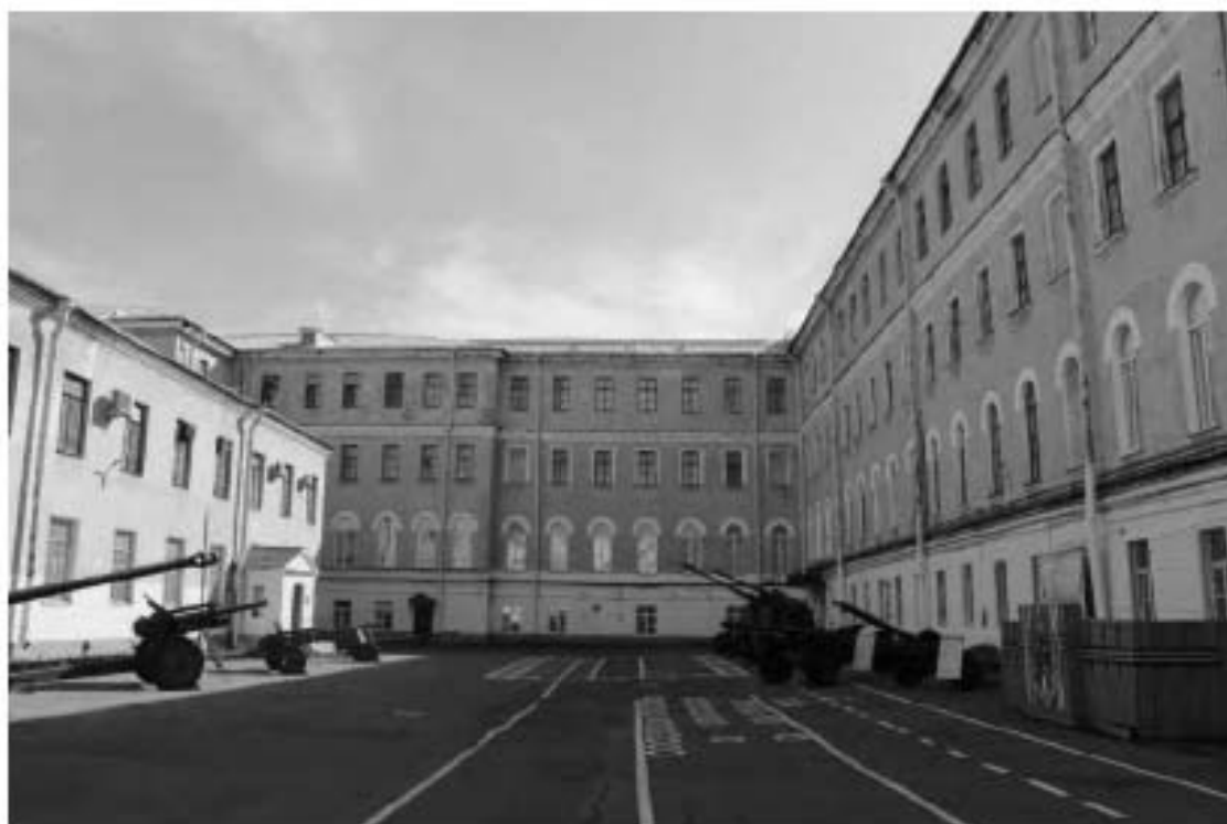
Фото 36. Вид на северный фасад южного корпуса и восточный фасад западного корпуса выявленного объекта культурного наследия «Главный корпус с 1-м солдатским корпусом, офицерским флигелем и Михайловское артиллерийское училище». Фото 03.05.2023 г.
