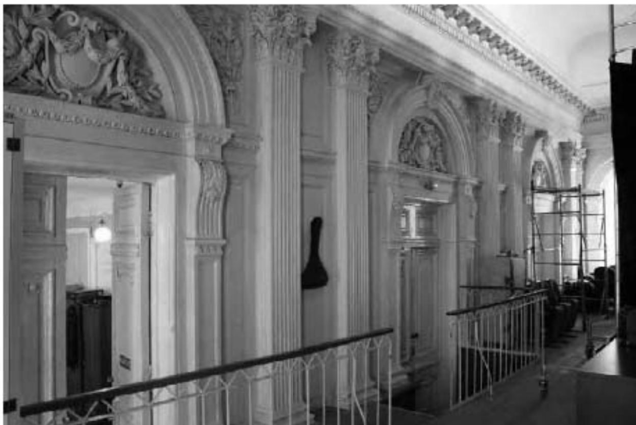
Фото 85. Выявленный объект культурного наследия «Главный корпус с 1-м солдатским корпусом, офицерским флигелем и Михайловское артиллерийское училище». Внутренние помещения 3-го этажа. Фото 03.05.2023 г.
