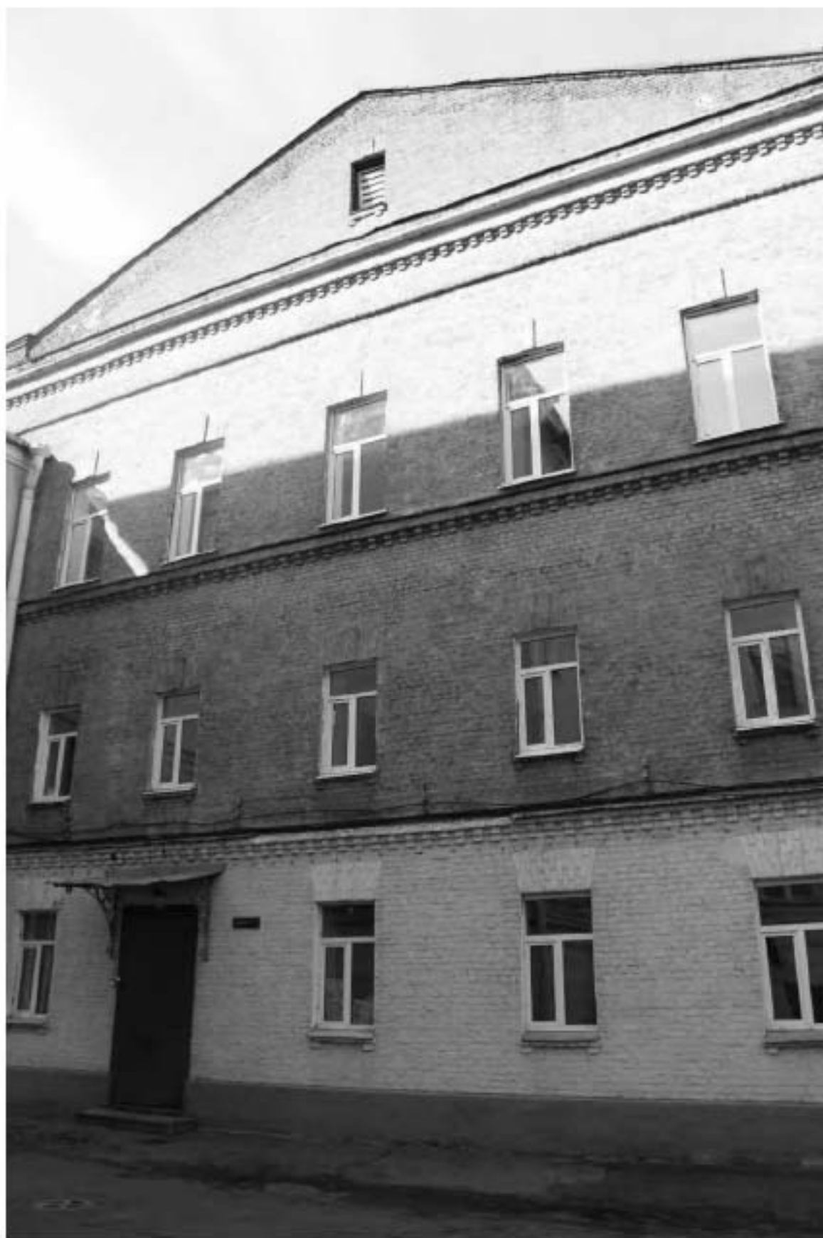
Фото 52. Вид на южный фасад выявленного объекта культурного наследия «Баня». Фото 03.05.2023 г.
