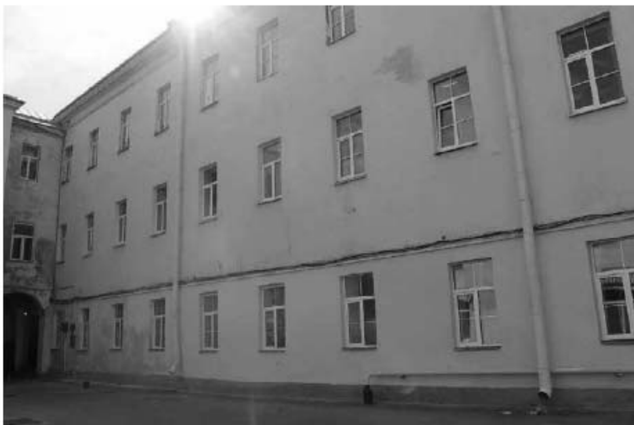
Фото 60. Вид на восточный фасад выявленного объекта культурного наследия «Пиротехническая школа». Фото 03.05.2023 г.
