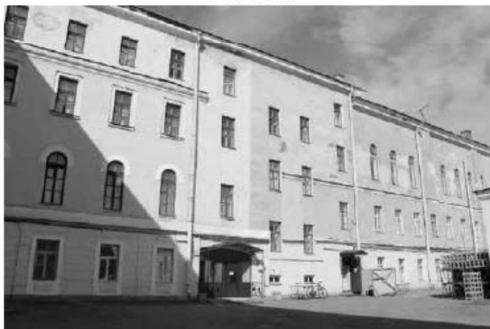
Фото 27. Вид на южный фасад северного корпуса выявленного объекта культурного наследия «Главный корпус с 1-м солдатским корпусом, офицерским флигелем и Михайловское артиллерийское училище». Фото 03.05.2023 г.
