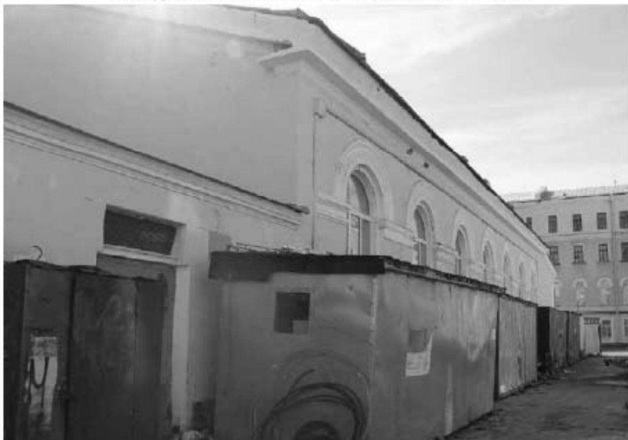
Фото 48. Вид на северный фасад выявленного объекта культурного наследия «Малый манеж». Фото 03.05.2023 г.
