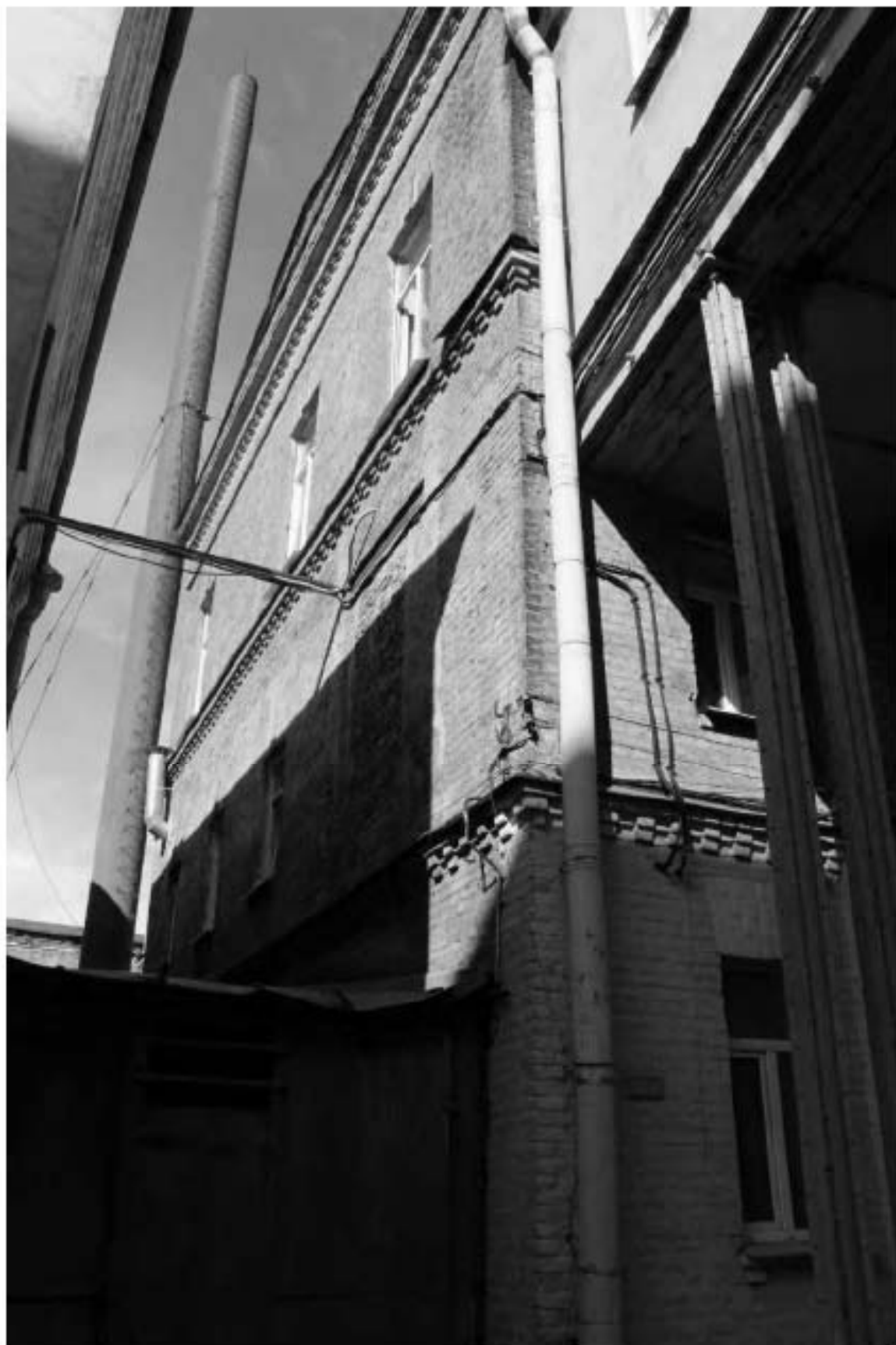
Фото 54. Вид на западный фасад выявленного объекта культурного наследия «Баня». Фото 03.05.2023 г.
