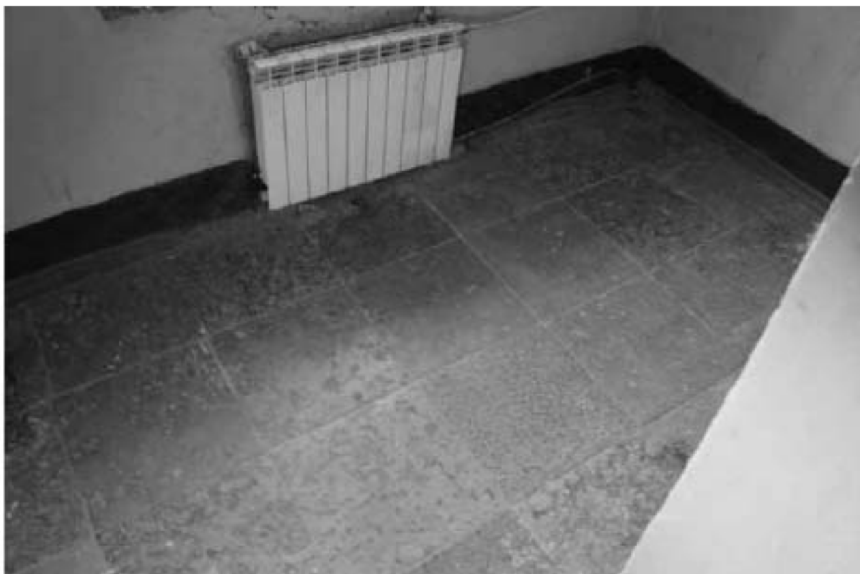
Фото 202. Выявленный объект культурного наследия «Пиротехническая школа». 11ЛК. Фото 03.05.2023 г.
