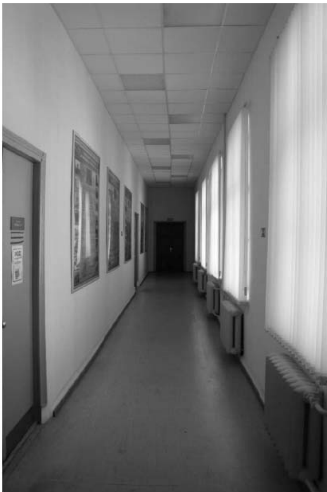
Фото 112. Выявленный объект культурного наследия «Главный корпус с 1-м солдатским корпусом, офицерским флигелем и Михайловское артиллерийское училище». Внутренние помещения 3-го этажа. Фото 03.05.2023 г.
