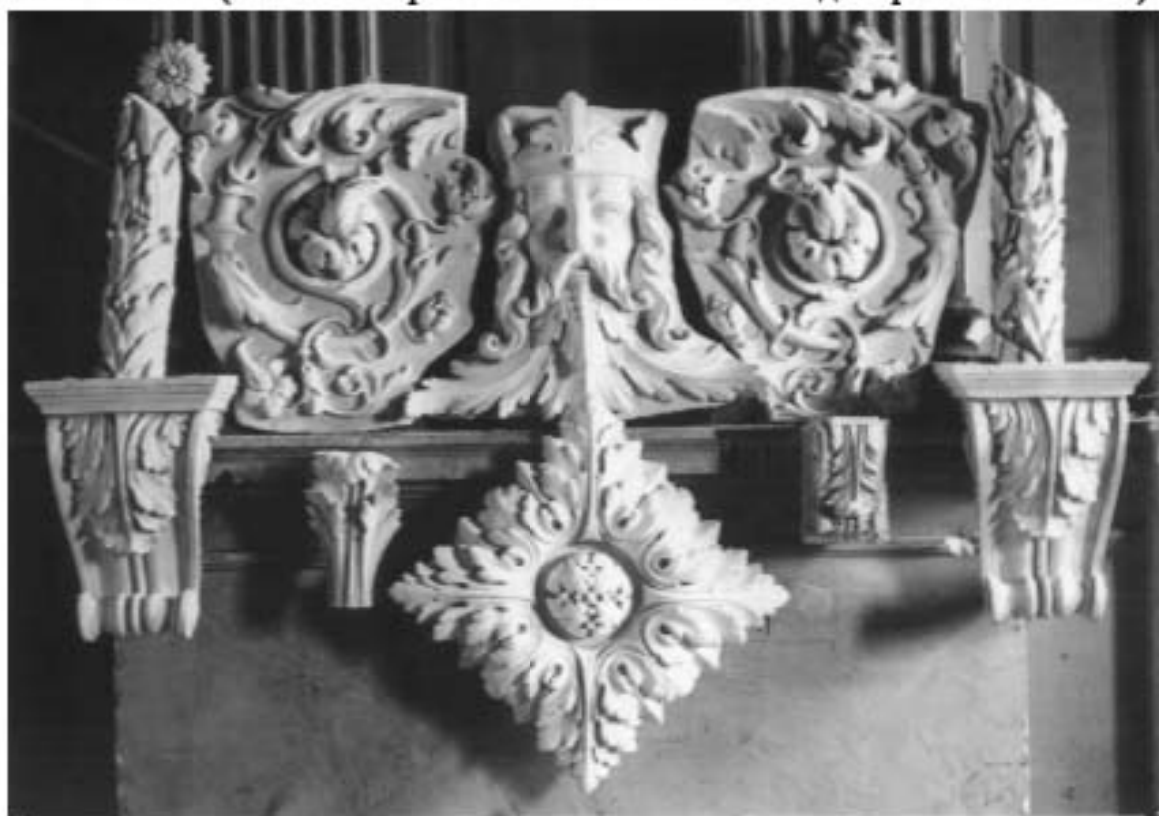
Илл. 86. Детали лепки, изготовленные для реставрации зала Высшей офицерской артиллерийской школы. 19.04.1946 г. (источник: архив КГИОП. Фототека отд. охр. пам. № 17099).
