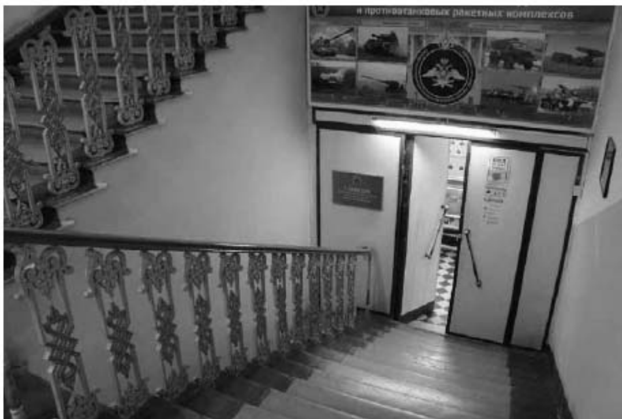
Фото 91. Выявленный объект культурного наследия «Главный корпус с 1-м солдатским корпусом, офицерским флигелем и Михайловское артиллерийское училище». ЗЛК. Фото 03.05.2023 г.
