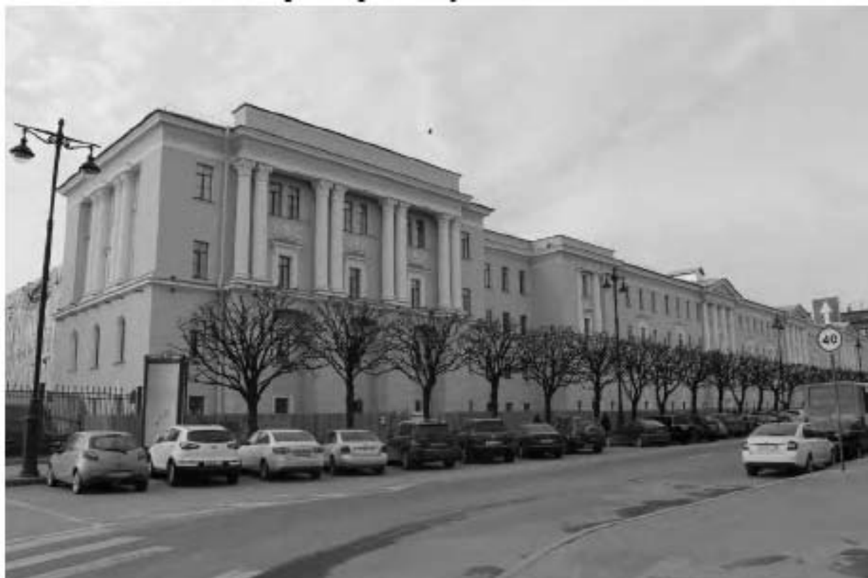
Фото 10. Вид на лицевой фасад по пл. Ленина выявленного объекта культурного наследия «Главный корпус с 1-м солдатским корпусом, офицерским флигелем и Михайловское артиллерийское училище». Фото 17.04.2023 г.
