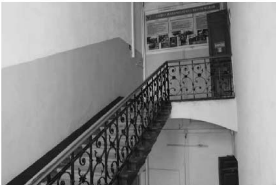
Фото 178. Выявленный объект культурного наследия «Корпус квартир офицеров (угловой)» (объект культурного наследия регионального значения «Академия Михайловская артиллерийская, где преподавали ученые Ленц Э.Х., Остроградский М.В., Петрушевский В.Ф.»). 10ЛК. Фото 03.05.2023 г.
