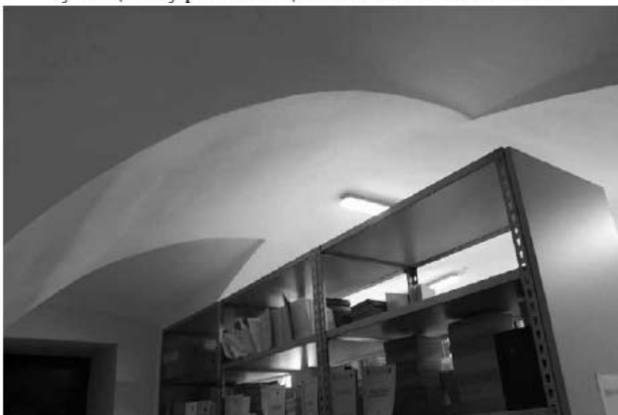
Фото 165. Выявленный объект культурного наследия «Главный корпус с 1-м солдатским корпусом, офицерским флигелем и Михайловское артиллерийское училище». Внутренние помещения 1-го этажа. Фото 03.05.2023 г.
