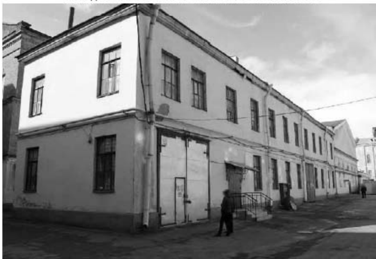
Фото 44. Вид на юго-восточное крыло выявленного объекта культурного наследия «Манеж с конюшнями». Фото 03.05.2023 г.
