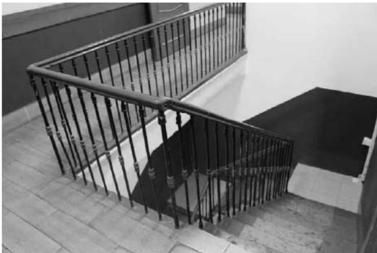
Фото 204. Выявленный объект культурного наследия «Пиротехническая школа». 13ЛК. Фото 03.05.2023 г.
