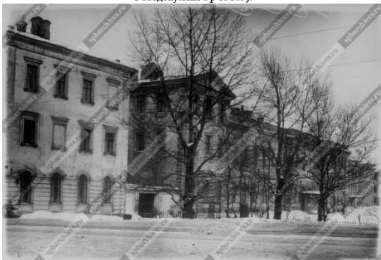
Илл. 72. Вид на южные фасады Пиротехнической школы и лабораторного корпуса. 04.08.1926 г. (источник: ЦГАКФФД СПб. Фотодокумент Гр 65101).
