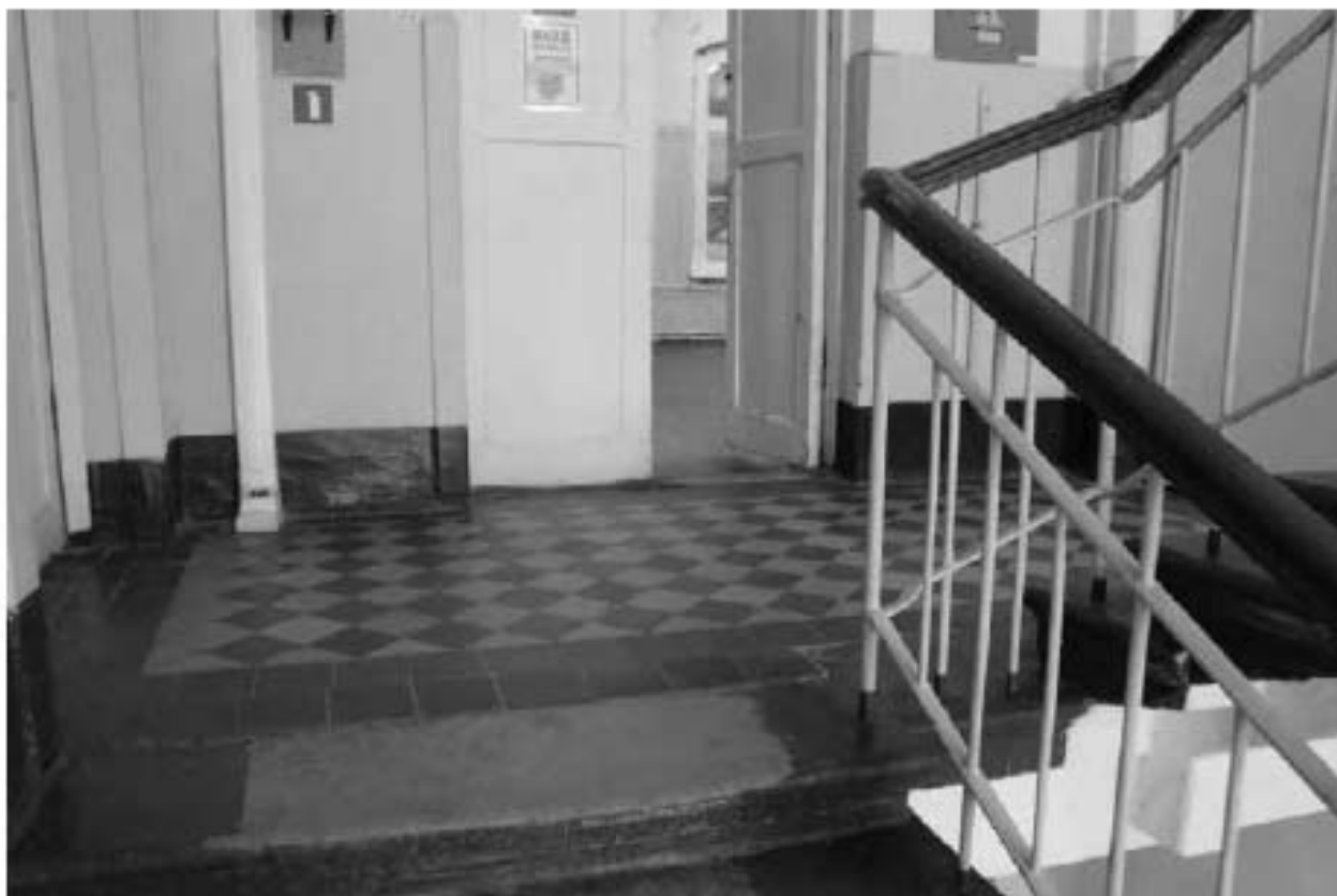
Фото 186. Выявленный объект культурного наследия «Орудийный сарай». Лестница 44-Н. Фото 03.05.2023 г.
