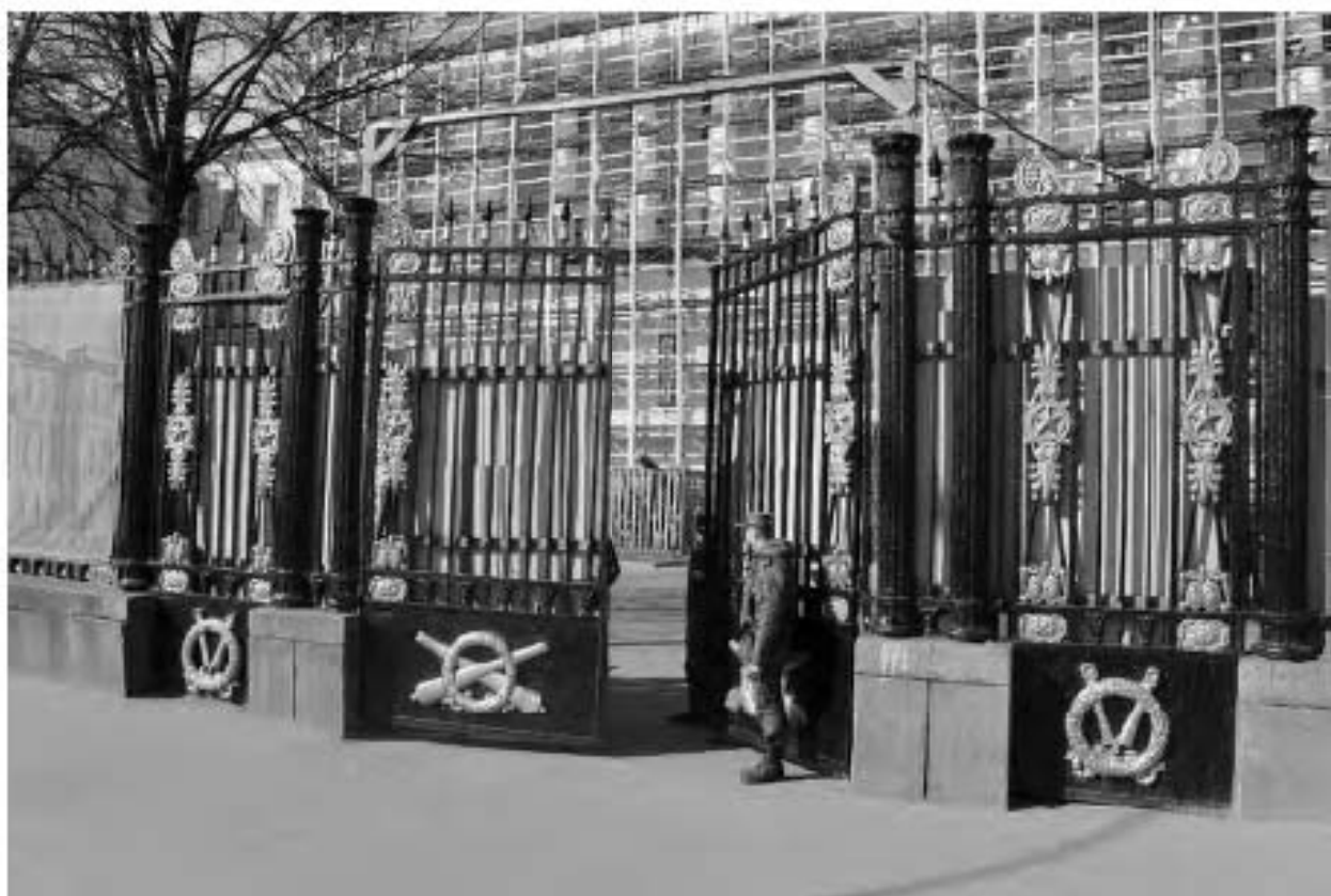
Фото 13. Вид на ворота, ведущие на территорию выявленного объекта культурного наследия «Комплекс зданий Михайловского военного училища и академии». Фото 03.05.2023 г.
