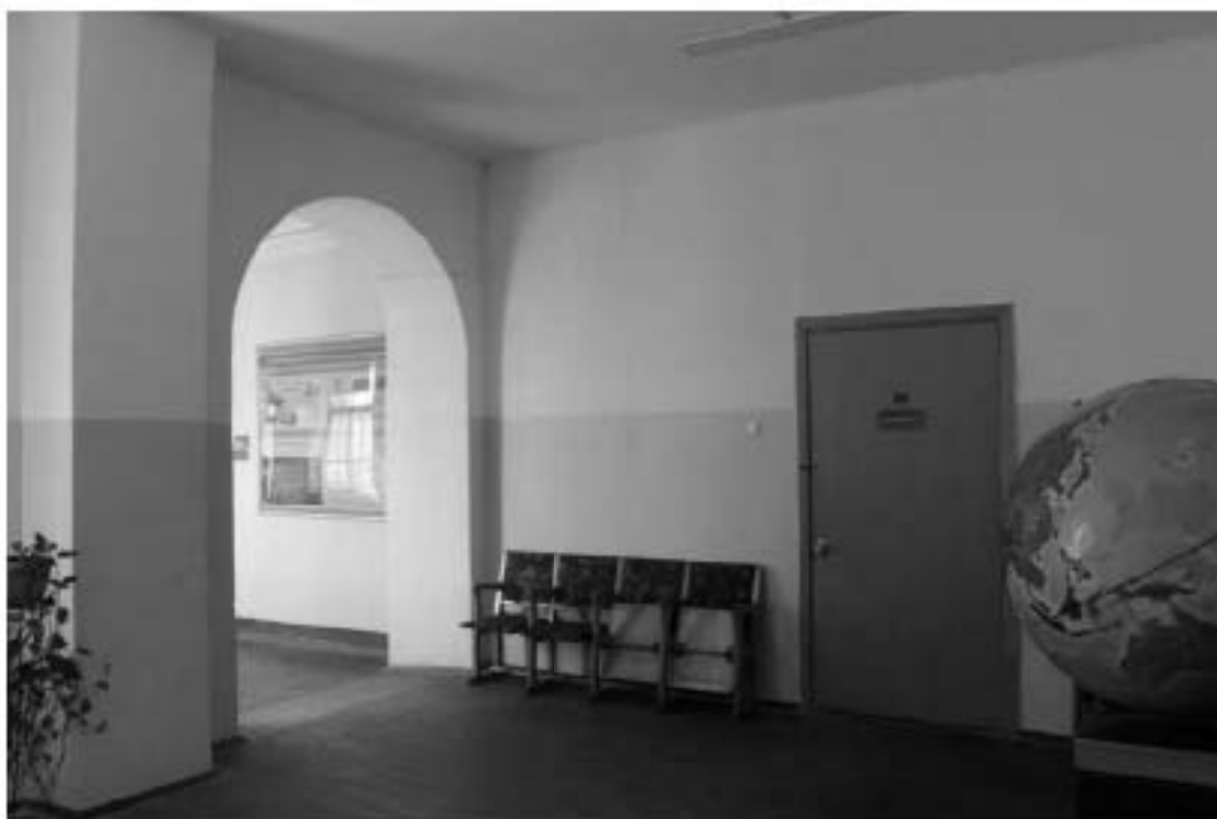
Фото 155. Выявленный объект культурного наследия «Главный корпус с 1-м солдатским корпусом, офицерским флигелем и Михайловское артиллерийское училище». Внутренние помещения 4-го этажа. Фото 03.05.2023 г.
