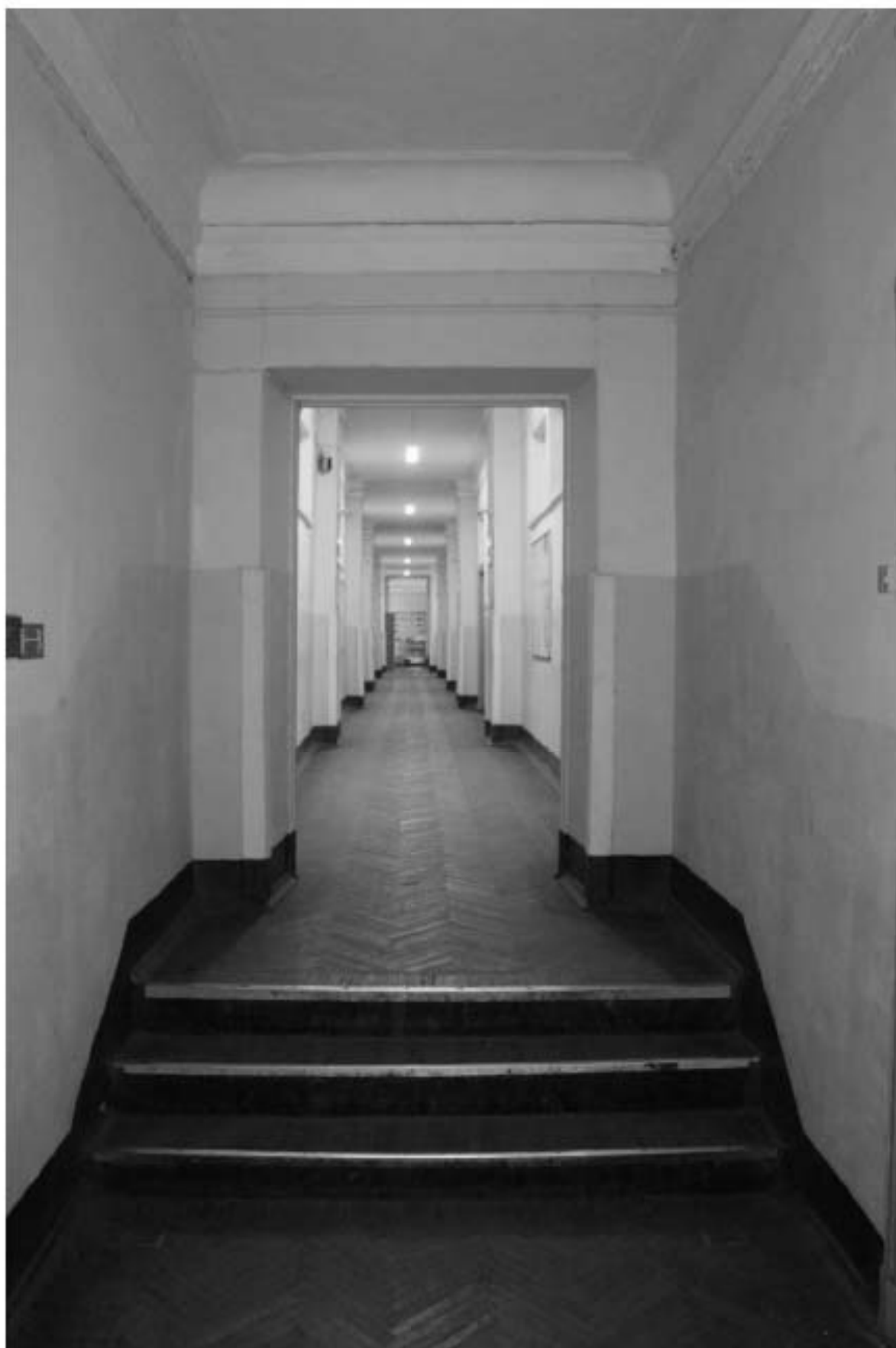
Фото 158. Выявленный объект культурного наследия «Главный корпус с 1-м солдатским корпусом, офицерским флигелем и Михайловское артиллерийское училище». Внутренние помещения 4-го этажа. Фото 03.05.2023 г.
