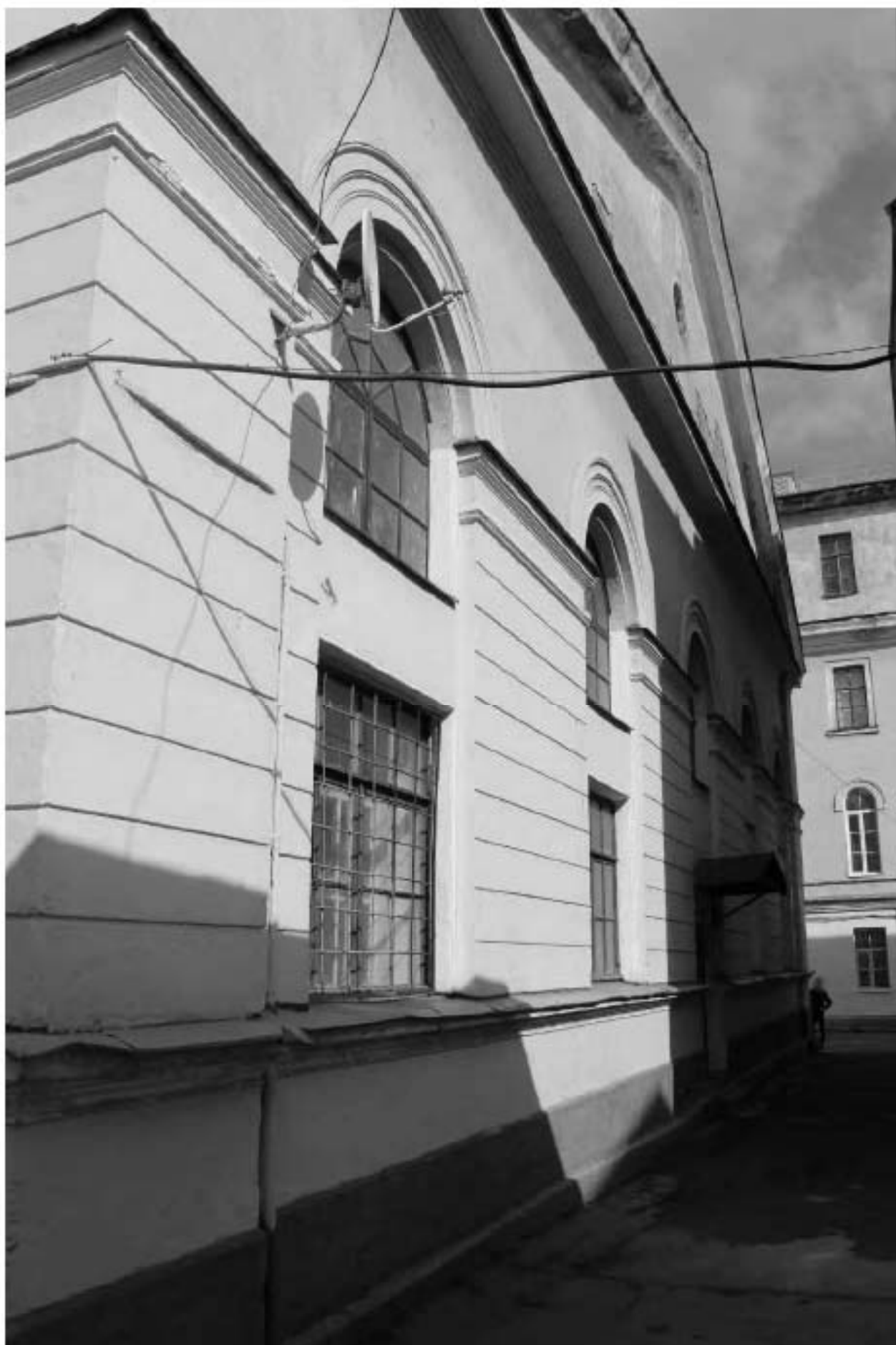
Фото 70. Вид на южный фасад выявленного объекта культурного наследия «Экипажный сарай с конюшнями». Фото 03.05.2023 г.
