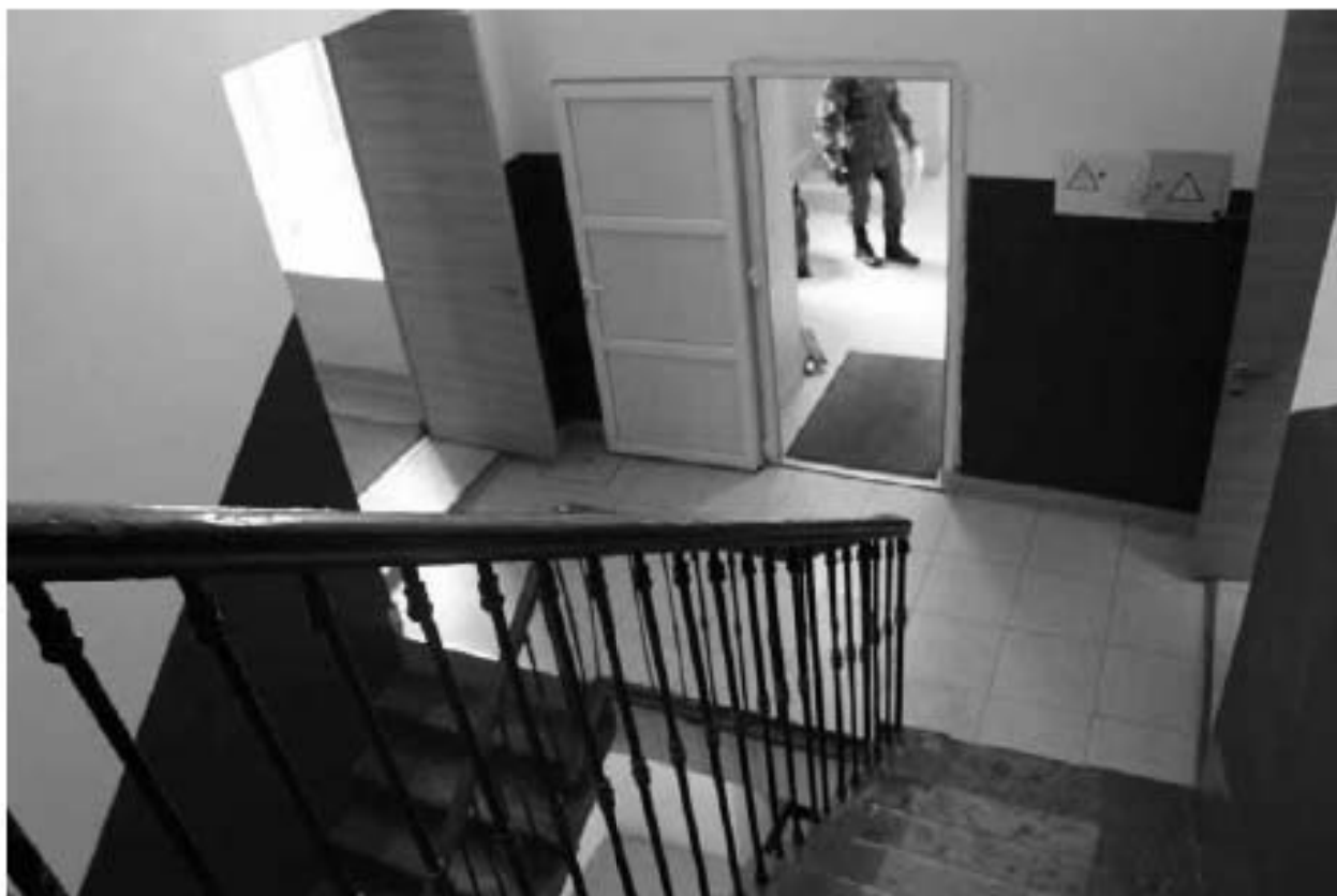
Фото 206. Выявленный объект культурного наследия «Пиротехническая школа». 13ЛК. Фото 03.05.2023 г.
