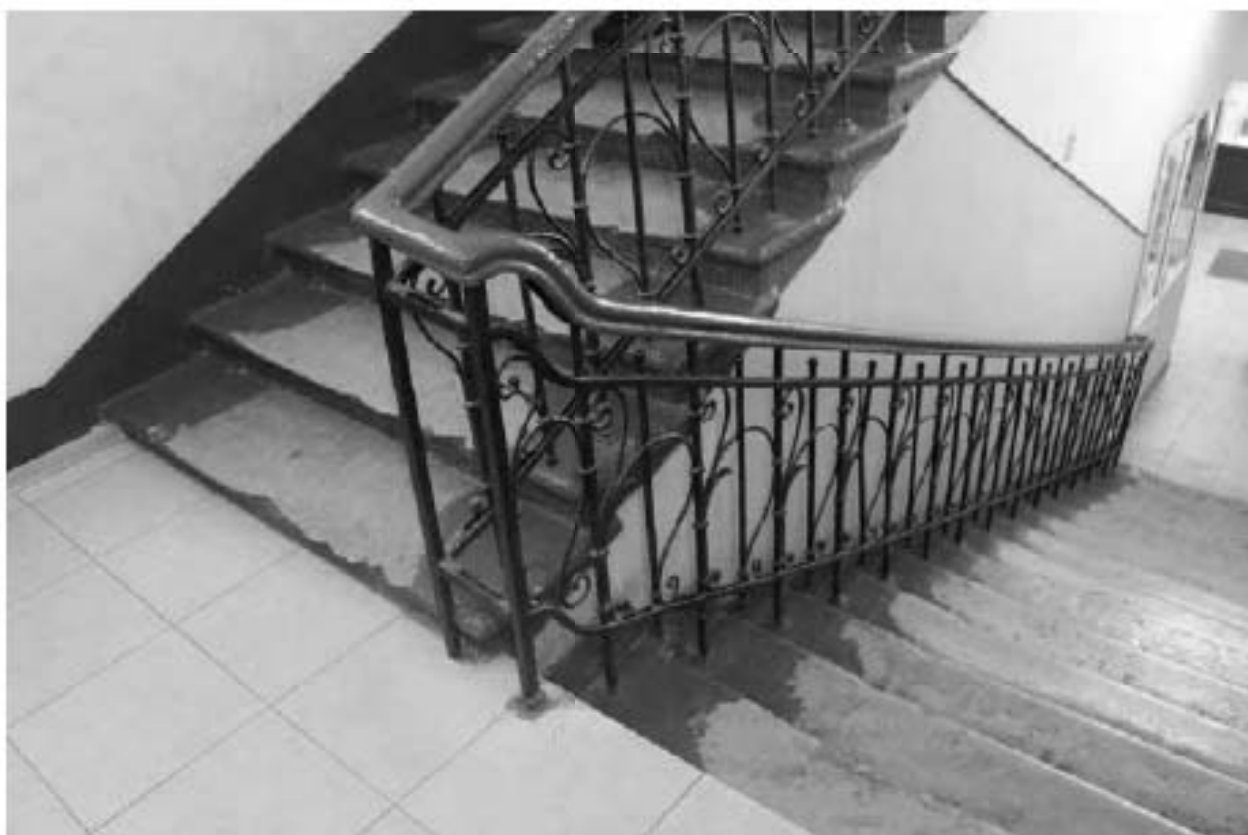
Фото 195. Выявленный объект культурного наследия «Пиротехническая школа». 12ЛК. Фото 03.05.2023 г.
