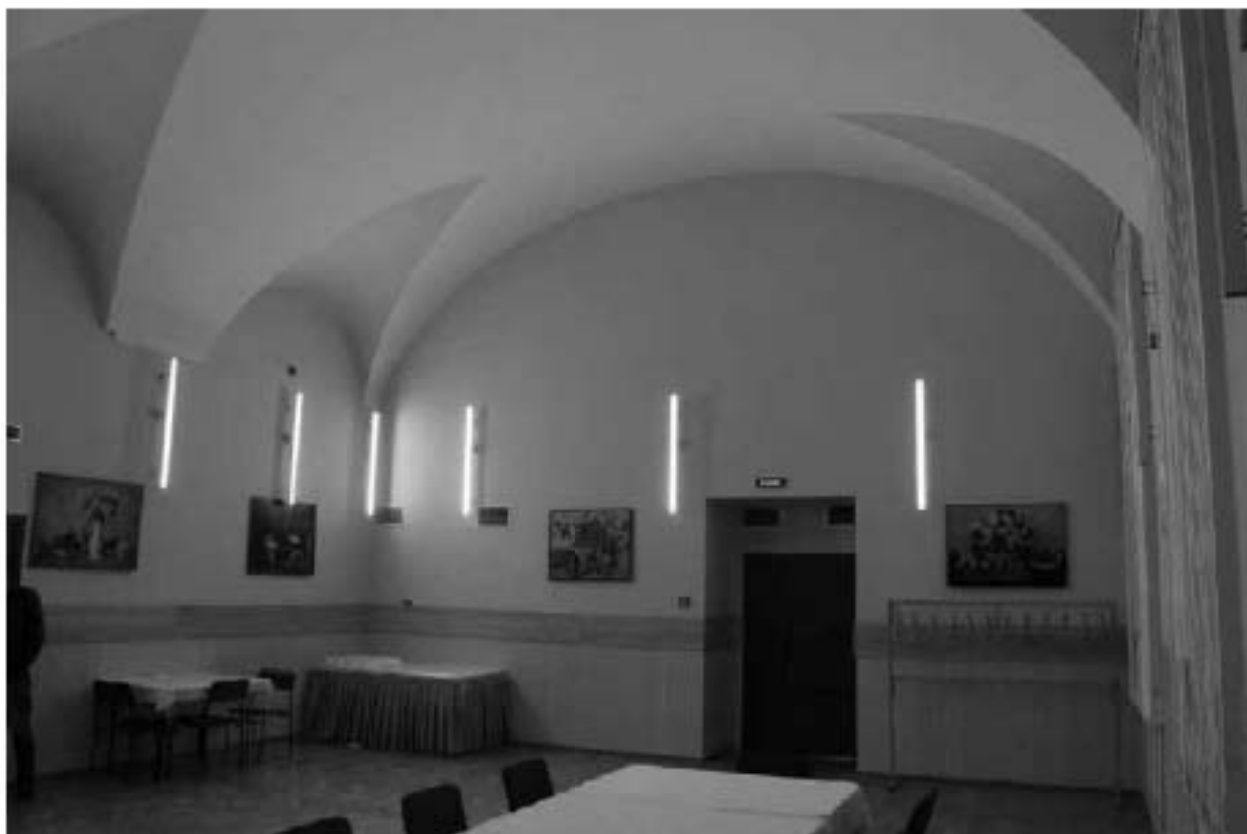
Фото 132. Выявленный объект культурного наследия «Лабораторный корпус». Внутренние помещения 1-го этажа. Фото 03.05.2023 г.
