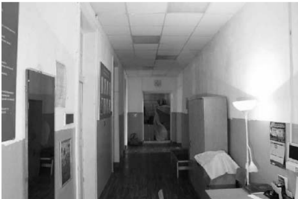
Фото 192. Выявленный объект культурного наследия «Орудийный сарай». Внутренние помещения 3-го этажа. Фото 03.05.2023 г.
