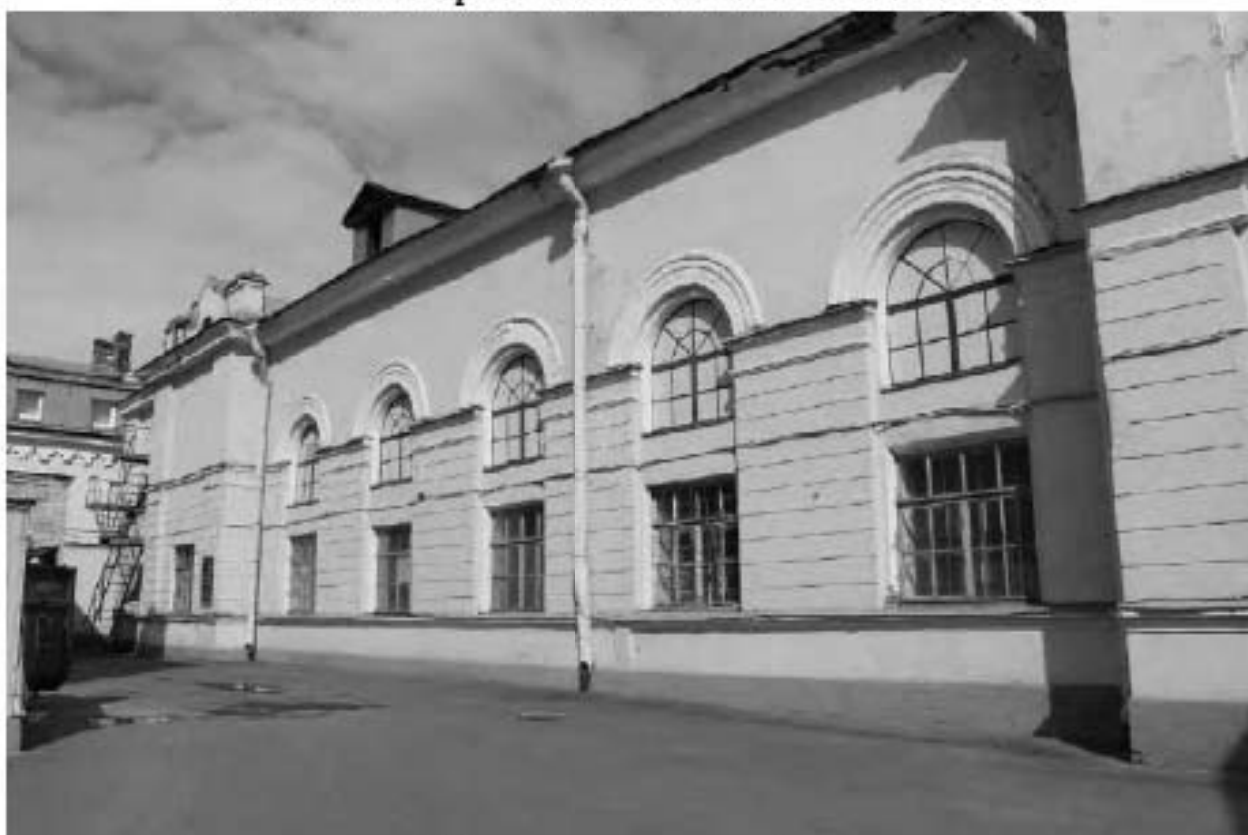
Фото 69. Вид на западный фасад выявленного объекта культурного наследия «Экипажный сарай с конюшнями». Фото 03.05.2023 г.
