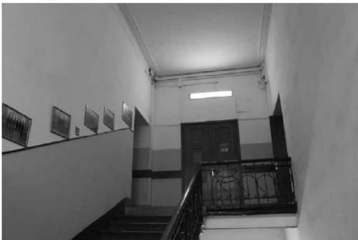
Фото 198. Выявленный объект культурного наследия «Пиротехническая школа». 12ЛК. Фото 03.05.2023 г.
