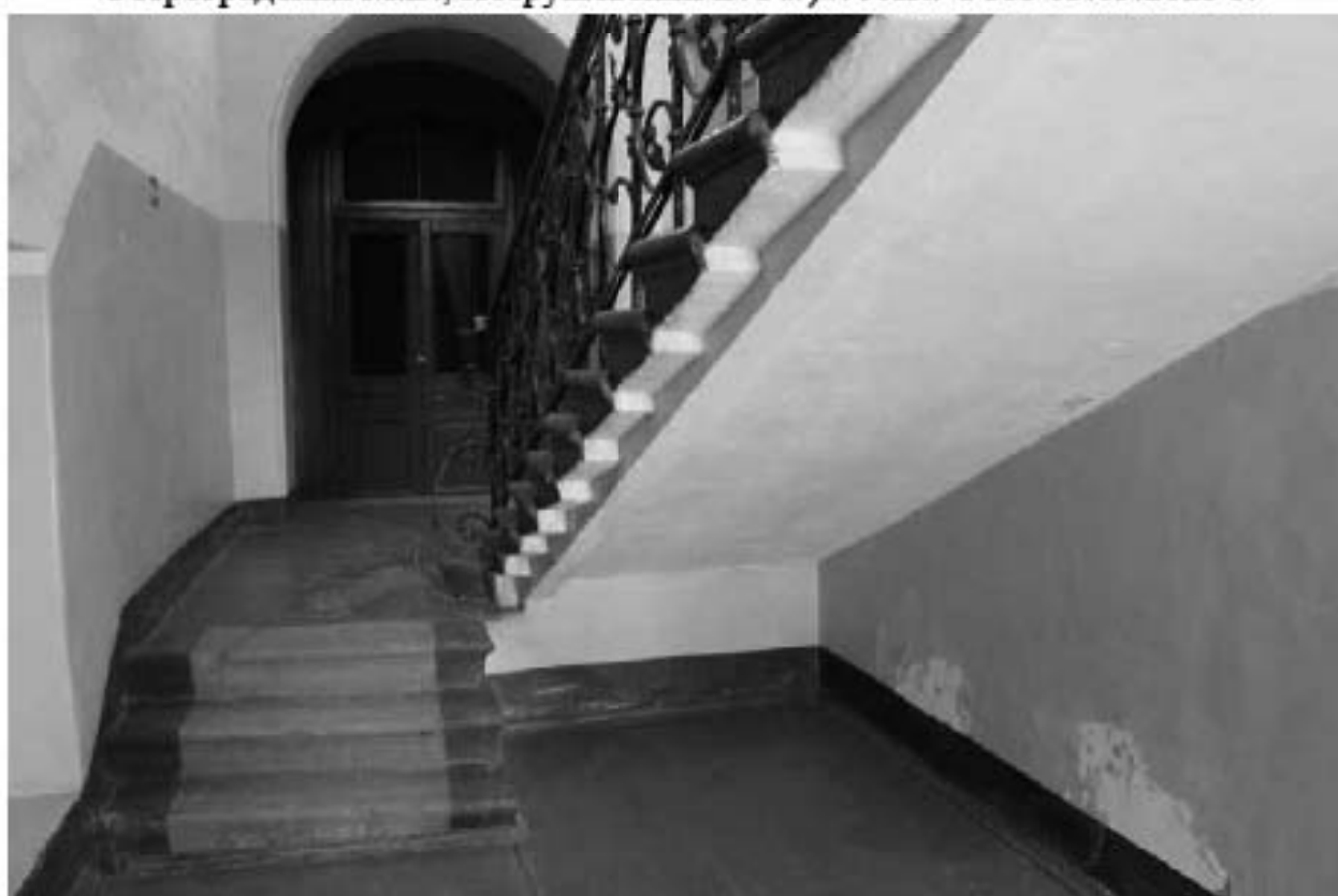
Фото 173. Выявленный объект культурного наследия «Корпус квартир офицеров (угловой)» (объект культурного наследия регионального значения «Академия Михайловская артиллерийская, где преподавали ученые Ленц Э.Х., Остроградский М.В., Петрушевский В.Ф.»). 10ЛК. Фото 03.05.2023 г.
