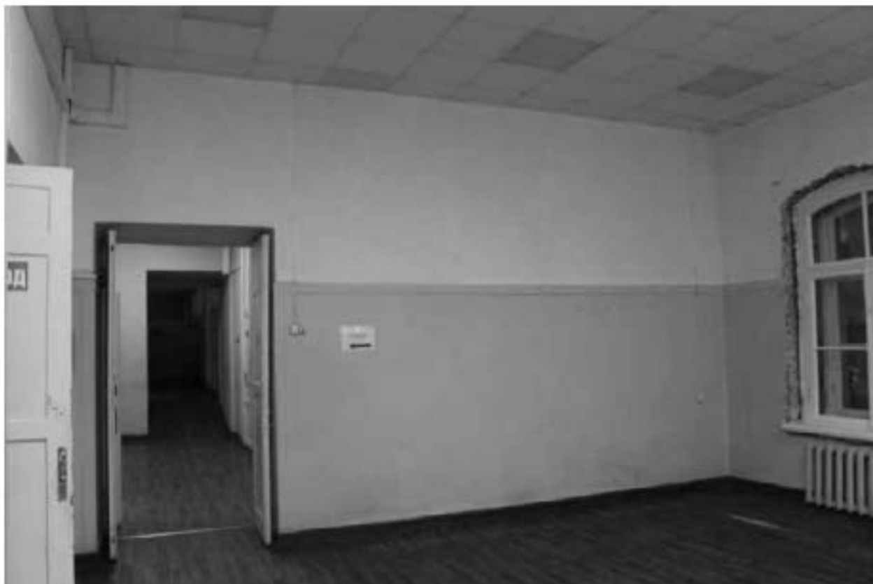
Фото 188. Выявленный объект культурного наследия «Орудийный сарай». Внутренние помещения 2-го этажа. Фото 03.05.2023 г.
