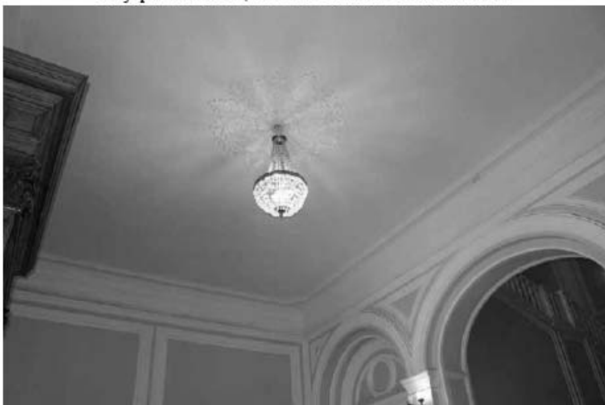
Фото 123. Выявленный объект культурного наследия «Лабораторный корпус». Внутренние помещения 1-го этажа. Фото 03.05.2023 г.
