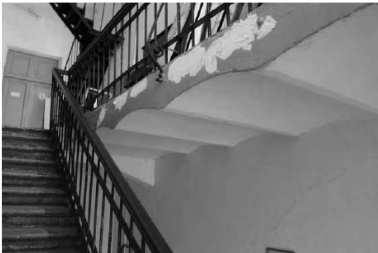
Фото 213. Выявленный объект культурного наследия «Лабораторный корпус». Лестница 99-Н. Фото 03.05.2023 г.
