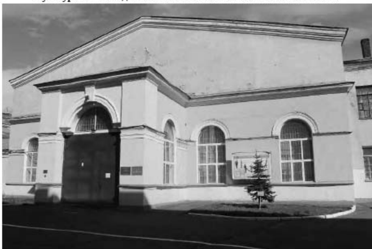
Фото 40. Вид на западный фасад центрального объема выявленного объекта культурного наследия «Манеж с конюшнями». Фото 03.05.2023 г.
