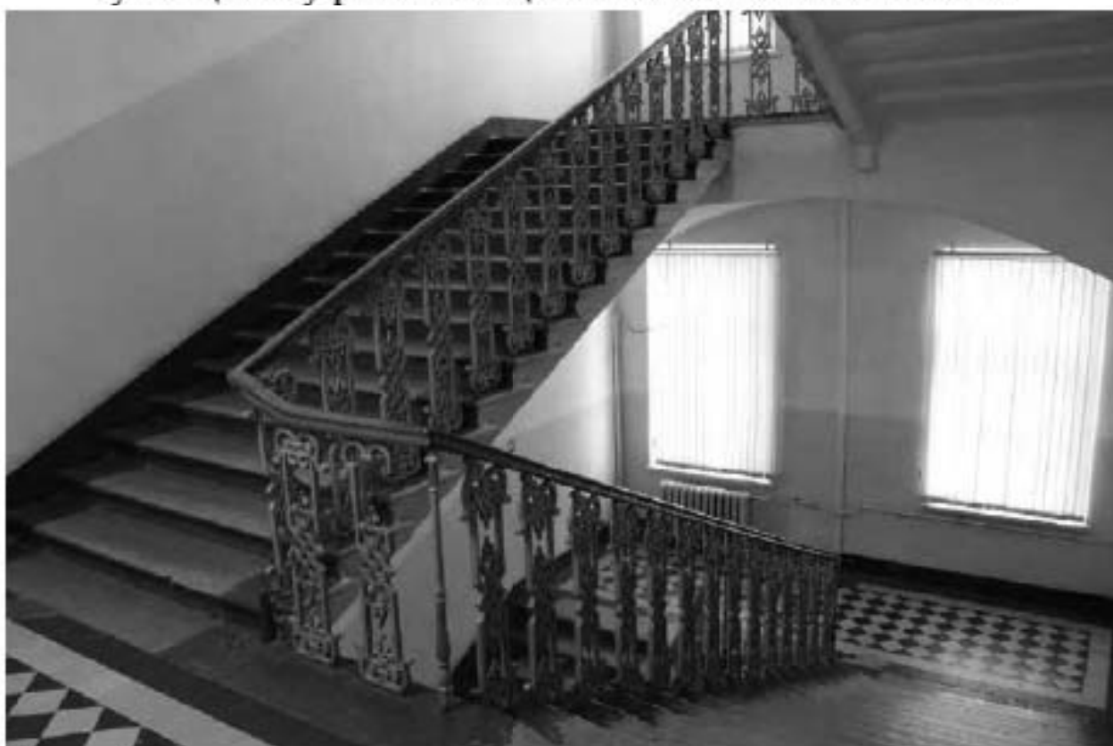
Фото 86. Выявленный объект культурного наследия «Главный корпус с 1-м солдатским корпусом, офицерским флигелем и Михайловское артиллерийское училище». ЗЛК. Фото 03.05.2023 г.
