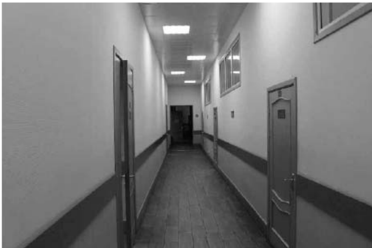
Фото 199. Выявленный объект культурного наследия «Пиротехническая школа». Внутренние помещения 3-го этажа. Фото 03.05.2023 г.
