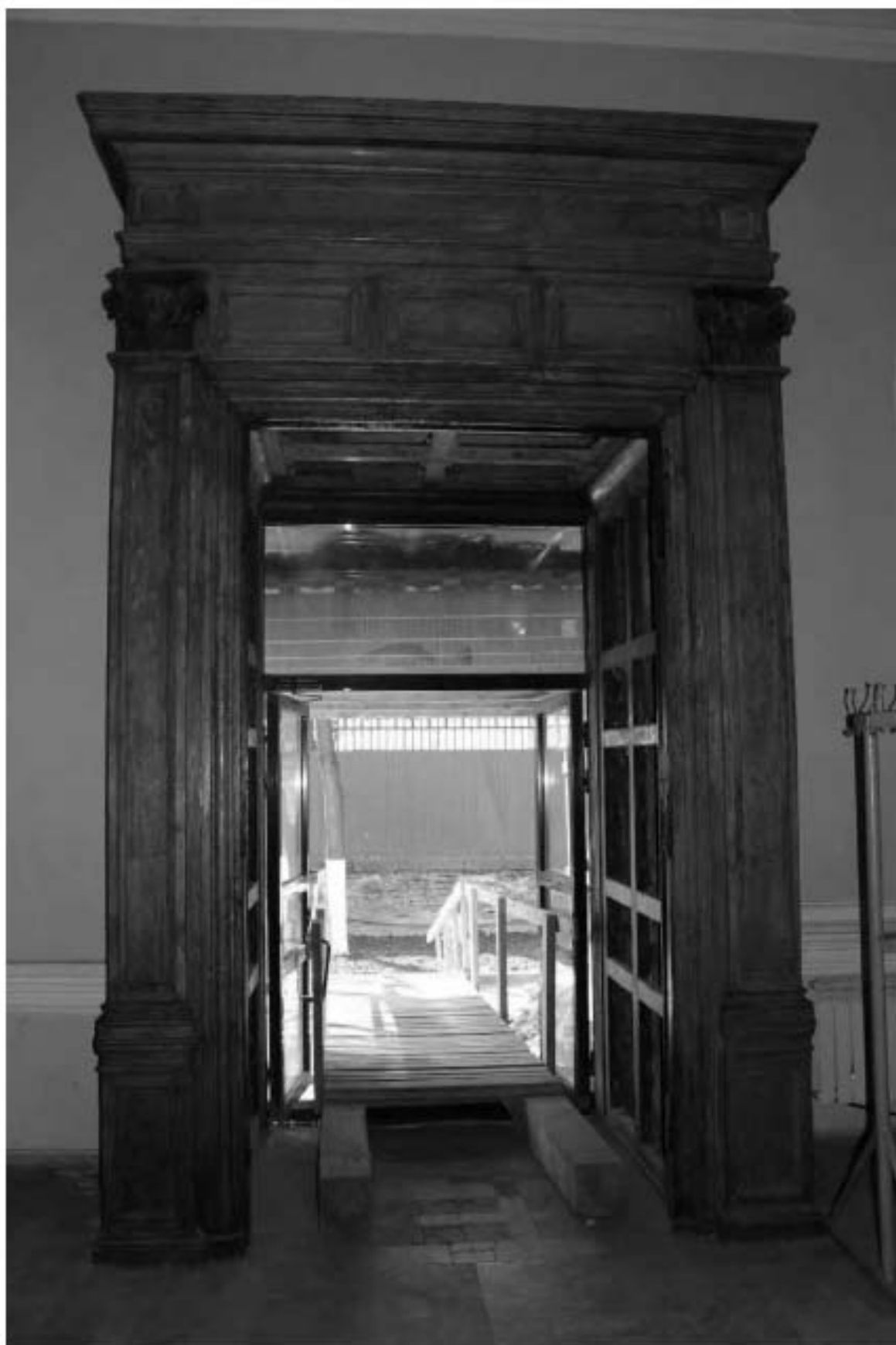
Фото 121. Выявленный объект культурного наследия «Лабораторный корпус». Внутренние помещения 1-го этажа. Фото 03.05.2023 г.
