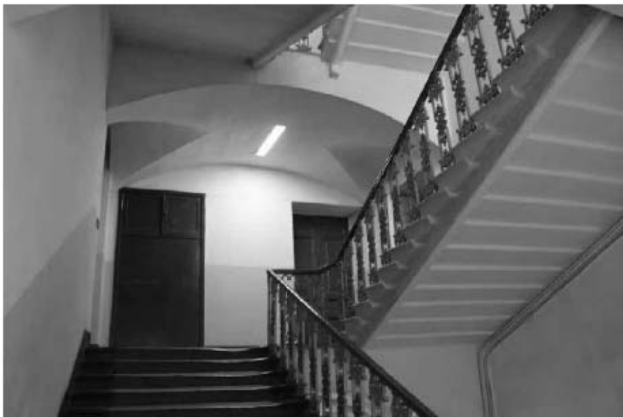
Фото 87. Выявленный объект культурного наследия «Главный корпус с 1-м солдатским корпусом, офицерским флигелем и Михайловское артиллерийское училище». ЗЛК. Фото 03.05.2023 г.
