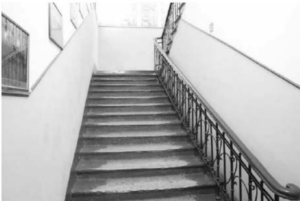
Фото 194. Выявленный объект культурного наследия «Пиротехническая школа». 12ЛК. Фото 03.05.2023 г.
