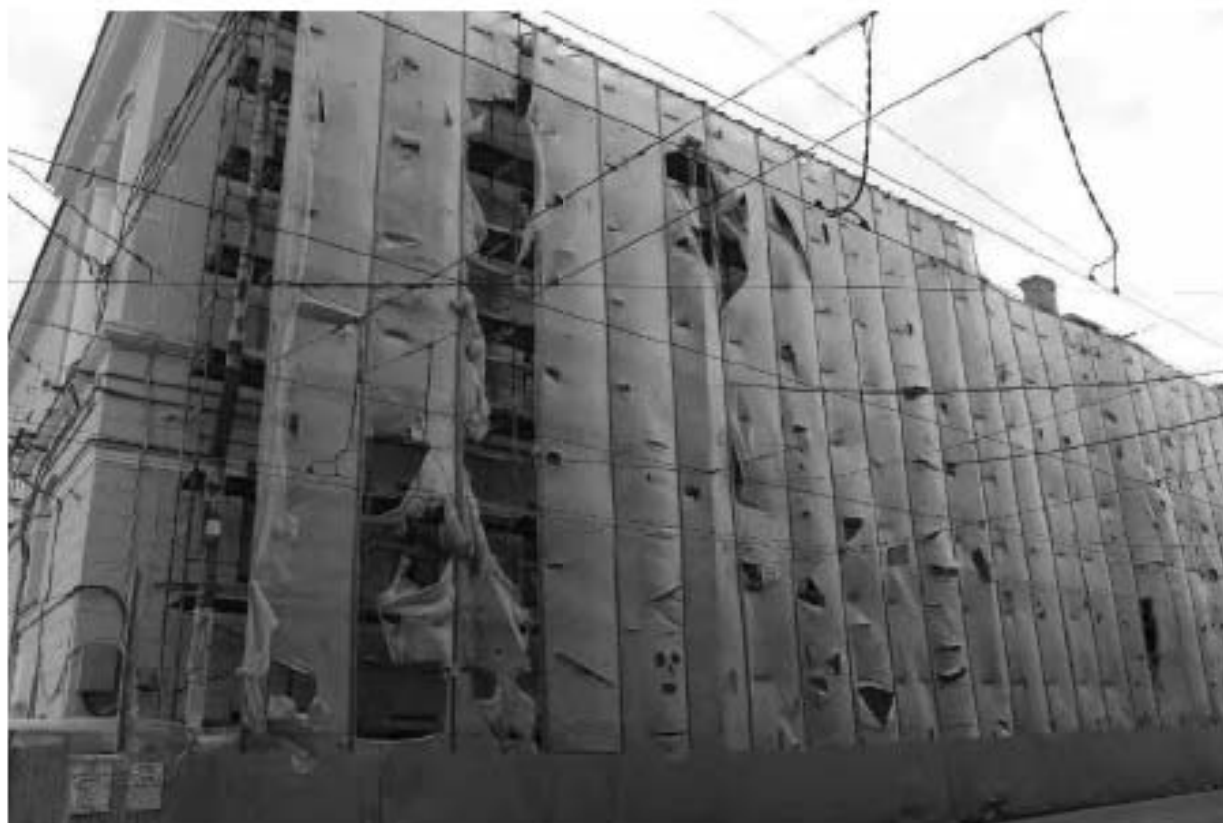
Фото 7. Вид на лицевой фасад по ул. Комсомола выявленного объекта культурного наследия «Главный корпус с 1-м солдатским корпусом, офицерским флигелем и Михайловское артиллерийское училище». Фото 17.04.2023 г.
