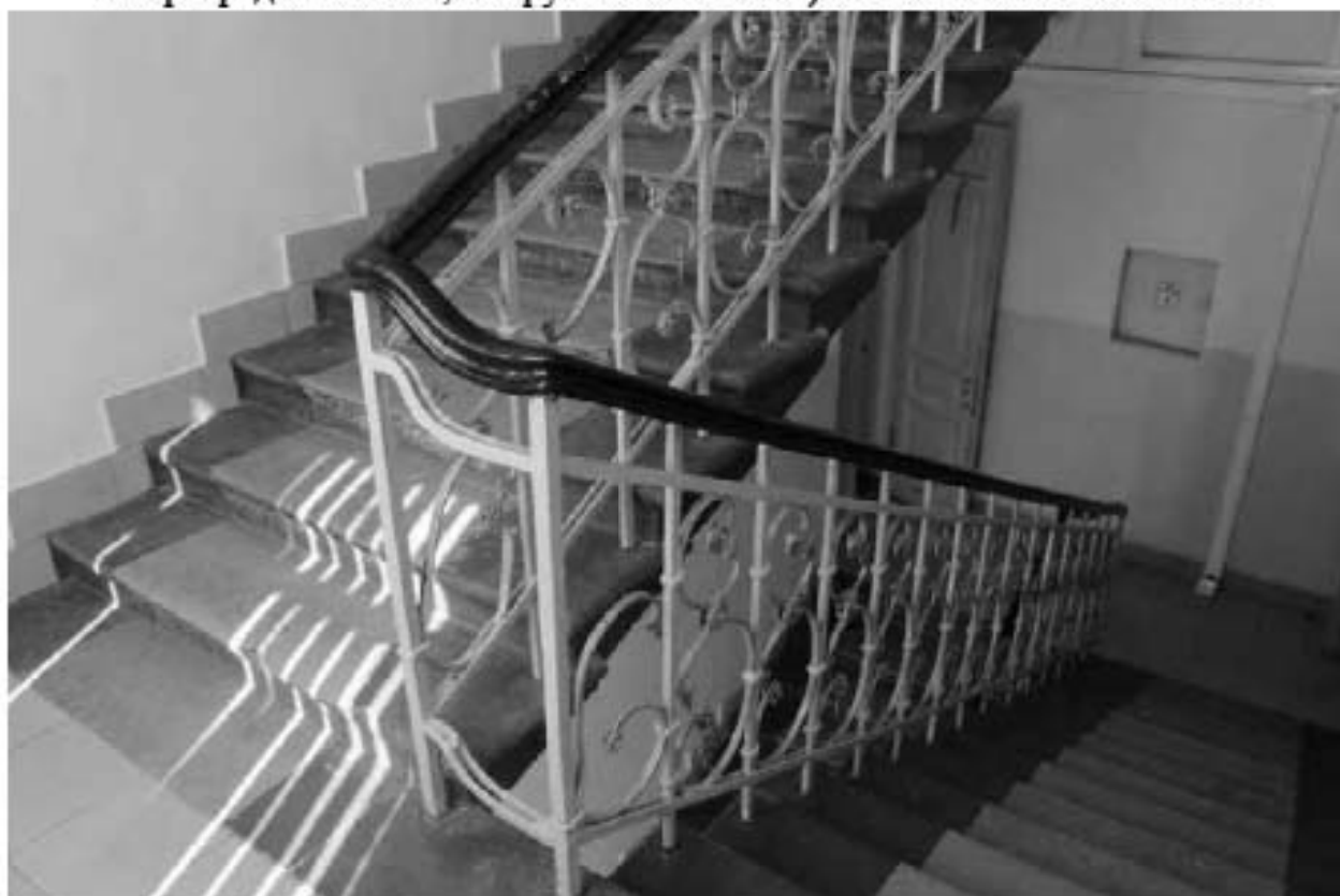
Фото 169. Выявленный объект культурного наследия «Корпус квартир офицеров (угловой)» (объект культурного наследия регионального значения «Академия Михайловская артиллерийская, где преподавали ученые Ленц Э.Х., Остроградский М.В., Петрушевский В.Ф.»). 9ЛК. Фото 03.05.2023 г.
