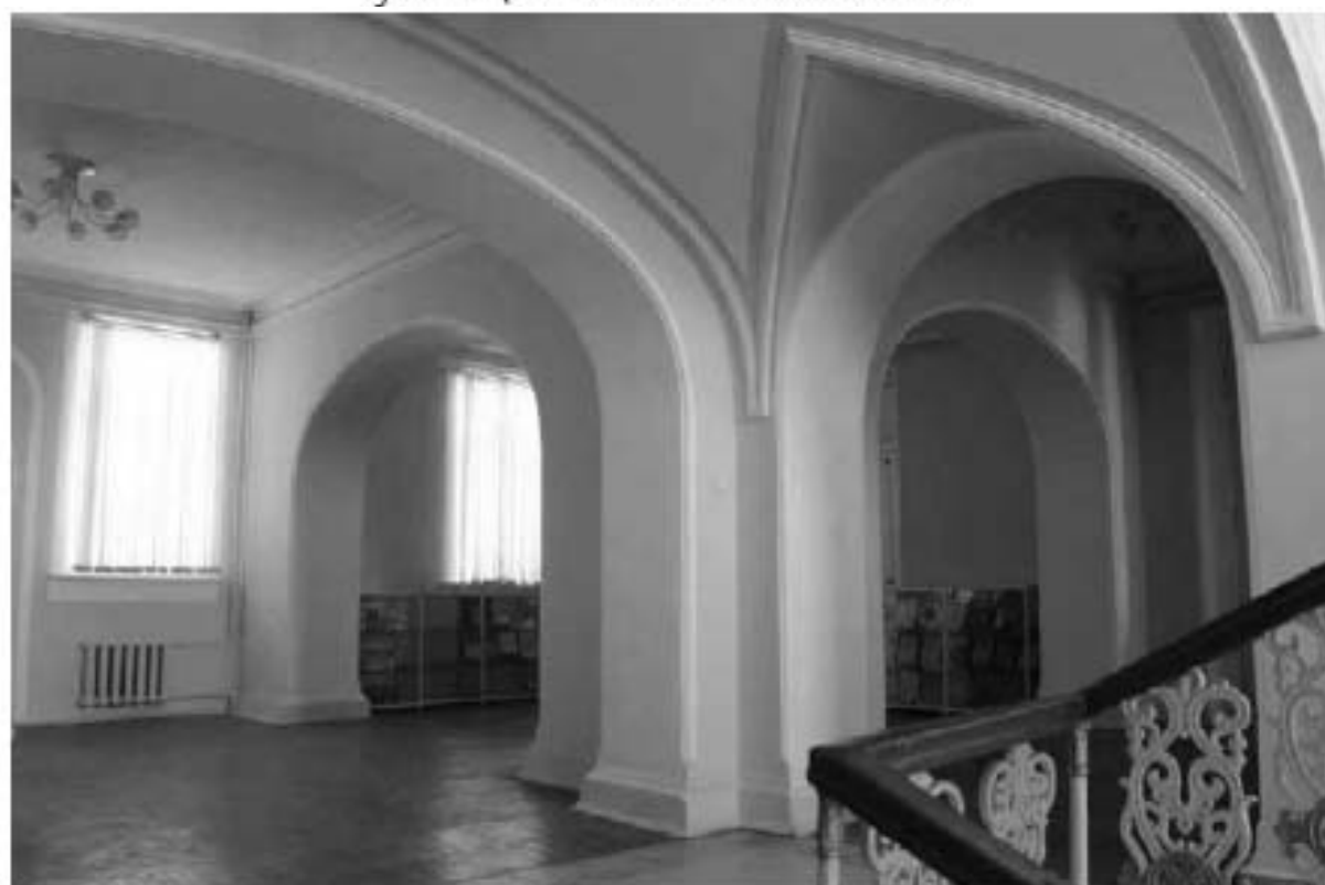
Фото 82. Выявленный объект культурного наследия «Главный корпус с 1-м солдатским корпусом, офицерским флигелем и Михайловское артиллерийское училище». 2ЛК, выход к внутренним помещениям 3-го этажа. Фото 03.05.2023 г.
