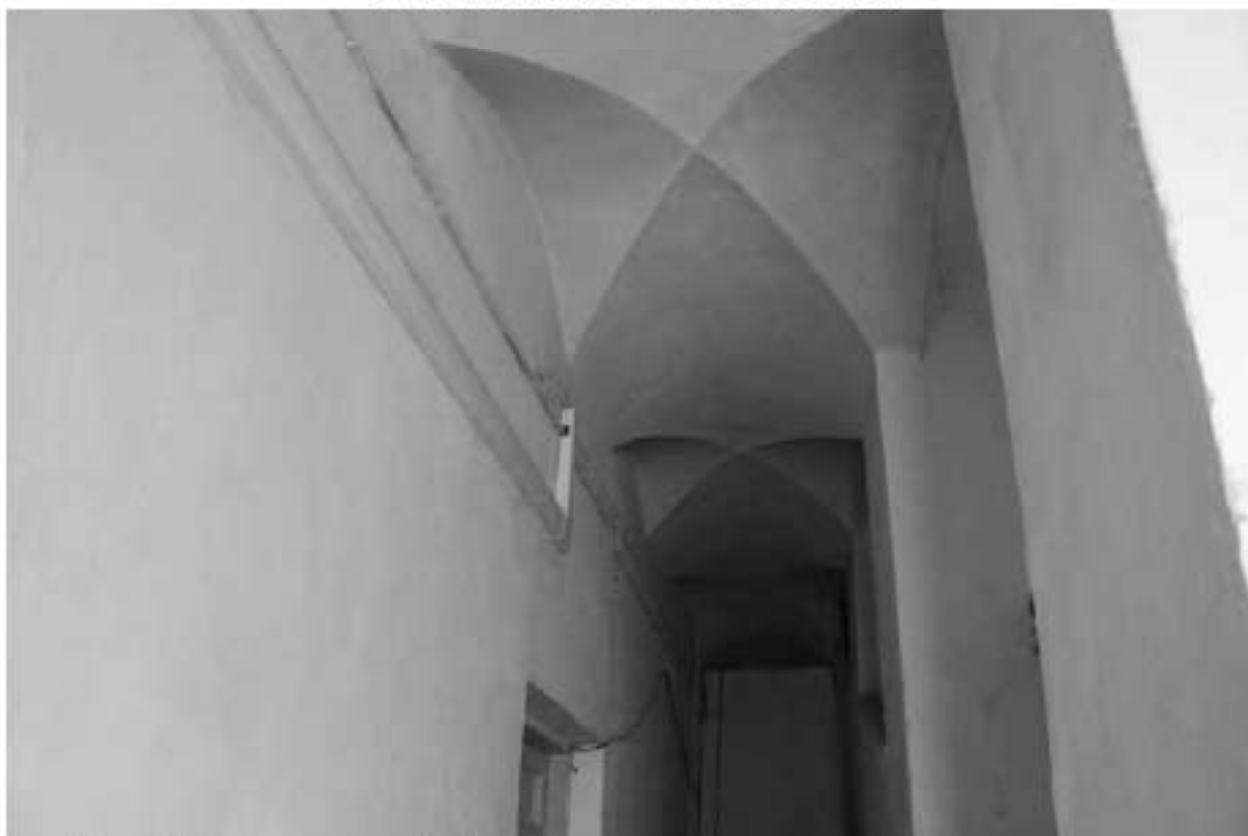
Фото 203. Выявленный объект культурного наследия «Пиротехническая школа». 11ЛК. Фото 03.05.2023 г.
