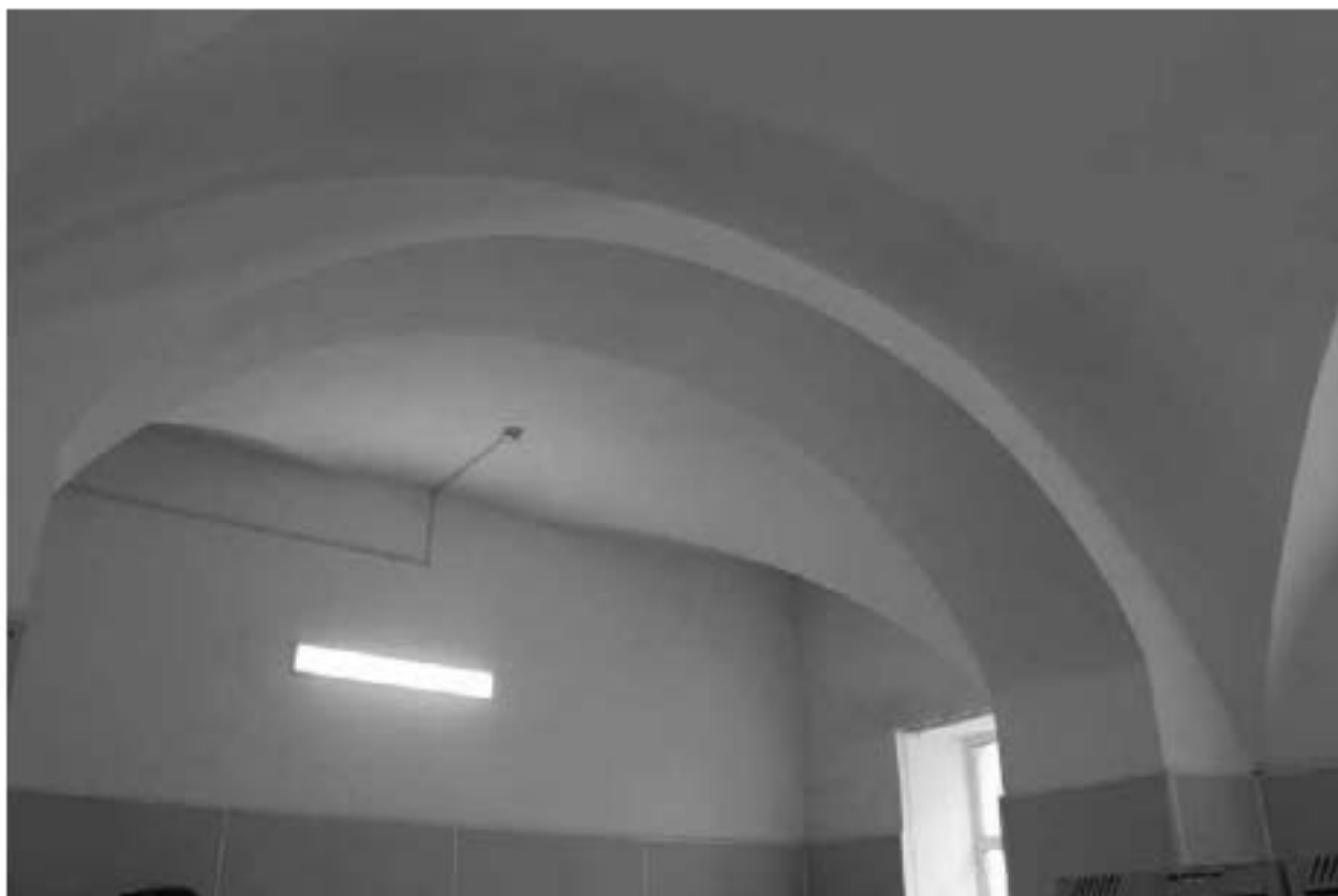
Фото 208. Выявленный объект культурного наследия «Пиротехническая школа». Внутренние помещения 1-го этажа. Фото 03.05.2023 г.
