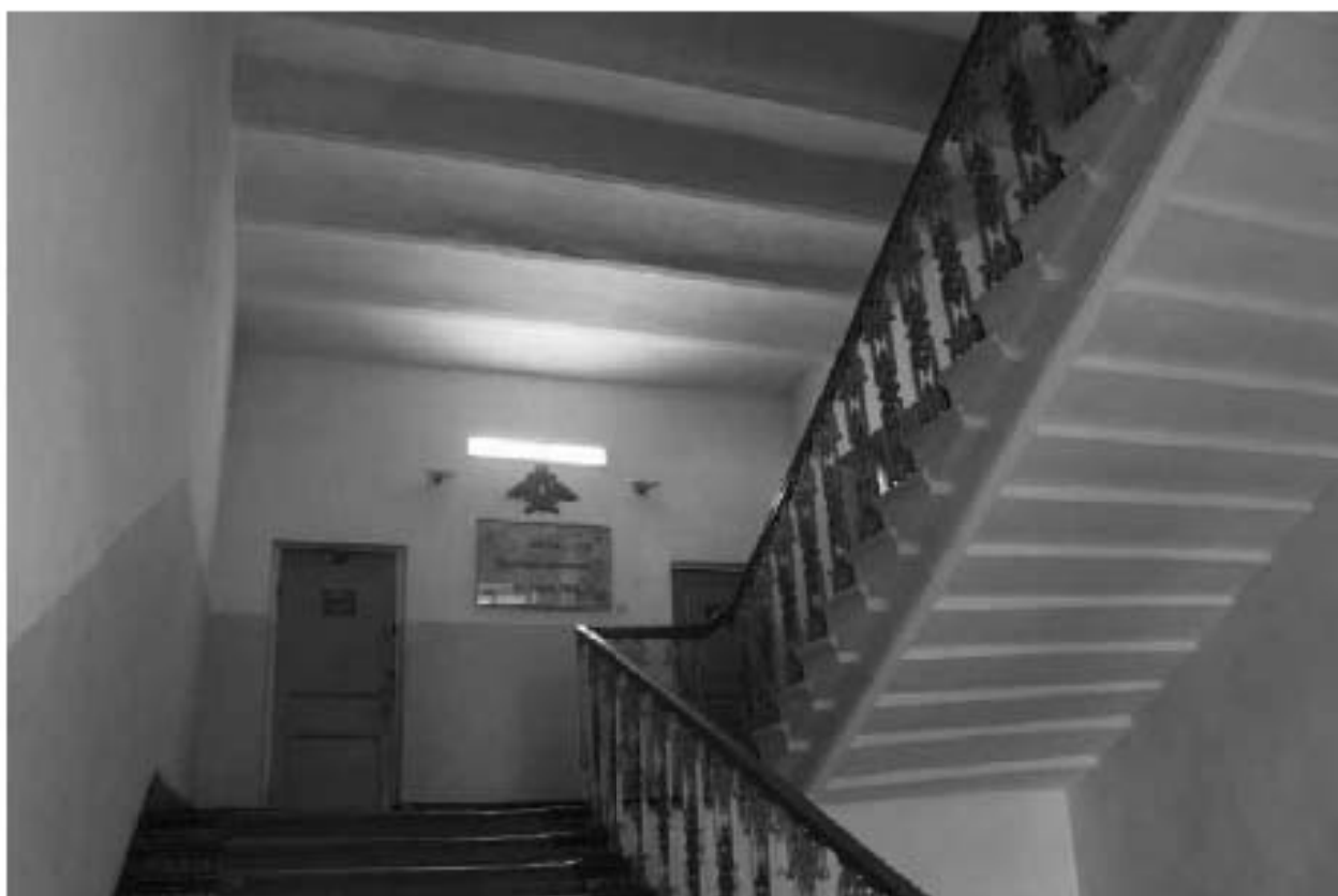
Фото 89. Выявленный объект культурного наследия «Главный корпус с 1-м солдатским корпусом, офицерским флигелем и Михайловское артиллерийское училище». ЗЛК. Фото 03.05.2023 г.
