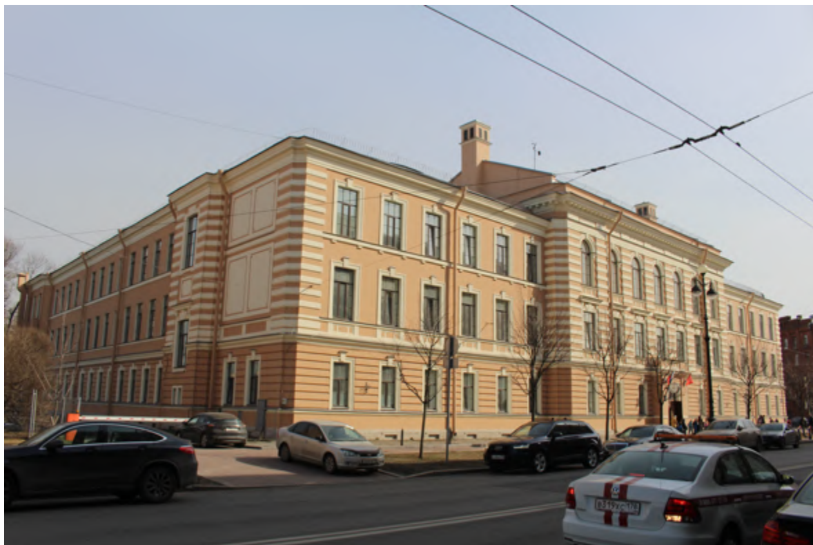
1. Вид с северо-запада
