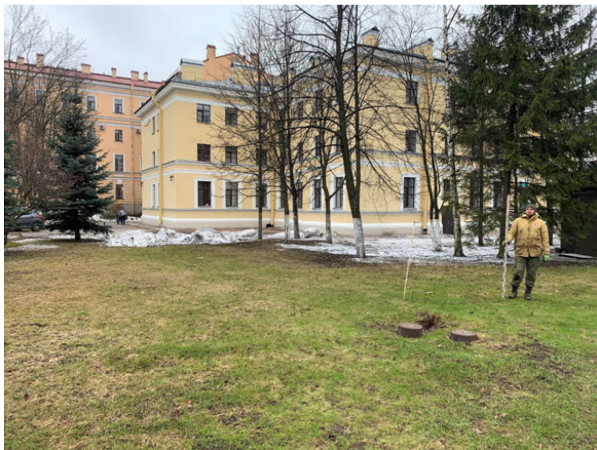
Рис. 25. СПб, Духовная семинария-2023. Дом 15-17. Точка фотофиксации 6, вид на юго-запад.
