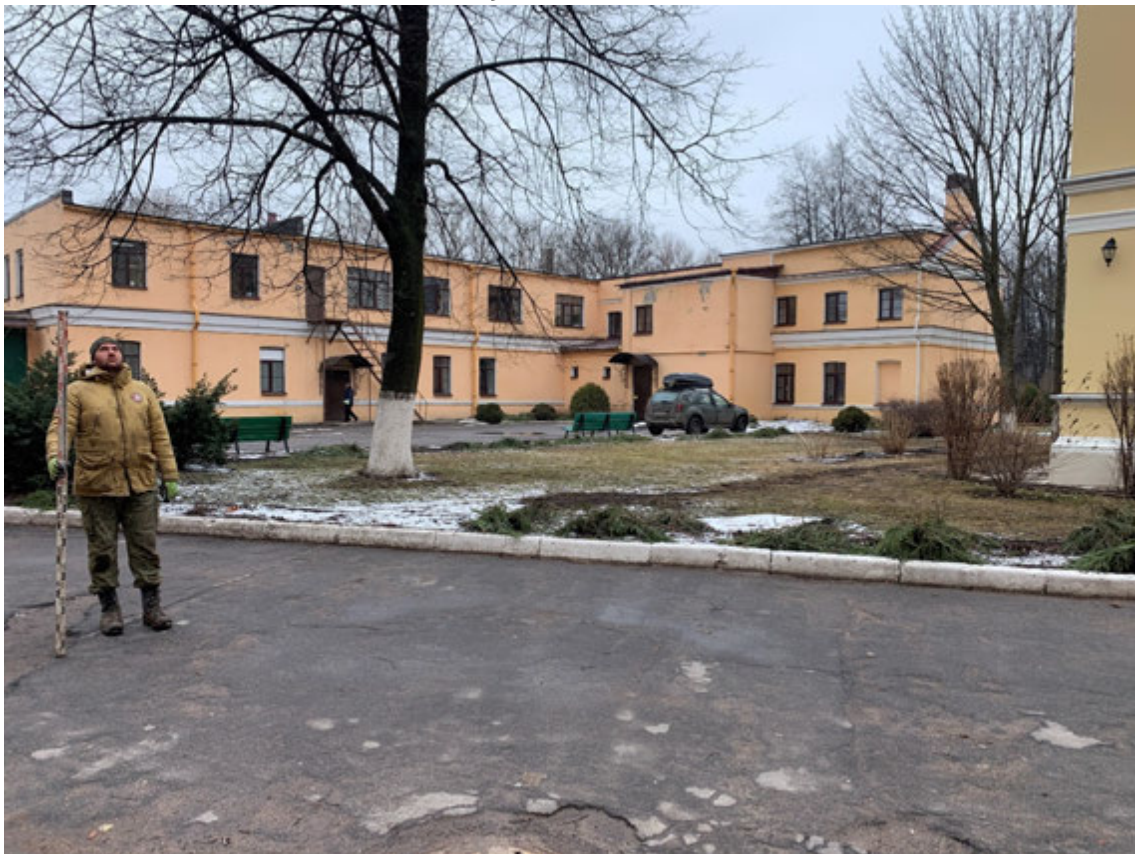
Рис. 20. СПб, Духовная семинария-2023. Дом 15-17. Точка фотофиксации 4, вид на северо-восток.
