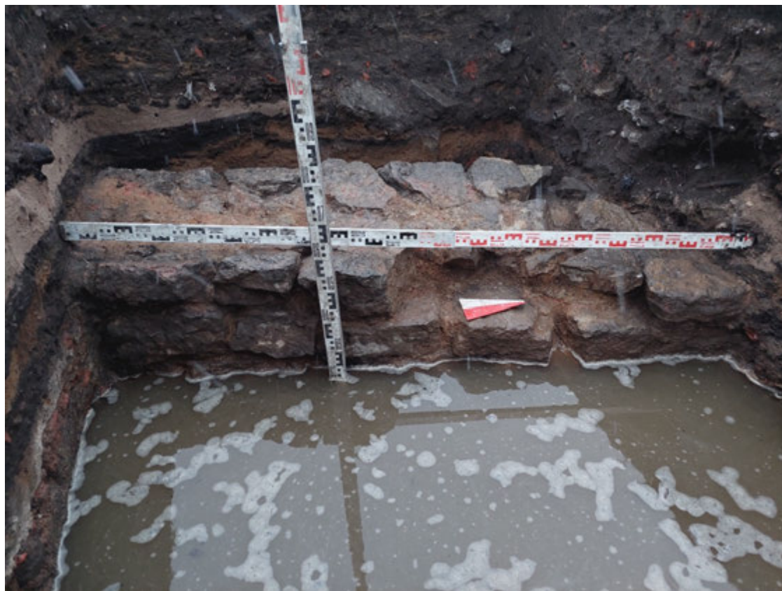
Рис. 66. СПб, Духовная семинария-2023. Дом 15-17. Шурф 2-3, фундаментная кладка, восточная стенка, вид на запад.
