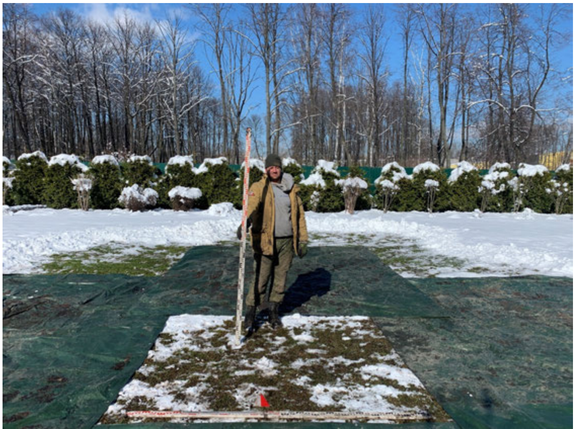
Рис. 58. СПб, Духовная семинария-2023. Дом 15-17. Местоположение шурфа 2-3 до начала работ, вид на север.
