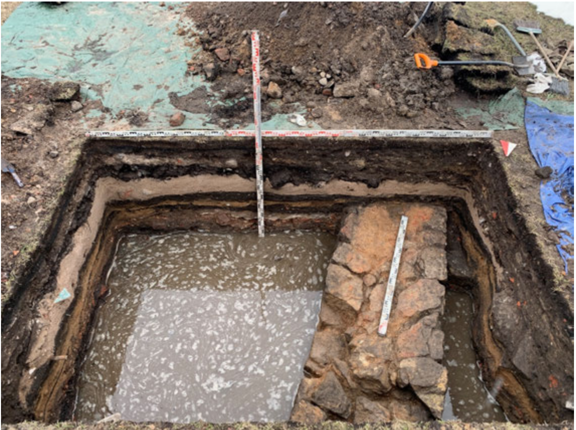
Рис. 61. СПб, Духовная семинария-2023. Дом 15-17. Шурф 2-3, фиксация по уровню окончания работ, вид на юг.
