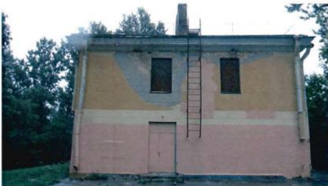
4. Западный фасад объекта культурного наследия.
