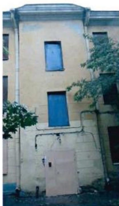
2. Фрагмент южного фасада объекта культурного наследия
