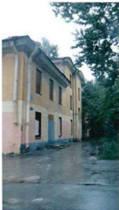
1. Фрагмент южного фасада объекта культурного наследия
