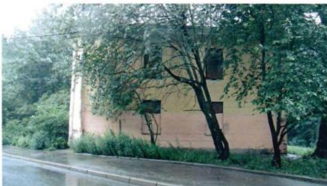
5. Восточный фасад объекта культурного наследия.
