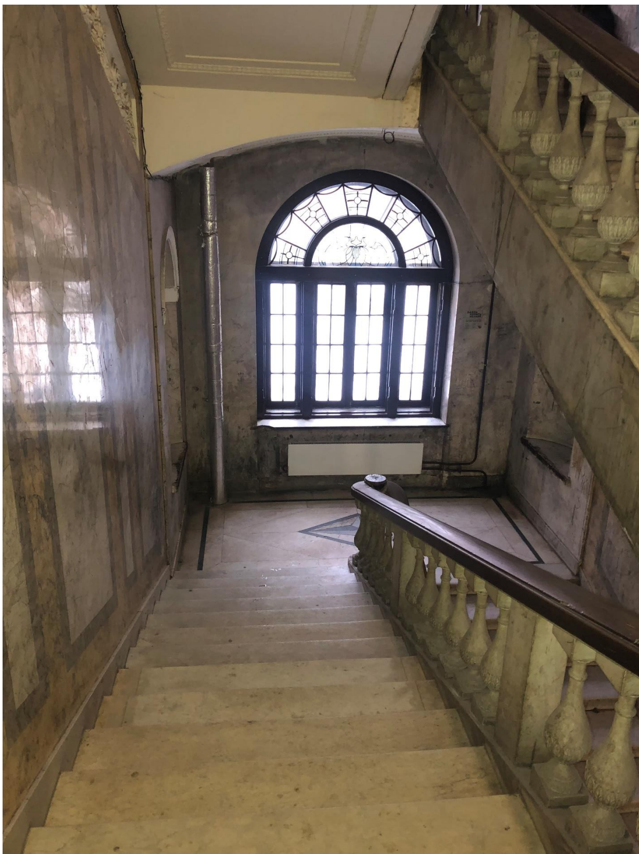
Фото 10. Вид на парадную лестницу с 3-го этажа.
