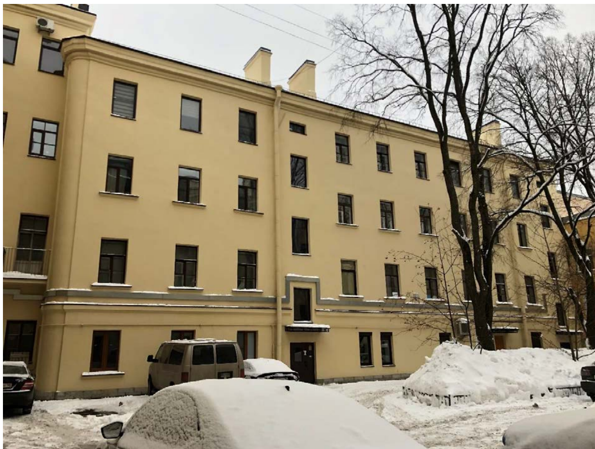
Фото 8. Вид на дворовый фасад восточного корпуса.
