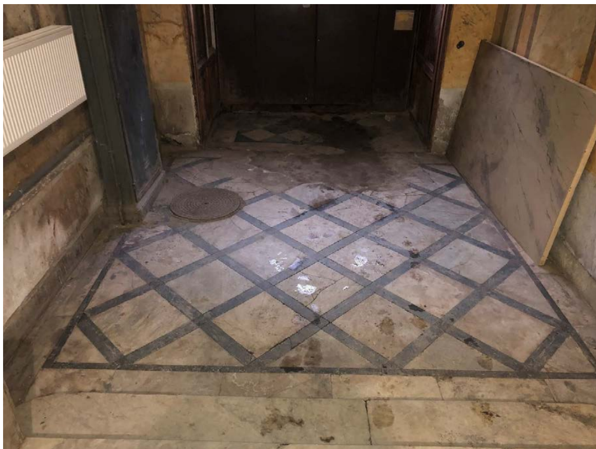
Фото 2. Пол вестибюля парадной лестницы. Вид с юга на север.
