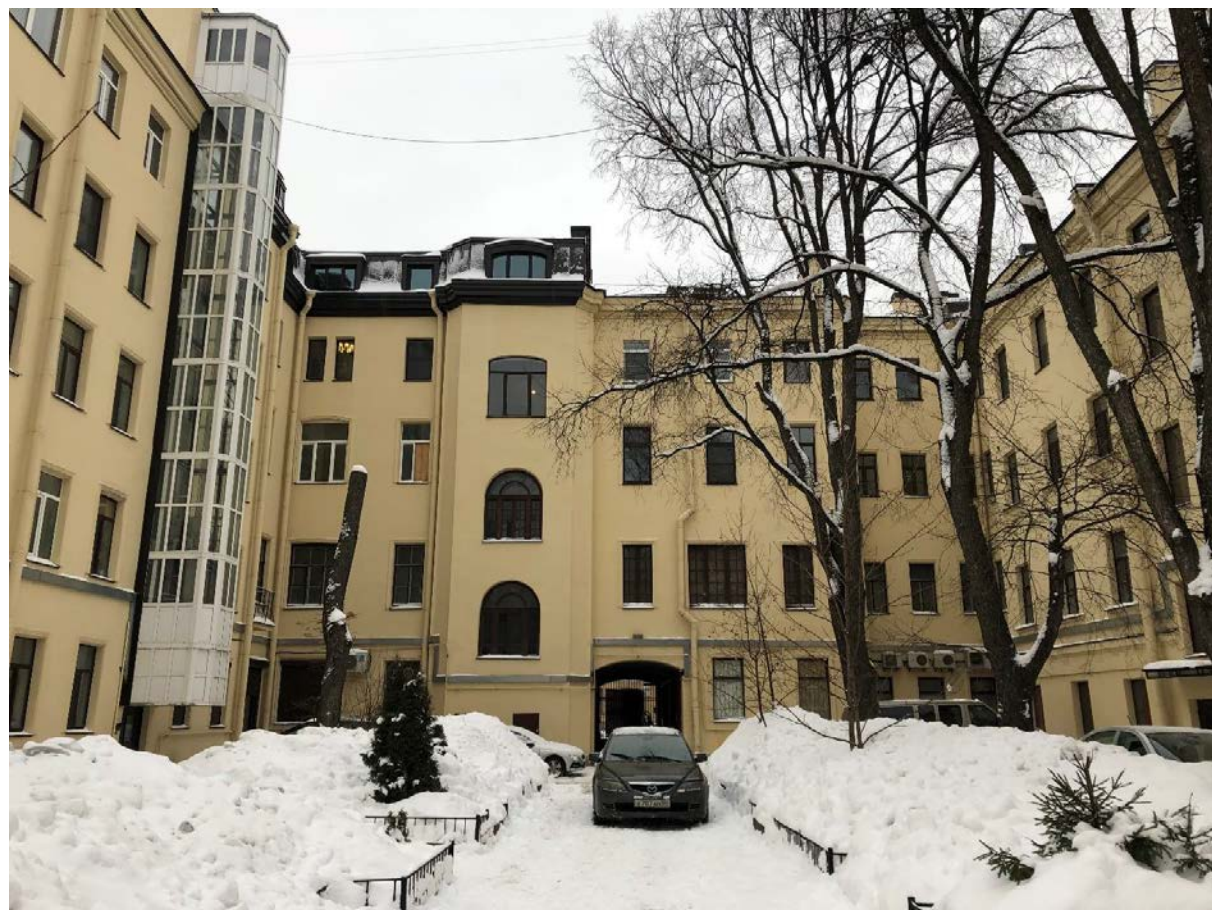
Фото 9. Вид на дворовый фасад лицевого корпуса.
