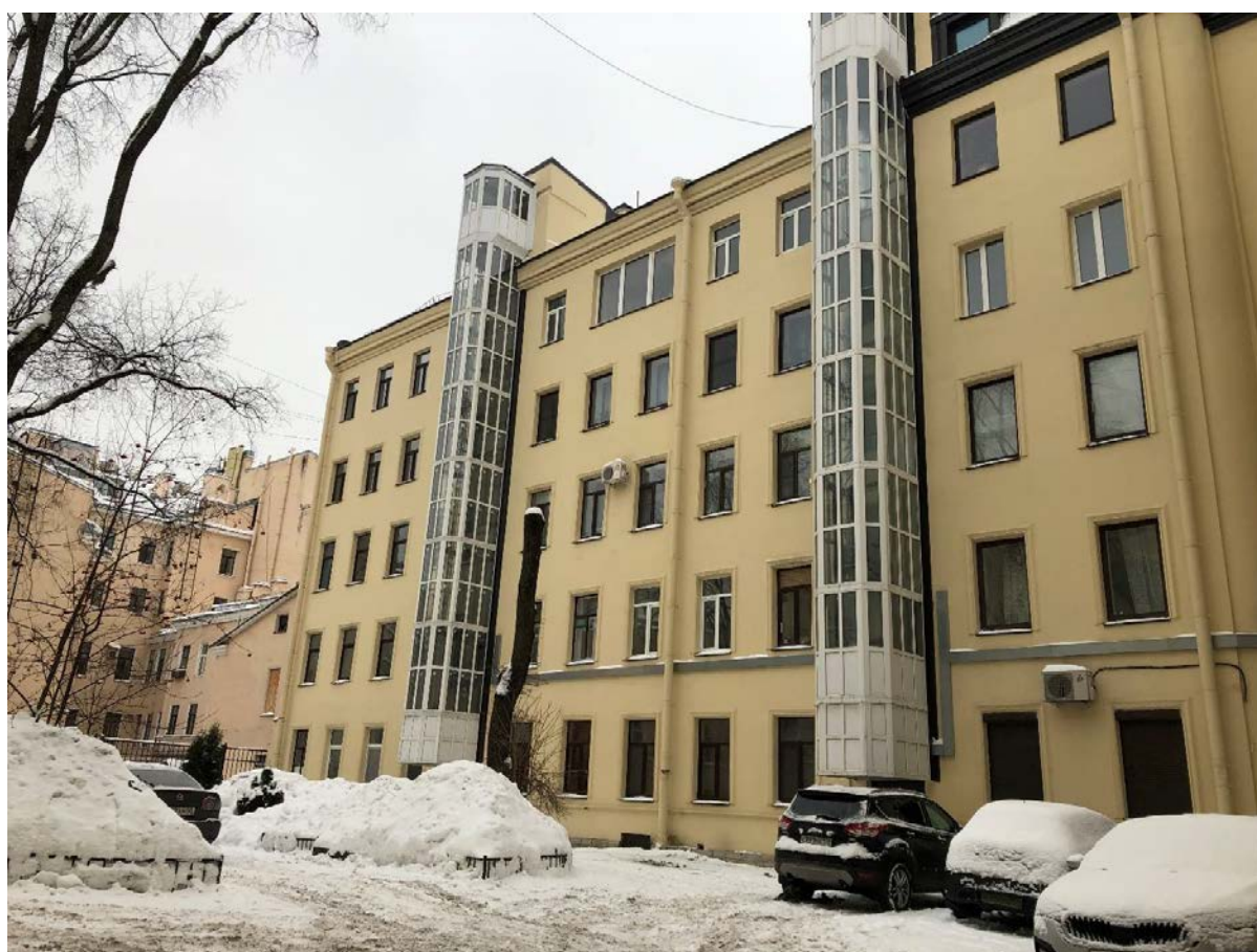
Фото 7. Вид на дворовый фасад западного корпуса.
