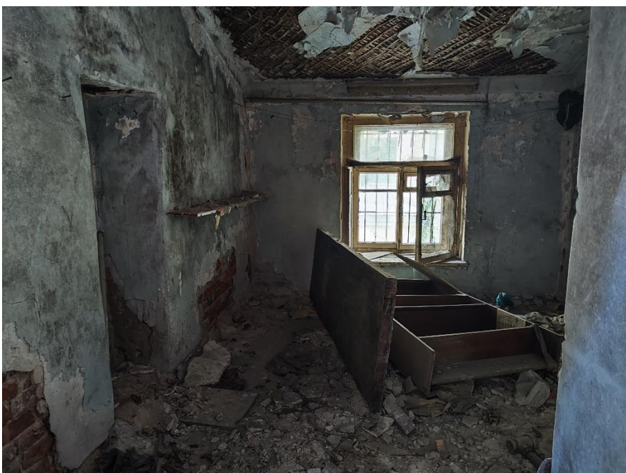
18. «Дом Утеман Ф.Ф.», наб. Лейтенанта Шмидта д. 31, лит. 3. Помещение второго этажа. Общий вид. Фото 08.06.2023г.
