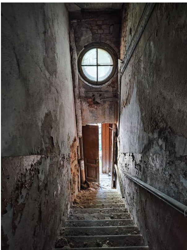
27. «Дом Утеман Ф.Ф.», наб. Лейтенанта Шмидта д. 31, лит. 3. Лестница на второй этаж. Общий вид. Фото 08.06.2023г.
