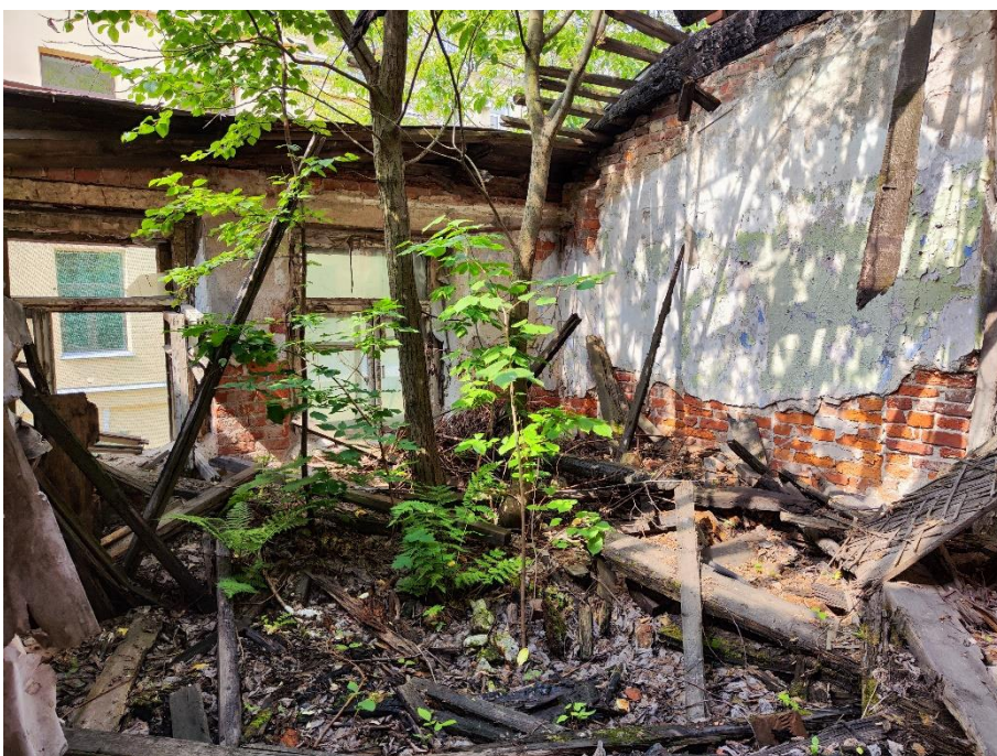
20. «Дом Утеман Ф.Ф.», наб. Лейтенанта Шмидта д. 31, лит. 3. Помещение второго этажа. Общий вид. Фото 08.06.2023г.
