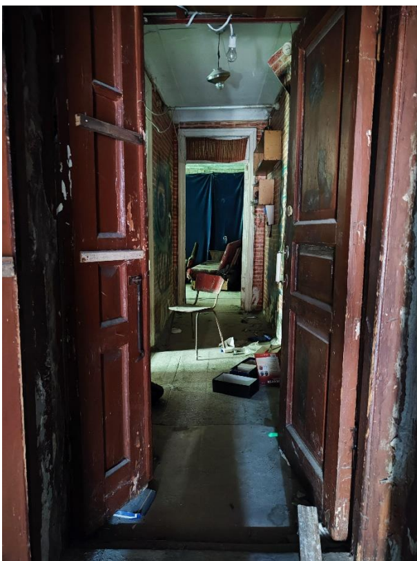
16. «Дом Утеман Ф.Ф.», наб. Лейтенанта Шмидта д. 31, лит. 3. Второй этаж. Коридор. Общий вид. Фото 08.06.2023г.
