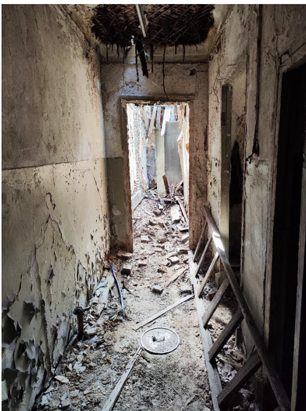
15. «Дом Утеман Ф.Ф.», наб. Лейтенанта Шмидта д. 31, лит. 3. Второй этаж. Коридор. Общий вид. Фото 08.06.2023г.
