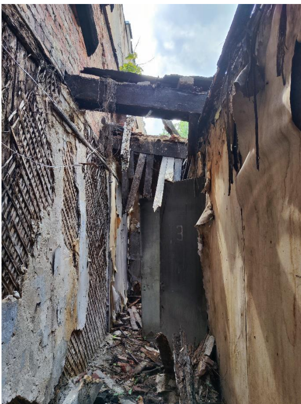
19. «Дом Утеман Ф.Ф.», наб. Лейтенанта Шмидта д. 31, лит. 3. Помещение второго этажа. Общий вид. Фото 08.06.2023г.
