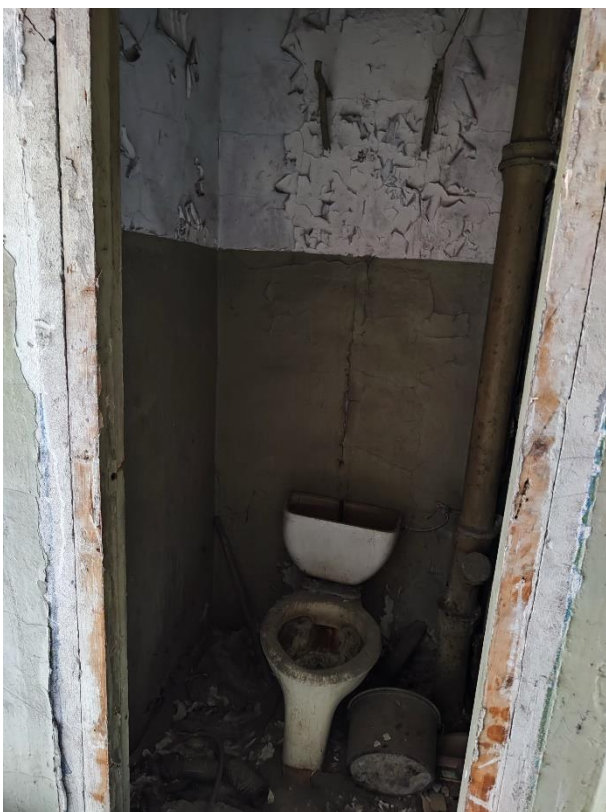
17. «Дом Утеман Ф.Ф.», наб. Лейтенанта Шмидта д. 31, лит. 3. Второй этаж. Санузел. Общий вид. Фото 08.06.2023г.
