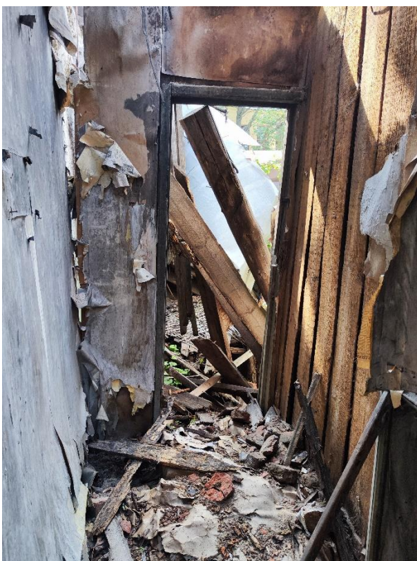
22. «Дом Утеман Ф.Ф.», наб. Лейтенанта Шмидта д. 31, лит. 3. Помещение второго этажа. Общий вид. Фото 08.06.2023г.
