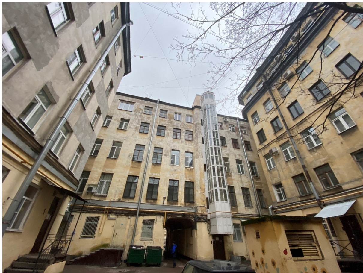
Фото 6. Юго-восточный дворовой фасад. Вид со стороны северного дворового пространства.
