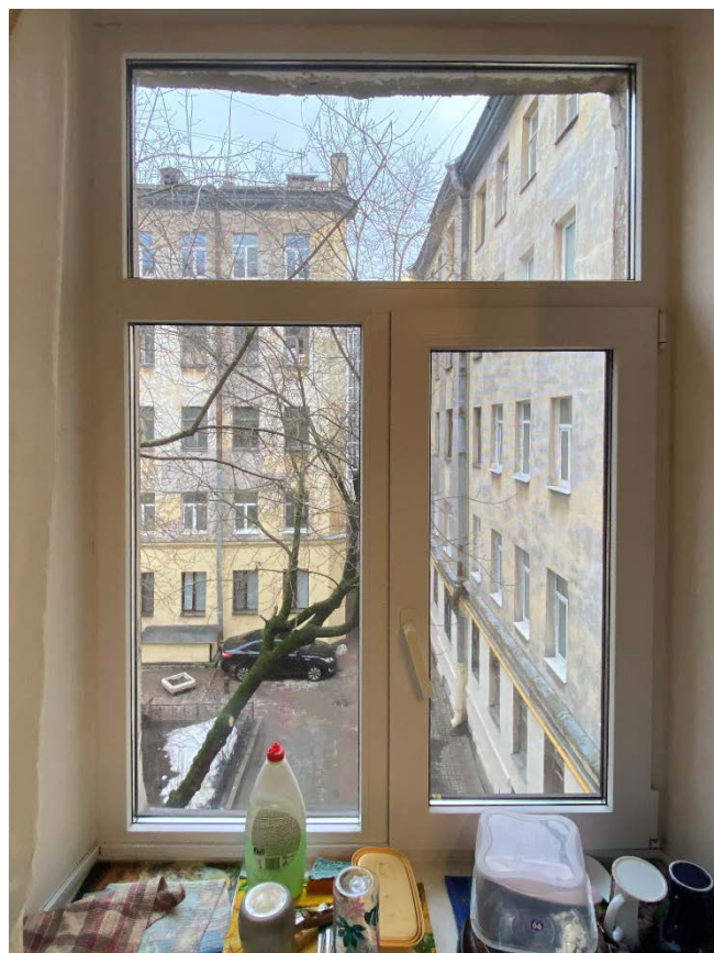
Фото 35. Оконное заполнение в помещении № 8. Вид с юга.
