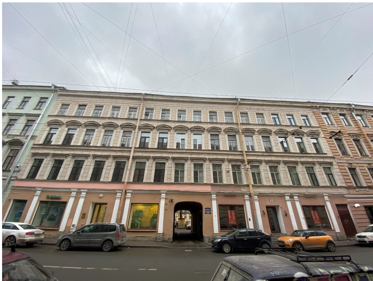
Фото 3. Северный фасад лицевого корпуса. Вид с северо-запада.
