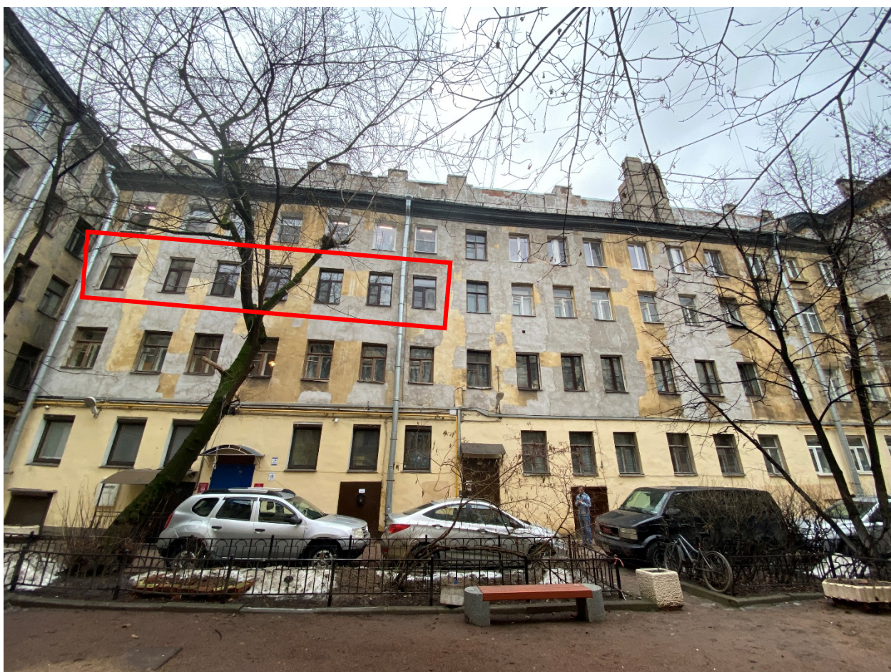
Фото 10. Северо-восточный фасад южного дворового флигеля. Вид с северо-востока.
