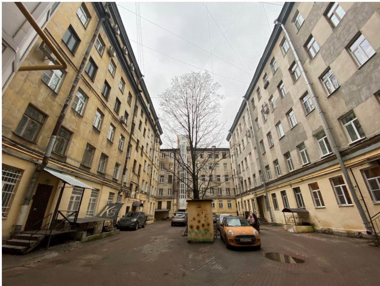
Фото 5. Общий вид северного дворового пространства и дворовых флигелей. Вид с северо-запада.
