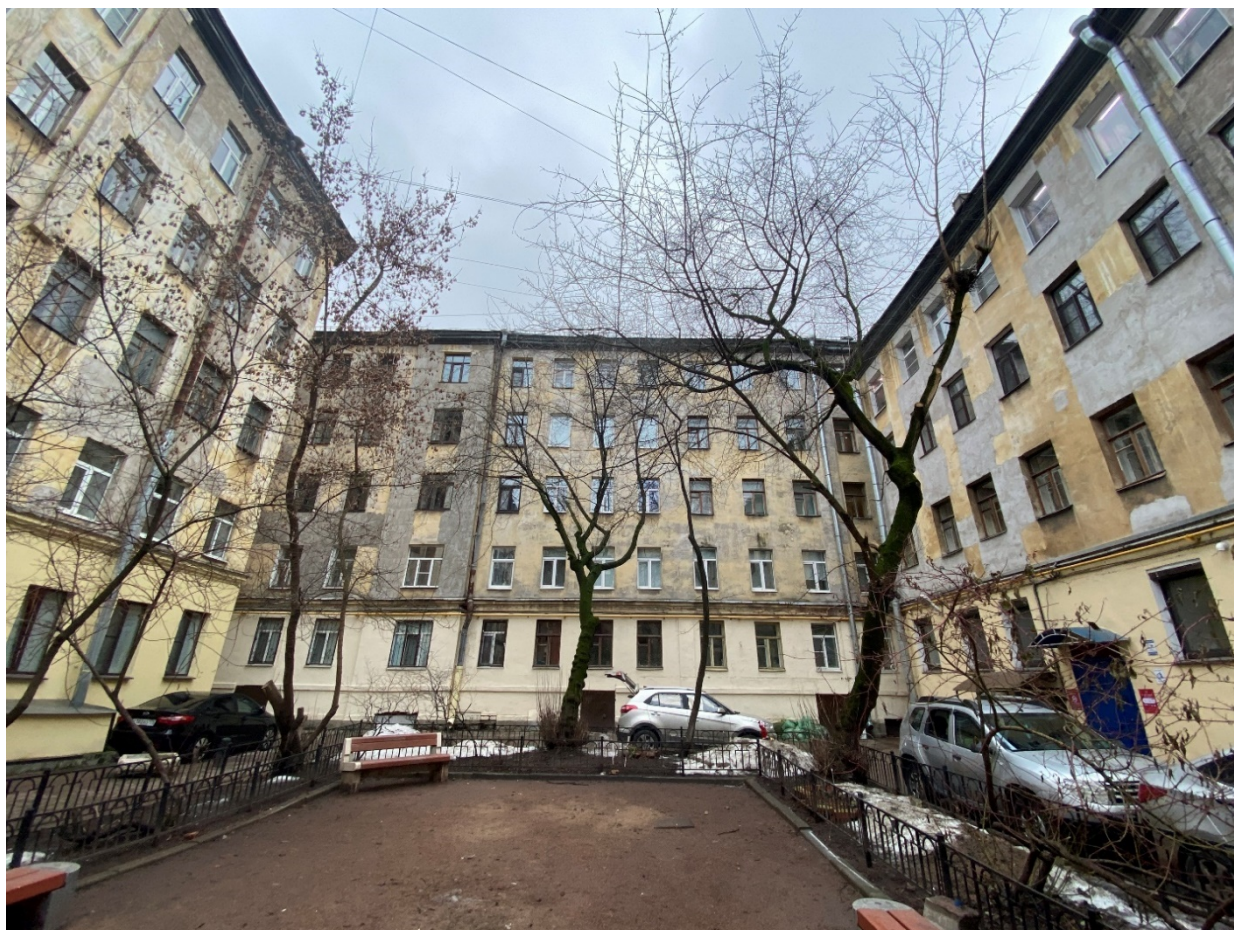
Фото 11. Северо-западный фасад дворового флигеля (южный двор). Вид с северо-запада.
