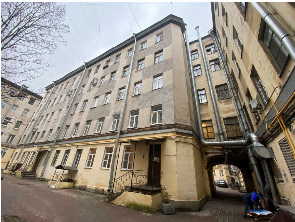
Фото 8. Северо-восточный фасад северного дворового флигеля. Вид с северо-запада.
