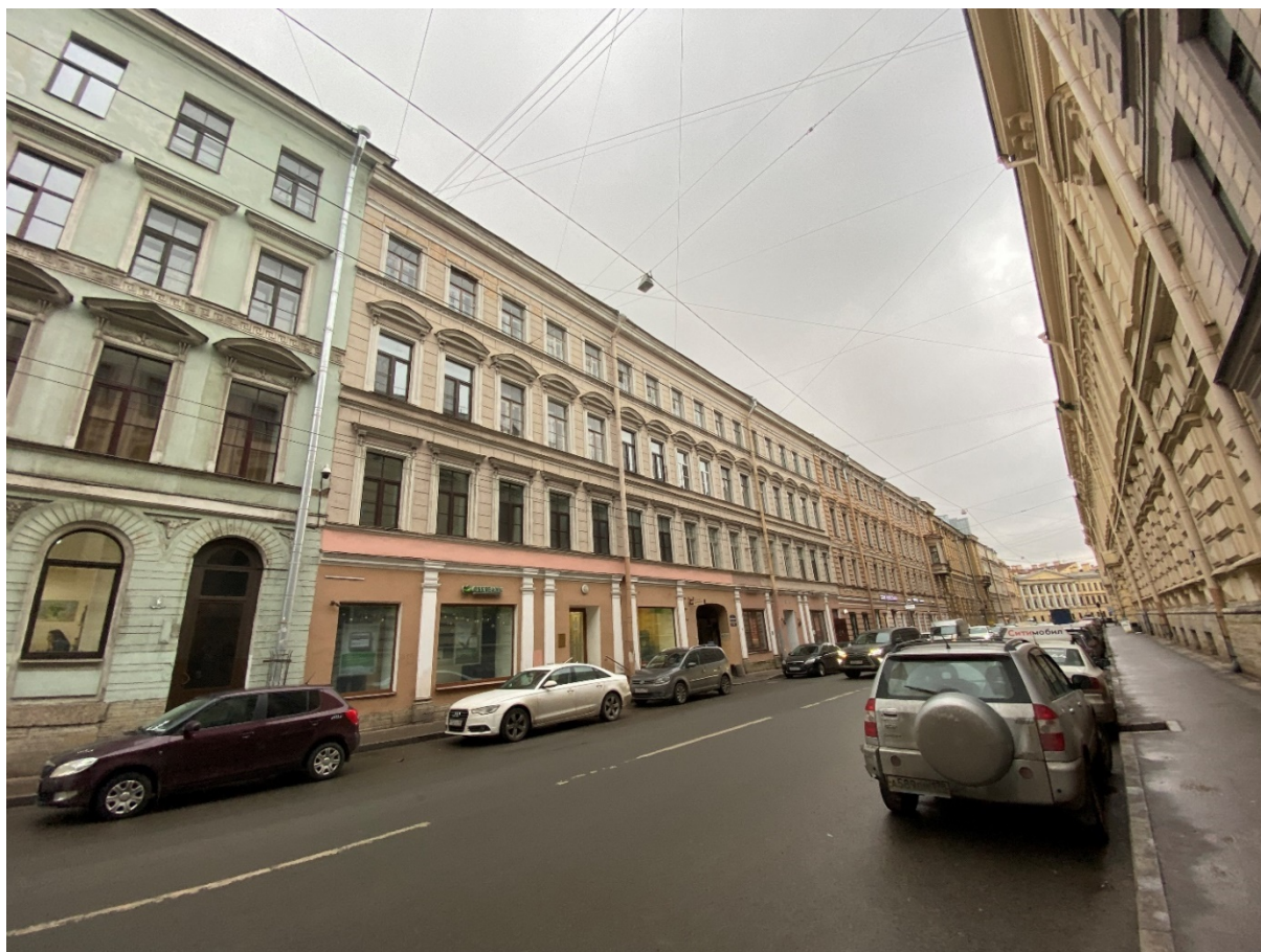
Фото 1. Общий вид объекта культурного наследия федерального значения «Дом, где в 1865-1928 гг. жил композитор Глазунов А.К.», расположенного по адресу: г. Санкт-Петербург, Казанская ул., 8-10. Вид с севера.
