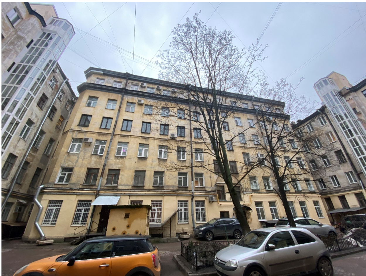
Фото 7. Юго-западный фасад северного дворового флигеля. Вид с юго-запада.
