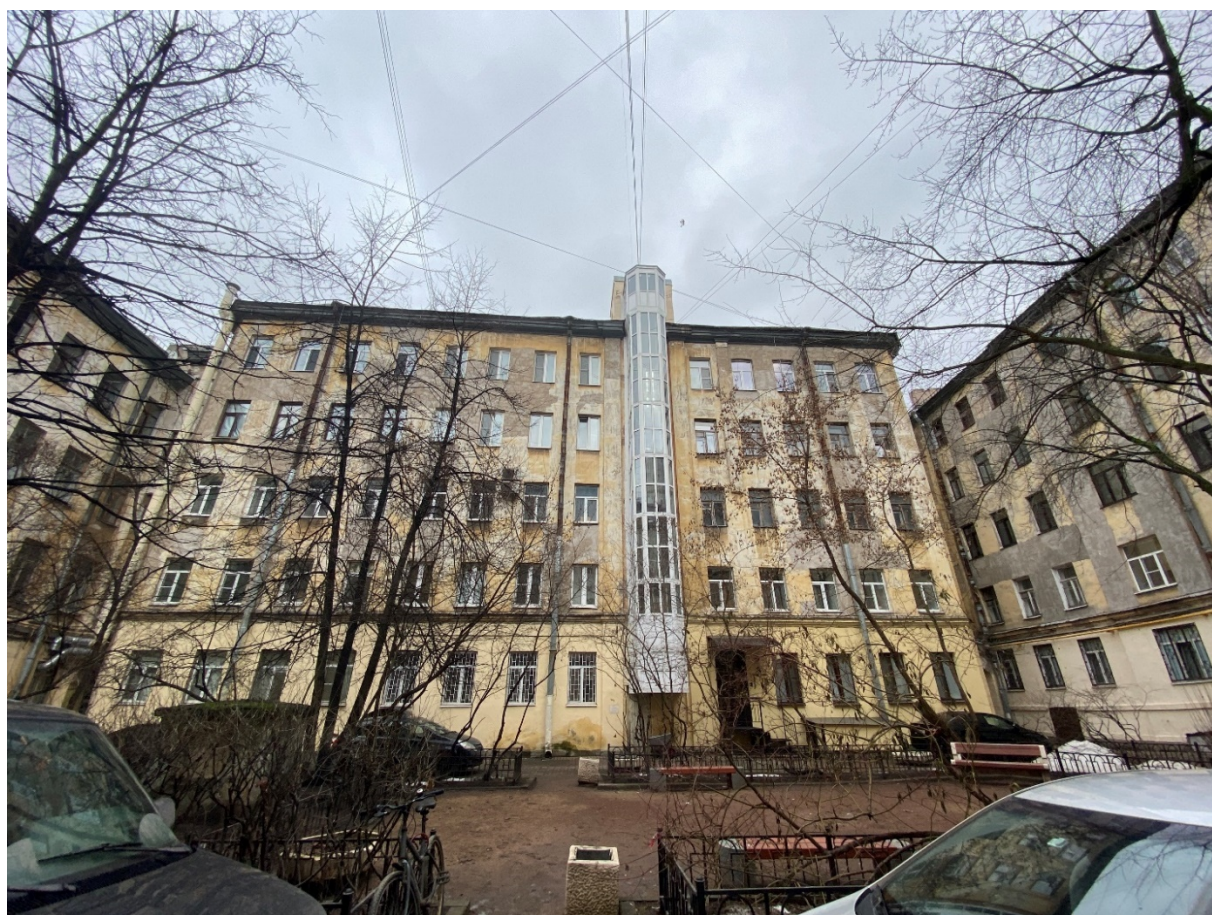
Фото 12. Юго-западный фасад дворового флигеля (южный двор). Вид с юго-запада.
