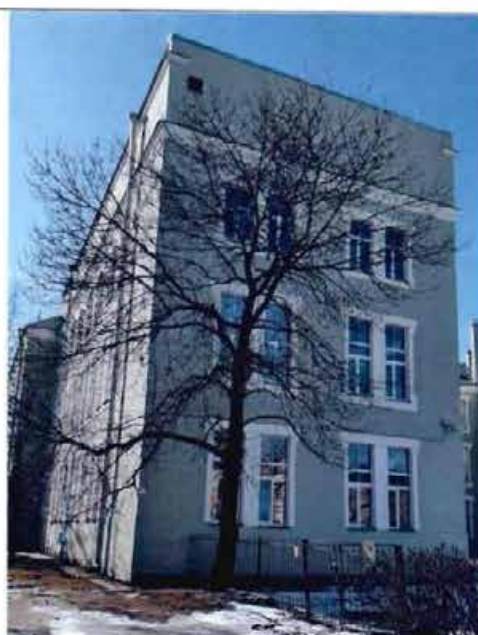
5. Фрагмент северо-восточного фасада
