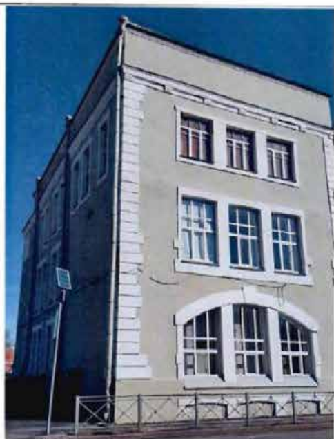
4. Фрагмент юго-западного фасада
