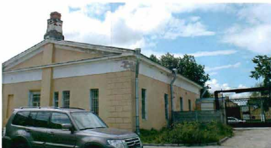
Фото №3. Вид на восточный и северный фасады со стороны двора.
