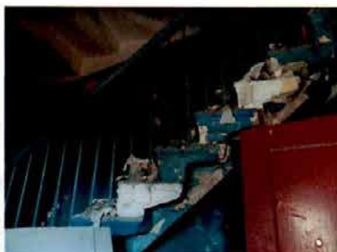
8. Лестница с бетонными ступенями.
