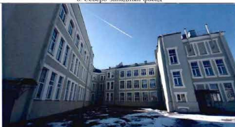
7. Фрагмент дворового фасада
