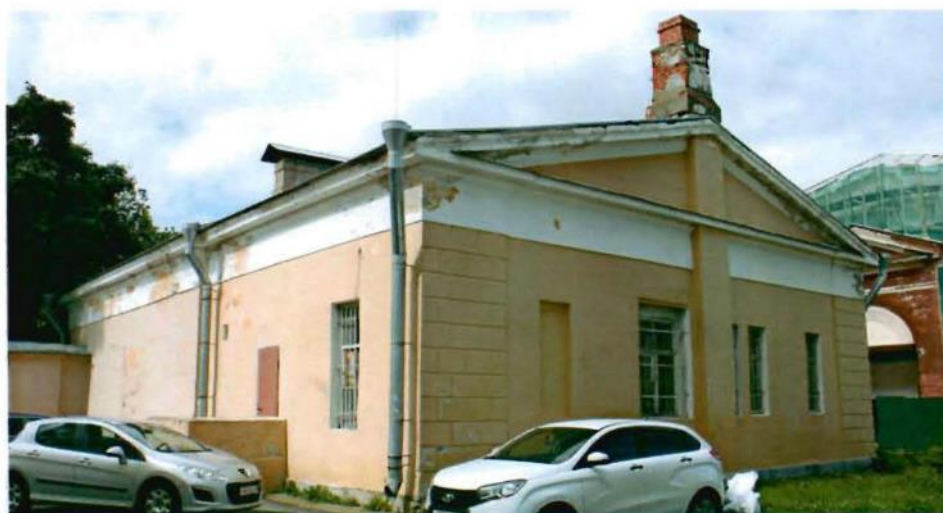
Фото №2. Вид на южный и восточный фасады со стороны двора.
