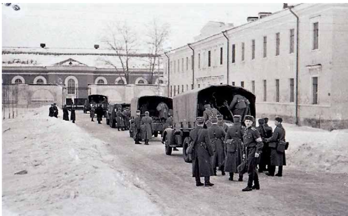
Илл. 14. ЛенВОКУ имени С.М.Кирова. Объект культурного наследия регионального значения «Казармы лейб-гвардии Уланского полка (с воротами, каменной оградой и территорией)». Фото в территории 1965 г. Retro View of Mankind's Habitat [Электронный ресурс]. Режим доступа: https://pastvu.com/ .
