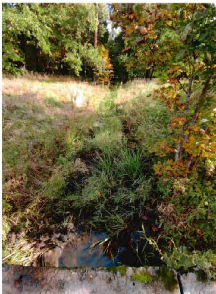
2. Русло наземной части объекта культурного наследия, вид с запада.
