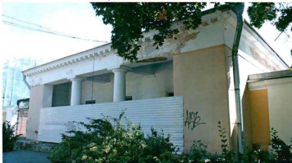
Фото №1. Вид на парадный (западный) фасад со стороны ул. Аврова.
