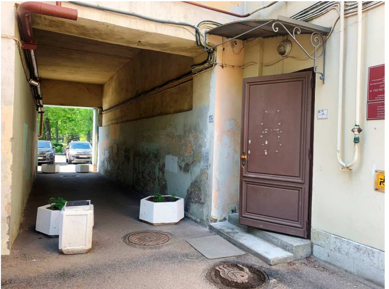
3. Фрагмент восточного (дворового) фасада. Вход в пом. 1-Н.
