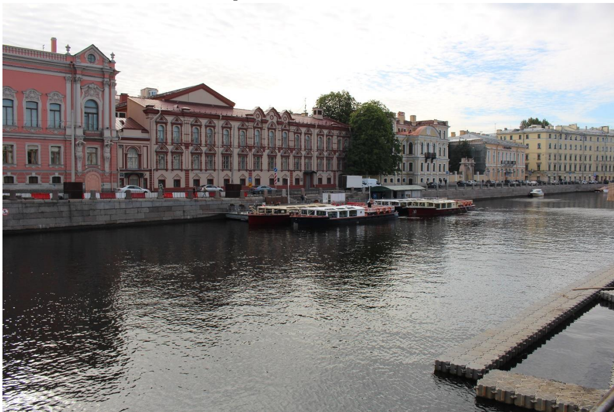
Фото 1. Вид на спуск № 3 объекта культурного наследия федерального значения «Набережные со спусками» на участке набережной реки Фонтанки «Аничков мост – мост Ломоносова», литера Б с северо-запада.
