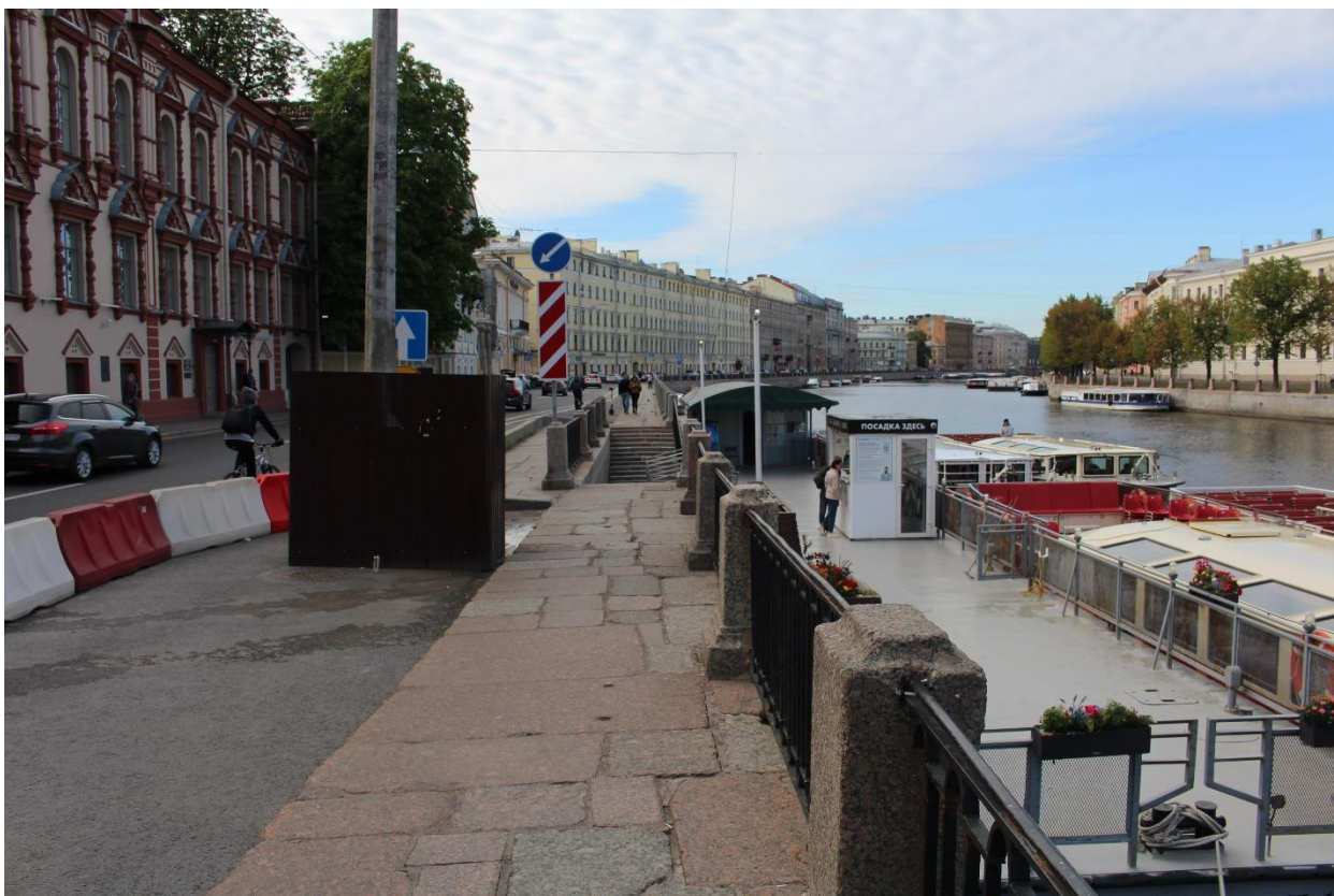
Фото 3. Вид на спуск № 3 объекта культурного наследия федерального значения «Набережные со спусками» на участке набережной реки Фонтанки «Аничков мост – мост Ломоносова», литера Б с северо-востока.
