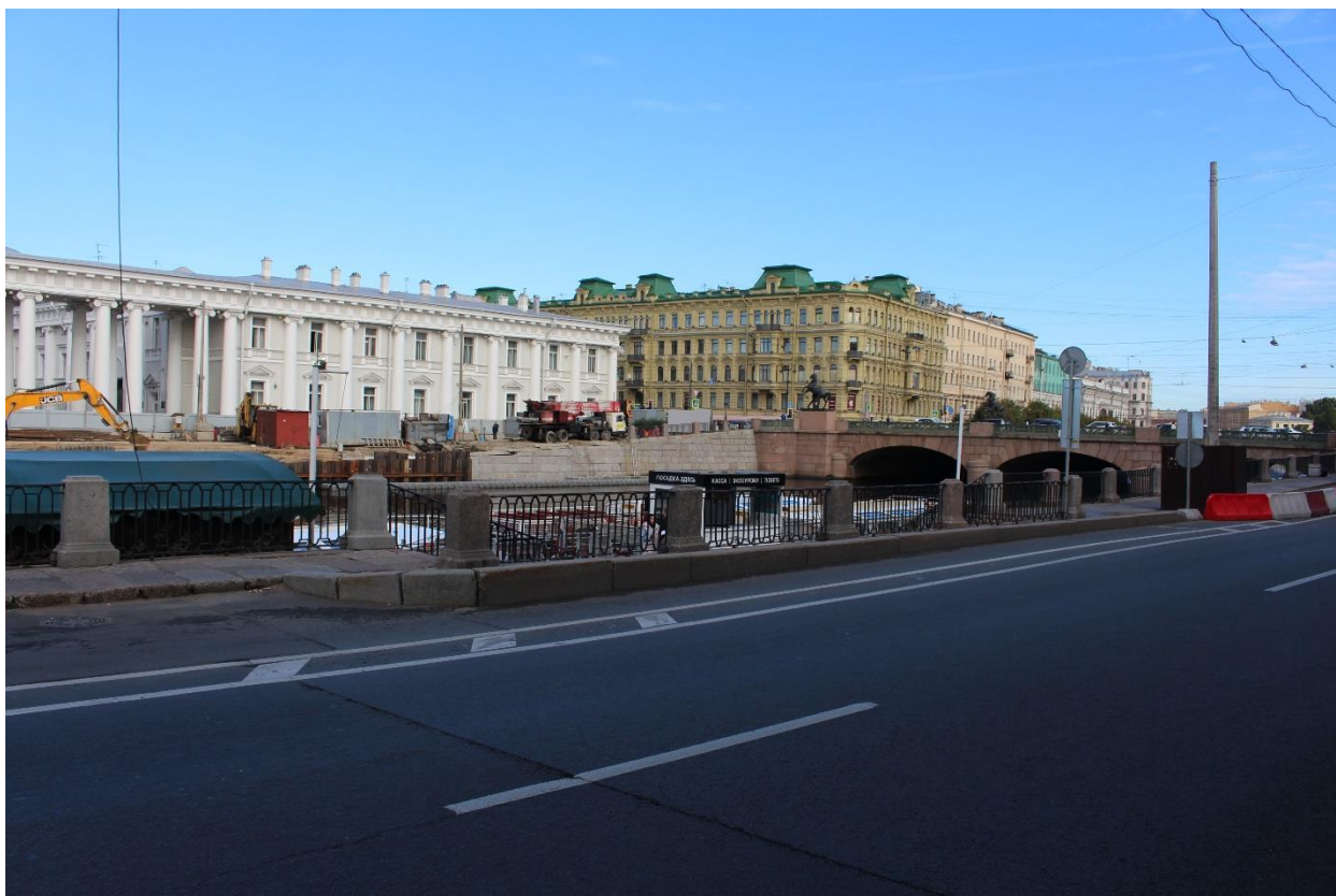
Фото 9. Вид на спуск № 3 объекта культурного наследия федерального значения «Набережные со спусками» на участке набережной реки Фонтанки «Аничков мост – мост Ломоносова», литера Б с юго-востока.
