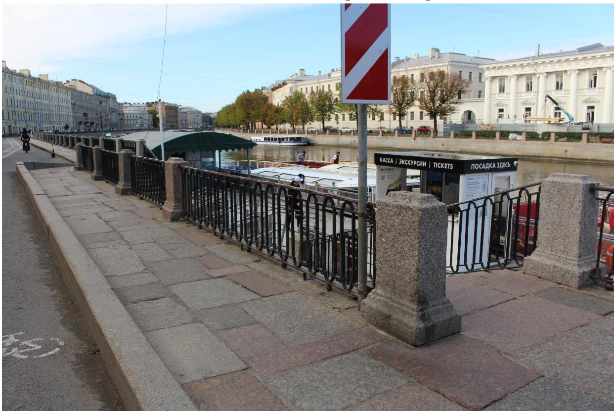
Фото 4. Вид на спуск № 3 объекта культурного наследия федерального значения «Набережные со спусками» на участке набережной реки Фонтанки «Аничков мост – мост Ломоносова», литера Б с северо-востока.
