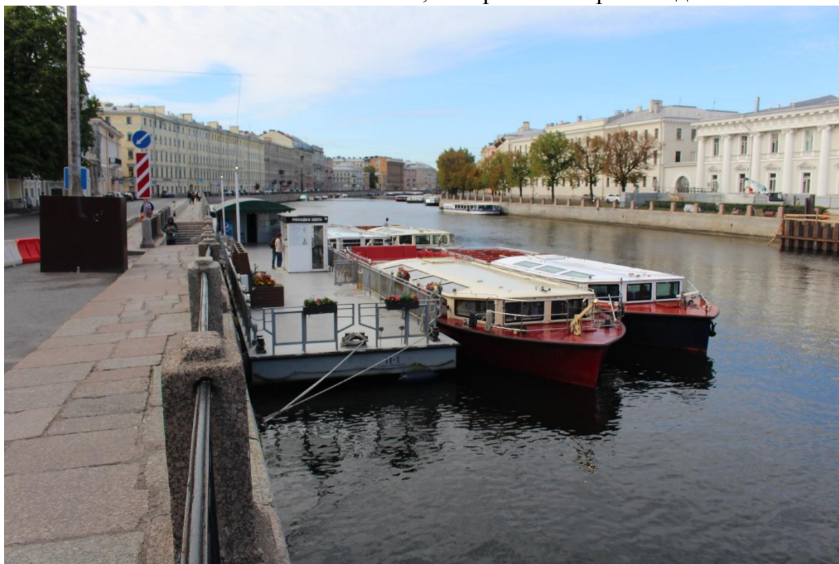
Фото 2. Вид на плавучий причал у спуска № 3 объекта культурного наследия федерального значения «Набережные со спусками» на участке набережной реки Фонтанки «Аничков мост – мост Ломоносова», литера Б с северо-востока.
