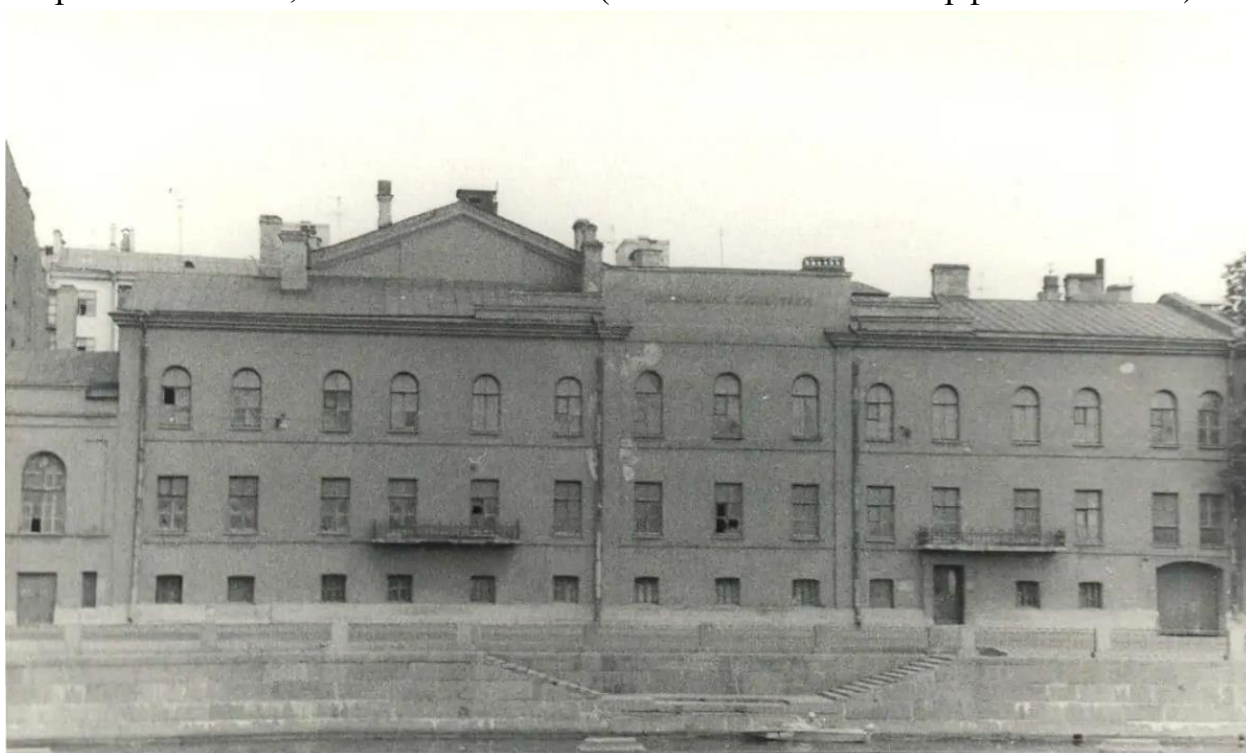
Илл. 14. Подготовленное к ремонту здание библиотеки им. В.В. Маяковского. 1973 г. (источник: https://pastvu.com/p/1087347 ).
