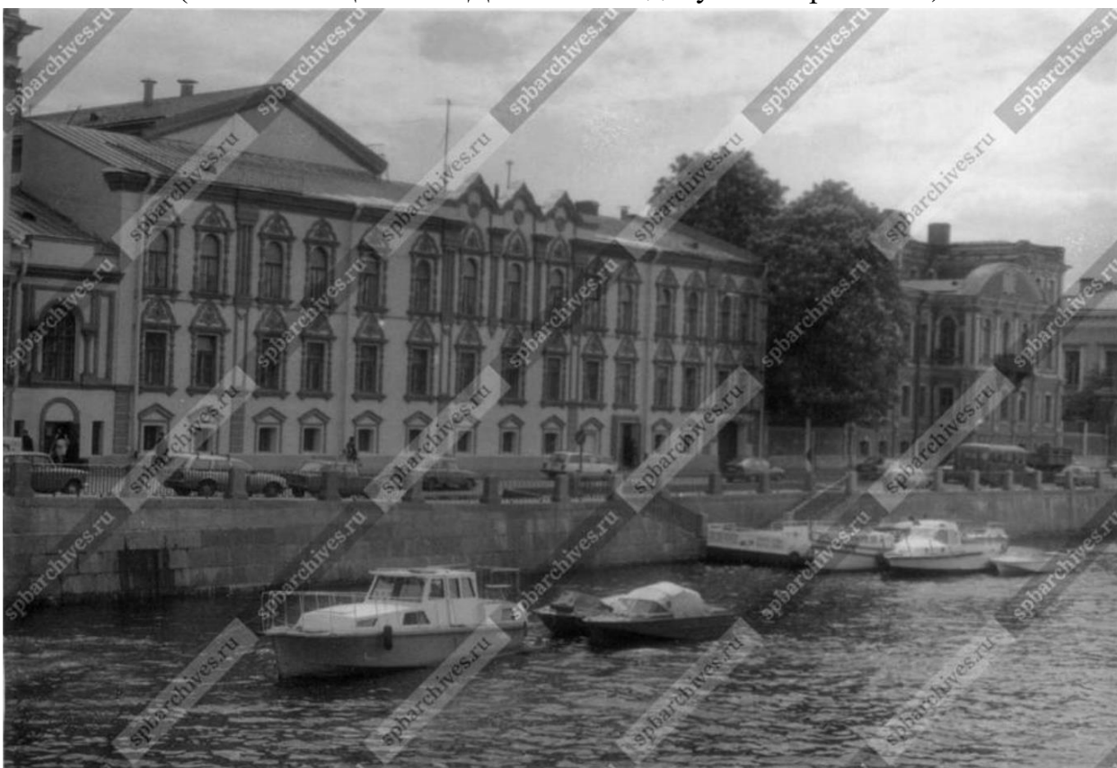
Илл. 18. Вид на пристань речного трамвая у дома №44 (здания бывшего подворья Троице-Сергиевой Лавры) на набережной реки Фонтанки. Нач. 1990-х гг. (источник: ЦГАКФД СПб. Фотодокумент Ар 175335).
