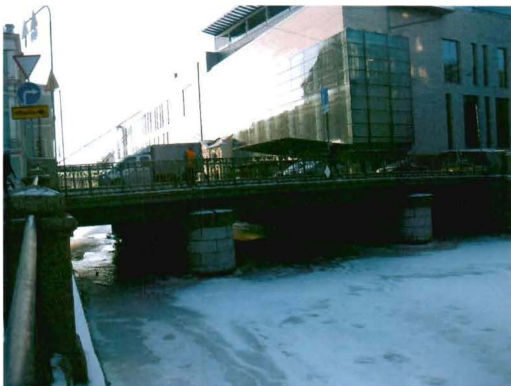
6. Вид моста со стороны низового фасада
