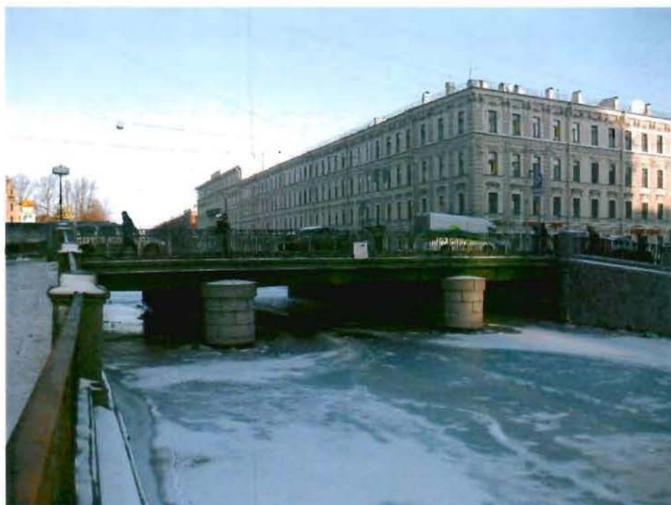
1. Вид моста со стороны верхового фасада
