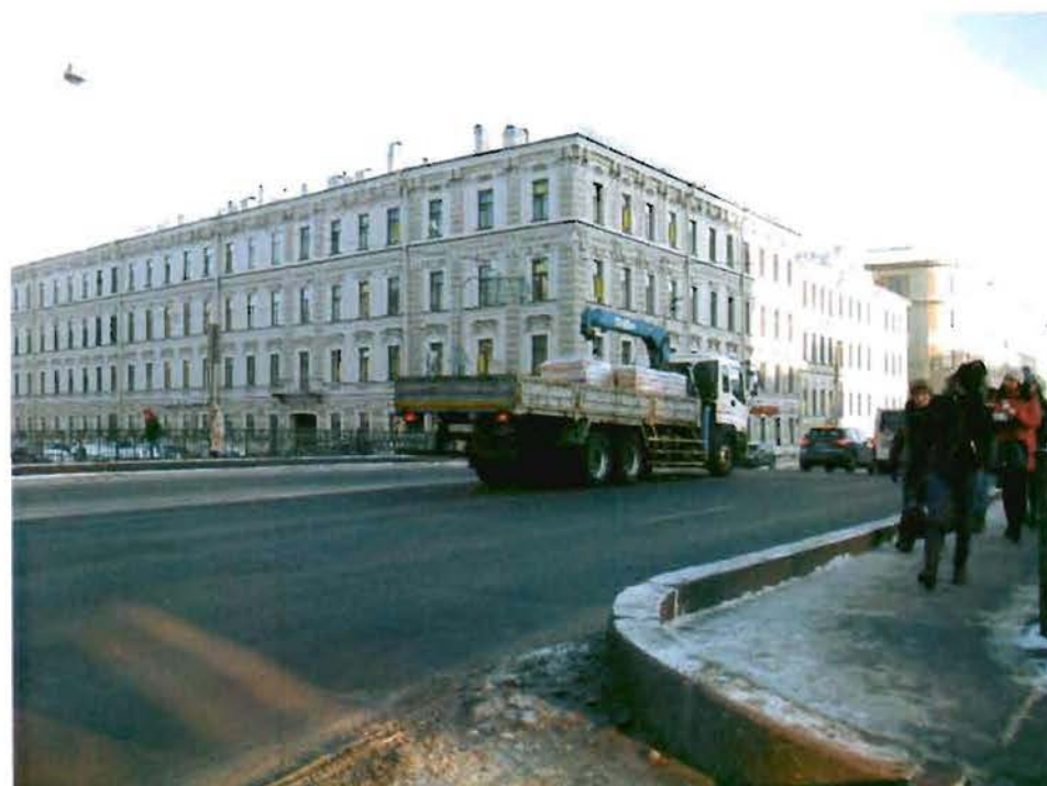
2. Вид на поверхность моста
