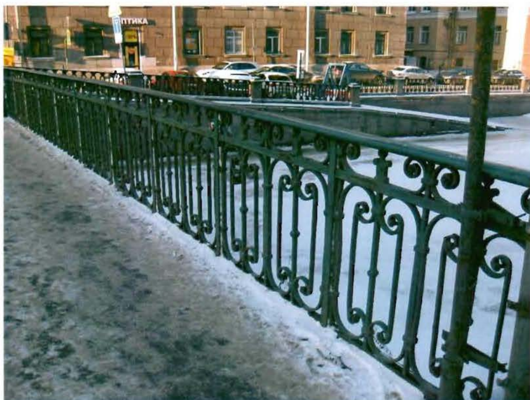
3. Перильное ограждение со стороны низового фасада
