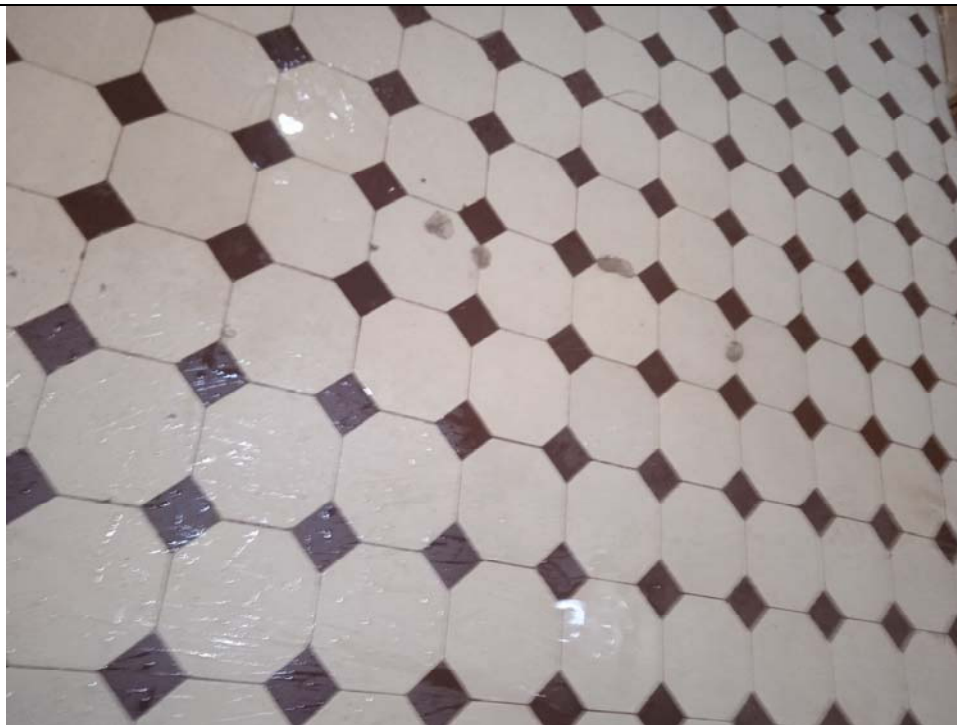
34. Объект культурного наследия федерального значения «Управление городское с оградой и воротами». Облицовка пола метлахской плиткой. Вестибюль.
