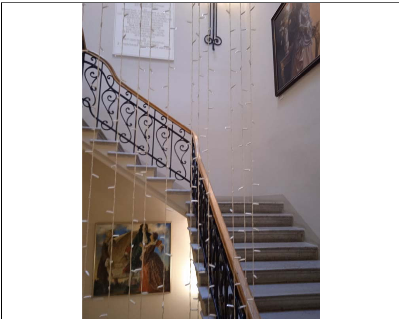
15. Объект культурного наследия федерального значения «Управление городское с оградой и воротами». Общий вид центральной лестницы.
