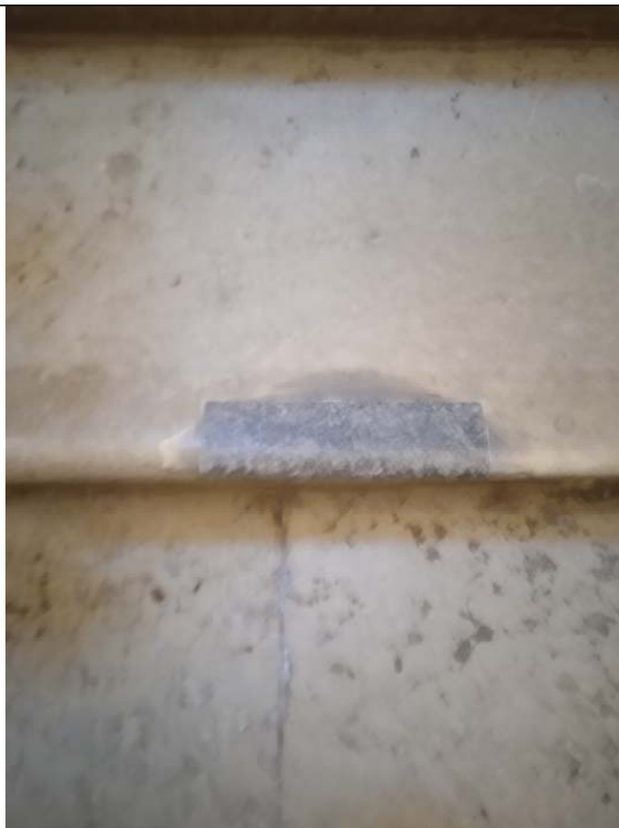
29. Объект культурного наследия федерального значения «Управление городское с оградой и воротами». Центральная лестница. Гранитная вставка в известняковую ступень.
