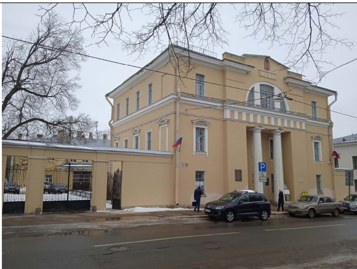
2. Объект культурного наследия федерального значения «Управление городское с оградой и воротами». Общий вид.
