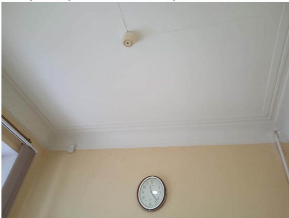
10. Объект культурного наследия федерального значения «Управление городское с оградой и воротами». Пом.1-Н, 1 этаж. Фрагмент.
