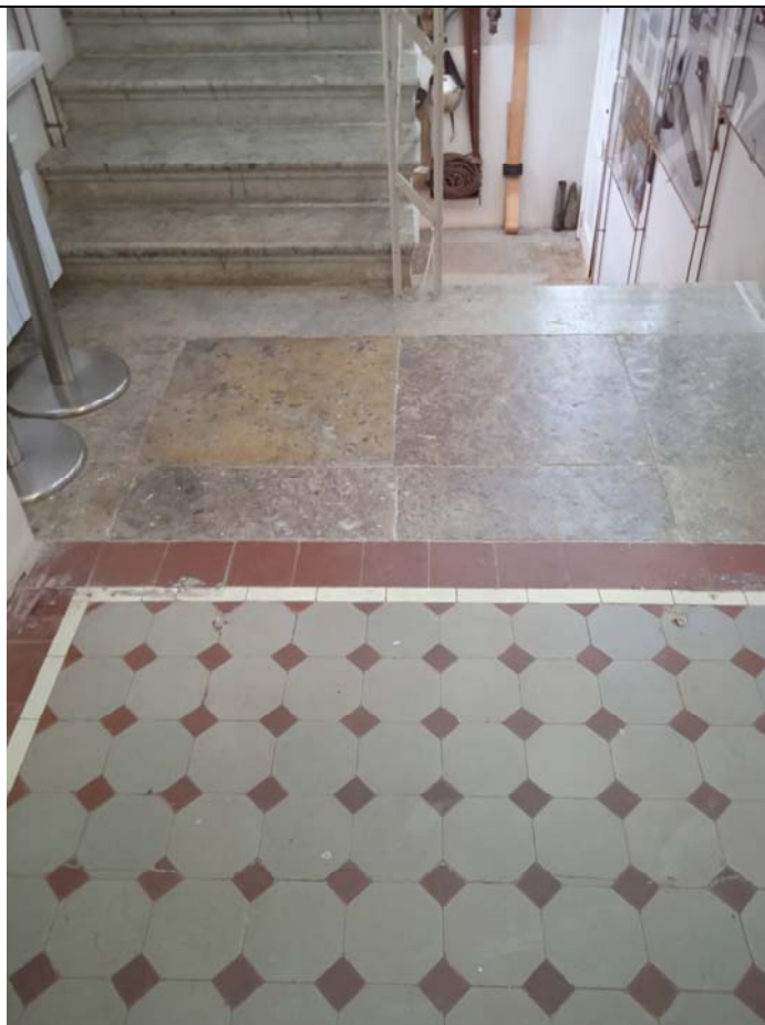
31. Объект культурного наследия федерального значения «Управление городское с оградой и воротами». Пожарная лестница. Облицовка лестничной площадки метлахской плиткой и известняковыми плитами.
