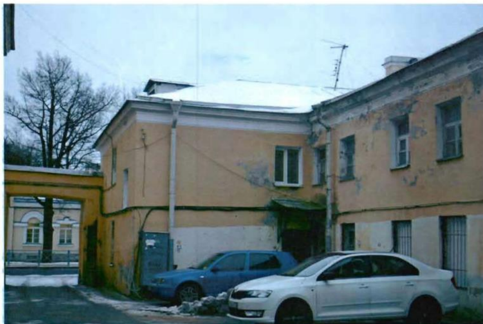
Фото 13. Часть дворового фасада.
