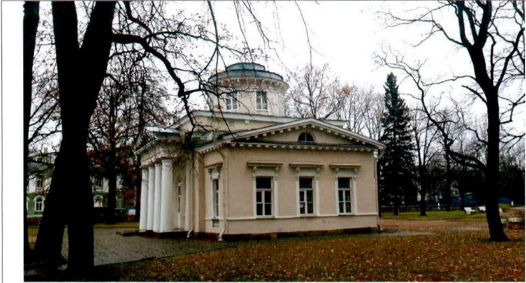
Фото 3. Восточный фасад. Общий вид. 28.10.2016.
