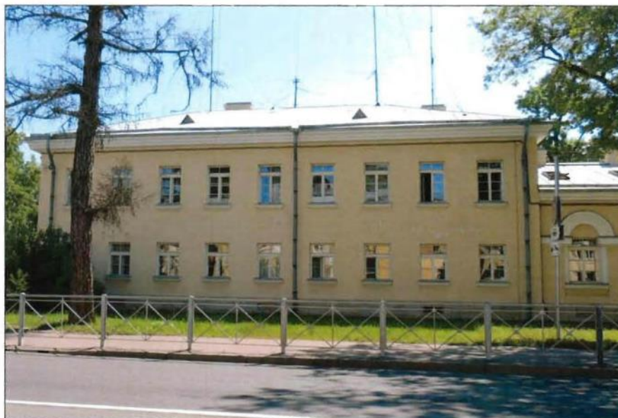
3. Западный фасад. Общий вид.
