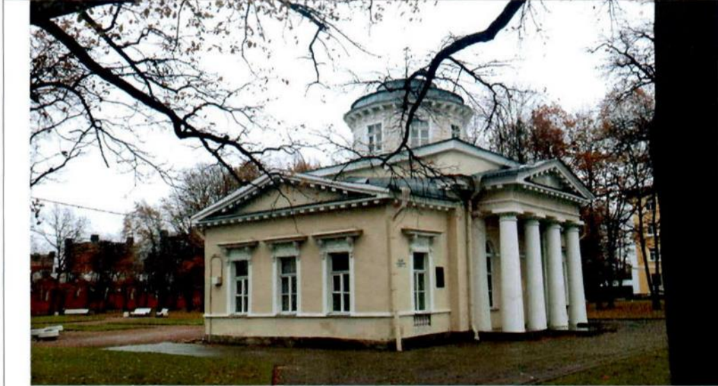
Фото 4. Западный фасад. Общий вид. 28.10.2016.
