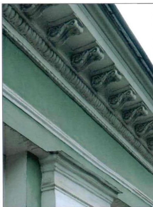
6. Западный фасад. Фрагмент. Венчающий карниз.
