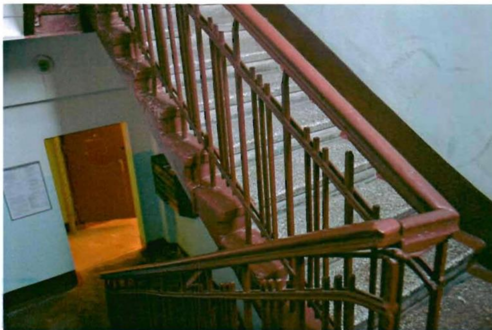
Фото 7. Лестница во втором подъезде.
