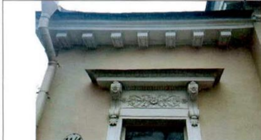
Фото 5. Оформление оконного проема, венчающий карниз. Фрагмент. 28.10.2016.
