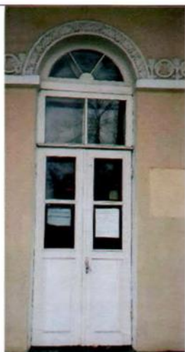
Фото 7. Дверной проем южного фасада. Общий вид. 28.10.2016.
