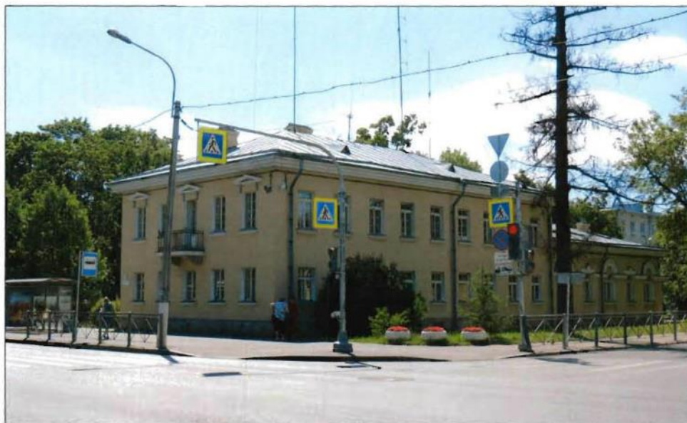
1. Общий вид с северо-запада.
