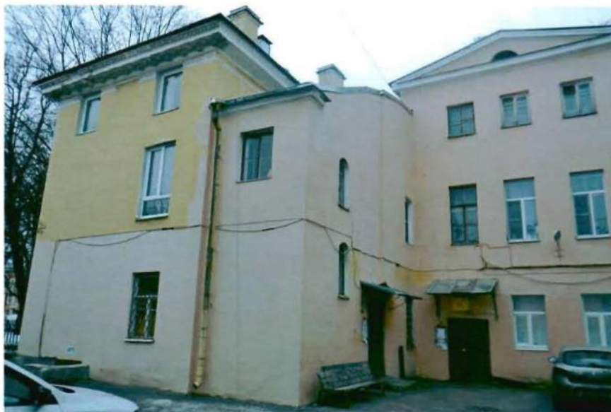
Фото 3. Часть дворового фасада.
