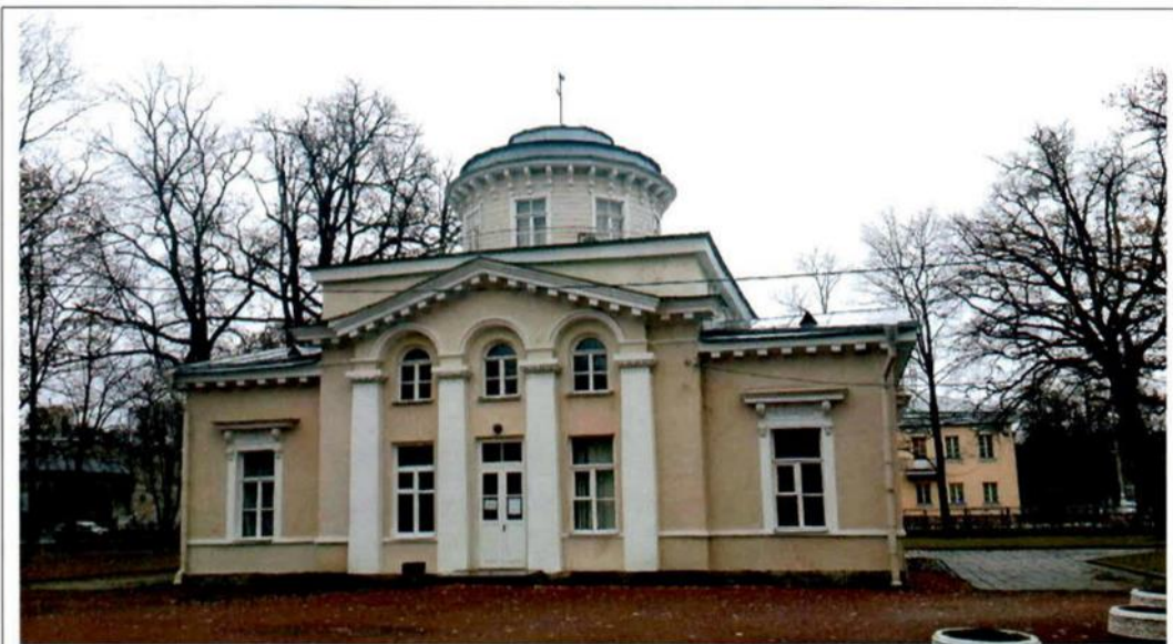
Фото 1. Северный фасад. Общий вид. 28.10.2016.
