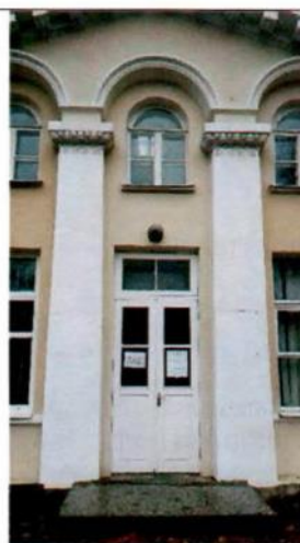
Фото 8. Дверной проем северного фасада. Общий вид. 28.10.2016.
