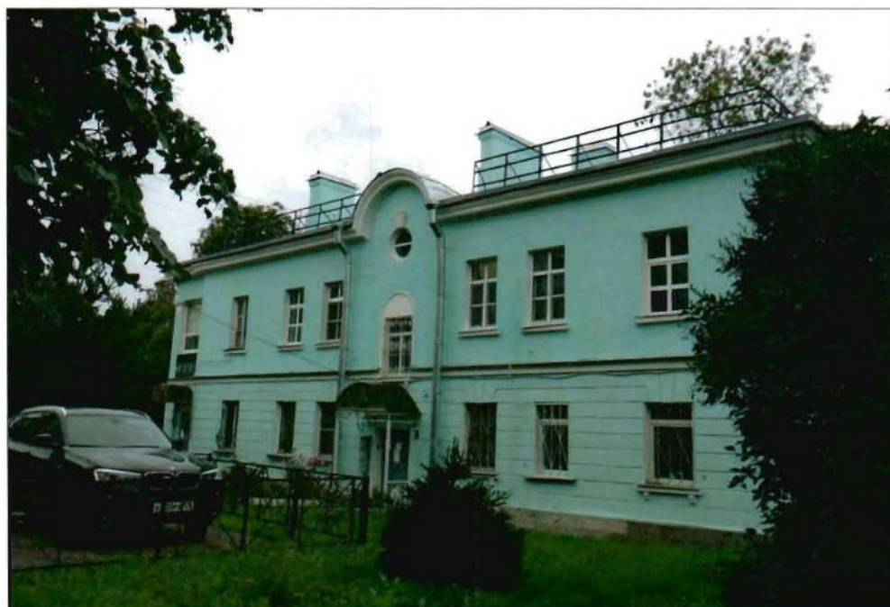
1. Общий вид с северо-востока.
