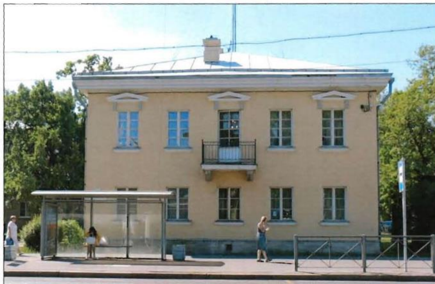
2. Северный фасад. Общий вид.
