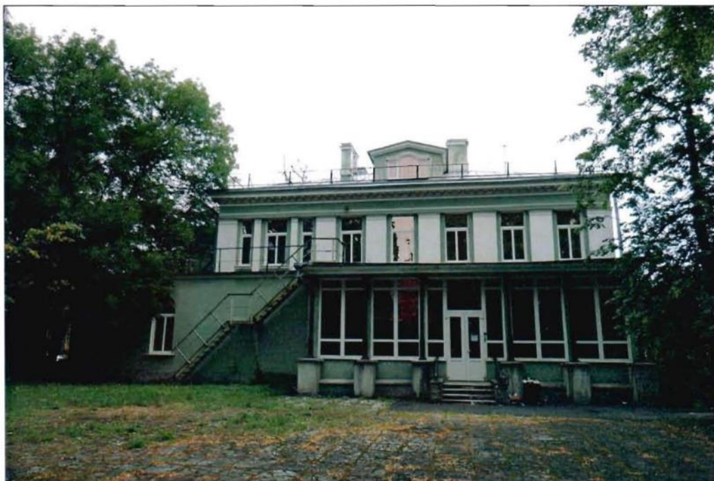
4. Западный фасад. Общий вид.
