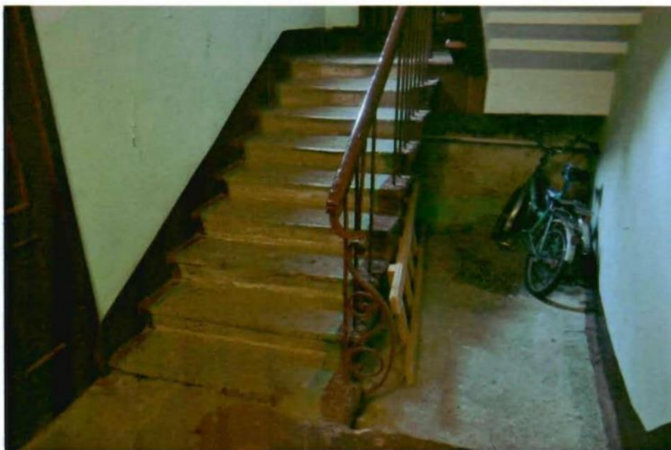
Фото 6. Лестница в первом подъезде.
