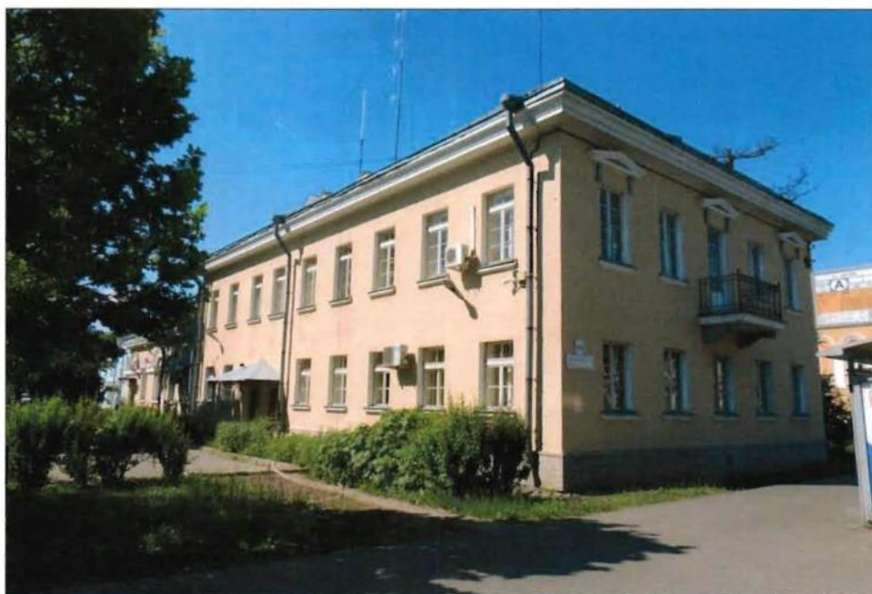
4. Общий вид с северо-востока.
