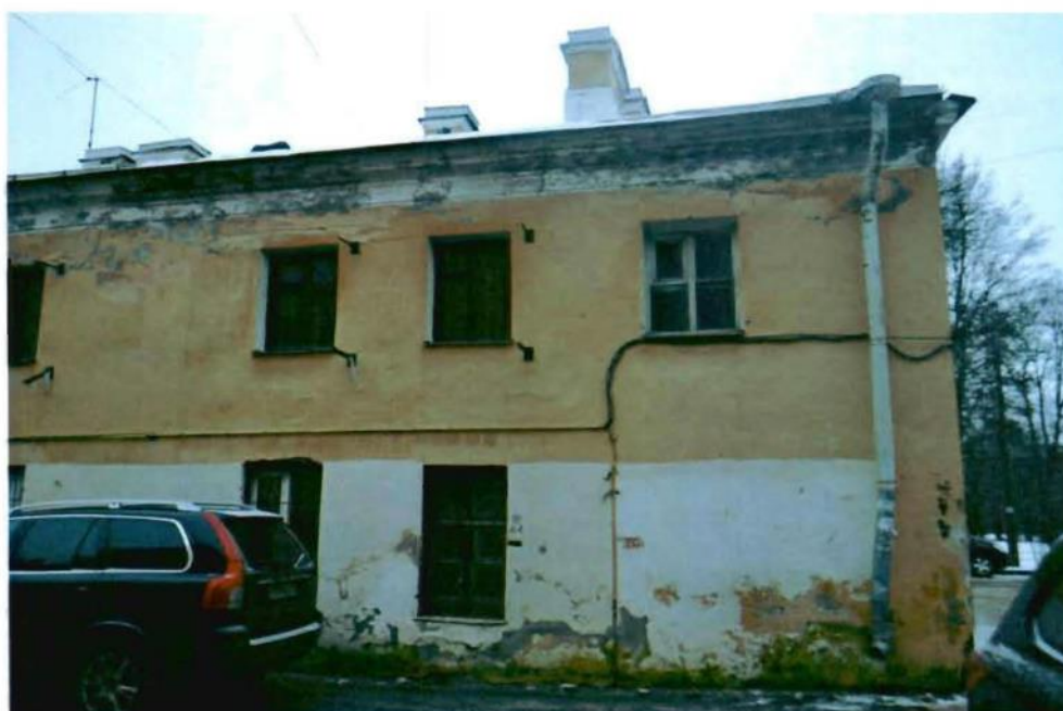
Фото 12. Часть дворового (северного) фасада.
