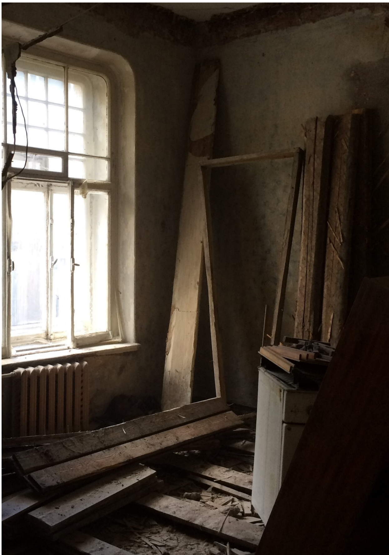
Фото 21 Общий вид на часть помещений квартиры № 50 (№ 8 по плану ПИБ). Наблюдается демонтаж отделки полов.
