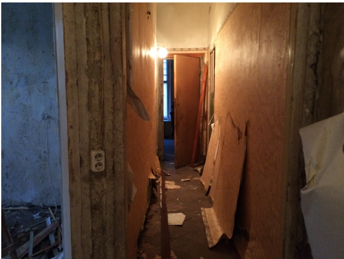
Фото 22 Общий вид на часть помещений квартиры № 50 (№ 9 по плану ПИБ).
