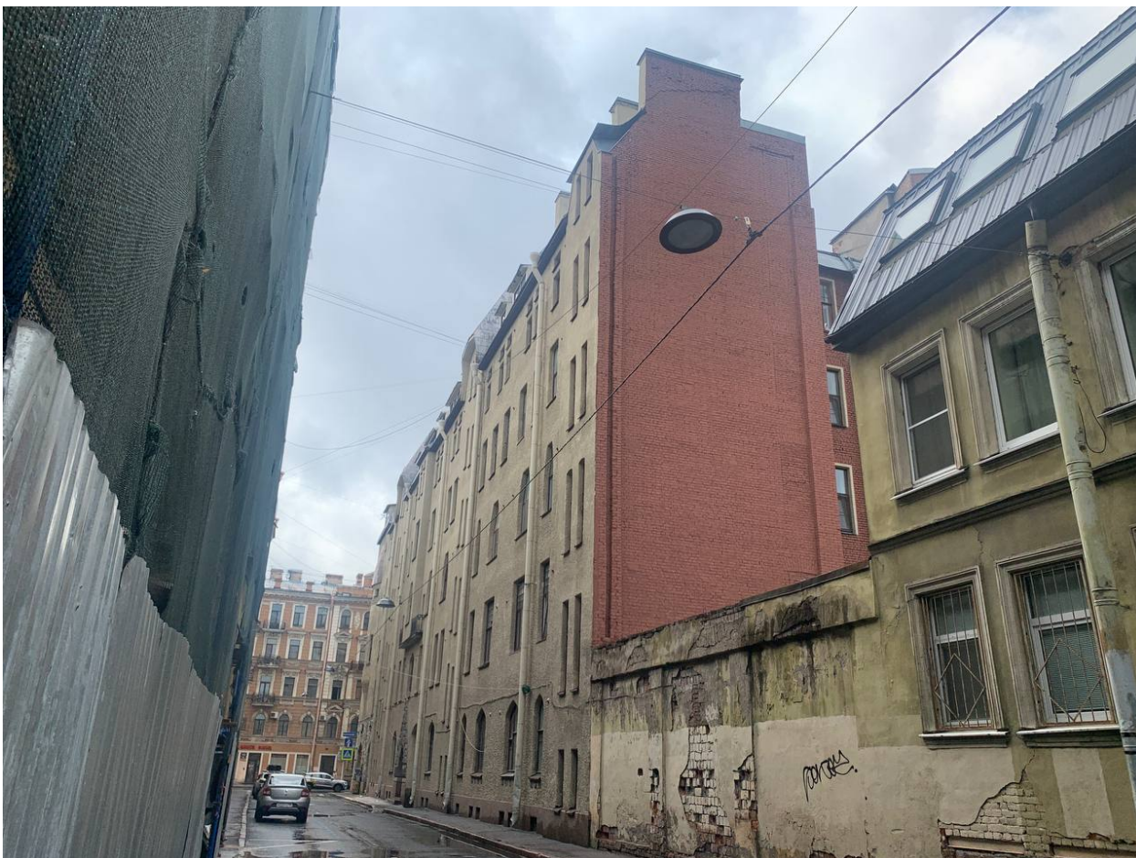
Фото 1 Общий вид на лицевой и часть дворового фасадов здания со стороны Ораниенбаумской ул.
