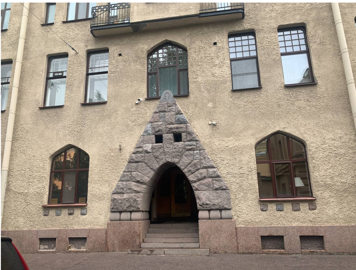
Фото 13 Общий вид на фрагмент лицевого фасада здания со стороны Стрельнинской ул.
