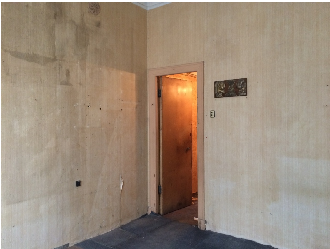
Фото 17 Общий вид на часть помещений квартиры № 50 (№ 8 по плану ПИБ).
