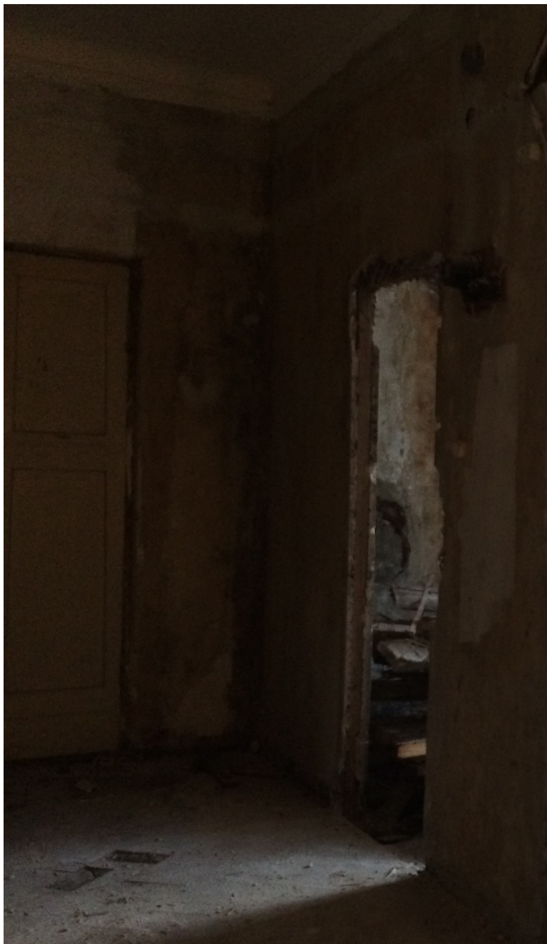
Фото 3 Общий вид на часть помещений квартиры № 50 (№ 1 по плану ПИБ).
