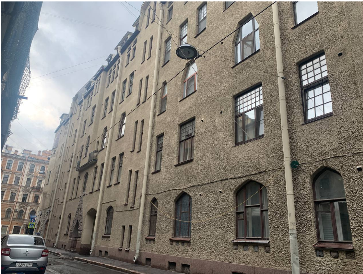
Фото 4 Общий вид на фрагмент лицевого фасада здания со стороны Ораниенбаумской ул.
