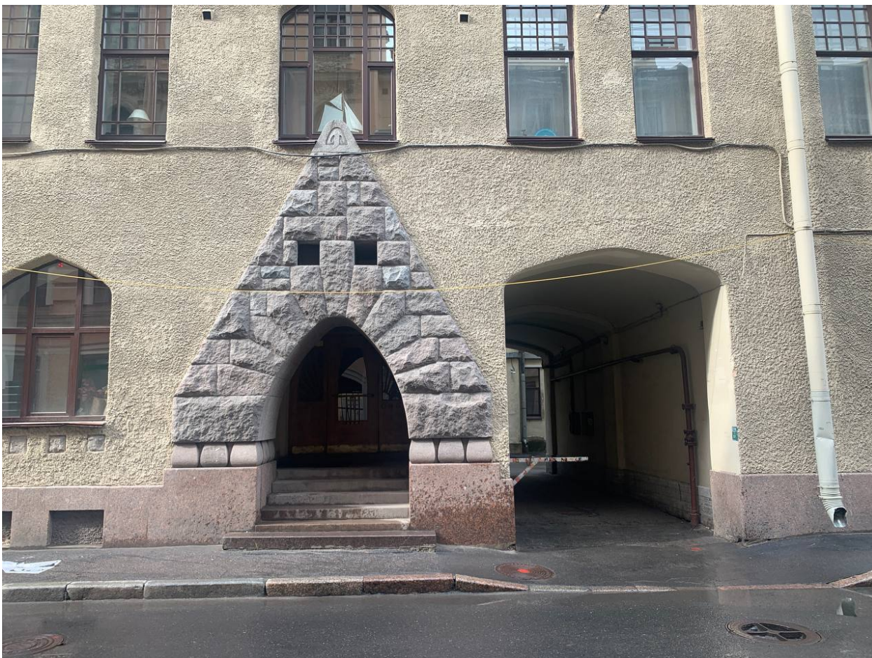
Фото 5 Общий вид на фрагмент лицевого фасада здания со стороны Ораниенбаумской ул.
