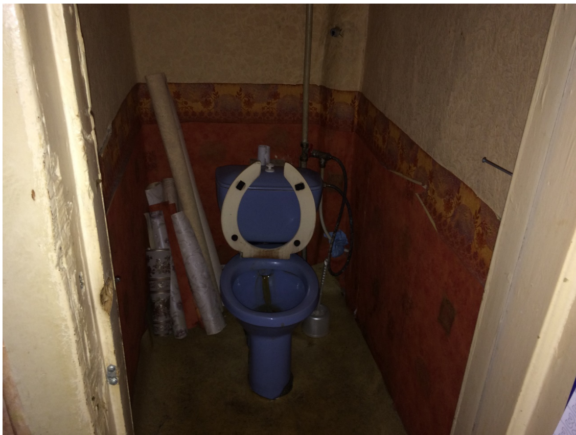
Фото 16 Общий вид на часть помещений квартиры № 50 (№ 7 по плану ПИБ).
