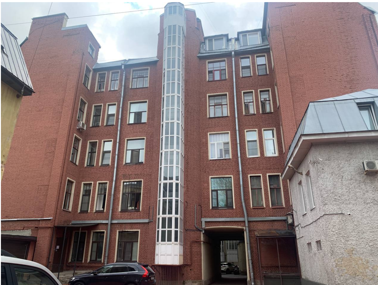
Фото 17 Общий вид на дворовой фасад здания.
