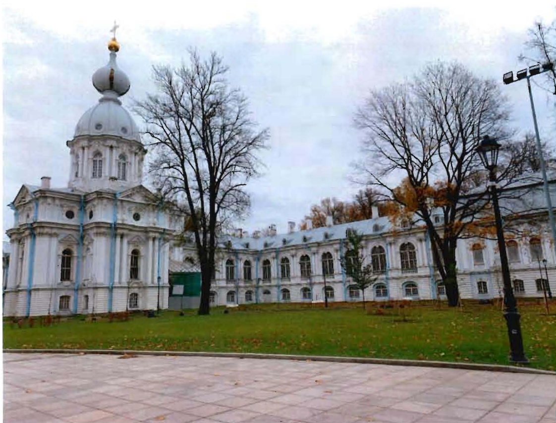
1. Фрагмент объекта культурного наследия с северной стороны.
