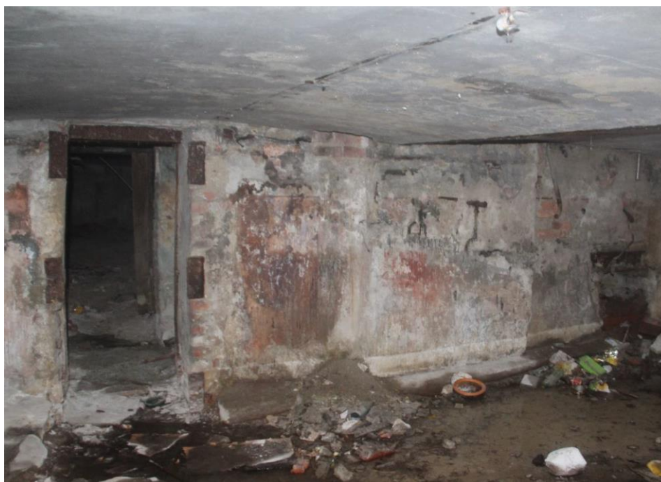
22. Здание по адресу: г. Санкт-Петербург, Кондратьевский пр., д. 40, литера А, корпус 7, являющееся частью объекта культурного наследия регионального значения «Жилые здания», входящее в состав объекта культурного наследия регионального значения «Кондратьевский жилмассив» (г. Санкт-Петербург, Калининский район, Кондратьевский пр., д. 40. На основании Распоряжения КГИОП от 27.02.2014 № 10-89). Помещение подвала. Общий вид.
