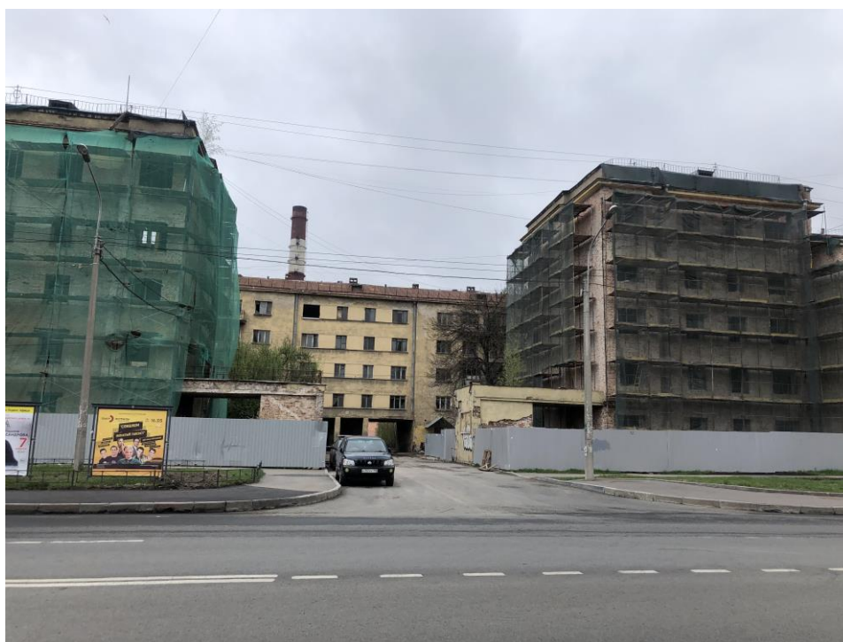
2. Здание по адресу: г. Санкт-Петербург, Кондратьевский пр., д. 40, литера А, корпус 7, являющееся частью объекта культурного наследия регионального значения «Жилые здания», входящее в состав объекта культурного наследия регионального значения «Кондратьевский жилмассив» (г. Санкт-Петербург, Калининский район, Кондратьевский пр., д. 40. На основании Распоряжения КГИОП от 27.02.2014 № 10-89). Общий вид на жилмассив со стороны Кондратьевского проспекта.
