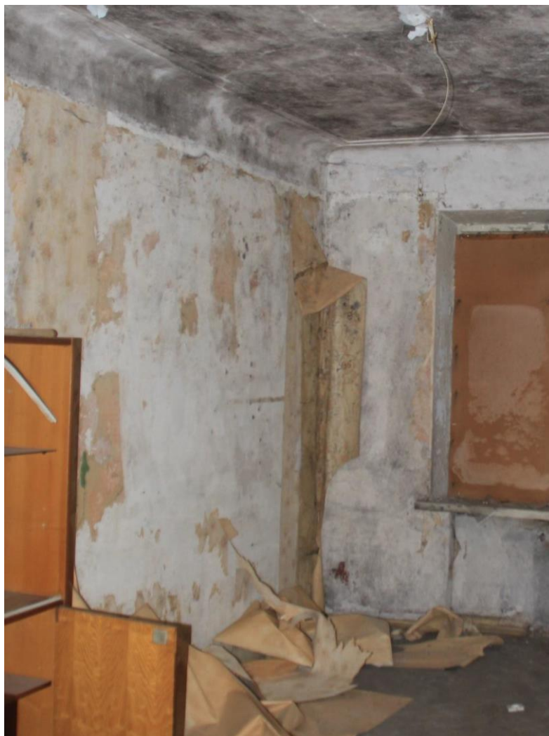
38. Здание по адресу: г. Санкт-Петербург, Кондратьевский пр., д. 40, литера А, корпус 7, являющееся частью объекта культурного наследия регионального значения «Жилые здания», входящее в состав объекта культурного наследия регионального значения «Кондратьевский жилмассив» (г. Санкт-Петербург, Калининский район, Кондратьевский пр., д. 40. На основании Распоряжения КГИОП от 27.02.2014 № 10-89). Фрагмент интерьера помещения четвертого этажа.
