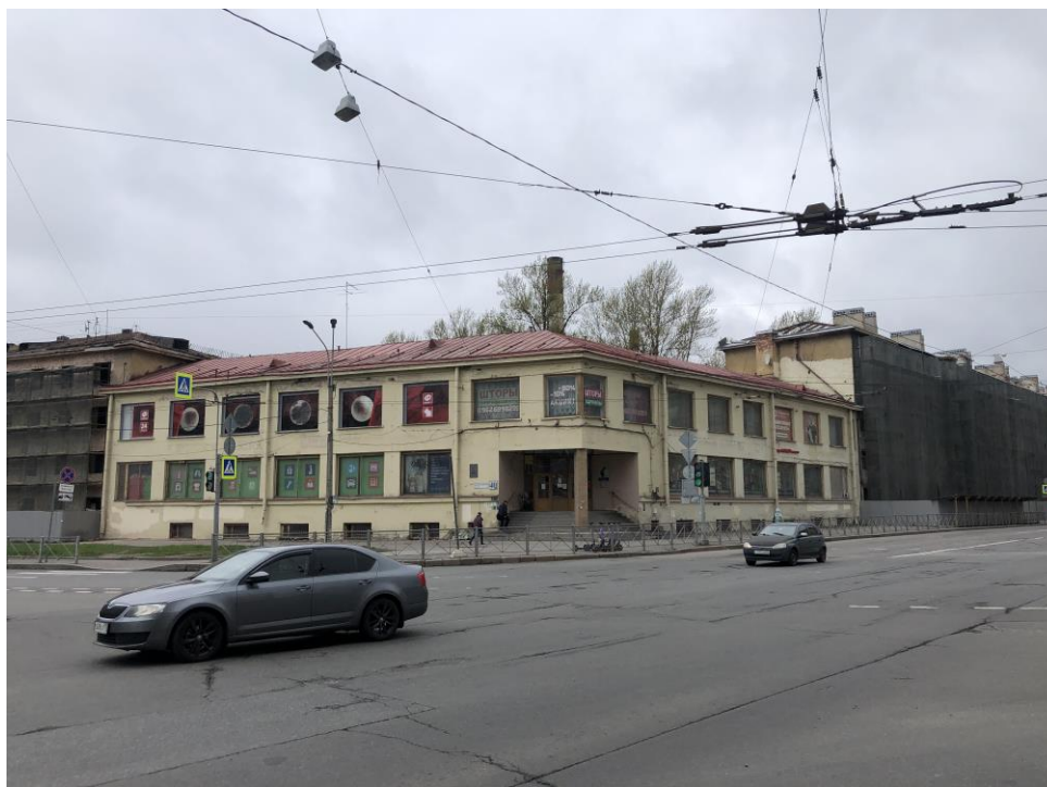
1. Здание по адресу: г. Санкт-Петербург, Кондратьевский пр., д. 40, литера А, корпус 7, являющееся частью объекта культурного наследия регионального значения «Жилые здания», входящее в состав объекта культурного наследия регионального значения «Кондратьевский жилмассив» (г. Санкт-Петербург, Калининский район, Кондратьевский пр., д. 40. На основании Распоряжения КГИОП от 27.02.2014 № 10-89). Общий вид на жилмассив со стороны площади Калинина.
