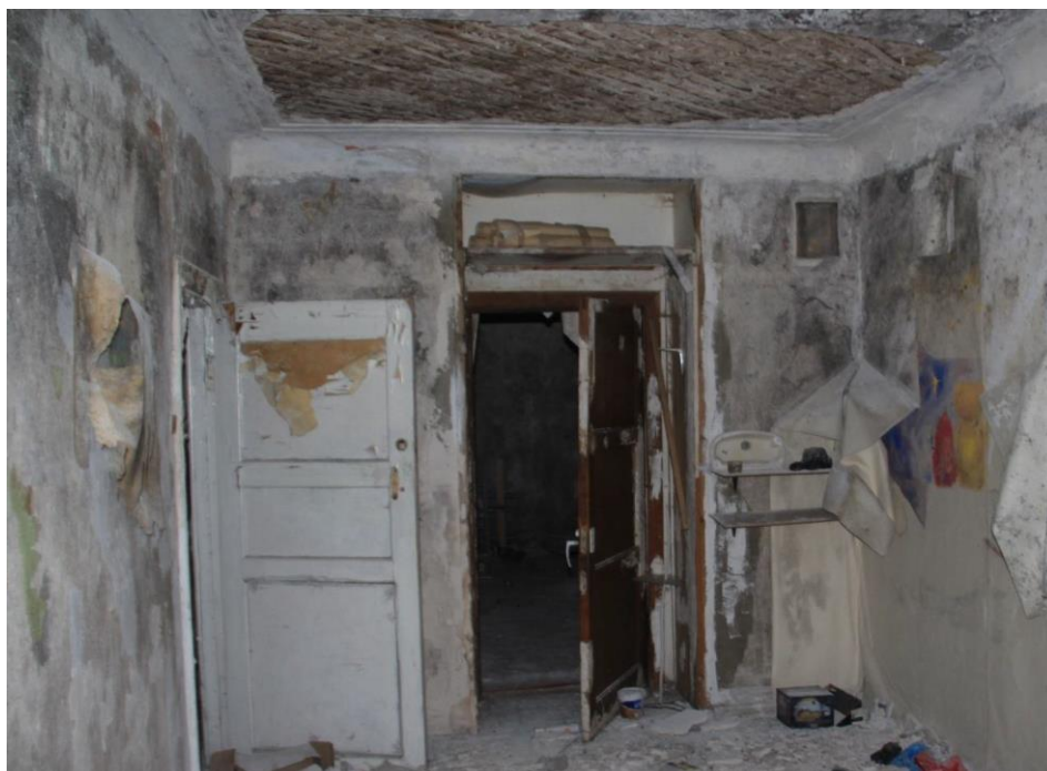
35. Здание по адресу: г. Санкт-Петербург, Кондратьевский пр., д. 40, литера А, корпус 7, являющееся частью объекта культурного наследия регионального значения «Жилые здания», входящее в состав объекта культурного наследия регионального значения «Кондратьевский жилмассив» (г. Санкт-Петербург, Калининский район, Кондратьевский пр., д. 40. На основании Распоряжения КГИОП от 27.02.2014 № 10-89). Помещение третьего этажа. Общий вид.
