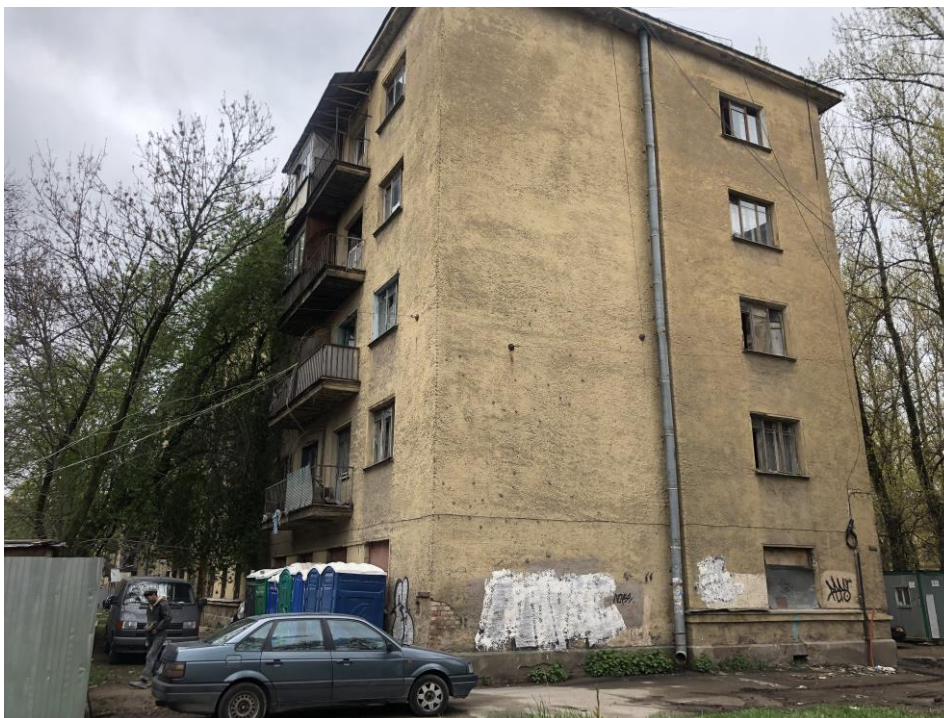
14. Здание по адресу: г. Санкт-Петербург, Кондратьевский пр., д. 40, литера А, корпус 7, являющееся частью объекта культурного наследия регионального значения «Жилые здания», входящее в состав объекта культурного наследия регионального значения «Кондратьевский жилмассив» (г. Санкт-Петербург, Калининский район, Кондратьевский пр., д. 40. На основании Распоряжения КГИОП от 27.02.2014 № 10-89). Вид на угол северного торцевого и восточного фасадов корпуса 7.
