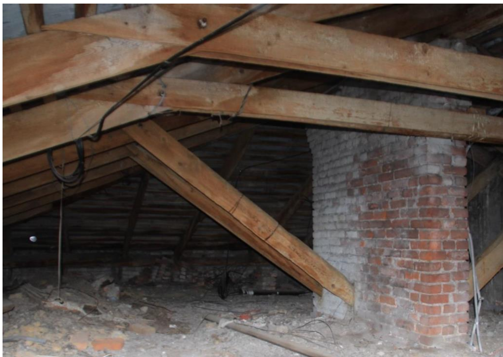
45. Здание по адресу: г. Санкт-Петербург, Кондратьевский пр., д. 40, литера А, корпус 7, являющееся частью объекта культурного наследия регионального значения «Жилые здания», входящее в состав объекта культурного наследия регионального значения «Кондратьевский жилмассив» (г. Санкт-Петербург, Калининский район, Кондратьевский пр., д. 40. На основании Распоряжения КГИОП от 27.02.2014 № 10-89). Фрагмент интерьера помещения в уровне чердака.
