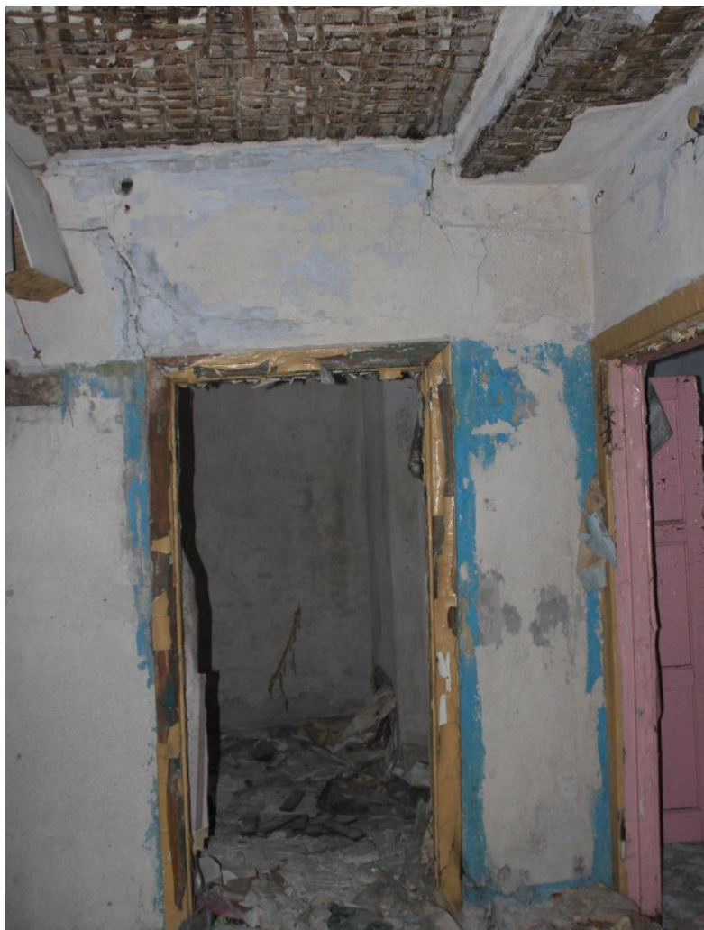
32. Здание по адресу: г. Санкт-Петербург, Кондратьевский пр., д. 40, литера А, корпус 7, являющееся частью объекта культурного наследия регионального значения «Жилые здания», входящее в состав объекта культурного наследия регионального значения «Кондратьевский жилмассив» (г. Санкт-Петербург, Калининский район, Кондратьевский пр., д. 40. На основании Распоряжения КГИОП от 27.02.2014 № 10-89). Фрагмент интерьера помещения третьего этажа.
