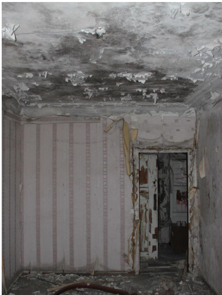
40. Здание по адресу: г. Санкт-Петербург, Кондратьевский пр., д. 40, литера А, корпус 7, являющееся частью объекта культурного наследия регионального значения «Жилые здания», входящее в состав объекта культурного наследия регионального значения «Кондратьевский жилмассив» (г. Санкт-Петербург, Калининский район, Кондратьевский пр., д. 40. На основании Распоряжения КГИОП от 27.02.2014 № 10-89). Фрагмент интерьера помещения четвертого этажа.
