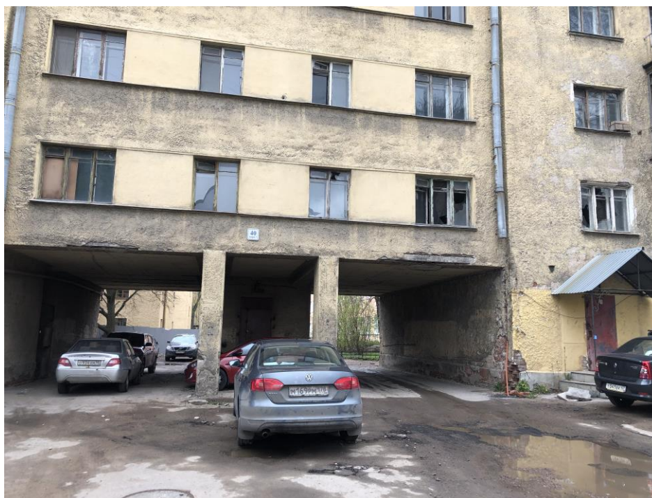
17. Здание по адресу: г. Санкт-Петербург, Кондратьевский пр., д. 40, литера А, корпус 7, являющееся частью объекта культурного наследия регионального значения «Жилые здания», входящее в состав объекта культурного наследия регионального значения «Кондратьевский жилмассив» (г. Санкт-Петербург, Калининский район, Кондратьевский пр., д. 40. На основании Распоряжения КГИОП от 27.02.2014 № 10-89). Фрагмент восточного фасада корпуса 7.
