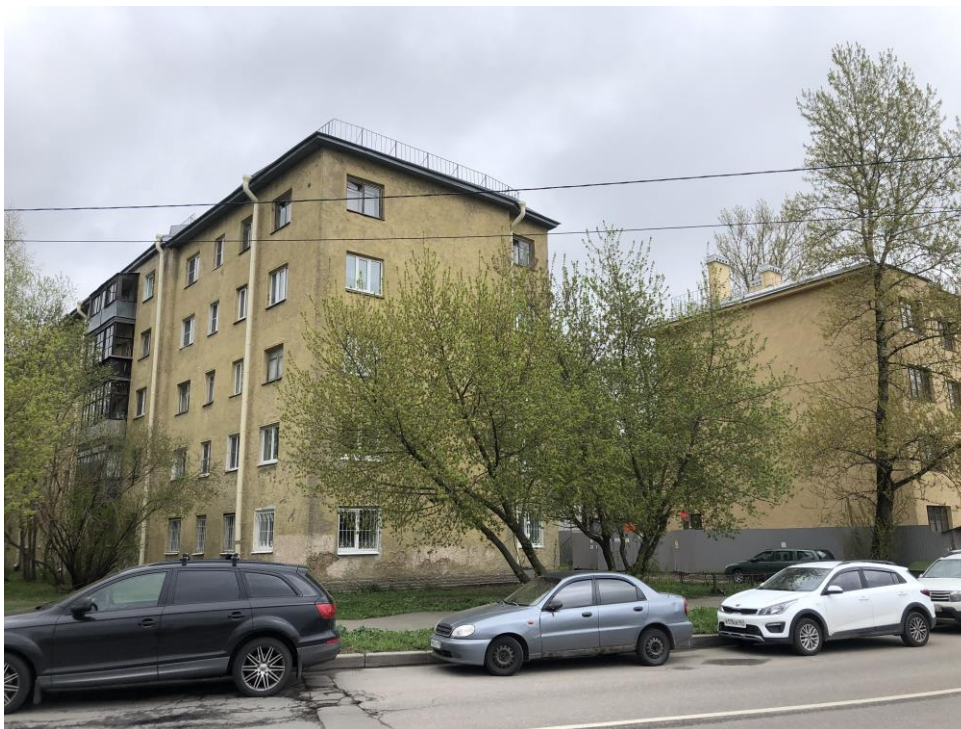
6. Здание по адресу: г. Санкт-Петербург, Кондратьевский пр., д. 40, литера А, корпус 7, являющееся частью объекта культурного наследия регионального значения «Жилые здания», входящее в состав объекта культурного наследия регионального значения «Кондратьевский жилмассив» (г. Санкт-Петербург, Калининский район, Кондратьевский пр., д. 40. На основании Распоряжения КГИОП от 27.02.2014 № 10-89). Общий вид на жилмассив с пересечения улицы Жукова и Чичуринского переулка.
