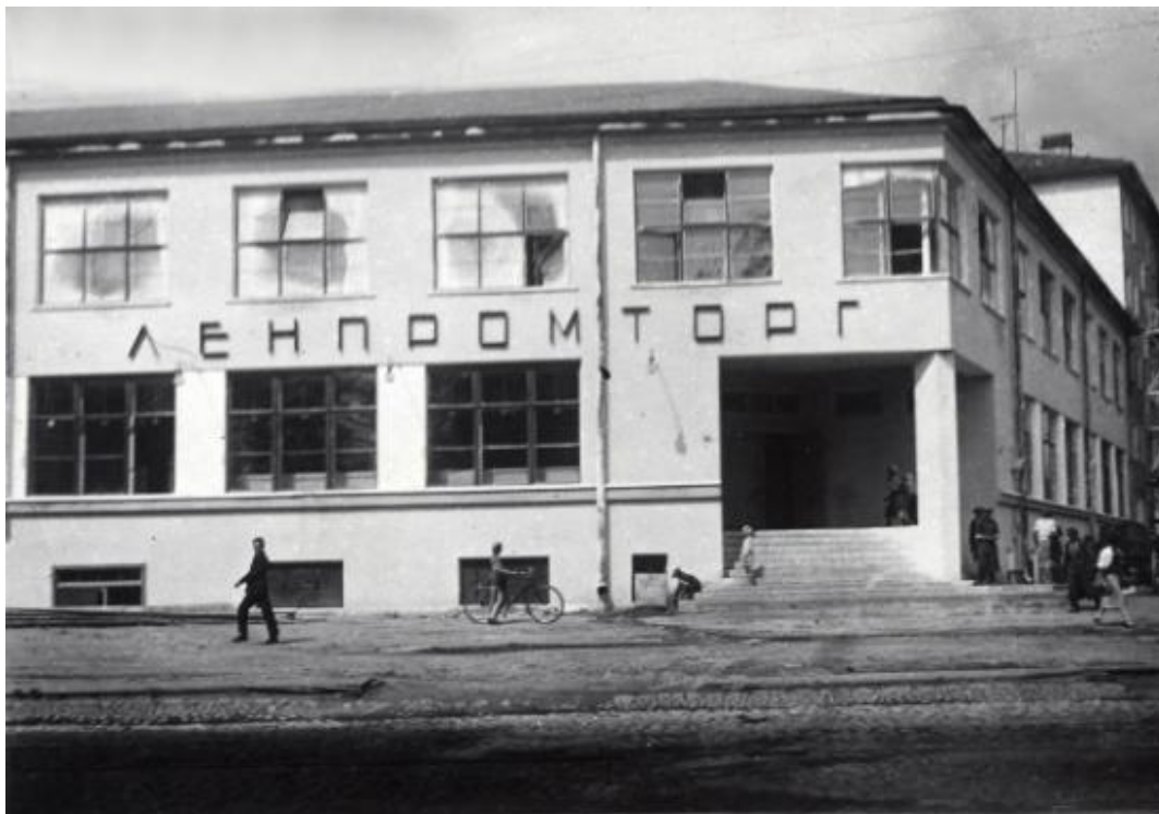
7. Фасад универмага на Кондратьевском проспекте. 1934 г. Фотография. ЦГА КФФД СПб. Бр-8221.
