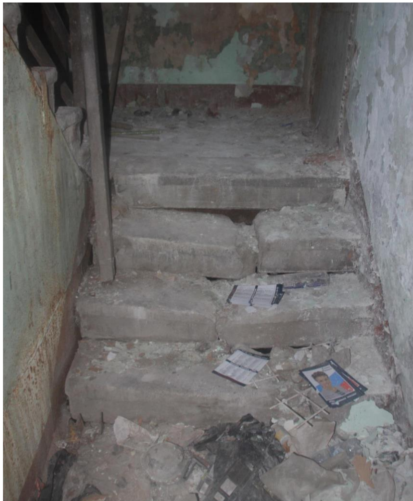
47. Здание по адресу: г. Санкт-Петербург, Кондратьевский пр., д. 40, литера А, корпус 7, являющееся частью объекта культурного наследия регионального значения «Жилые здания», входящее в состав объекта культурного наследия регионального значения «Кондратьевский жилмассив» (г. Санкт-Петербург, Калининский район, Кондратьевский пр., д. 40. На основании Распоряжения КГИОП от 27.02.2014 № 10-89). Общий вид лестницы в здании. Уровень первого этажа.
