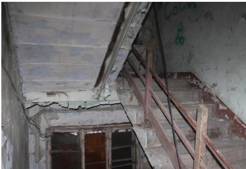
50. Здание по адресу: г. Санкт-Петербург, Кондратьевский пр., д. 40, литера А, корпус 7, являющееся частью объекта культурного наследия регионального значения «Жилые здания», входящее в состав объекта культурного наследия регионального значения «Кондратьевский жилмассив» (г. Санкт-Петербург, Калининский район, Кондратьевский пр., д. 40. На основании Распоряжения КГИОП от 27.02.2014 № 10-89). Лестница в здании. Фрагмент.
