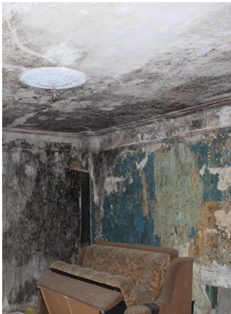
39. Здание по адресу: г. Санкт-Петербург, Кондратьевский пр., д. 40, литера А, корпус 7, являющееся частью объекта культурного наследия регионального значения «Жилые здания», входящее в состав объекта культурного наследия регионального значения «Кондратьевский жилмассив» (г. Санкт-Петербург, Калининский район, Кондратьевский пр., д. 40. На основании Распоряжения КГИОП от 27.02.2014 № 10-89). Фрагмент интерьера помещения четвертого этажа.
