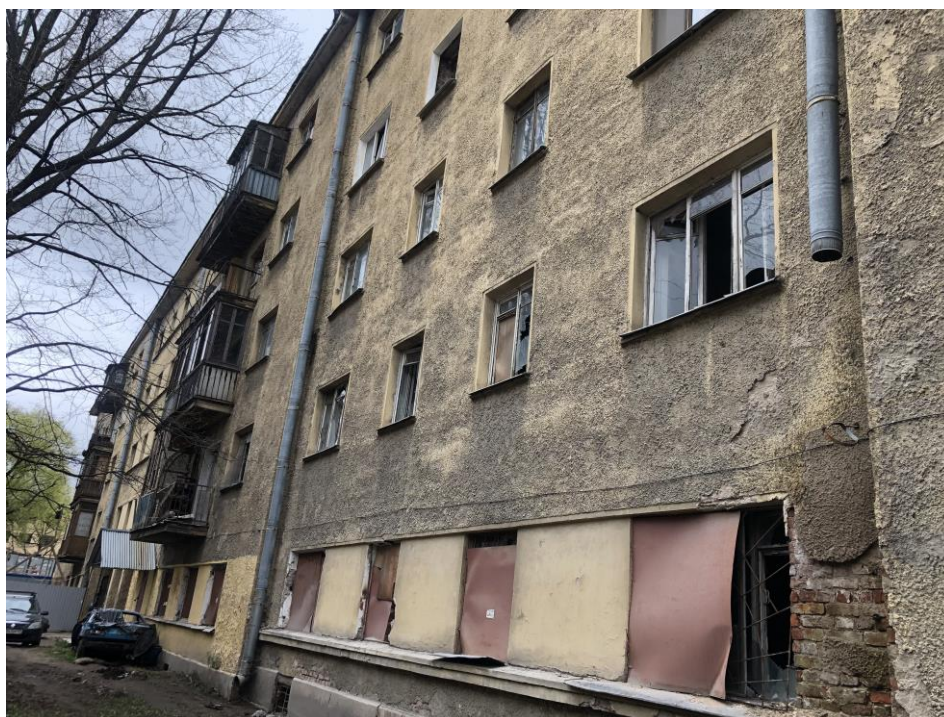
15. Здание по адресу: г. Санкт-Петербург, Кондратьевский пр., д. 40, литера А, корпус 7, являющееся частью объекта культурного наследия регионального значения «Жилые здания», входящее в состав объекта культурного наследия регионального значения «Кондратьевский жилмассив» (г. Санкт-Петербург, Калининский район, Кондратьевский пр., д. 40. На основании Распоряжения КГИОП от 27.02.2014 № 10-89). Фрагмент восточного фасада корпуса 7.
