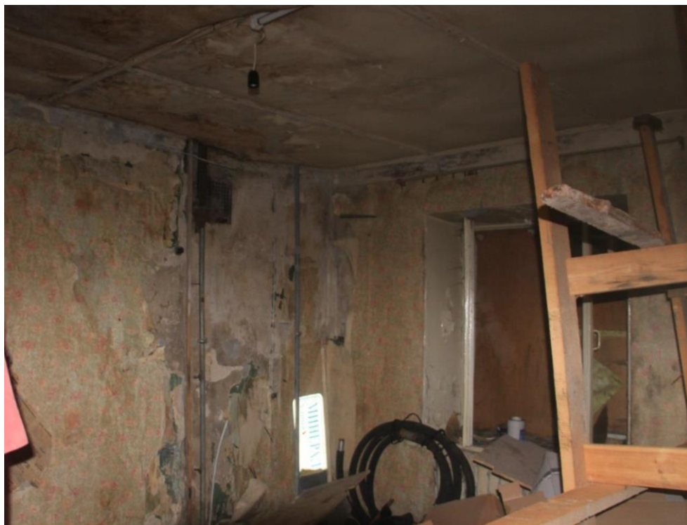
25. Здание по адресу: г. Санкт-Петербург, Кондратьевский пр., д. 40, литера А, корпус 7, являющееся частью объекта культурного наследия регионального значения «Жилые здания», входящее в состав объекта культурного наследия регионального значения «Кондратьевский жилмассив» (г. Санкт-Петербург, Калининский район, Кондратьевский пр., д. 40. На основании Распоряжения КГИОП от 27.02.2014 № 10-89). Помещение первого этажа. Общий вид.
