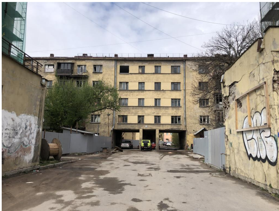
21. Здание по адресу: г. Санкт-Петербург, Кондратьевский пр., д. 40, литера А, корпус 7, являющееся частью объекта культурного наследия регионального значения «Жилые здания», входящее в состав объекта культурного наследия регионального значения «Кондратьевский жилмассив» (г. Санкт-Петербург, Калининский район, Кондратьевский пр., д. 40. На основании Распоряжения КГИОП от 27.02.2014 № 10-89). Фрагмент восточного фасада корпуса 7. Вид со стороны Кондратьевского проспекта.
