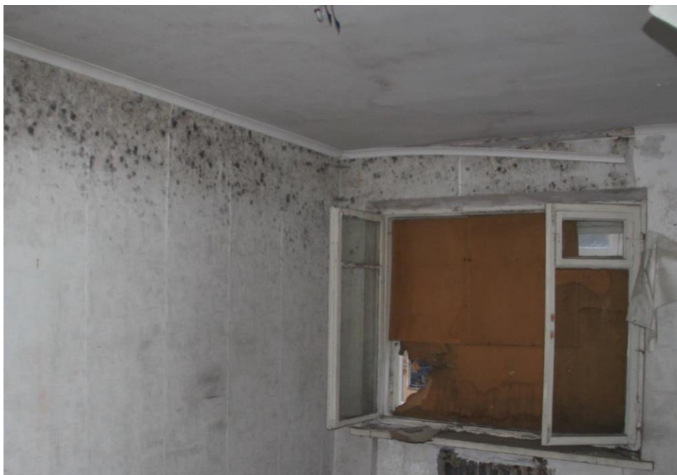
27. Здание по адресу: г. Санкт-Петербург, Кондратьевский пр., д. 40, литера А, корпус 7, являющееся частью объекта культурного наследия регионального значения «Жилые здания», входящее в состав объекта культурного наследия регионального значения «Кондратьевский жилмассив» (г. Санкт-Петербург, Калининский район, Кондратьевский пр., д. 40. На основании Распоряжения КГИОП от 27.02.2014 № 10-89). Помещение второго этажа. Общий вид.
