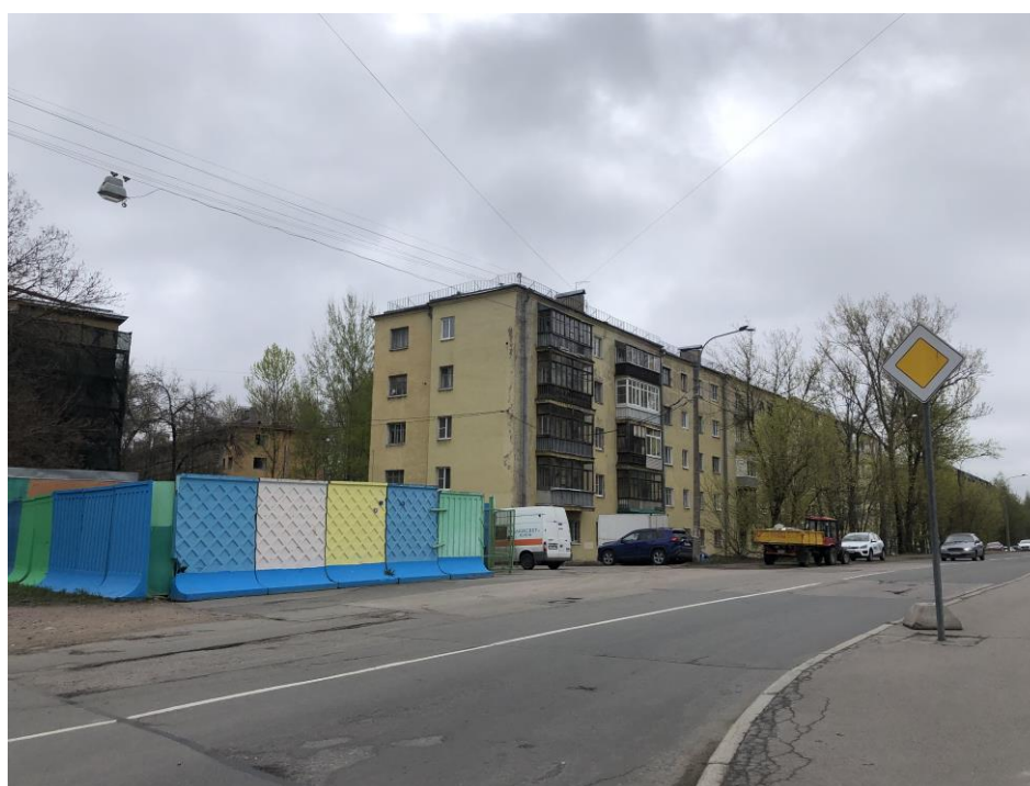
8. Здание по адресу: г. Санкт-Петербург, Кондратьевский пр., д. 40, литера А, корпус 7, являющееся частью объекта культурного наследия регионального значения «Жилые здания», входящее в состав объекта культурного наследия регионального значения «Кондратьевский жилмассив» (г. Санкт-Петербург, Калининский район, Кондратьевский пр., д. 40. На основании Распоряжения КГИОП от 27.02.2014 № 10-89). Общий вид на жилмассив с пересечения Чичуринского переулка и Полюстровского проспекта.
