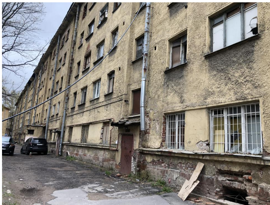
20. Здание по адресу: г. Санкт-Петербург, Кондратьевский пр., д. 40, литера А, корпус 7, являющееся частью объекта культурного наследия регионального значения «Жилые здания», входящее в состав объекта культурного наследия регионального значения «Кондратьевский жилмассив» (г. Санкт-Петербург, Калининский район, Кондратьевский пр., д. 40. На основании Распоряжения КГИОП от 27.02.2014 № 10-89). Фрагмент западного фасада корпуса 7.
