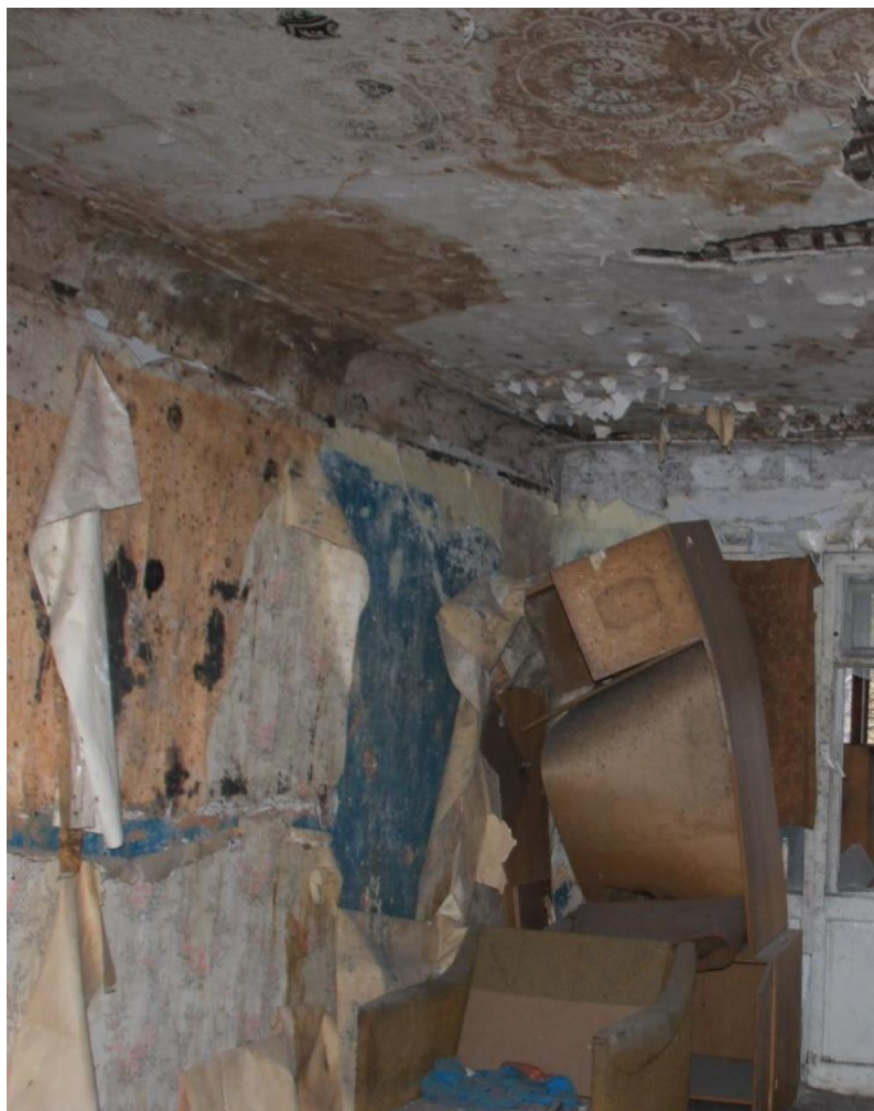
36. Здание по адресу: г. Санкт-Петербург, Кондратьевский пр., д. 40, литера А, корпус 7, являющееся частью объекта культурного наследия регионального значения «Жилые здания», входящее в состав объекта культурного наследия регионального значения «Кондратьевский жилмассив» (г. Санкт-Петербург, Калининский район, Кондратьевский пр., д. 40. На основании Распоряжения КГИОП от 27.02.2014 № 10-89). Фрагмент интерьера помещения четвертого этажа.
