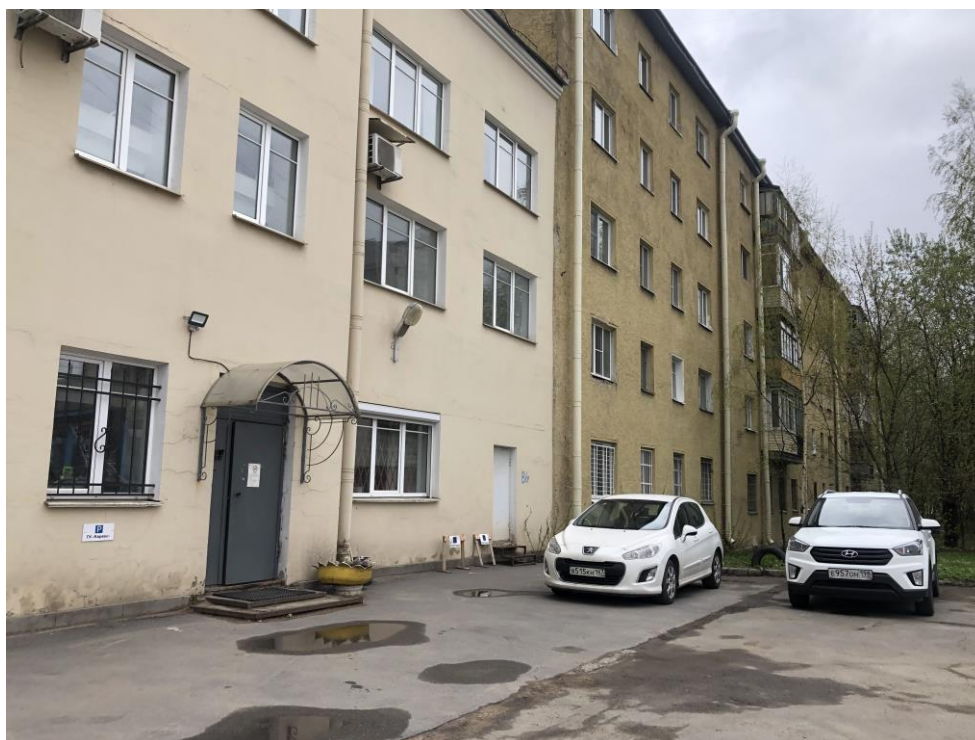
7. Здание по адресу: г. Санкт-Петербург, Кондратьевский пр., д. 40, литера А, корпус 7, являющееся частью объекта культурного наследия регионального значения «Жилые здания», входящее в состав объекта культурного наследия регионального значения «Кондратьевский жилмассив» (г. Санкт-Петербург, Калининский район, Кондратьевский пр., д. 40. На основании Распоряжения КГИОП от 27.02.2014 № 10-89). Общий на жилмассив со стороны Чичуринского переулка.
