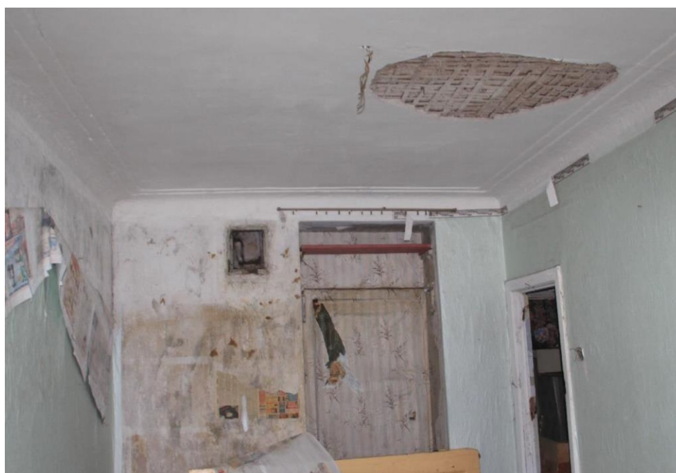
30. Здание по адресу: г. Санкт-Петербург, Кондратьевский пр., д. 40, литера А, корпус 7, являющееся частью объекта культурного наследия регионального значения «Жилые здания», входящее в состав объекта культурного наследия регионального значения «Кондратьевский жилмассив» (г. Санкт-Петербург, Калининский район, Кондратьевский пр., д. 40. На основании Распоряжения КГИОП от 27.02.2014 № 10-89). Фрагмент интерьера помещения третьего этажа.
