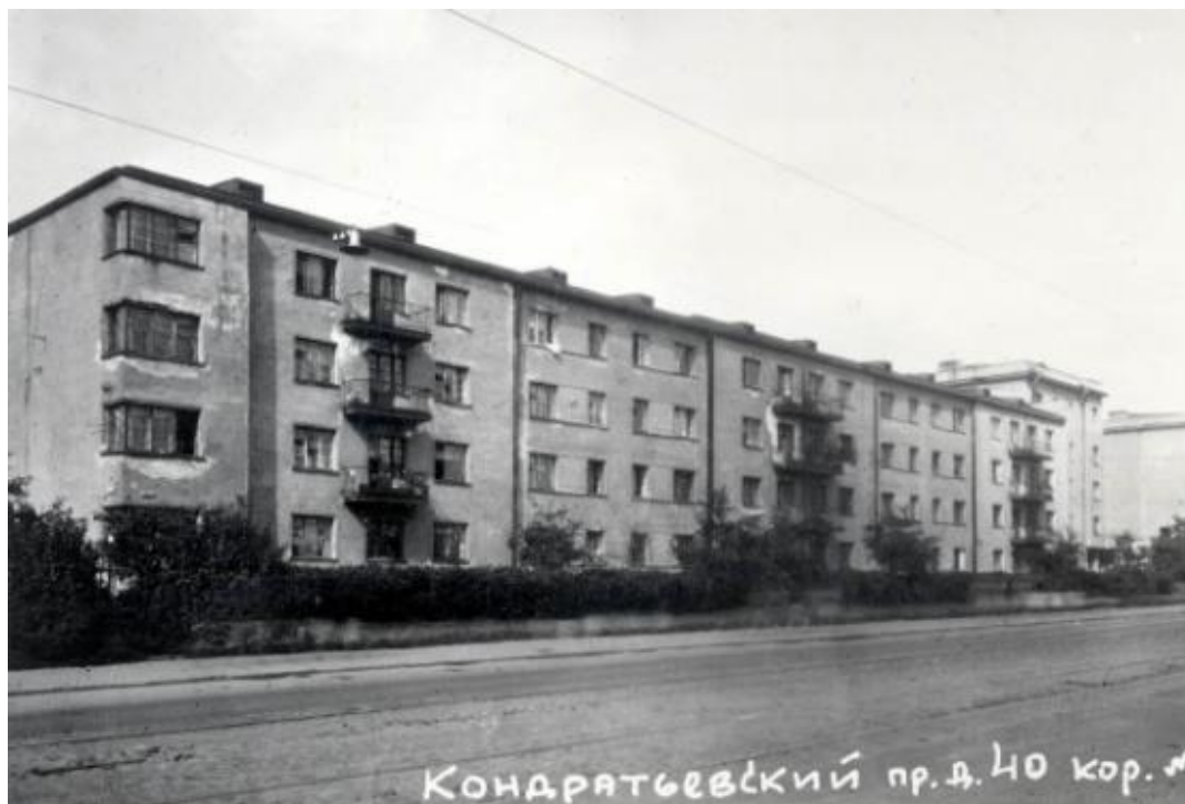
15. Корпус 1. Вид со стороны улицы. 1949 г. Фотография. ЦГАКФФД СПб. Гр-83203.
