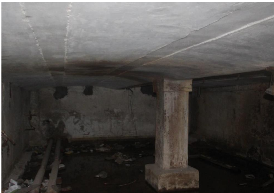
23. Здание по адресу: г. Санкт-Петербург, Кондратьевский пр., д. 40, литера А, корпус 7, являющееся частью объекта культурного наследия регионального значения «Жилые здания», входящее в состав объекта культурного наследия регионального значения «Кондратьевский жилмассив» (г. Санкт-Петербург, Калининский район, Кондратьевский пр., д. 40. На основании Распоряжения КГИОП от 27.02.2014 № 10-89). Помещение подвала. Общий вид.
