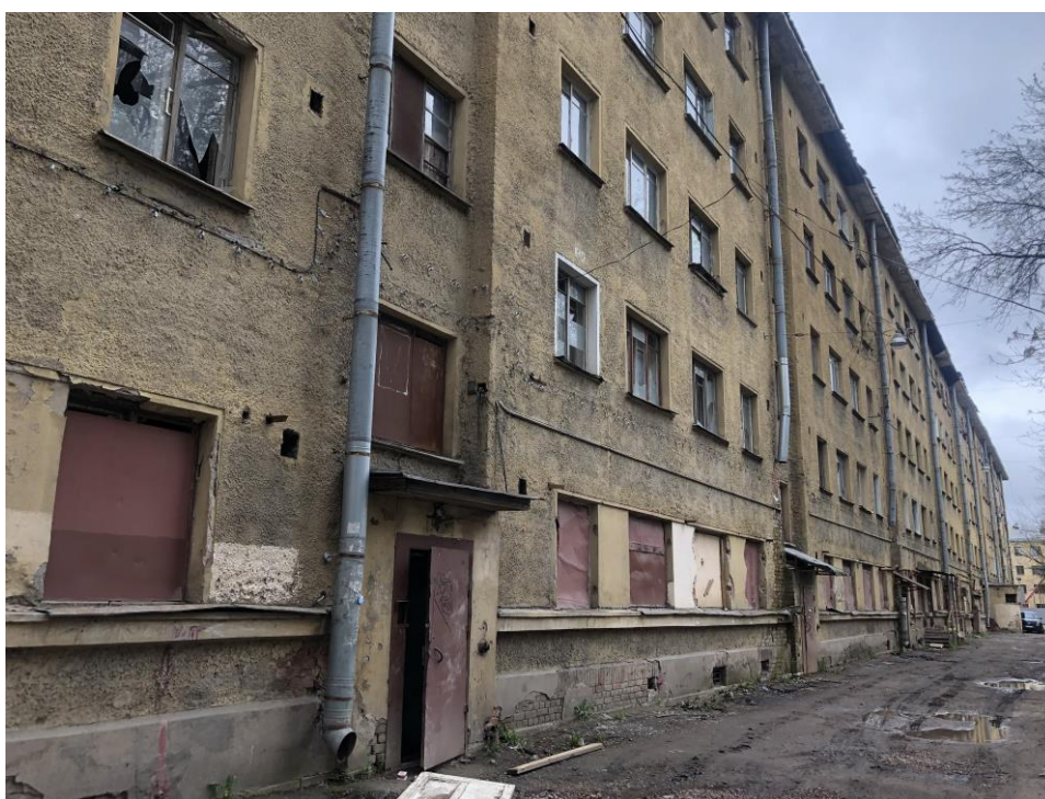
12. Здание по адресу: г. Санкт-Петербург, Кондратьевский пр., д. 40, литера А, корпус 7, являющееся частью объекта культурного наследия регионального значения «Жилые здания», входящее в состав объекта культурного наследия регионального значения «Кондратьевский жилмассив» (г. Санкт-Петербург, Калининский район, Кондратьевский пр., д. 40. На основании Распоряжения КГИОП от 27.02.2014 № 10-89). Вид на западный фасад корпуса 7.
