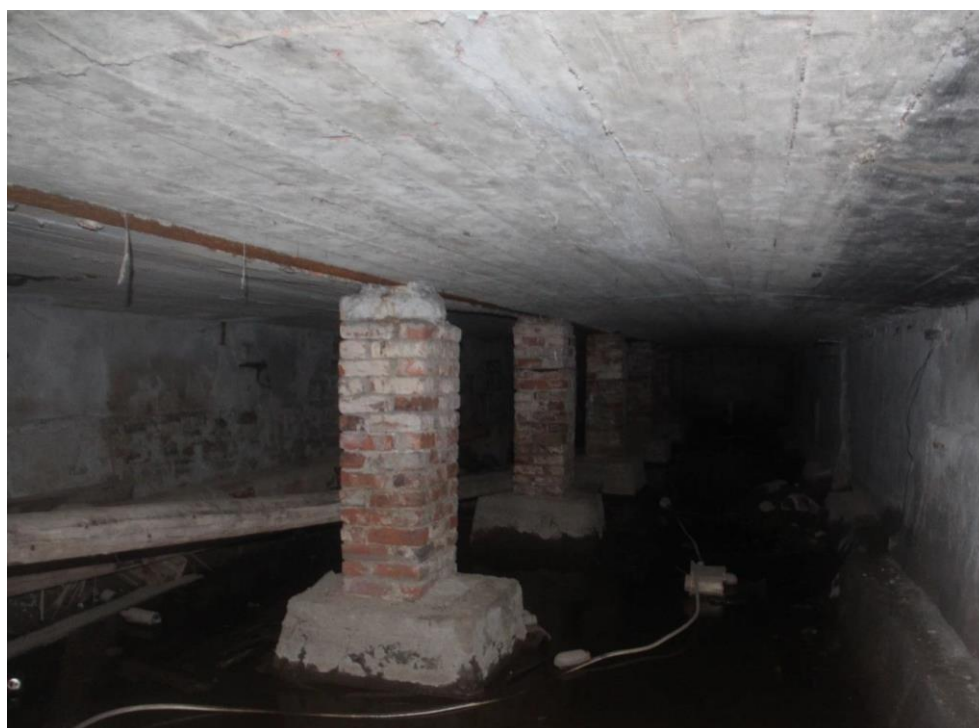
24. Здание по адресу: г. Санкт-Петербург, Кондратьевский пр., д. 40, литера А, корпус 7, являющееся частью объекта культурного наследия регионального значения «Жилые здания», входящее в состав объекта культурного наследия регионального значения «Кондратьевский жилмассив» (г. Санкт-Петербург, Калининский район, Кондратьевский пр., д. 40. На основании Распоряжения КГИОП от 27.02.2014 № 10-89). Помещение подвала. Общий вид.
