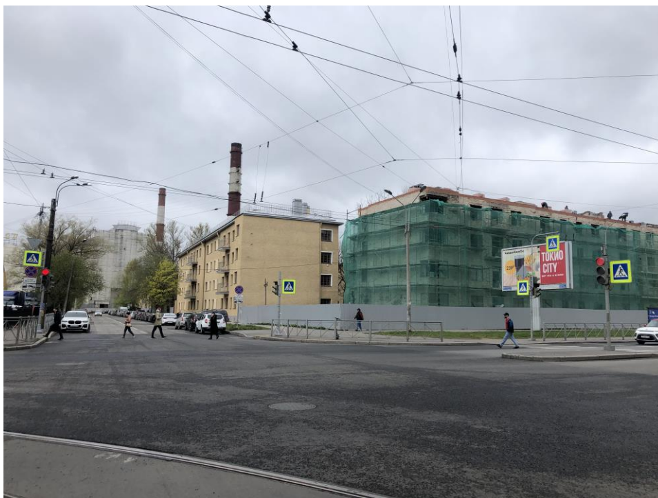
4. Здание по адресу: г. Санкт-Петербург, Кондратьевский пр., д. 40, литера А, корпус 7, являющееся частью объекта культурного наследия регионального значения «Жилые здания», входящее в состав объекта культурного наследия регионального значения «Кондратьевский жилмассив» (г. Санкт-Петербург, Калининский район, Кондратьевский пр., д. 40. На основании Распоряжения КГИОП от 27.02.2014 № 10-89). Общий вид на жилмассив с пересечения Кондратьевского проспекта и улицы Жукова.
