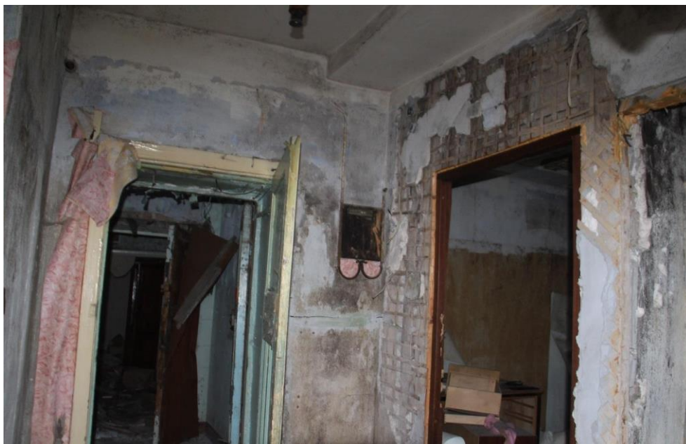
37. Здание по адресу: г. Санкт-Петербург, Кондратьевский пр., д. 40, литера А, корпус 7, являющееся частью объекта культурного наследия регионального значения «Жилые здания», входящее в состав объекта культурного наследия регионального значения «Кондратьевский жилмассив» (г. Санкт-Петербург, Калининский район, Кондратьевский пр., д. 40. На основании Распоряжения КГИОП от 27.02.2014 № 10-89). Фрагмент интерьера помещения четвертого этажа.
