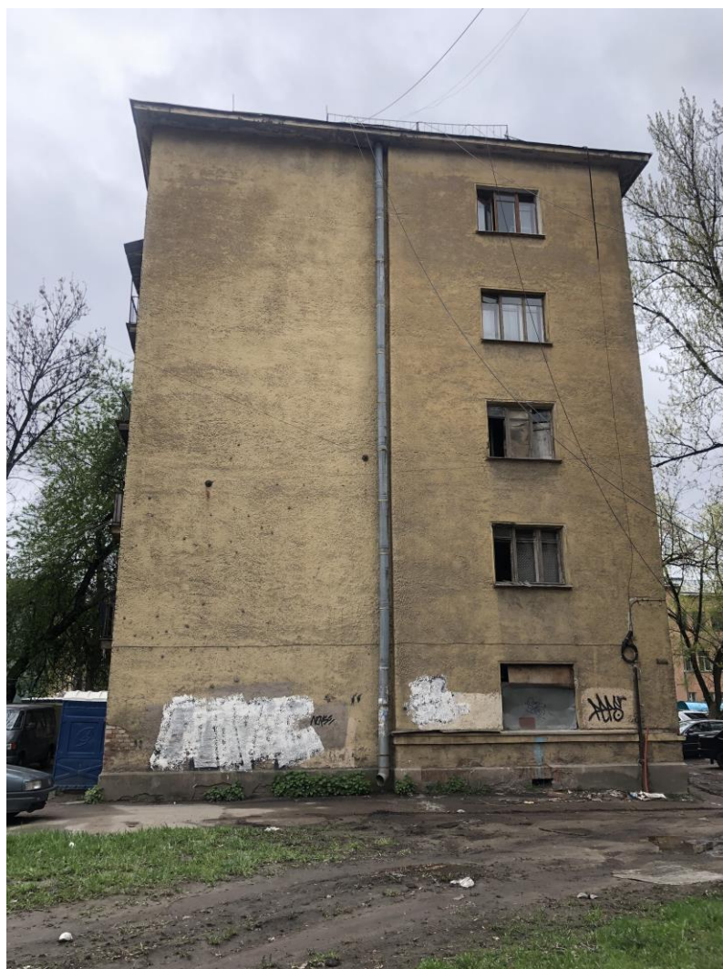
13. Здание по адресу: г. Санкт-Петербург, Кондратьевский пр., д. 40, литера А, корпус 7, являющееся частью объекта культурного наследия регионального значения «Жилые здания», входящее в состав объекта культурного наследия регионального значения «Кондратьевский жилмассив» (г. Санкт-Петербург, Калининский район, Кондратьевский пр., д. 40. На основании Распоряжения КГИОП от 27.02.2014 № 10-89). Вид на северный торцевой фасад корпуса 7.
