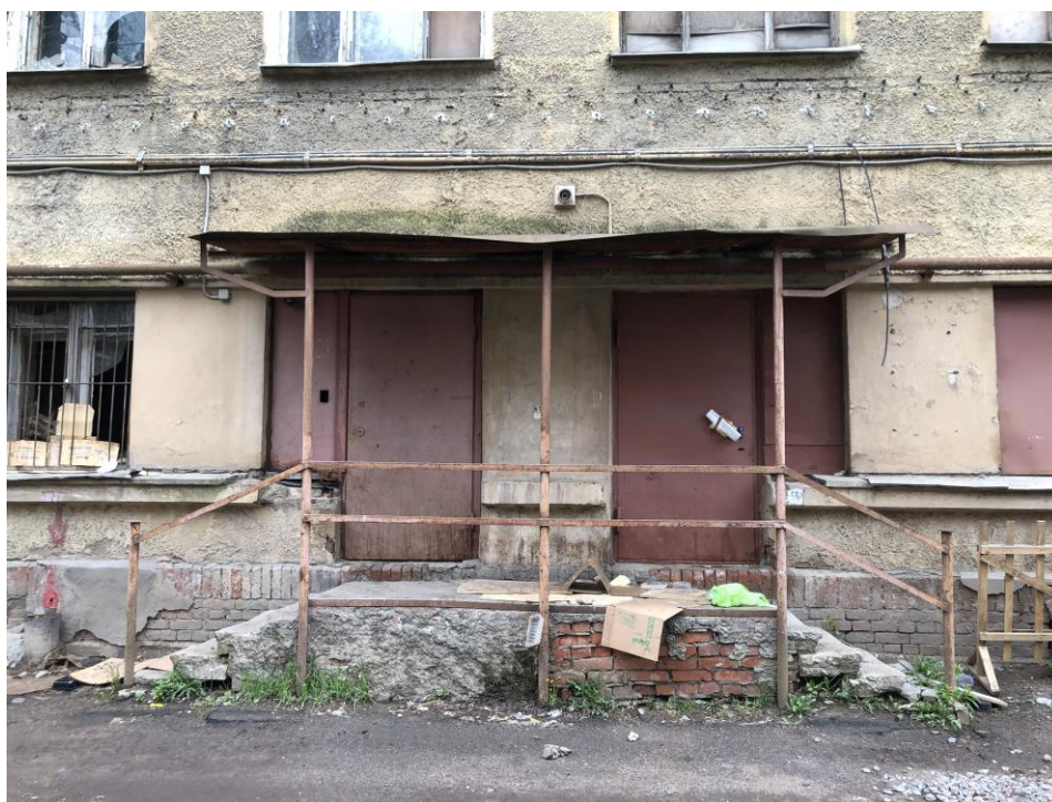
19. Здание по адресу: г. Санкт-Петербург, Кондратьевский пр., д. 40, литера А, корпус 7, являющееся частью объекта культурного наследия регионального значения «Жилые здания», входящее в состав объекта культурного наследия регионального значения «Кондратьевский жилмассив» (г. Санкт-Петербург, Калининский район, Кондратьевский пр., д. 40. На основании Распоряжения КГИОП от 27.02.2014 № 10-89). Фрагмент западного фасада корпуса 7.
