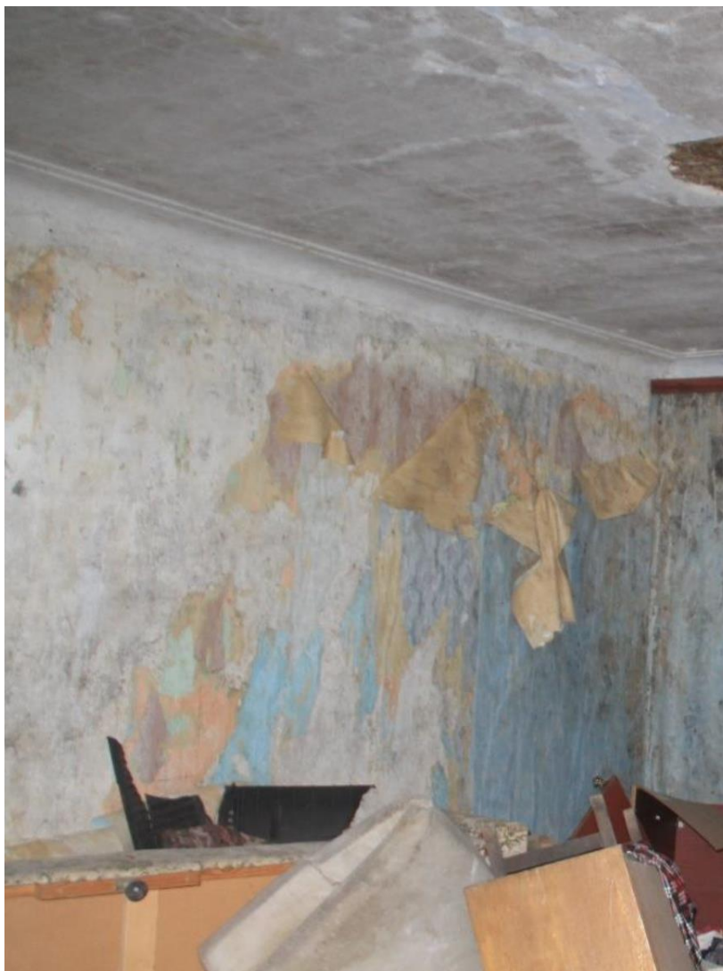
31. Здание по адресу: г. Санкт-Петербург, Кондратьевский пр., д. 40, литера А, корпус 7, являющееся частью объекта культурного наследия регионального значения «Жилые здания», входящее в состав объекта культурного наследия регионального значения «Кондратьевский жилмассив» (г. Санкт-Петербург, Калининский район, Кондратьевский пр., д. 40. На основании Распоряжения КГИОП от 27.02.2014 № 10-89). Фрагмент интерьера помещения третьего этажа.
