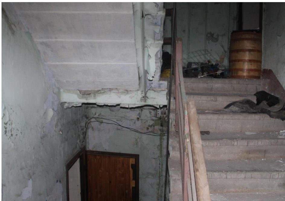
49. Здание по адресу: г. Санкт-Петербург, Кондратьевский пр., д. 40, литера А, корпус 7, являющееся частью объекта культурного наследия регионального значения «Жилые здания», входящее в состав объекта культурного наследия регионального значения «Кондратьевский жилмассив» (г. Санкт-Петербург, Калининский район, Кондратьевский пр., д. 40. На основании Распоряжения КГИОП от 27.02.2014 № 10-89). Лестница в здании. Фрагмент.
