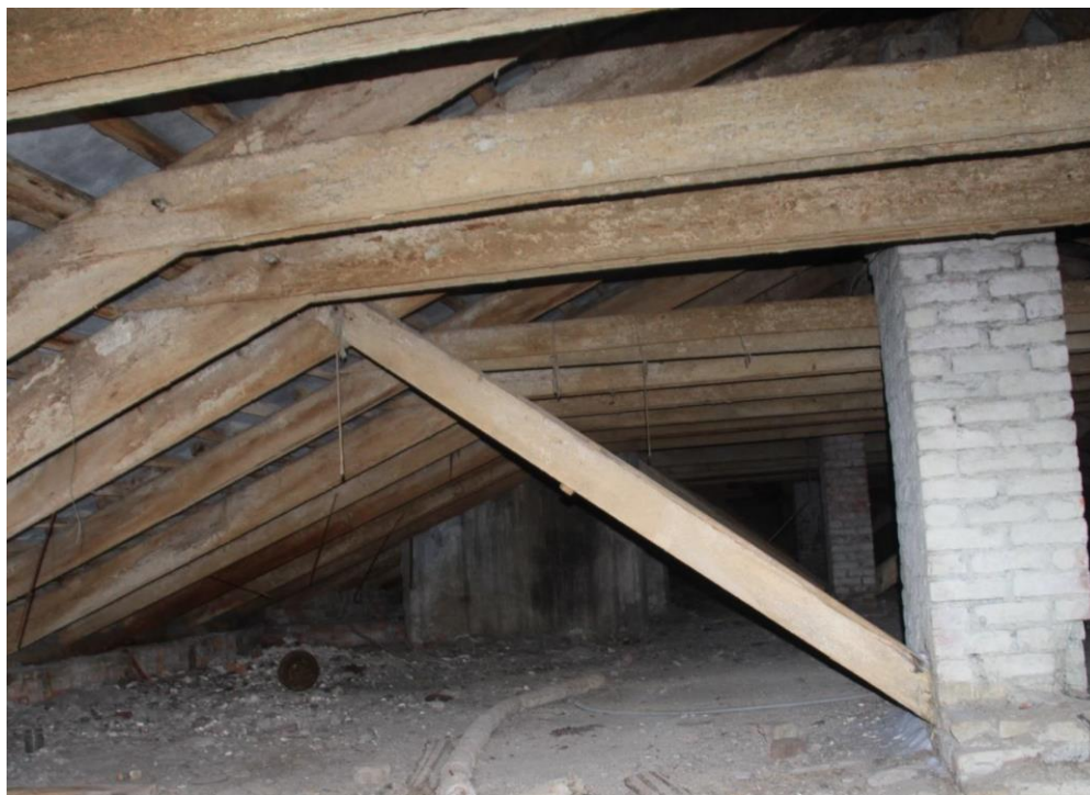
46. Здание по адресу: г. Санкт-Петербург, Кондратьевский пр., д. 40, литера А, корпус 7, являющееся частью объекта культурного наследия регионального значения «Жилые здания», входящее в состав объекта культурного наследия регионального значения «Кондратьевский жилмассив» (г. Санкт-Петербург, Калининский район, Кондратьевский пр., д. 40. На основании Распоряжения КГИОП от 27.02.2014 № 10-89). Фрагмент интерьера помещения в уровне чердака.
