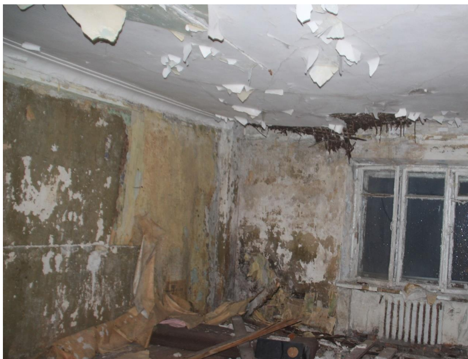
43. Здание по адресу: г. Санкт-Петербург, Кондратьевский пр., д. 40, литера А, корпус 7, являющееся частью объекта культурного наследия регионального значения «Жилые здания», входящее в состав объекта культурного наследия регионального значения «Кондратьевский жилмассив» (г. Санкт-Петербург, Калининский район, Кондратьевский пр., д. 40. На основании Распоряжения КГИОП от 27.02.2014 № 10-89). Фрагмент интерьера помещения пятого этажа.
