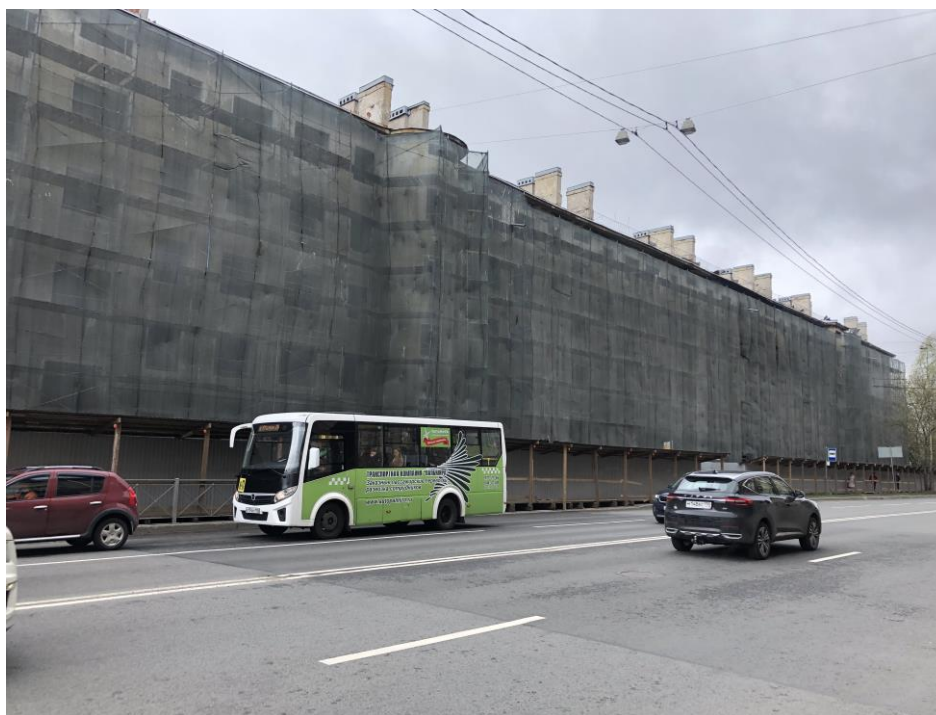
9. Здание по адресу: г. Санкт-Петербург, Кондратьевский пр., д. 40, литера А, корпус 7, являющееся частью объекта культурного наследия регионального значения «Жилые здания», входящее в состав объекта культурного наследия регионального значения «Кондратьевский жилмассив» (г. Санкт-Петербург, Калининский район, Кондратьевский пр., д. 40. На основании Распоряжения КГИОП от 27.02.2014 № 10-89). Общий вид на жилмассив со стороны Полюстровского проспекта.
