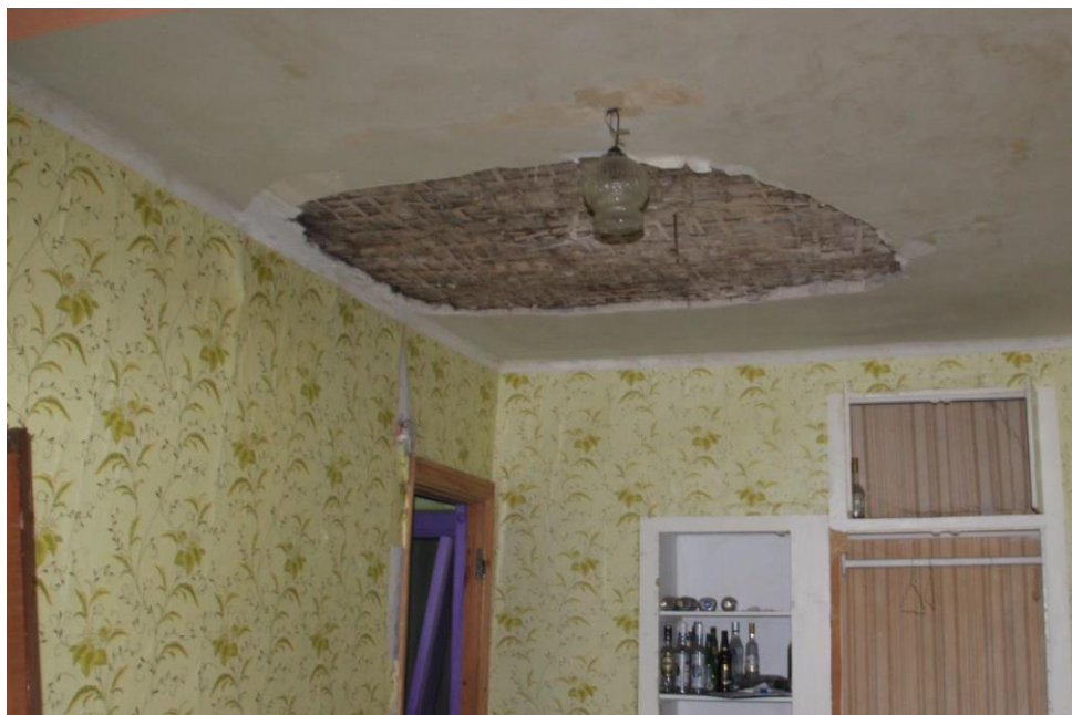
29. Здание по адресу: г. Санкт-Петербург, Кондратьевский пр., д. 40, литера А, корпус 7, являющееся частью объекта культурного наследия регионального значения «Жилые здания», входящее в состав объекта культурного наследия регионального значения «Кондратьевский жилмассив» (г. Санкт-Петербург, Калининский район, Кондратьевский пр., д. 40. На основании Распоряжения КГИОП от 27.02.2014 № 10-89). Фрагмент интерьера помещения второго этажа.
