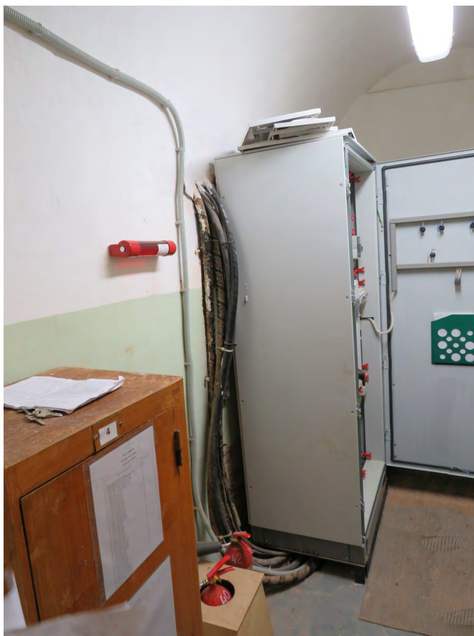
Фото 16. Помещение 020.1 подвального этажа (хозяйственное помещение). Общий вид.
