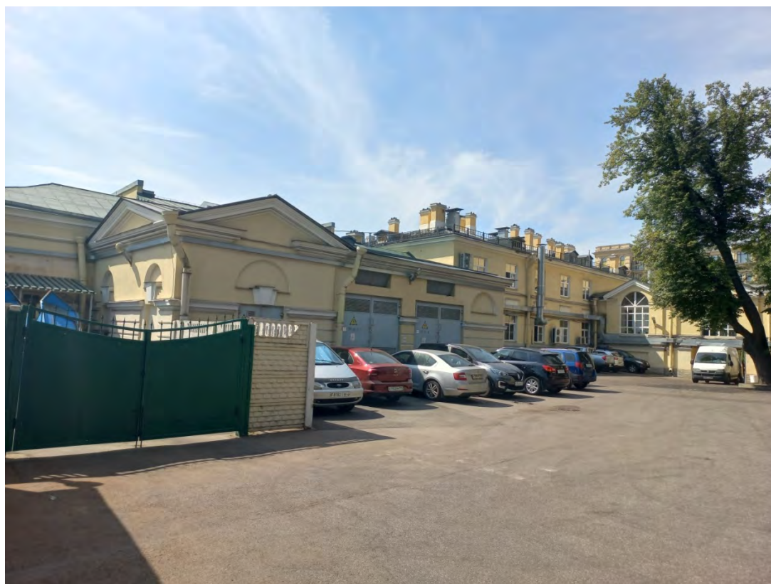
Фото 3. Территория ансамбля. Служебный корпус, примыкающий к Главному с южной стороны. Направление съемки – Юго-Запад.
