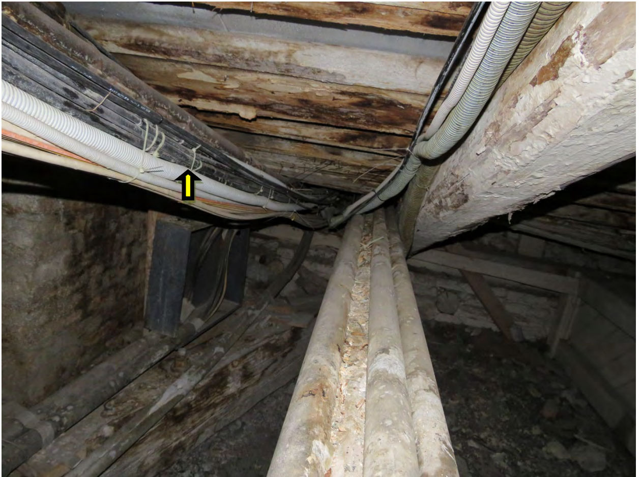
Фото 18. Помещение чердака. Общий вид.
