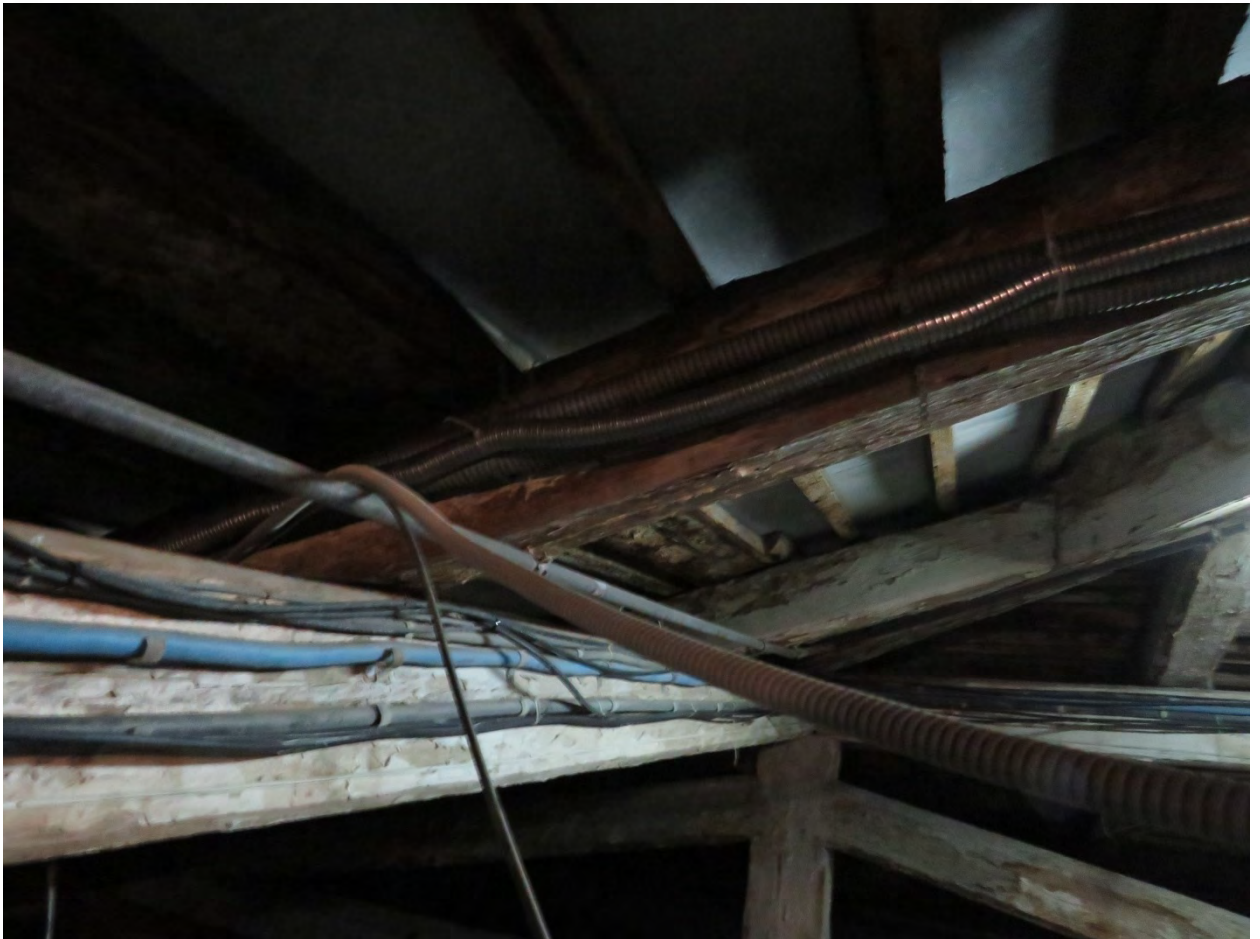
Фото 19. Помещение чердака. Общий вид. Конструкции покрытия. Существующие инженерные сети.
