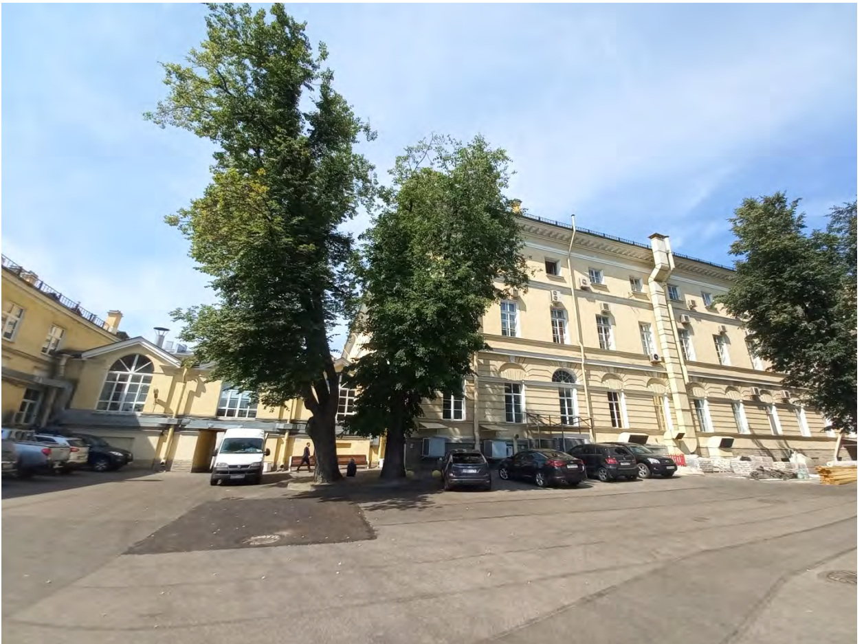
Фото 4. Направление съемки – Запад. Главный корпус (южная часть), Служебный корпус.
