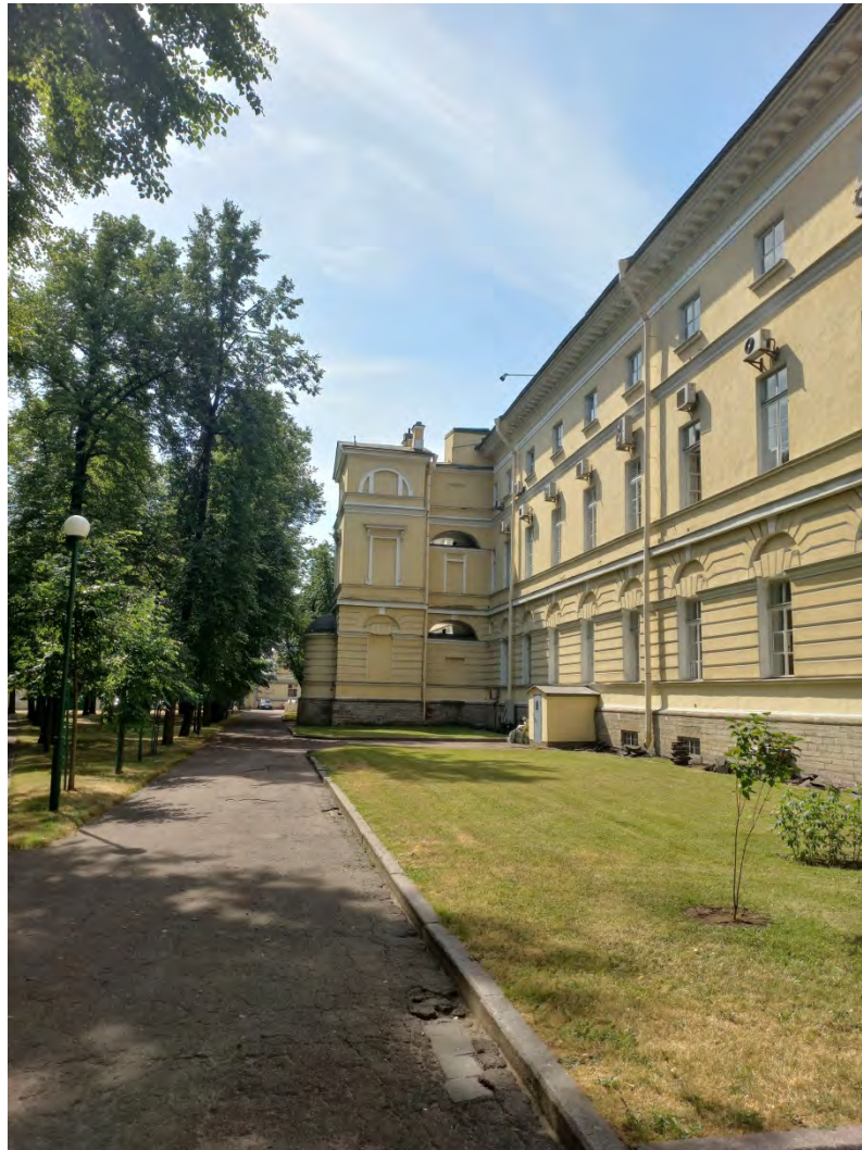
Фото 9. Восточный (дворовый) фасад Главного корпуса. Выступающий объем лестницы. Направление съемки - Юг.
