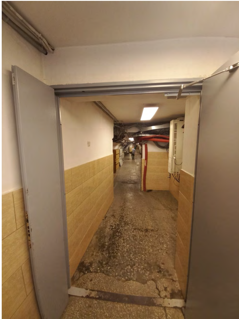
Фото 12. Главный корпус. Коридор подвала.
