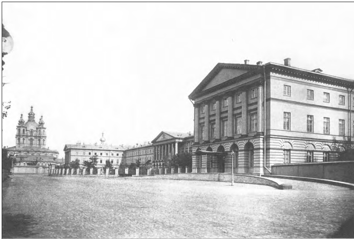
6. Смольный институт. Фасад. Правое крыло. Артистический подъезд. Фотография. 1900-е гг.
