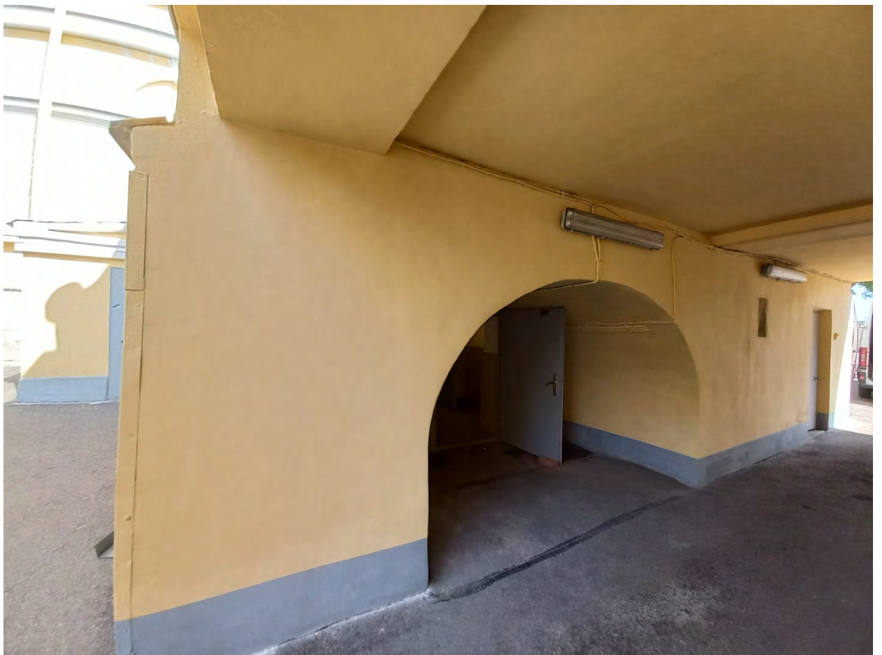
Фото 5. Вход в подвал Главного корпуса со стороны арки. Направление съемки – Северо-Восток.
