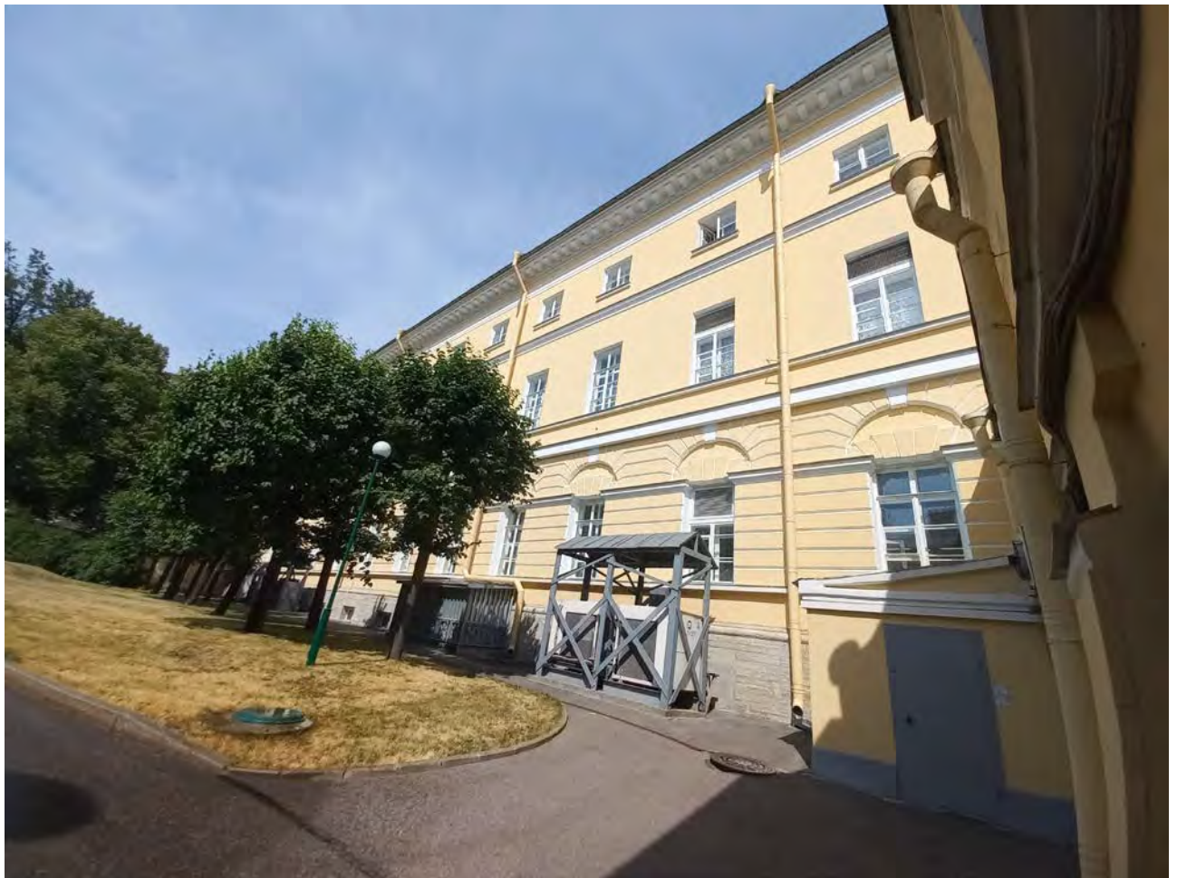
Фото 7. Южный боковой фасад. Направление съемки - Север.
