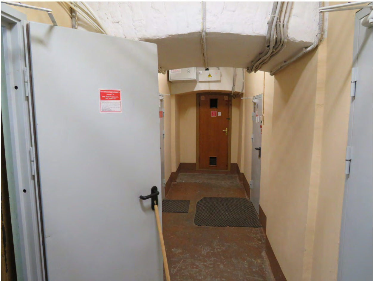
Фото 15. Подвал. Помещение 020 (хозяйственное помещение). Общий вид.
