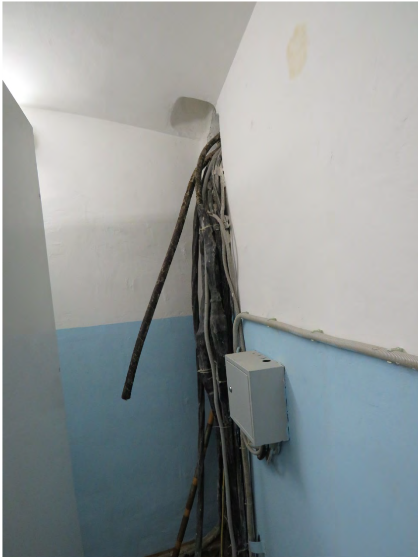
Фото 17. Помещение 010.1 подвального этажа (хозяйственное помещение). Общий вид.
