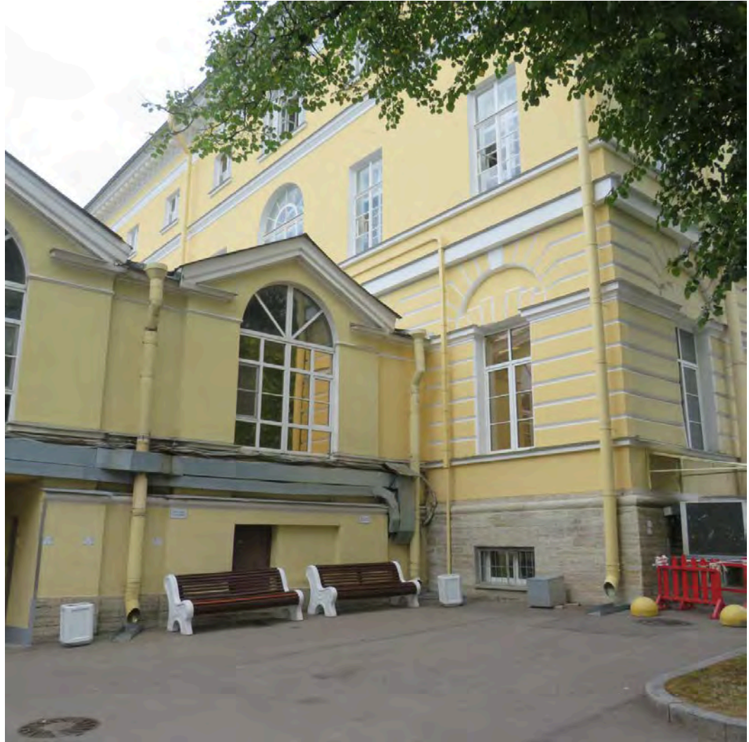
Фото 6. Фрагмент южного фасада. Существующий металлический лоток для прокладки кабеля. Направление съемки – Северо-Запад.
