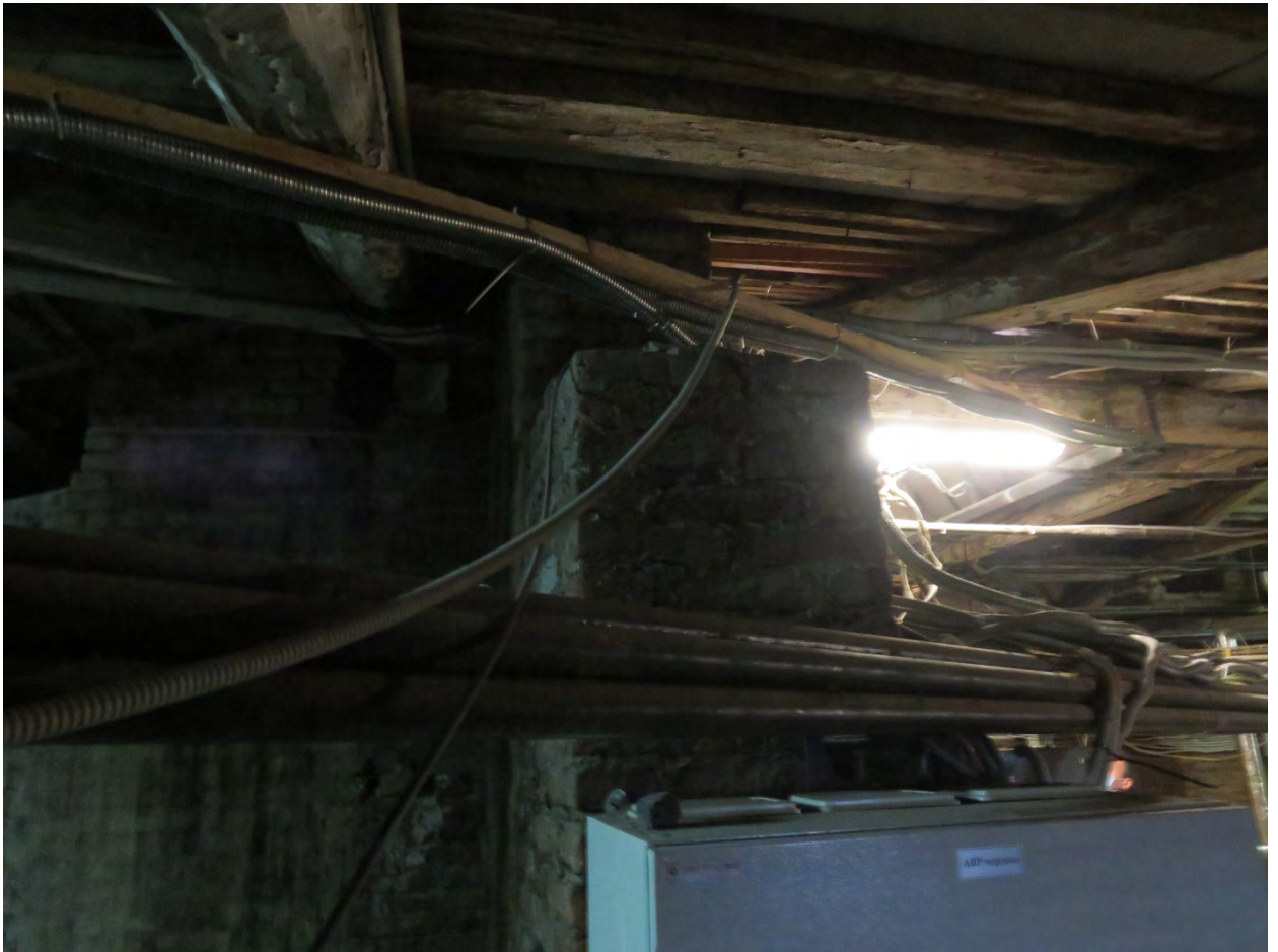
Фото 20. Помещение чердака. Общий вид. Конструкции покрытия. Несущие кирпичные стены. Существующие щиты и кабельные линии.
